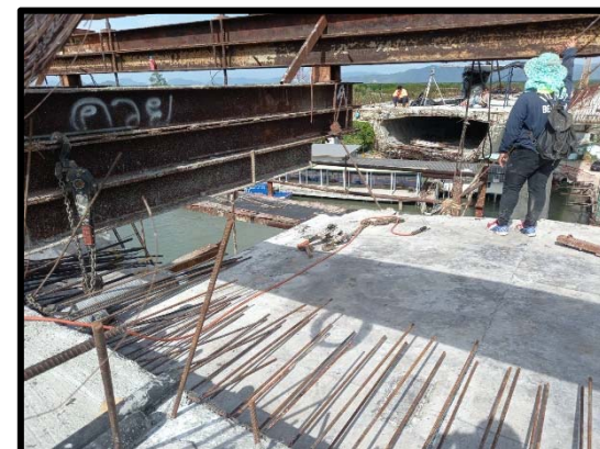
งานติดตั้งพื้นล่างพร้อมเช็คระดับ Balance Type G-G P๑๐
