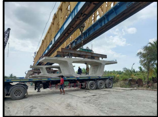
งานขนย้าย Box segment ติดตั้ง p๑๑-p๑๘
