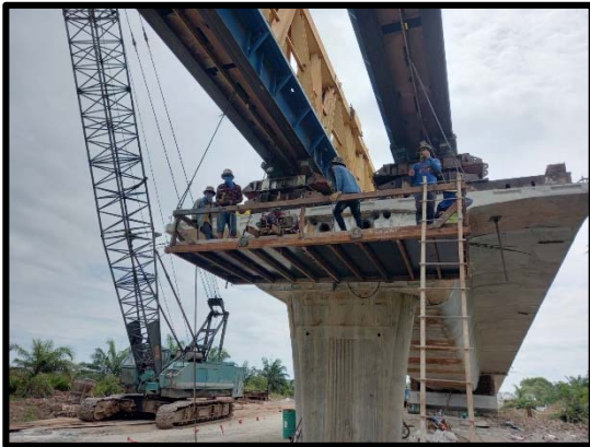
งานติดตั้งลวดอัดแรงตามยาว Box segment ช่วง P๑๗-P๑๘
