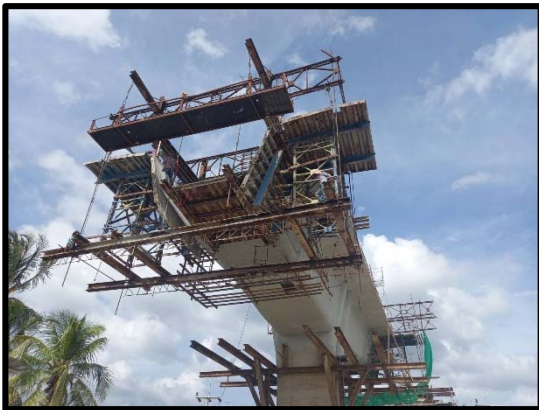
งานติดตั้งพื้นล่าง Balance Type D-D P๑๐
