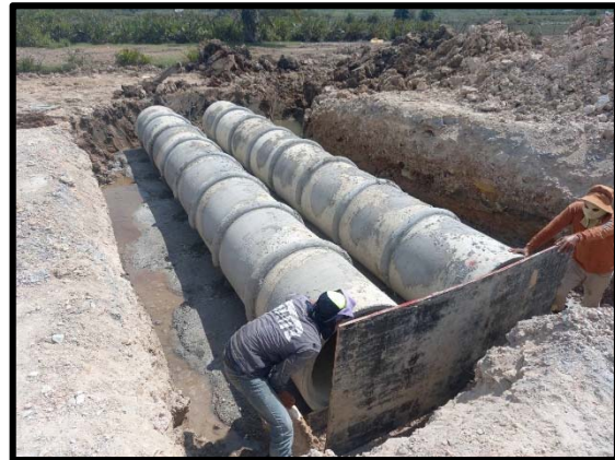
งานวางท่อ Cross Sta.๑+๗๐๐ และ ๑+๘๐๐ LT
