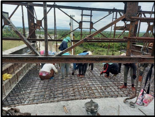
งานผูกเหล็กพื้นล่าง Balance Type G-G P๑๐
