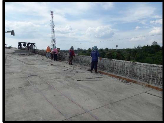
งานติดตั้ง Barrier ช่วง P๖-P๗
