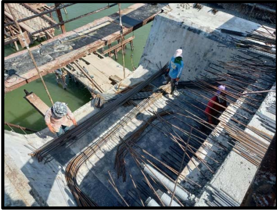
งานผูกเหล็กพื้นล่าง Balance Type G-G P๑๐
