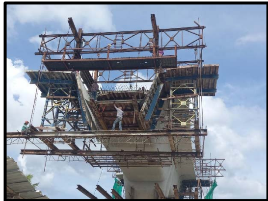
งานติดตั้งพื้นล่าง Balance Type D-D P๑๑พร้อม ตรวจสอบค่าระดับ
