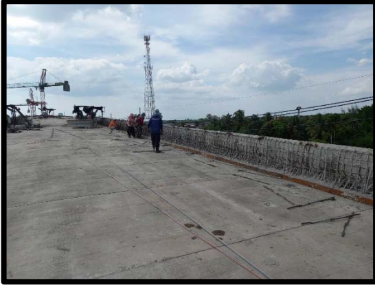
งานติดตั้ง Barrier ช่วง P๖-P๗
