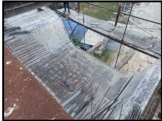
งานติดตั้งพื้นล่าง Balance Type D-D P๑๐
