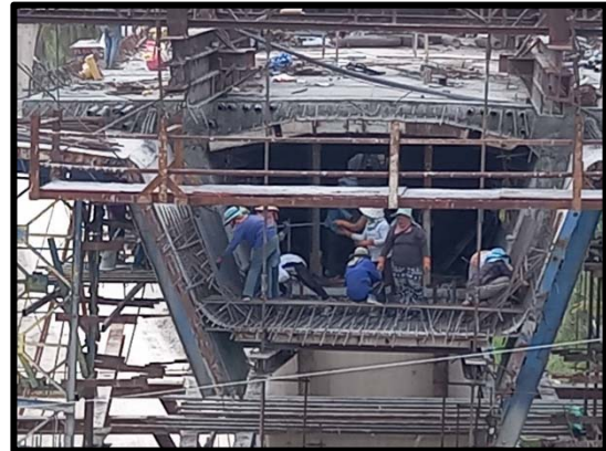
งานผูกเหล็กพื้น Balance Type D-D P๑๑
