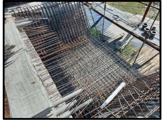
งานผูกเหล็กพื้นล่าง Balance Type G-G P๑๐
