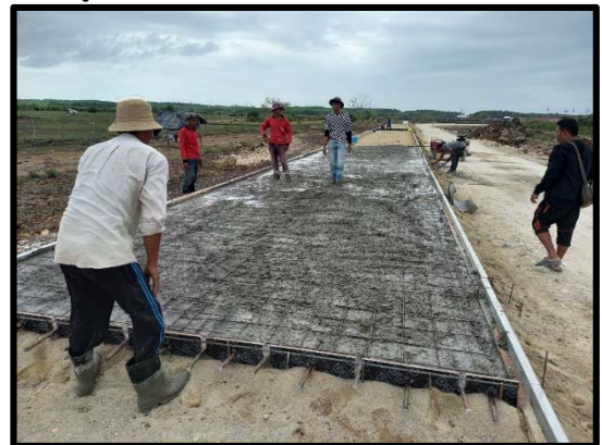
งานผูกเหล็กพื้นบน Balance Type D-D P๑๑
