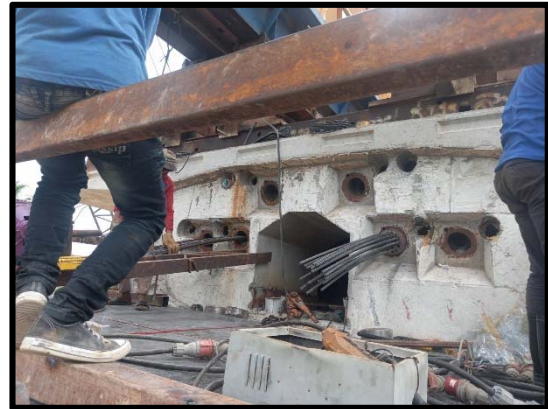
งานติดตั้งลวดอัดแรงตามยาว Box segment ช่วง P๑๗-P๑๘
