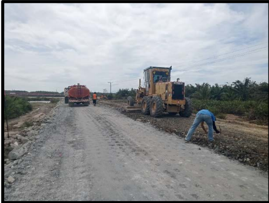
งานลงวัสดุชั้นดินถมคันทางพร้อมบดอัด กม. ๒+๑๕๐ - ๒+๓๐๐
