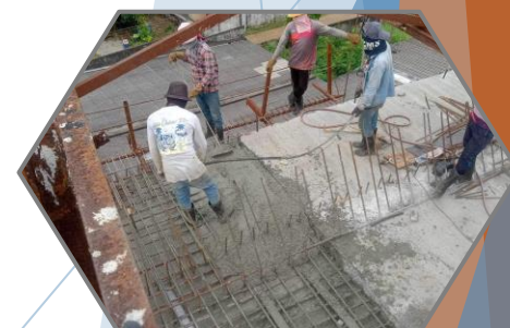
งานเทคอนกรีต Balance P8 Type K-K'
