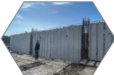
งานเทคอนกรีตคาน A,B Abutment (ฝั่งเกาะ)
