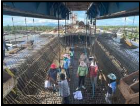
ภาพแสดงงานผูกเหล็กพื้นล่างและผนังข้าง งาน Side Span ช่วง P7-P8
