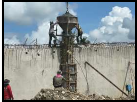
ภาพแสดงงานเทคอนกรีตรอยต่อระหว่างผนัง งาน Abutment (ฝั่งเกาะ)
