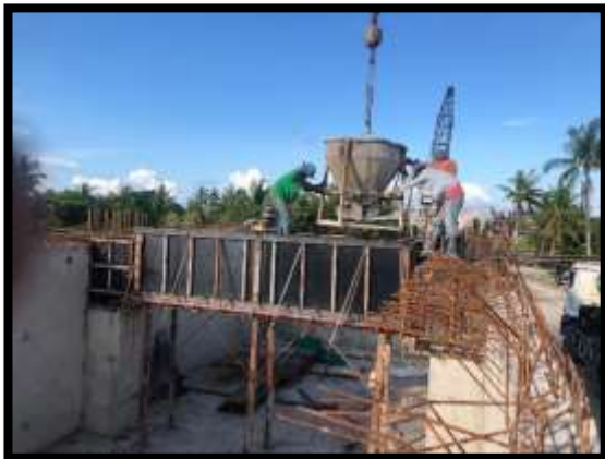
ภาพแสดงงานเทคอนกรีตคาน งาน Abutment (ฝั่งเกาะ)
