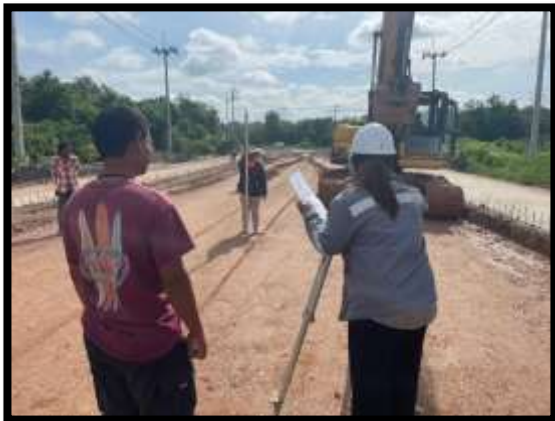
ภาพแสดงงานใช้ระดับชั้นรองพื้นทาง ความหนา 0.20 ม. งาน Transition และ งานกำแพงกันดิน
