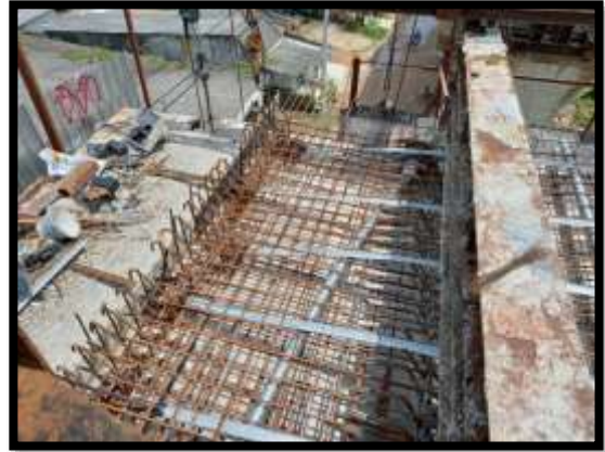
ภาพแสดงงานติดตั้งท่อร้อยลวดอัดแรงตามขวางและตามยาว งาน Balance P8 Type J-J
