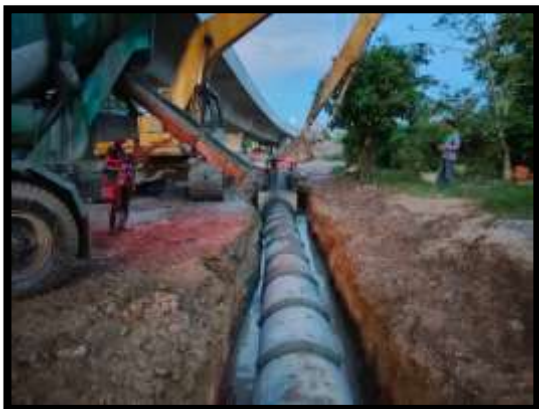
ภาพแสดงงานเทคอนกรีตรัดท่อ คสล. งานบ่อพักชุมชน
