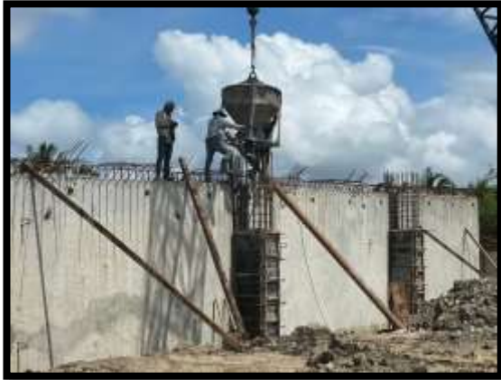
ภาพแสดงงานเทคอนกรีตรอยต่อระหว่างผนัง งาน Abutment (ฝั่งเกาะ)
