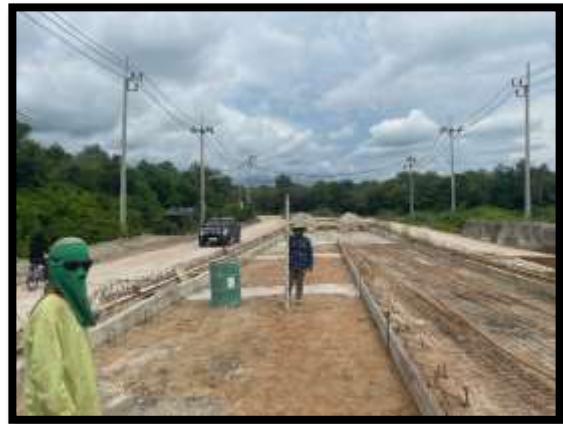
ภาพแสดงงานตรวจสอบระดับแบบข้างพื้นที่ทาง Sta.0+601.750 ถึง Sta.0+650.494
