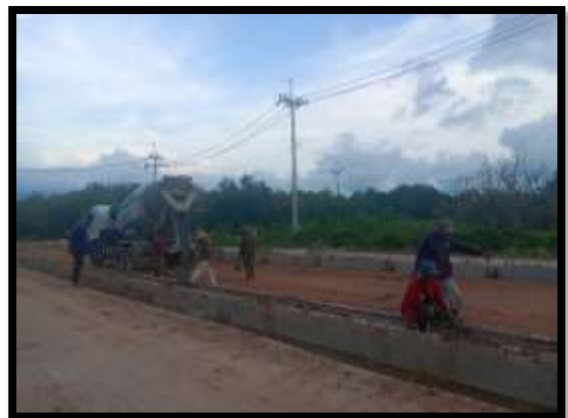
ภาพแสดงงานเทคอนกรีตรอยต่อรางน้ำ งาน Transition (ฝั่งแผ่นดิน)
