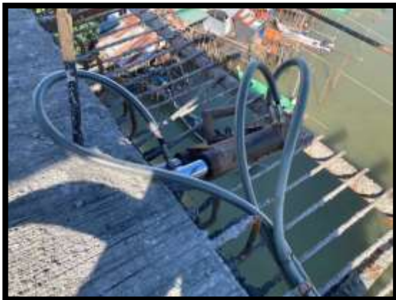
ภาพแสดงงานดึงลวดอัดแรงตามขวาง งาน Balance P10 Type B-B
