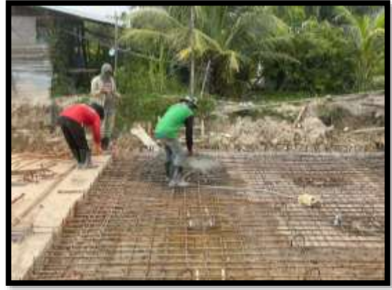
ภาพแสดงงานเทคอนกรีตพื้นล่าง งาน Transition (ฝั่งเกาะ)
