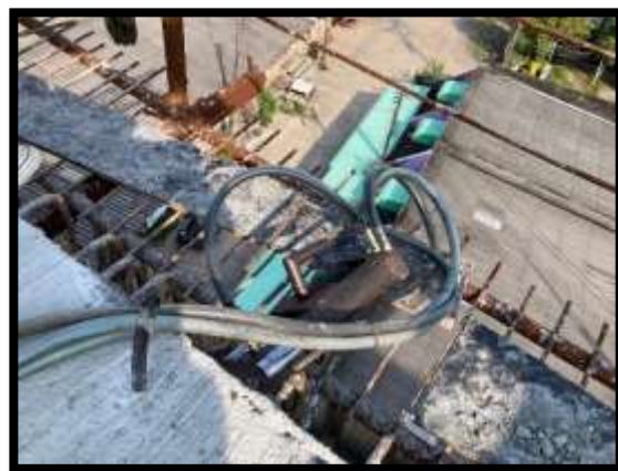
ภาพแสดงงานดึงลวดอัดแรงตามขวาง งาน Balance P8 Type J-J
