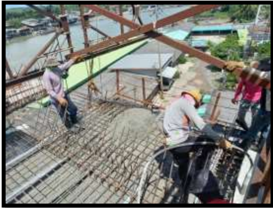
ภาพแสดงงานเทคอนกรีตพื้นบน งาน Balance P8 Type J-J
