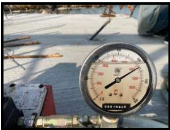
ภาพแสดงงานดึงลวดอัดแรงตามขวาง งาน Balance P8 Type J-J
