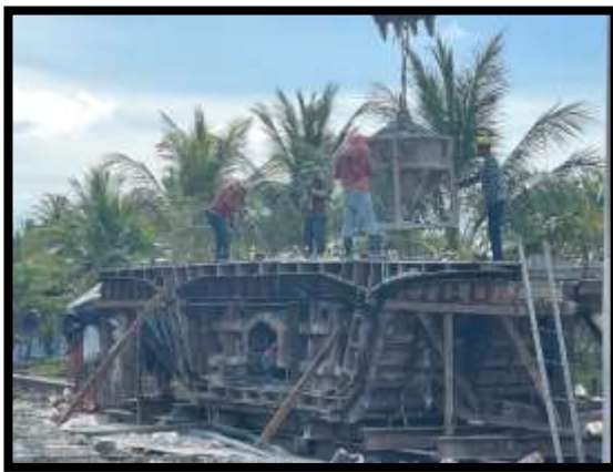
ภาพแสดงงานเทคอนกรีต Pier Head P12
