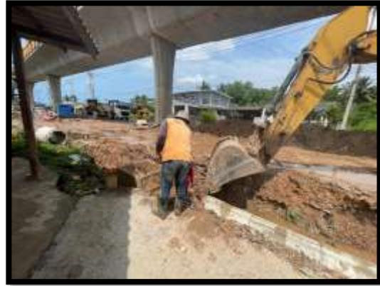
ภาพแสดงงานวางท่อ คสล. ขนาด \varnothing 0.60 ม.งานบ่อพักชุมชน
