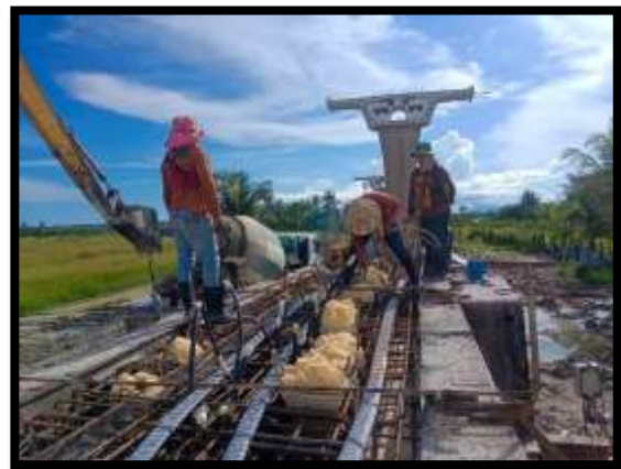
ภาพแสดงงานเทคอนกรีต Pier Head P12
