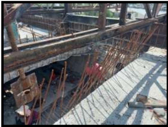
ภาพแสดงงานดึงลวดอัดแรงตามยาว งาน Balance P8 Type J-J
