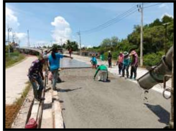
ภาพแสดงงานเทคอนกรีตพื้นทาง Sta.0+601.750 ถึง Sta.0+650.494
