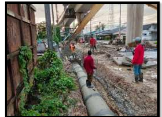
ภาพแสดงงานเทคอนกรีตรัดท่อ คสล. งานบ่อพักชุมชน
