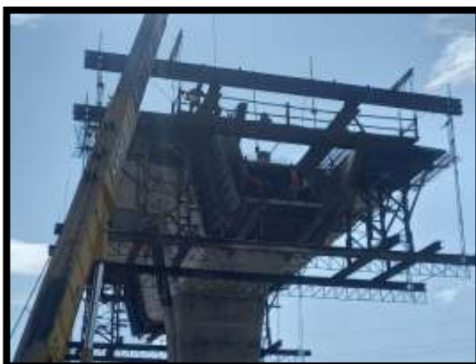
ภาพแสดงงานผูกเหล็กพื้นล่างและผนังข้าง งาน Balance P10 Type B-B
