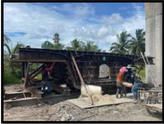
ภาพแสดงงานเข้าแบบ Pier Head P12
