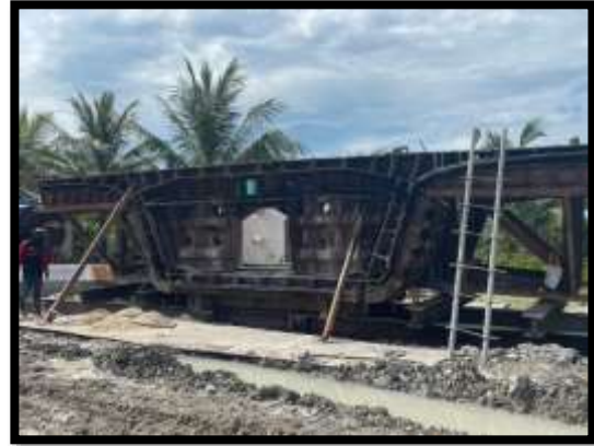
ภาพแสดงงานเข้าแบบ Pier Head P12
