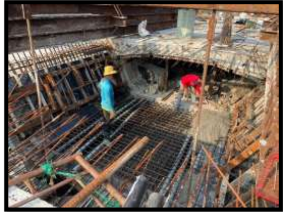
ภาพแสดงงานเทคอนกรีตพื้นล่าง งาน Balance P8 Type J-J
