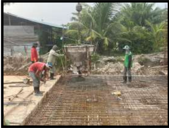
ภาพแสดงงานเทคอนกรีตพื้นล่าง งาน Transition (ฝั่งเกาะ)
