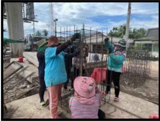
ภาพแสดงงานผูกเหล็กบ่อพัก งานบ่อพักสะพาน
