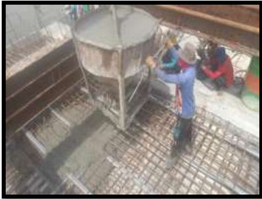
ภาพแสดงงานเทคอนกรีต งาน Balance 10 Type B-B
