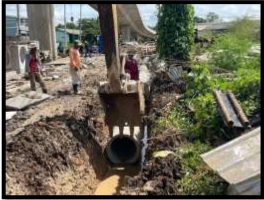
ภาพแสดงงานวางท่อ คสล. ขนาด \varnothing 0.60 ม.งานบ่อพักชุมชน
