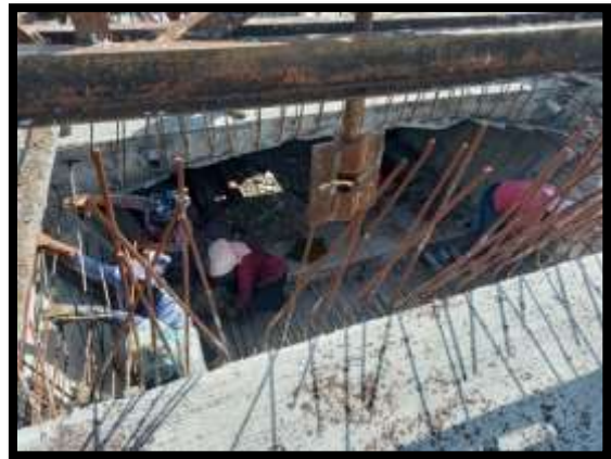
ภาพแสดงงานดึงลวดอัดแรงตามยาว งาน Balance P8 Type J-J
