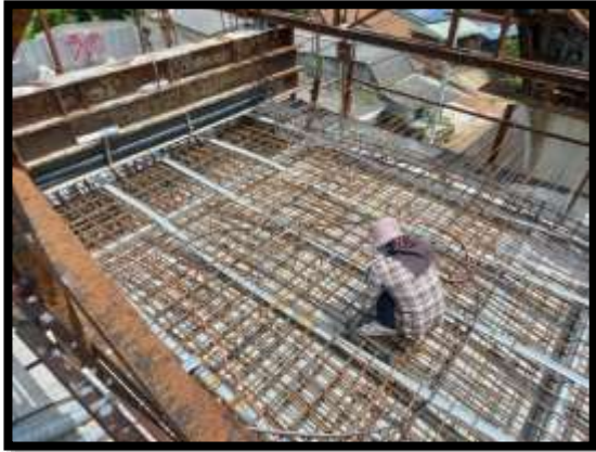
ภาพแสดงงานติดตั้งท่อร้อยลวดอัดแรงตามขวางและตามยาว งาน Balance P8 Type J-J
