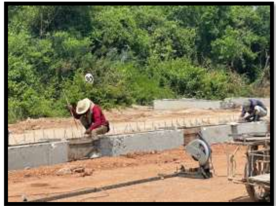
ภาพแสดงงานเข้าแบบบรอยต่อรางน้ำ งาน Transition (ฝั่งแผ่นดิน)
