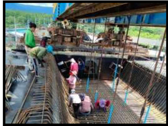
ภาพแสดงงานผูกเหล็กพื้นล่างและผนังข้าง งาน Side Span ช่วง P7-P8
