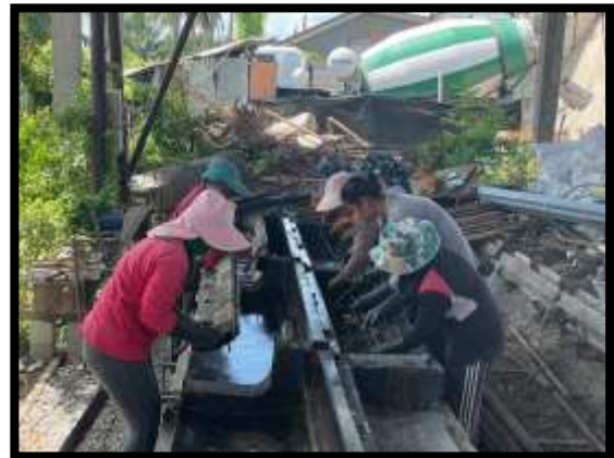
ภาพแสดงงานผูกเหล็กค้ำหินปิดทางเท้า
