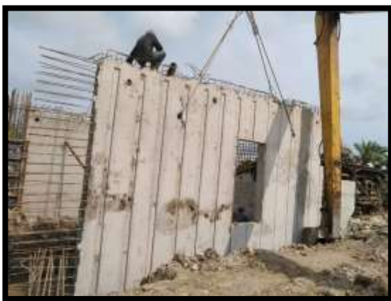
ภาพแสดงงานติดตั้งผนัง งาน Abutment (ฝั่งเกาะ)
