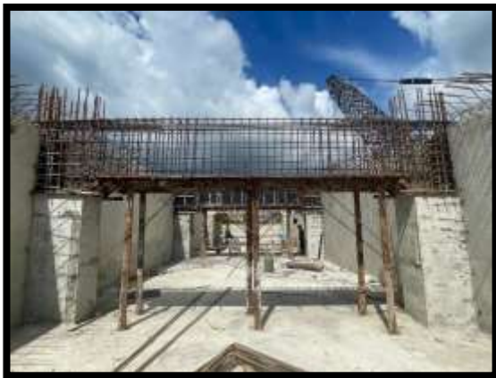
ภาพแสดงงานติดตั้งเหล็กคาน งาน Abutment (ฝั่งเกาะ)
