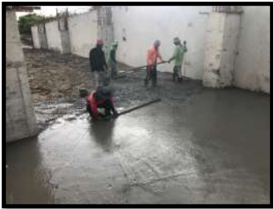
ภาพแสดงงานเทคอนกรีตหยาบ งาน Abutment (ฝั่งเกาะ)
