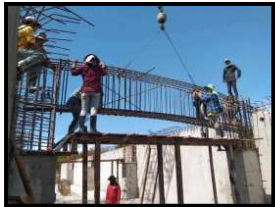
ภาพแสดงงานติดตั้งเหล็กคาน งาน Abutment (ฝั่งเกาะ)
