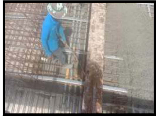
ภาพแสดงงานเทคอนกรีต งาน Balance 10 Type B-B
