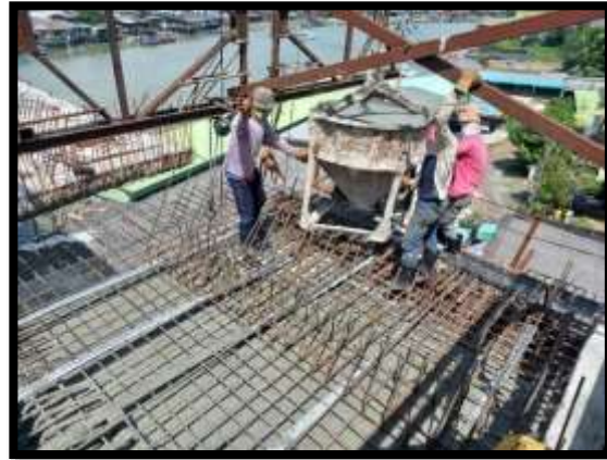
ภาพแสดงงานเทคอนกรีตพื้นบน งาน Balance P8 Type J-J
