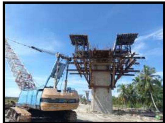
ภาพแสดงงานติดตั้ง Form Traveler P11
