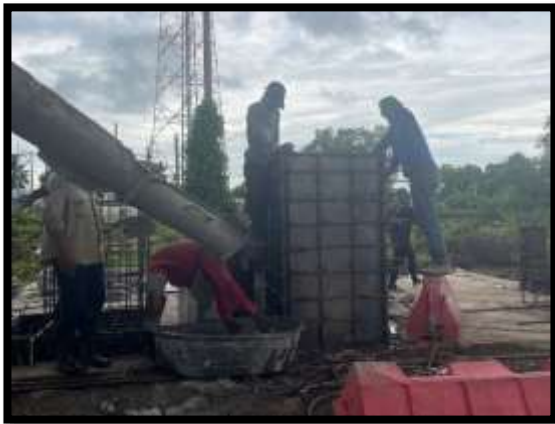
ภาพแสดงงานเข้าแบบพร้อมเทคอนกรีตบ่อพัก งานบ่อพักสะพาน
