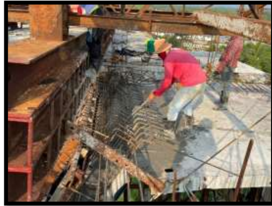
ภาพแสดงงานเทคอนกรีตผนังข้าง งาน Balance P8 Type J-J
