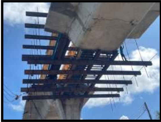
ภาพแสดงงานติดตั้งนั่งร้านและให้ระดับพร้อมติดตั้งแบบพื้นล่าง งาน Side Span ช่วง P7-P8
