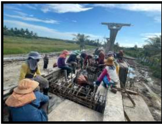
ภาพแสดงงานผูกเหล็ก Pier Head P12
