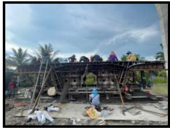
ภาพแสดงงานผูกเหล็ก Pier Head P12
