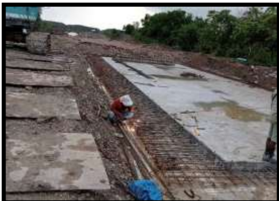
ภาพแสดงงานผูกเหล็กพื้นล่าง งาน Transition (ฝั่งเกาะ)
