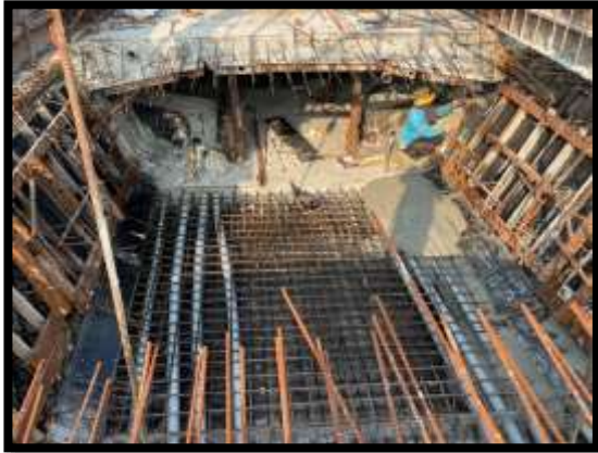
ภาพแสดงงานเทคอนกรีตพื้นล่าง งาน Balance P8 Type J-J
