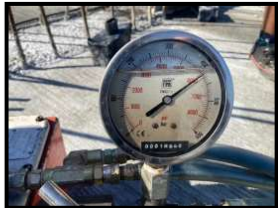
ภาพแสดงงานดึงลวดอัดแรงตามขวาง งาน Balance P10 Type B-B
