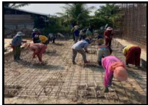
ภาพแสดงงานผูกเหล็กพื้นล่าง งาน Transition (ฝั่งเกาะ)
