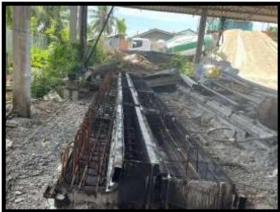
ภาพแสดงงานผูกเหล็กค้ำหินปิดทางเท้า
