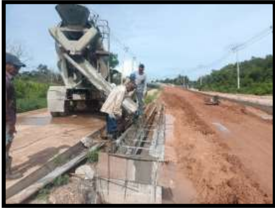
ภาพแสดงงานเทคอนกรีตรางน้ำ งาน กำแพงกันดิน (ฝั่งแผ่นดิน)
