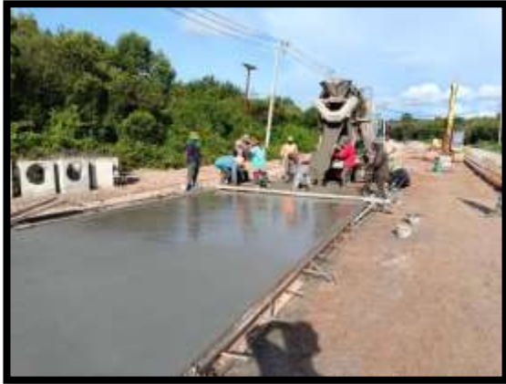
ภาพแสดงงานเทคอนกรีตพื้นทาง Sta.0+601.750 ถึง Sta.0+650.494
