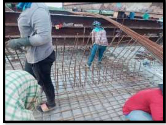
ภาพแสดงงานผูกเหล็กพื้นบน งาน Balance P10 Type B-B
