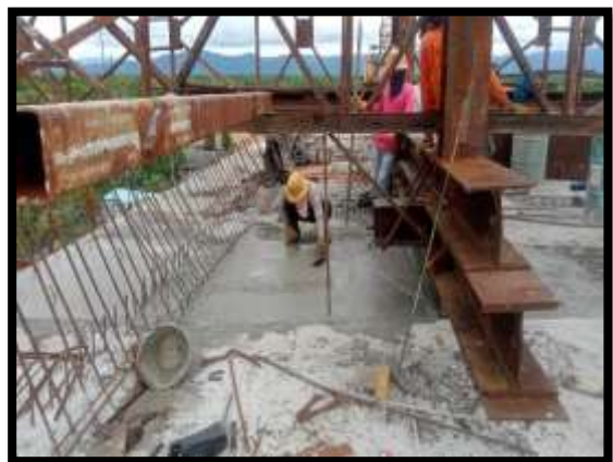
ภาพแสดงงานเทคอนกรีตพื้นบน งาน Balance P8 Type K-K
