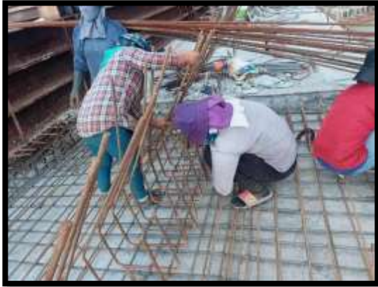
ภาพแสดงงานผูกเหล็กพื้นบน งาน Balance P10 Type B-B
