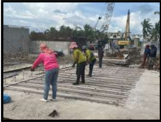
ภาพแสดงงานผูกเหล็กผนัง งาน Abutment (ฝั่งเกาะ)
