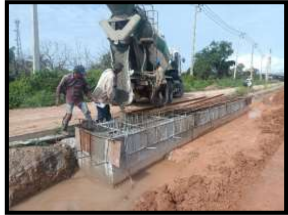
ภาพแสดงงานเทคอนกรีตรางน้ำ งาน กำแพงกันดิน (ฝั่งแผ่นดิน)
