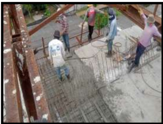
ภาพแสดงงานเทคอนกรีตพื้นบน งาน Balance P8 Type K-K
