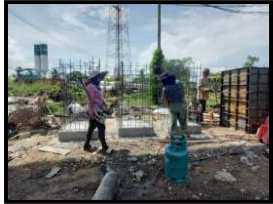
ภาพแสดงงานผูกเหล็กบ่อพัก งานบ่อพักสะพาน
