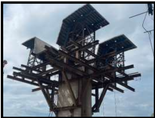
ภาพแสดงงานติดตั้ง Form Traveler P11
