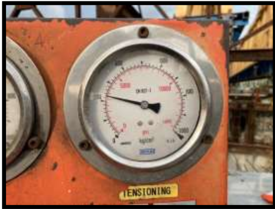
ภาพแสดงงานดึงลวดอัดแรงตามยาว งาน Balance P8 Type J-J
