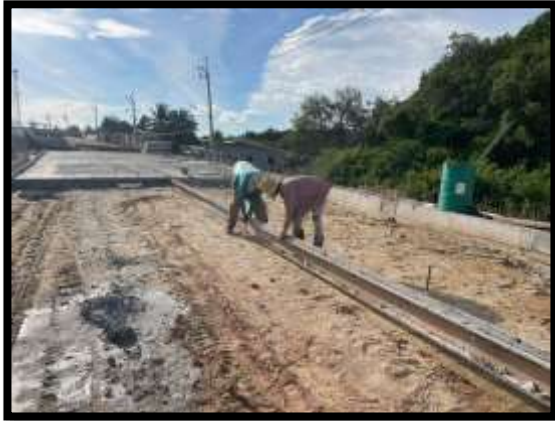
ภาพแสดงงานเข้าแบบข้างพื้นที่ทาง Sta.0+601.750 ถึง Sta.0+650.494
