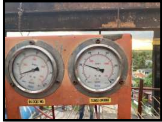
ภาพแสดงงานติดตั้งอัดแรงตามยาว งาน Balance P10 Type B-B
