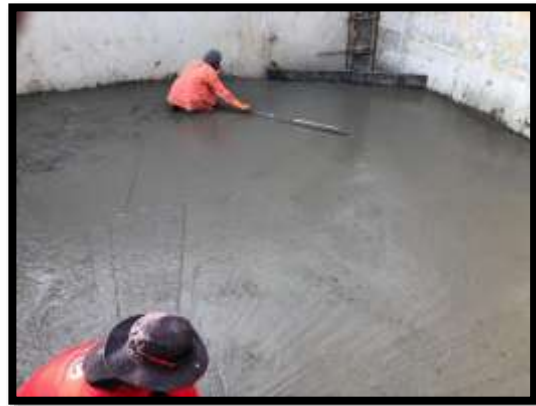
ภาพแสดงงานเทคอนกรีตหยาบ งาน Abutment (ฝั่งเกาะ)
