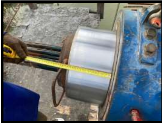
ภาพแสดงงานดัดลวดอัดแรงตามยาว งาน Balance P10 Type A-A
