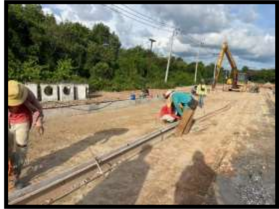
ภาพแสดงงานเข้าแบบข้างพื้นที่ทาง Sta.0+601.750 ถึง Sta.0+650.494
