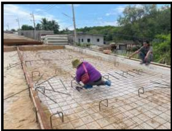
ภาพแสดงงานผูกเหล็กพื้นทาง Sta.0+601.750 ถึง Sta.0+650.494
