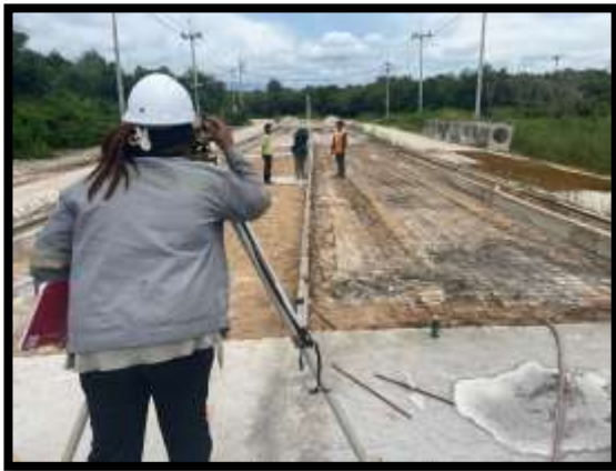
ภาพแสดงงานตรวจสอบระดับแบบข้างพื้นที่ทาง Sta.0+601.750 ถึง Sta.0+650.494
