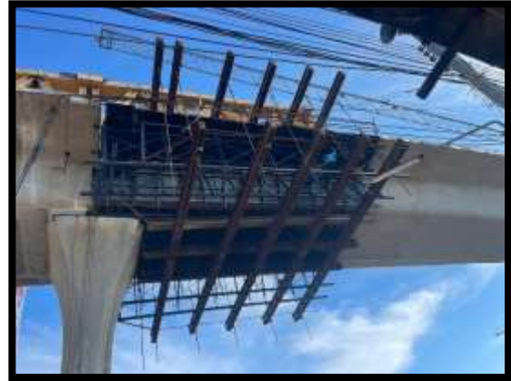
ภาพแสดงงานติดตั้งนั่งร้านและให้ระดับพร้อมติดตั้งแบบพื้นล่าง งาน Side Span ช่วง P7-P8
