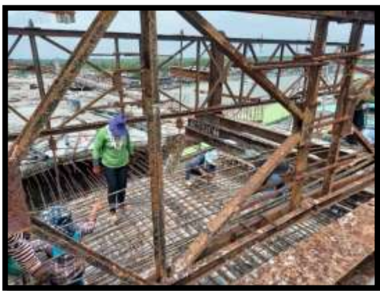
ภาพแสดงงานผูกเหล็กพื้นบน งาน Balance P8 Type J-J
