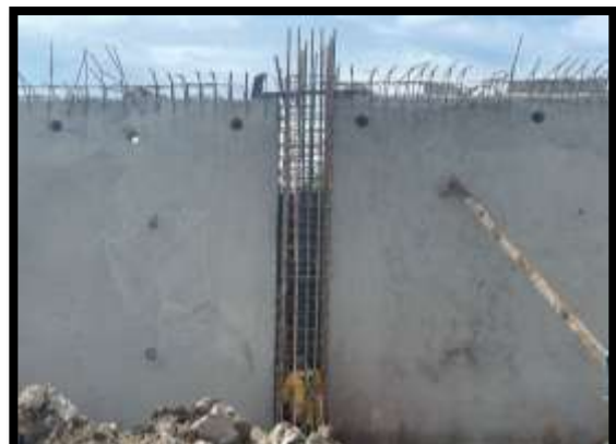
ภาพแสดงงานผูกเหล็กรอยต่อระหว่างผนัง งาน Abutment (ฝั่งเกาะ)
