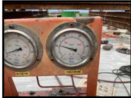
ภาพแสดงงานดัดลวดอัดแรงตามยาว งาน Balance P10 Type A-A
