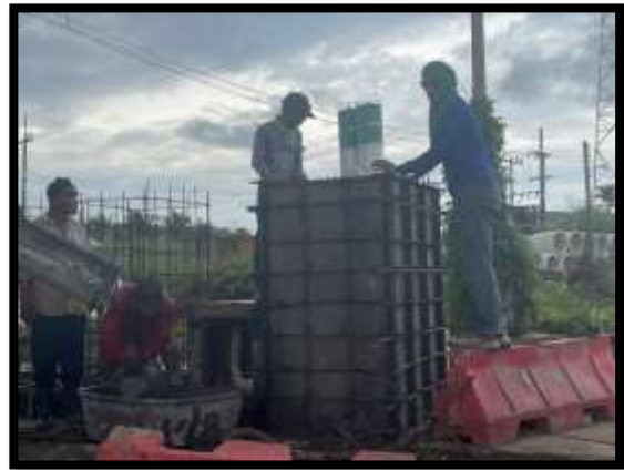
ภาพแสดงงานเข้าแบบพร้อมเทคอนกรีตบ่อพัก งานบ่อพักสะพาน
