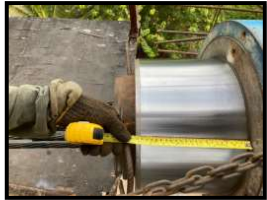
ภาพแสดงงานดึงลวดอัดแรงตามยาว งาน Balance P8 Type J-J
