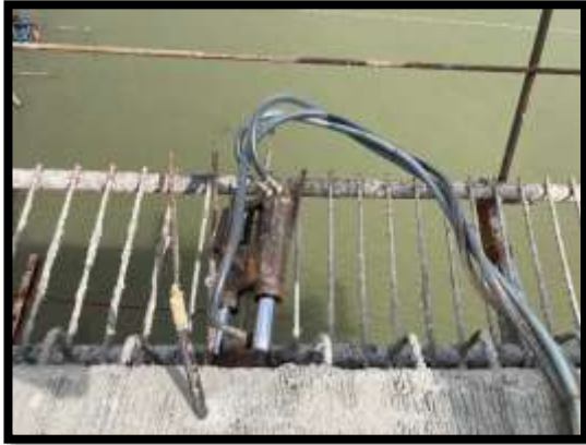
ภาพแสดงงานดัดลวดอัดแรงตามขวาง งาน Balance P10 Type A-A
