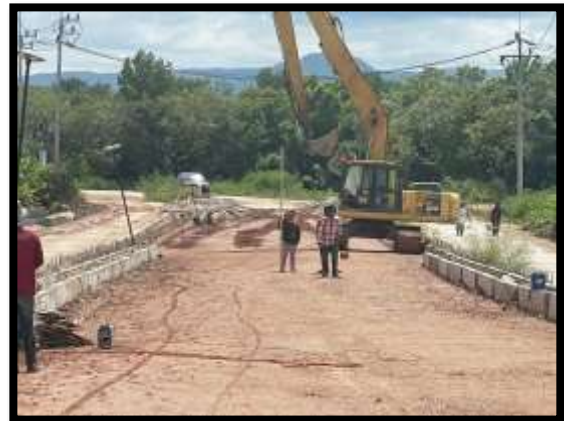
ภาพแสดงงานใช้ระดับชั้นรองพื้นทาง ความหนา 0.20 ม. งาน Transition และ งานกำแพงกันดิน
