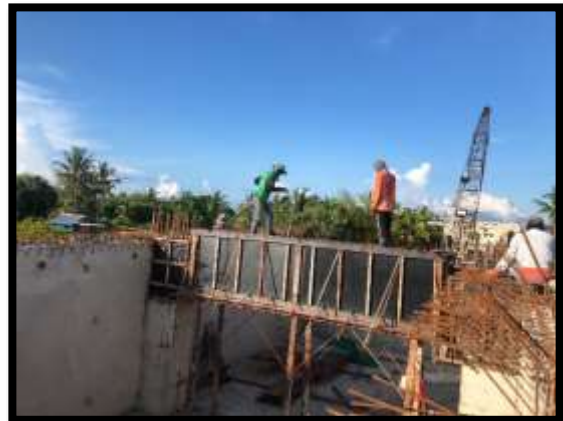
ภาพแสดงงานเทคอนกรีตคาน งาน Abutment (ฝั่งเกาะ)
