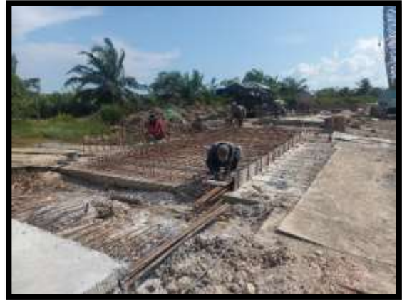
ภาพแสดงงานผูกเหล็กผนัง งาน Abutment (ฝั่งเกาะ)
