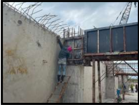
ภาพแสดงงานเข้าแบบคาน งาน Abutment (ฝั่งเกาะ)
