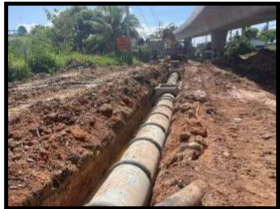
ภาพแสดงงานเกร้าท์ปูนหลังท่อ คสล. ขนาด \varnothing 0.60 ม. งานบ่อพักชุมชน
