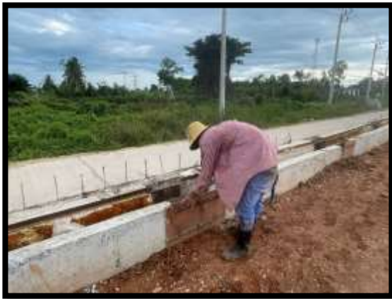
ภาพแสดงงานเข้าแบบบรอยต่อรางน้ำ งาน Transition (ฝั่งแผ่นดิน)
