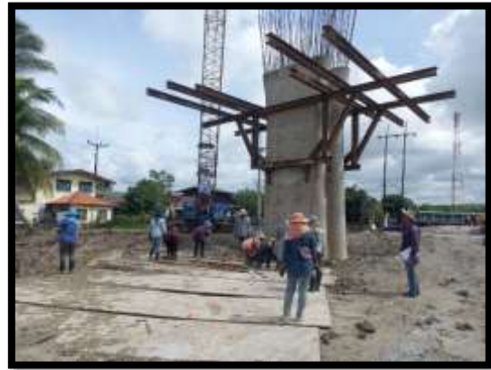
ภาพแสดงงานติดตั้งอัดแรงตามยาว งาน Balance P10 Type B-B
