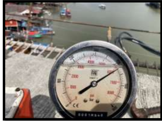
ภาพแสดงงานดัดลวดอัดแรงตามขวาง งาน Balance P10 Type A-A
