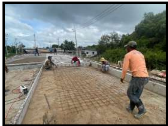
ภาพแสดงงานผูกเหล็กพื้นทาง Sta.0+601.750 ถึง Sta.0+650.494
