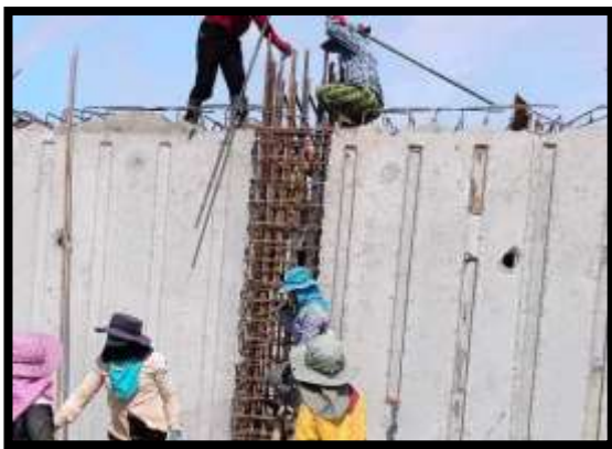
ภาพแสดงงานผูกเหล็กรอยต่อระหว่างผนัง งาน Abutment (ฝั่งเกาะ)
