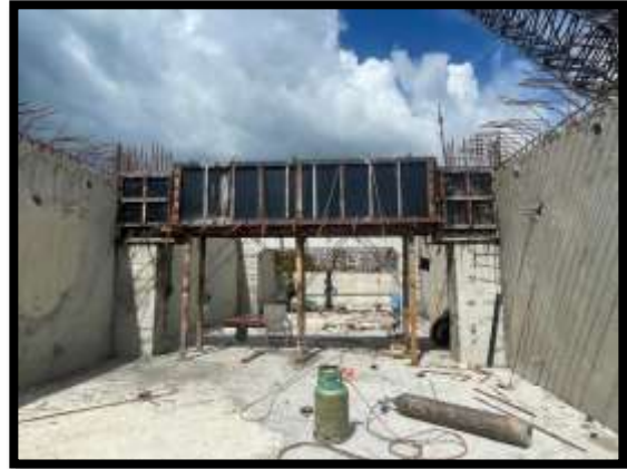
ภาพแสดงงานเข้าแบบคาน งาน Abutment (ฝั่งเกาะ)
