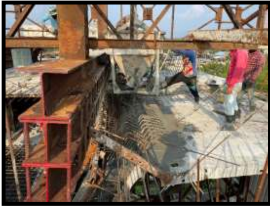
ภาพแสดงงานเทคอนกรีตผนังข้าง งาน Balance P8 Type J-J
