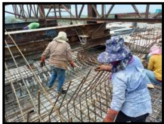
ภาพแสดงงานผูกเหล็กพื้นบน งาน Balance P8 Type J-J
