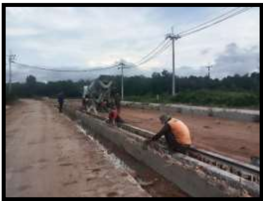
ภาพแสดงงานเทคอนกรีตรอยต่อรางน้ำ งาน Transition (ฝั่งแผ่นดิน)
