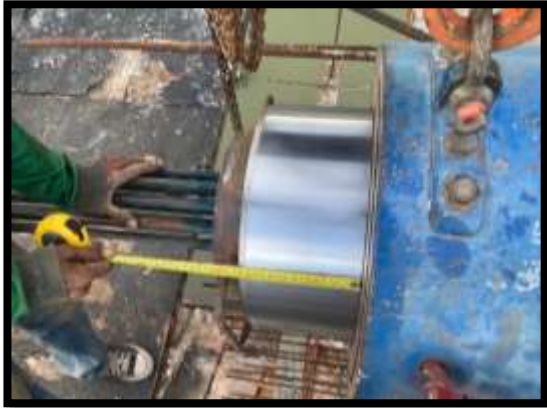
ภาพแสดงงานติดตั้งอัดแรงตามยาว งาน Balance P10 Type B-B
