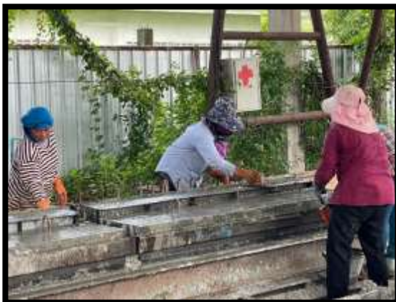
ภาพแสดงงานเทคอนกรีตค้ำหินปิดทางเท้า
