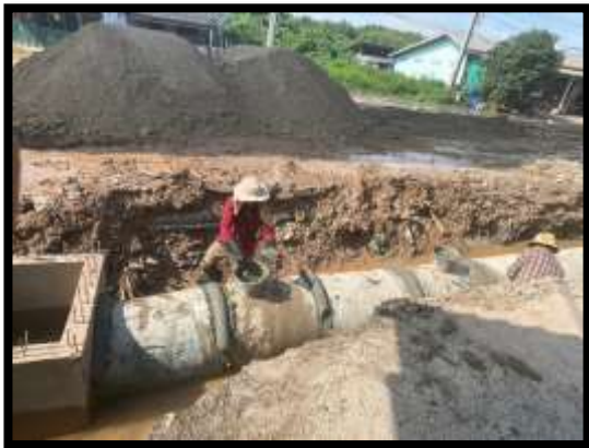
ภาพแสดงงานเกร้าท์ปูนหลังท่อ คสล. ขนาด \varnothing 0.60 ม. งานบ่อพักชุมชน
