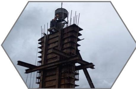
งานเทคอนกรีต โครงสร้างเสาตอม่อ P11
