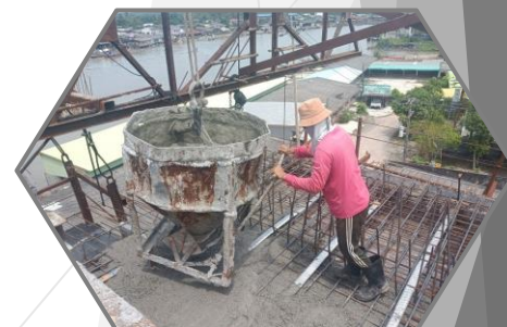
งานเทคอนกรีต Balance P8 Type I-I'
