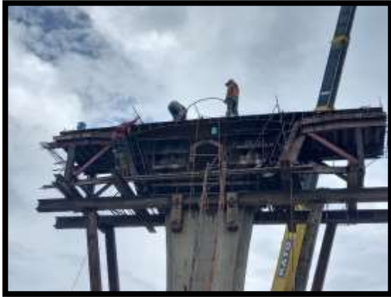
ภาพแสดงงานผูกเหล็ก Pier Head P13
