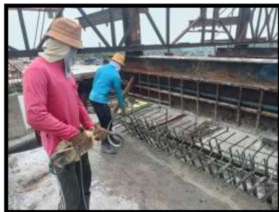
ภาพแสดงงานเทคอนกรีตผนังข้าง งาน Balance P8 Type I-I
