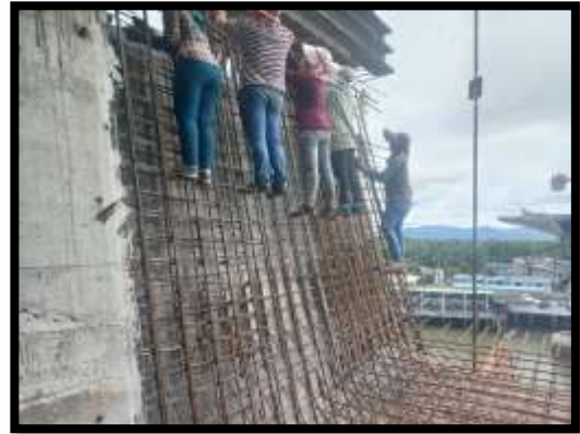
ภาพแสดงงานผูกเหล็กพื้นล่างและผนังข้าง งาน Balance 10 Type A-A
