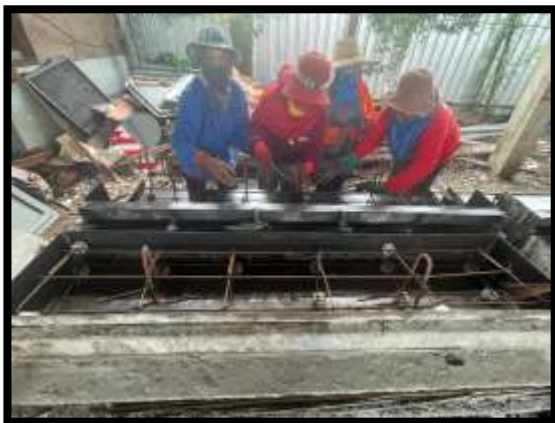
ภาพแสดงงานผูกเหล็กค้ำหินปิดทางเท้า
