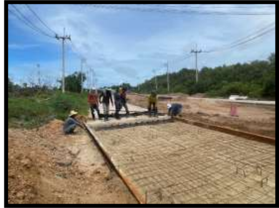
ภาพแสดงงานเข้าแบบผูกเหล็ก งานถนน Sta.0+500 ถึง Sta.0+510 LT
