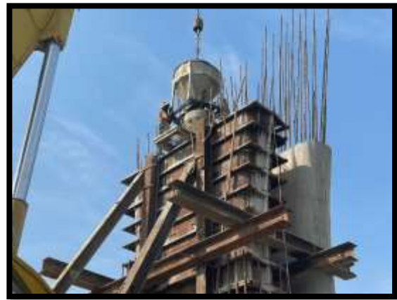
ภาพแสดงงานเทคอนกรีตโครงสร้างเสาตอม่อ P11
