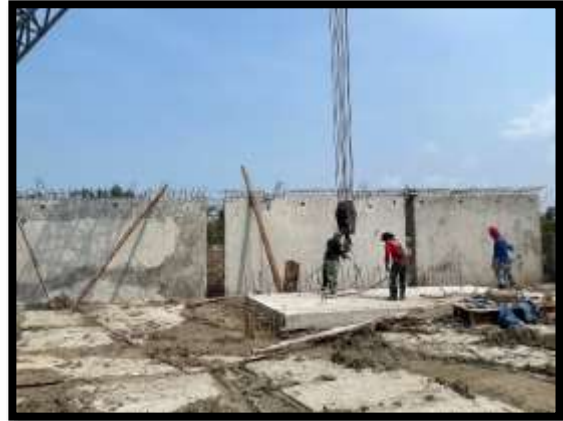
ภาพแสดงงานติดตั้งผนัง งาน Abutment (ฝั่งเกาะ)
