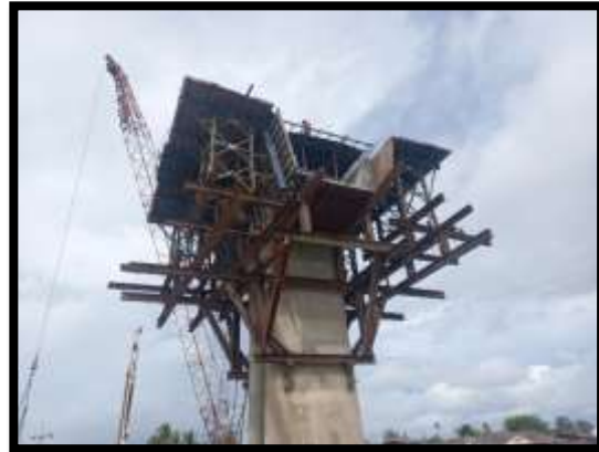
ภาพแสดงงานผูกเหล็ก งาน Pier Head P10
