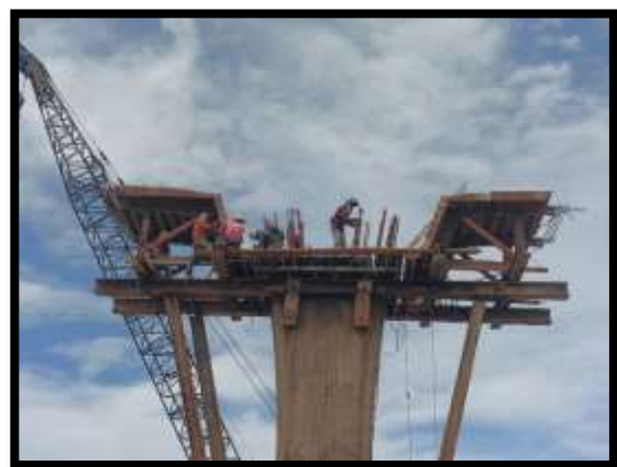
ภาพแสดงงานเตรียมแบบ Pier Head P13
