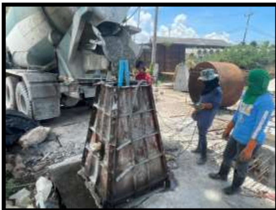
ภาพแสดงงานเทคอนกรีตฐานเสาไฟฟ้า
