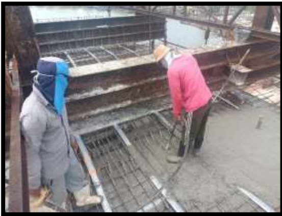
ภาพแสดงงานผูกเหล็กพื้นบน งาน Balance P8 Type I-I
