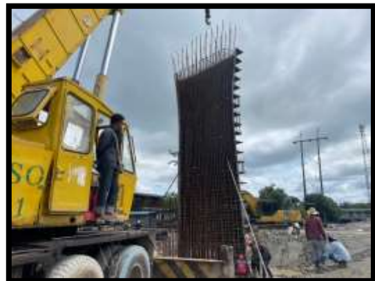
ภาพแสดงงานผูกเหล็กพื้นบน งาน Balance P10 Type A-A
