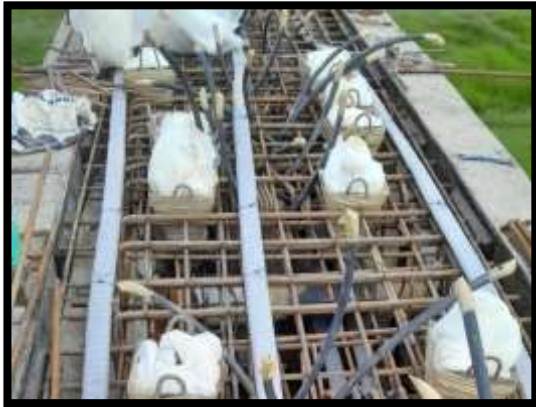
ภาพแสดงงานติดตั้งท่อร้อยลวดอัดแรง Pier Head P13
