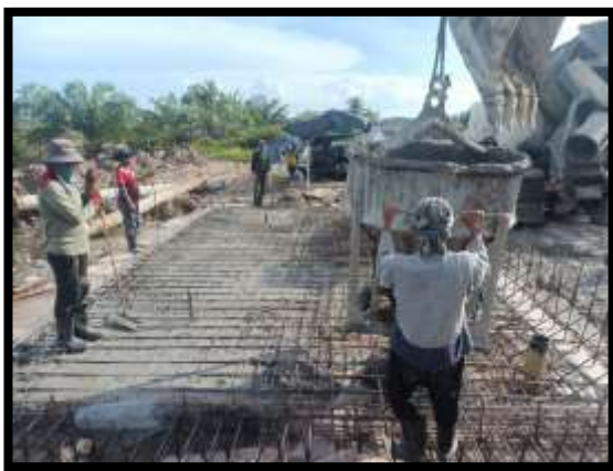
ภาพแสดงงานเทคอนกรีตผนัง งาน Abutment (ฝั่งเกาะ)
