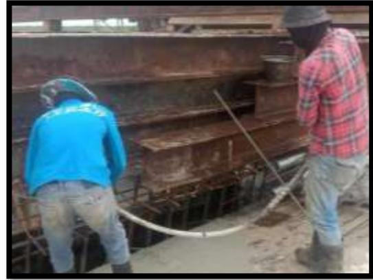
ภาพแสดงงานเทคอนกรีตผนังข้าง งาน Balance P10 Type A-A
