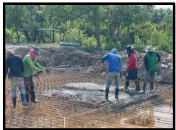
ภาพแสดงงานเทคอนกรีตพื้น งาน Transition (ฝั่งเกาะ)
