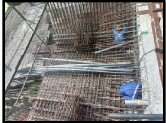
ภาพแสดงงานผูกเหล็กพื้นล่างและผนังข้าง งาน Balance P8 Type I-I
