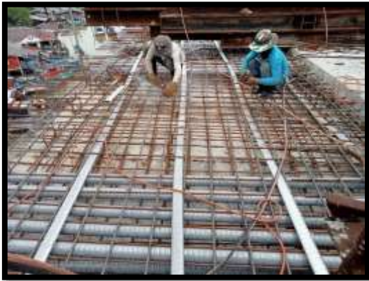
ภาพแสดงงานผูกเหล็กพื้นบน งาน Balance P10 Type A-A
