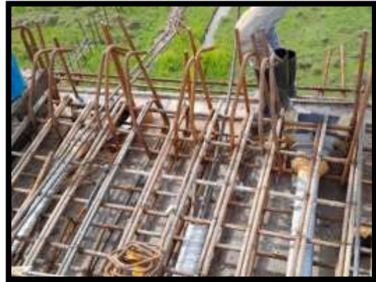
ภาพแสดงงานติดตั้งท่อร้อยลวดอัดแรง Pier Head P13
