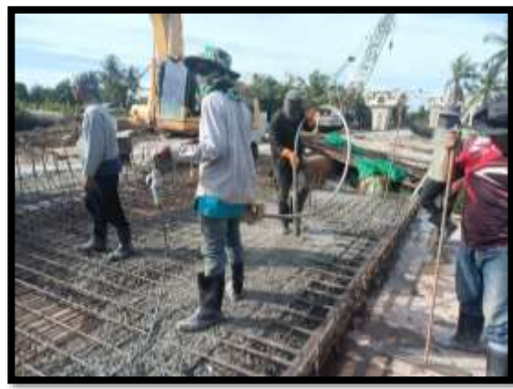
ภาพแสดงงานเทคอนกรีตผนัง งาน Abutment (ฝั่งเกาะ)
