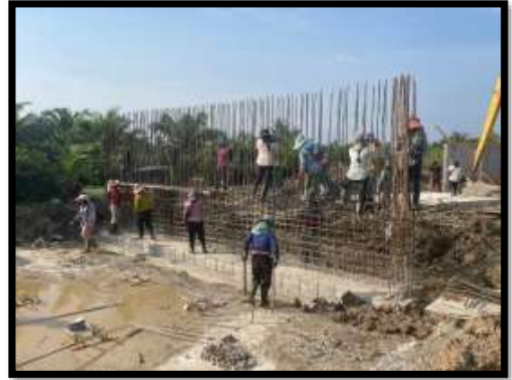
ภาพแสดงงานผูกเหล็กคาน ช่วงท้าย งาน Abutment (ฝั่งเกาะ)
