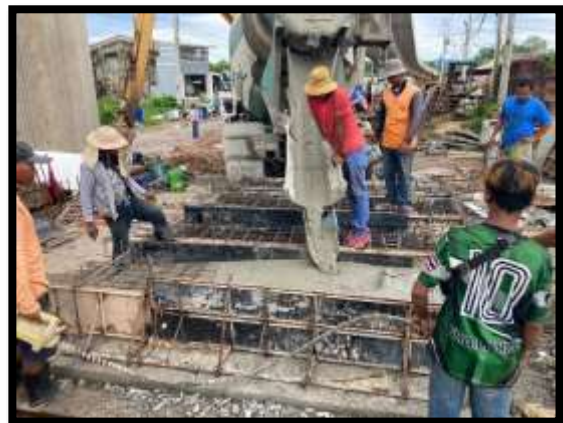
ภาพแสดงงานเทคอนกรีตวางน้ำ
