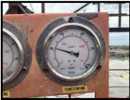
ภาพแสดงงานดึงลวดอัดแรงตามยาว งาน Balance P8 Type H-H
