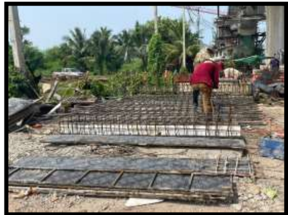
ภาพแสดงงานเข้าแบบ ผูกเหล็กวางน้ำ
