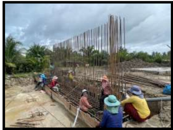
ภาพแสดงงานเข้าแบบผูกเหล็กฐานราก ช่วงท้าย งาน Abutment (ฝั่งเกาะ)
