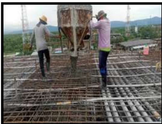
ภาพแสดงงานเทคอนกรีต งาน Pier Head P10
