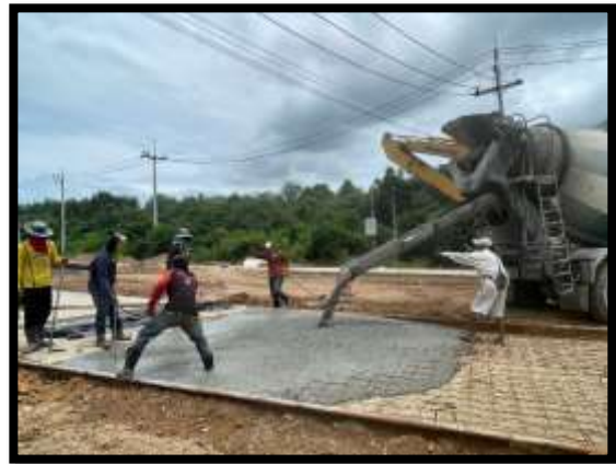
ภาพแสดงงานเทคอนกรีต งานถนน Sta.0+500 ถึง Sta.0+510 LT
