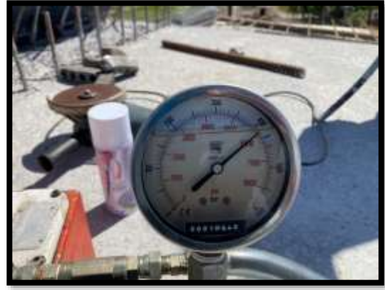
ภาพแสดงงานติดตั้งลวดอัดแรงตามขวาง งาน Pier Head P10
