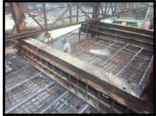
ภาพแสดงงานผูกเหล็กพื้นบน งาน Balance P8 Type I-I
