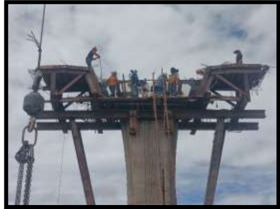
ภาพแสดงงานผูกเหล็ก Pier Head P13
