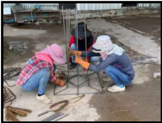
ภาพแสดงงานผูกเหล็กฐานเสาไฟฟ้า
