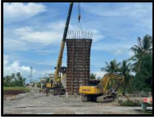
ภาพแสดงงานเข้าแบบโครงสร้างเสาตอม่อ P11
