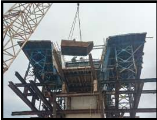
ภาพแสดงงานผูกเหล็ก งาน Pier Head P10
