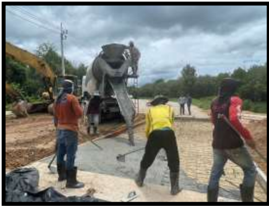
ภาพแสดงงานเทคอนกรีต งานถนน Sta.0+500 ถึง Sta.0+510 LT
