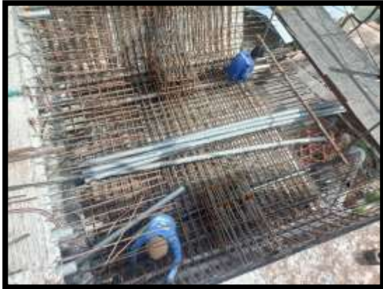
ภาพแสดงงานผูกเหล็กพื้นล่างและผนังข้าง งาน Balance P8 Type I-I
