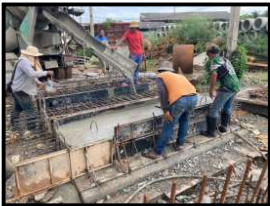
ภาพแสดงงานเทคอนกรีตวางน้ำ
