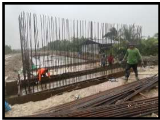
ภาพแสดงงานเทคอนกรีต ฐานราก ช่วงท้าย งาน Abutment (ฝั่งเกาะ)
