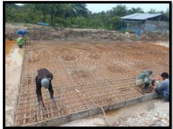
ภาพแสดงงานผูกเหล็กพื้น งาน Transition (ฝั่งเกาะ)
