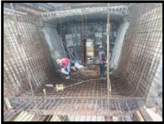
ภาพแสดงงานผูกเหล็กพื้นล่างและผนังข้าง งาน Balance 10 Type A-A
