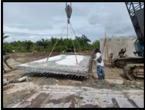
ภาพแสดงงานติดตั้งผนัง งาน Abutment (ฝั่งเกาะ)
