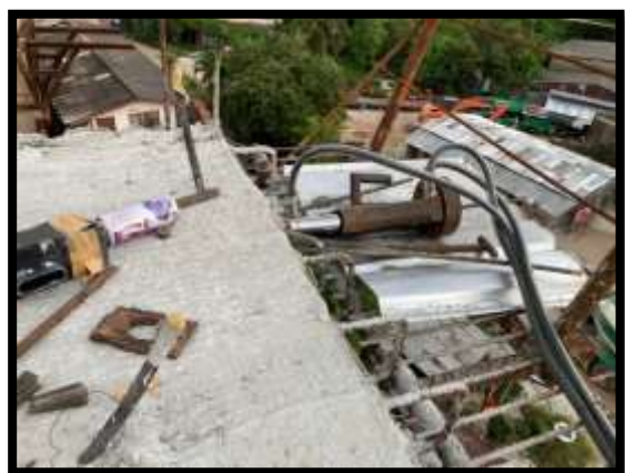
ภาพแสดงงานดึงลวดอัดแรงตามขวาง งาน Balance P8 Type I-I
