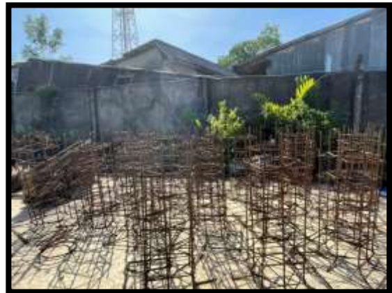
ภาพแสดงงานผูกเหล็กฐานเสาไฟฟ้า
