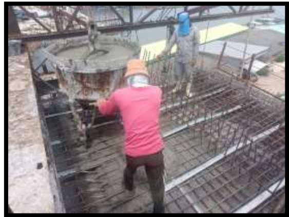
ภาพแสดงงานผูกเหล็กพื้นบน งาน Balance P8 Type I-I
