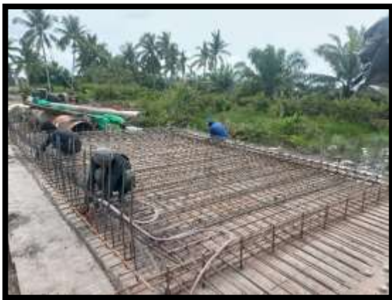
ภาพแสดงงานผูกเหล็กผนัง งาน Abutment (ฝั่งเกาะ)
