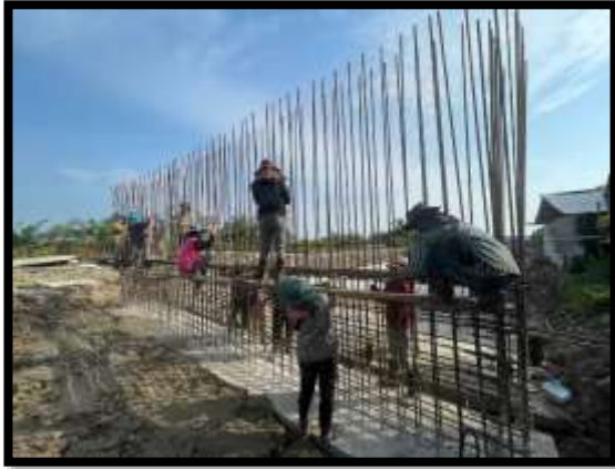
ภาพแสดงงานผูกเหล็กคาน ช่วงท้าย งาน Abutment (ฝั่งเกาะ)
