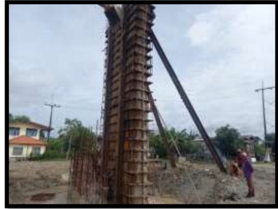
ภาพแสดงงานเข้าแบบโครงสร้างเสาตอม่อ P11
