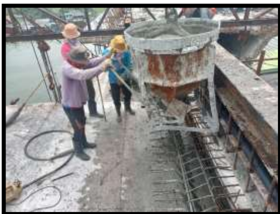
ภาพแสดงงานเทคอนกรีตผนังข้าง งาน Balance P8 Type I-I
