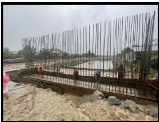
ภาพแสดงงานเทคอนกรีต ฐานราก ช่วงท้าย งาน Abutment (ฝั่งเกาะ)
