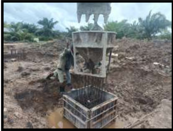
ภาพแสดงงานเทคอนกรีตฐานราก P18 งาน Abutment (ฝั่งเกาะ)
