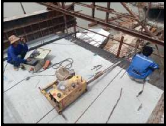
ภาพแสดงงานดึงลวดอัดแรงตามขวาง งาน Balance P8 Type H-H
