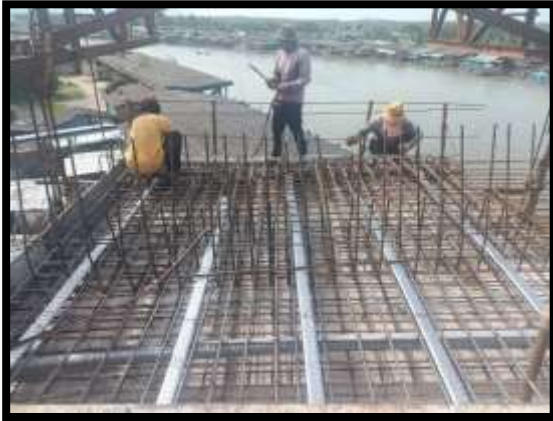
ภาพแสดงงานผูกเหล็กพื้นบน งาน Balance P8 Type I-I
