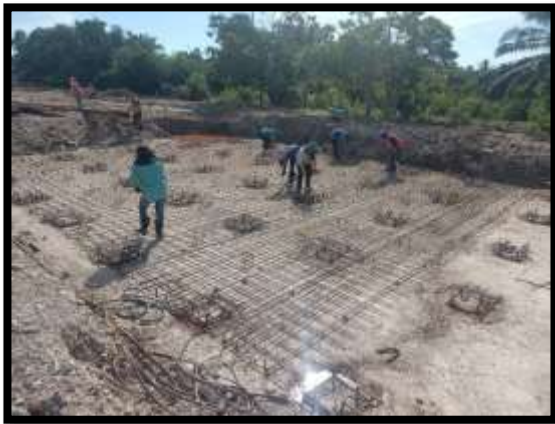
ภาพแสดงงานผูกเหล็กพื้น งาน Transition (ฝั่งเกาะ)
