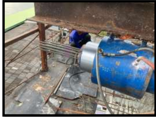
ภาพแสดงงานดึงลวดอัดแรงตามยาว งาน Balance P8 Type H
