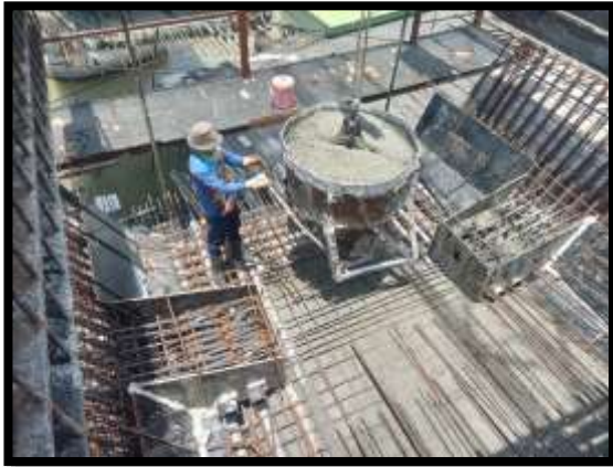
ภาพแสดงงานเทคอนกรีตพื้นล่าง งาน Balance P8 Type I-I
