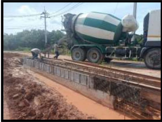
ภาพแสดงงานเทคอนกรีตรางน้ำ งานกำแพงกันดิน
