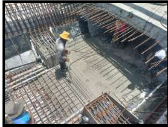
ภาพแสดงงานเทคอนกรีตพื้นล่าง งาน Balance P8 Type I-I
