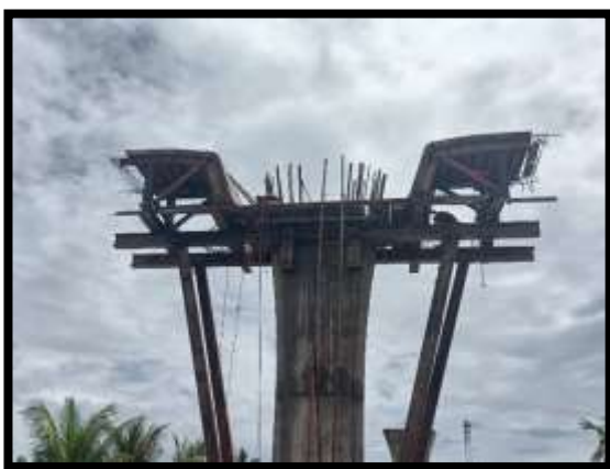
ภาพแสดงงานเตรียมแบบ Pier Head P13
