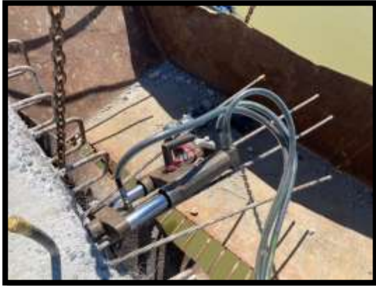
ภาพแสดงงานติดตั้งลวดอัดแรงตามขวาง งาน Pier Head P10
