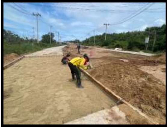
ภาพแสดงงานเข้าแบบผูกเหล็ก งานถนน Sta.0+500 ถึง Sta.0+510 LT
