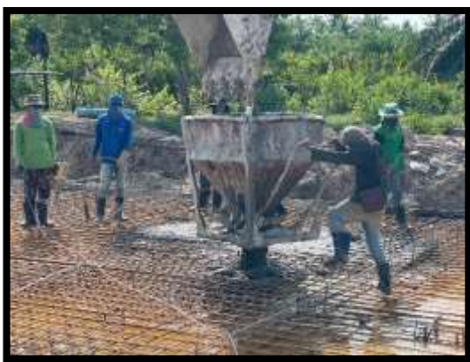
ภาพแสดงงานเทคอนกรีตพื้น งาน Transition (ฝั่งเกาะ)
