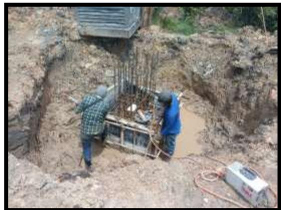
ภาพแสดงงานผูกเหล็กฐานราก P18 งาน Abutment (ฝั่งเกาะ)
