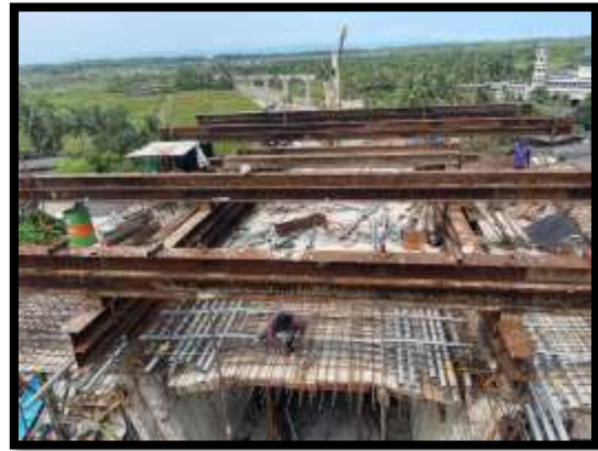
ภาพแสดงงานผูกเหล็กพื้นบน งาน Balance P10 Type A-A
