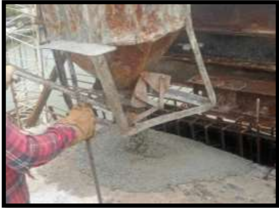
ภาพแสดงงานเทคอนกรีตผนังข้าง งาน Balance P10 Type A-A
