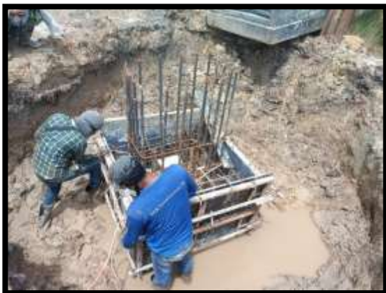
ภาพแสดงงานผูกเหล็กฐานราก P18 งาน Abutment (ฝั่งเกาะ)
