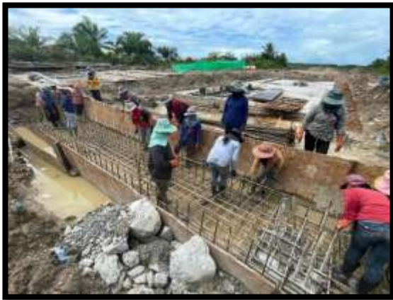
ภาพแสดงงานเข้าแบบผูกเหล็กฐานราก ช่วงท้าย งาน Abutment (ฝั่งเกาะ)
