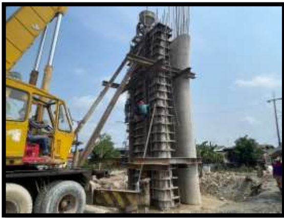
ภาพแสดงงานเทคอนกรีตโครงสร้างเสาตอม่อ P11
