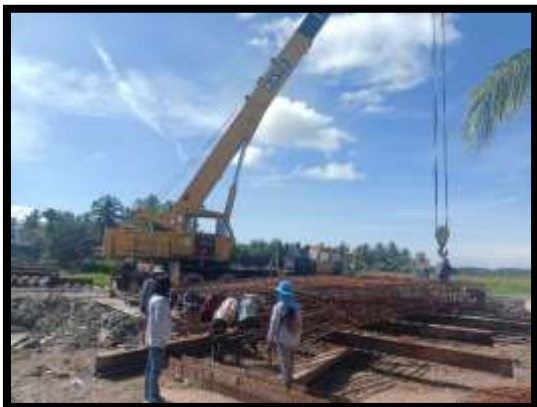
ภาพแสดงงานผูกเหล็กพื้นบน งาน Balance P10 Type A-A
