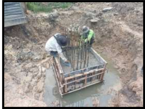
ภาพแสดงงานเทคอนกรีตฐานราก P18 งาน Abutment (ฝั่งเกาะ)
