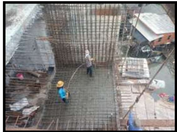
ภาพแสดงงานเทคอนกรีตพื้นล่าง งาน Balance P10 Type A-A
