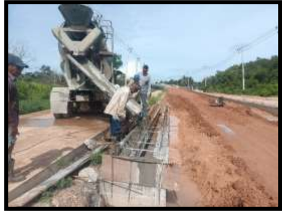
ภาพแสดงงานเทคอนกรีตรางน้ำ งานกำแพงกันดิน
