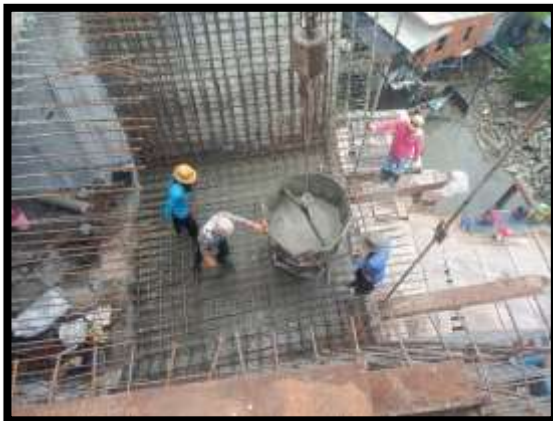
ภาพแสดงงานเทคอนกรีตพื้นล่าง งาน Balance P10 Type A-A
