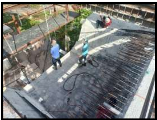
ภาพแสดงงานเตรียมแบบ งาน Balance P8 Type I-I
