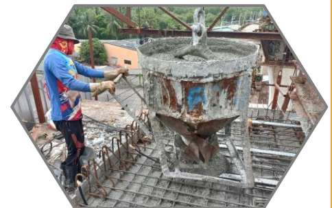
งานเทคอนกรีตพื้นบน Balance P8 Type H-H'
