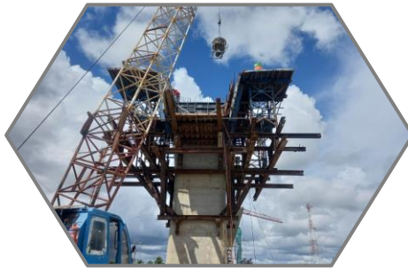
งานเทคอนกรีต พื้นล่าง และผนัง P10
