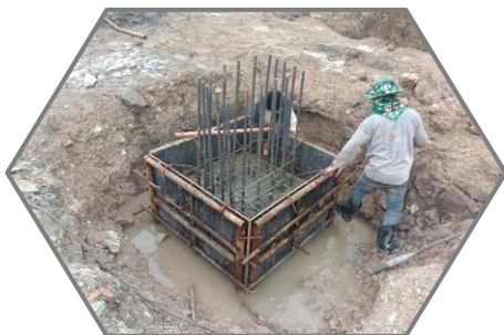
งานเทคอนกรีตฐานราก P18
