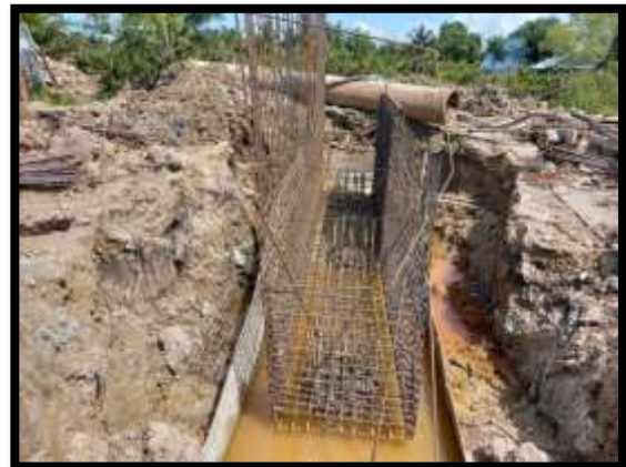
ภาพแสดงงานผูกเหล็กฐานราก P18
