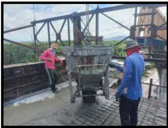
ภาพแสดงงานเทคอนกรีตพื้นบน งาน Balance P8 Type G-G
