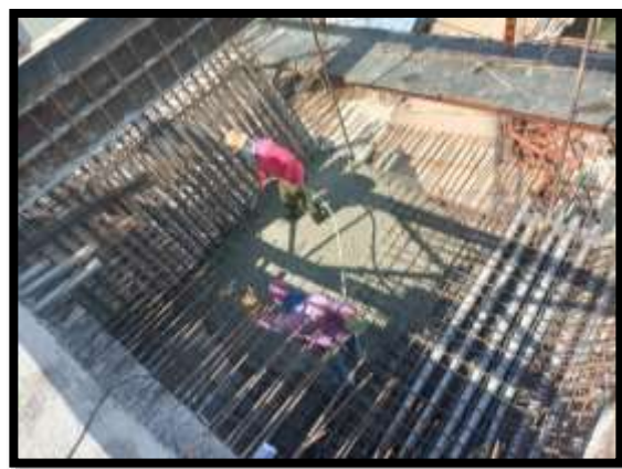
ภาพแสดงงานเทคอนกรีตพื้นล่าง งาน Balance P8 Type H-H
