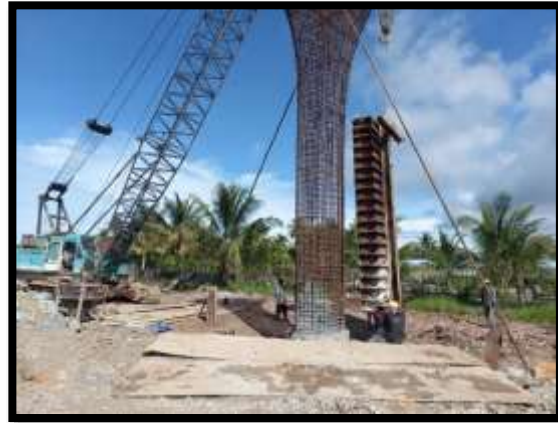
ภาพแสดงงานติดตั้งแบบโครงสร้างเสาตอม่อ P12
