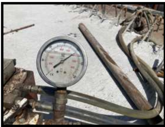
ภาพแสดงงานดึงลวดอัดแรงตามขวาง งาน Balance P8 Type G-G
