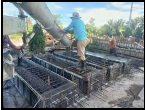
ภาพแสดงงานเทคอนกรีตรางน้ำ งาน Transition
