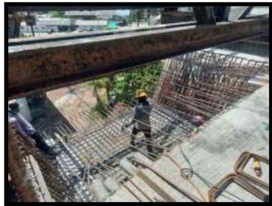
ภาพแสดงงานเทคอนกรีตพื้นล่าง งาน Balance P8 Type G-G
