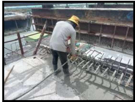
ภาพแสดงงานเทคอนกรีตผนังข้าง งาน Balance P8 Type H-H
