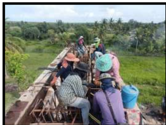
ภาพแสดงงานผูกเหล็ก Pier Head P15
