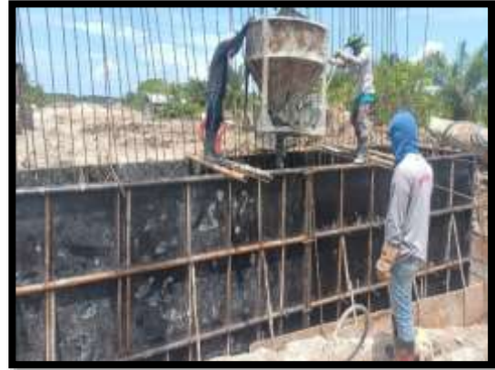
ภาพแสดงงานเทคอนกรีตฐานราก P18
