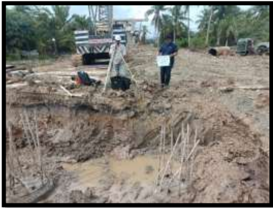
ภาพแสดงงานทดสอบความสมบูรณ์ของเสาเข็มเจาะ ด้วย วิธี Sonic logging P18 (ฝั่งเกาะ)
