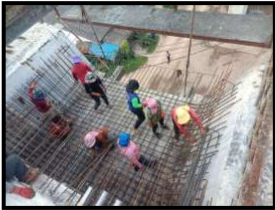
ภาพแสดงงานผูกเหล็กพื้นล่างและผนังข้าง งาน Balance P8 Type G-G
