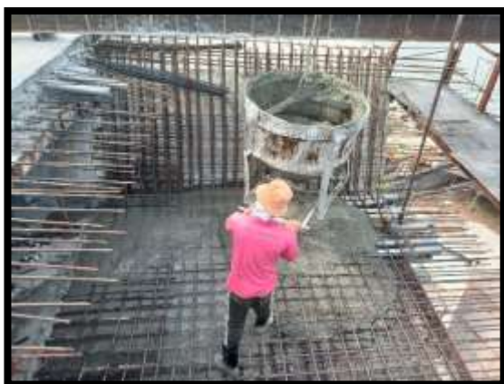
ภาพแสดงงานเทคอนกรีตพื้นล่าง งาน Balance P8 Type H-H
