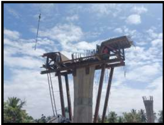
ภาพแสดงงานติดตั้งนั่งร้าน Pier Head P14
