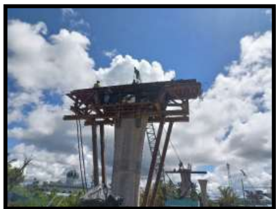
ภาพแสดงงานผูกเหล็ก Pier Head P14
