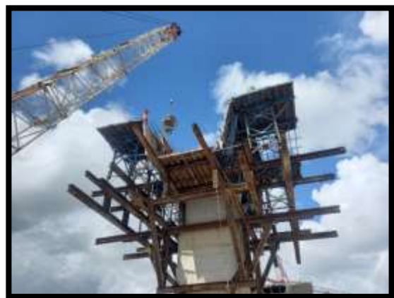
ภาพแสดงงานเทคอนกรีตพื้นล่างและผนังข้าง งาน Balance P10
