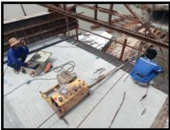
ภาพแสดงงานร้อยลวดอัดแรงตามยาว งาน Balance P8 Type H-H
