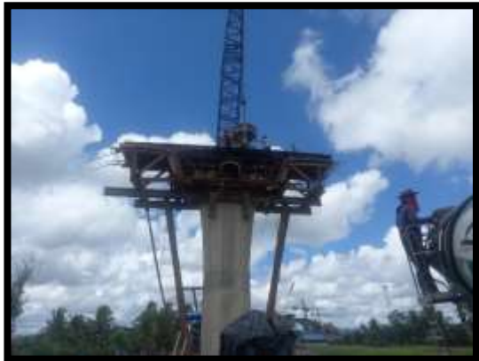
ภาพแสดงงานเทคอนกรีต Pier Head P14
