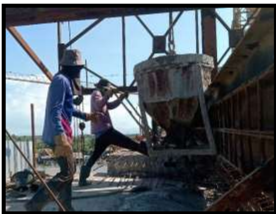
ภาพแสดงงานเทคอนกรีตผนังข้าง งาน Balance P8 Type G-G
