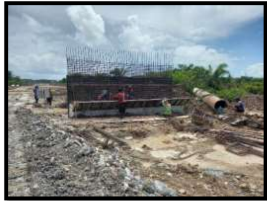
ภาพแสดงงานเทคอนกรีตฐานราก P18
