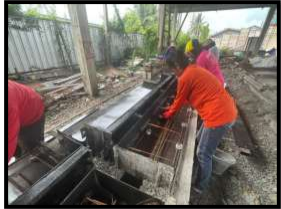
ภาพแสดงงานผูกเหล็กค้ำหินปิดทางเท้า และแบรีเออทางเท้า
