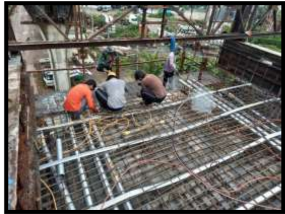
ภาพแสดงงานผูกเหล็กพื้นบนพร้อมติดตั้งท่อร้อยลวดอัดแรงตามขวาง และตามยาว งาน Balance P8 Type G-G
