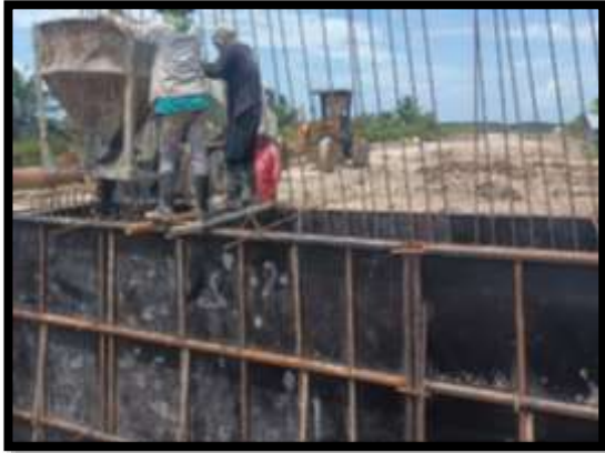
ภาพแสดงงานเทคอนกรีตฐานราก P18
