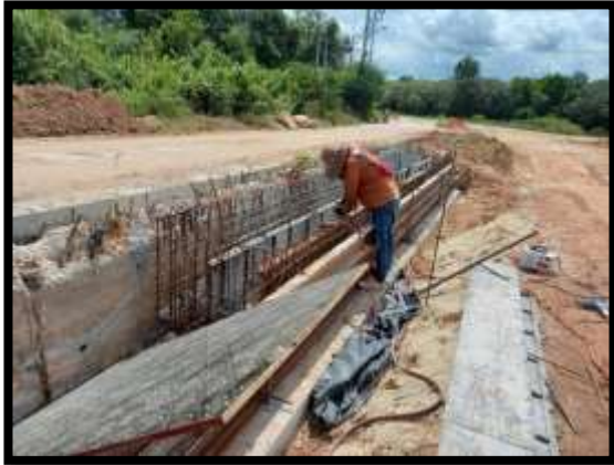
ภาพแสดงงานผูกเหล็กรางน้ำ งานกำแพงกันดิน
