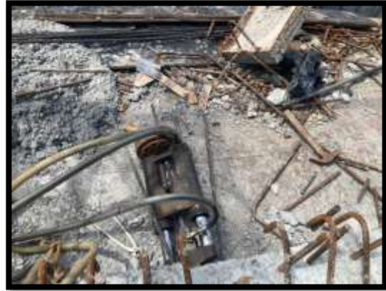
ภาพแสดงงานติดตั้งอัดแรงตามขวาง งาน Balance P8 Type F-F
