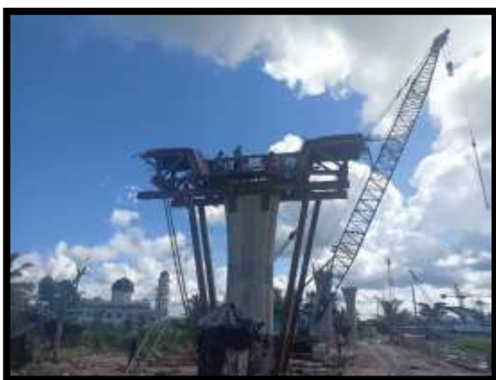
ภาพแสดงงานผูกเหล็ก Pier Head P14
