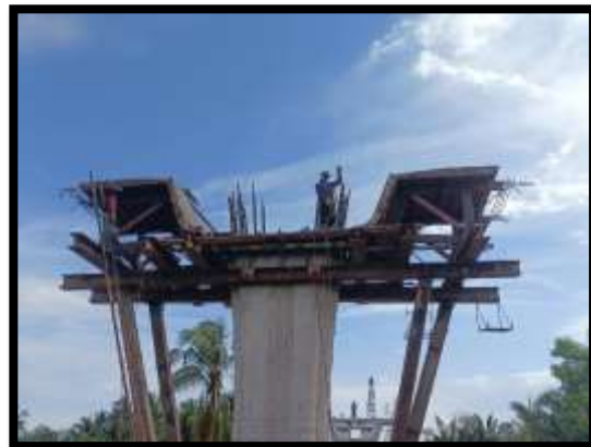
ภาพแสดงงานติดตั้งแบบ Pier Head P15
