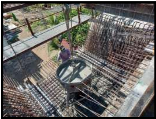
ภาพแสดงงานเทคอนกรีตพื้นล่าง งาน Balance P8 Type G-G
