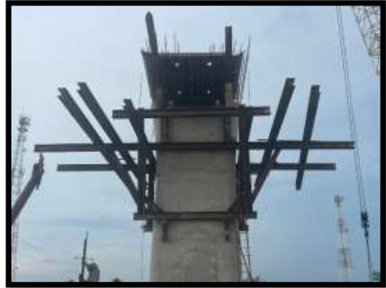
ภาพแสดงงานติดตั้งนั่งร้าน Pier Head P10
