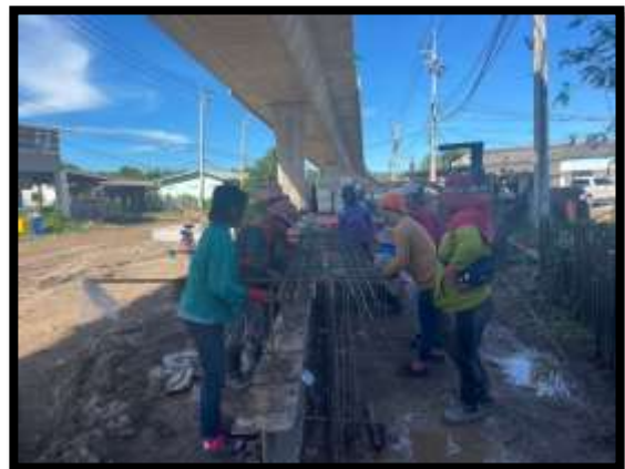
ภาพแสดงงานผูกเหล็กรางน้ำ งาน Transition
