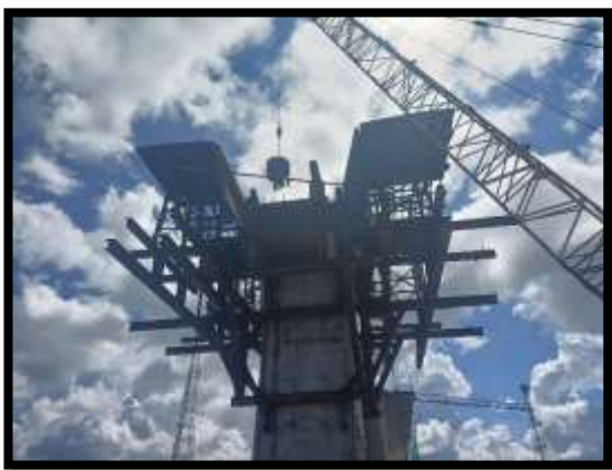
ภาพแสดงงานเทคอนกรีตพื้นล่างและผนังข้าง งาน Balance P10
