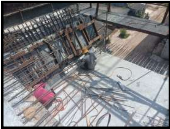
ภาพแสดงงานเข้าแบบข้าง งาน Balance P8 Type H-H
