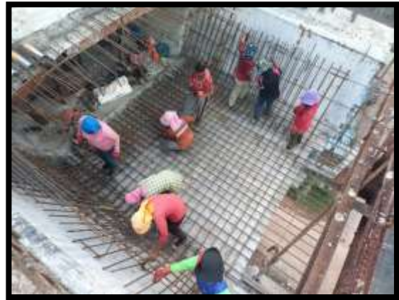
ภาพแสดงงานผูกเหล็กพื้นล่างและผนังข้าง งาน Balance P8 Type G-G
