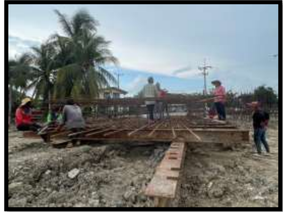
ภาพแสดงงานผูกเหล็กโครงสร้างเสาตอม่อ P11
