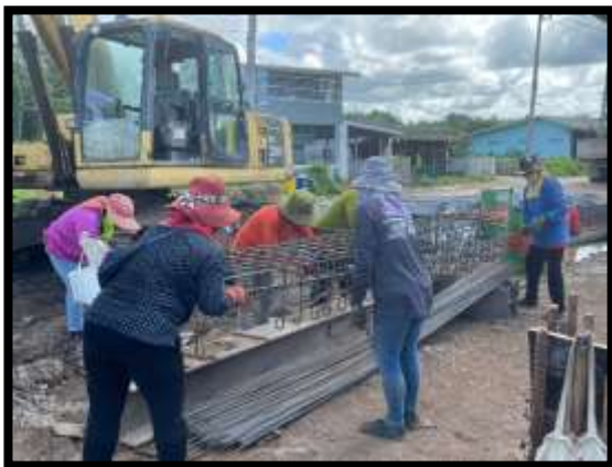
ภาพแสดงงานผูกเหล็กรางน้ำ งาน Transition
