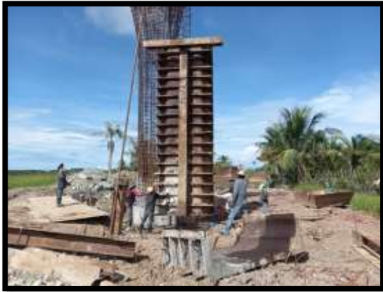
ภาพแสดงงานติดตั้งแบบโครงสร้างเสาตอม่อ P12
