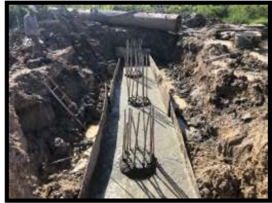
ภาพแสดงงานเทคอนกรีตหยาบ P18
