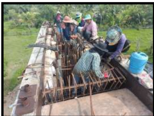
ภาพแสดงงานผูกเหล็ก Pier Head P15
