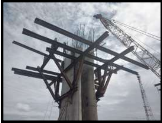
ภาพแสดงงานติดตั้งนั่งร้าน Pier Head P10
