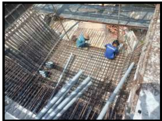
ภาพแสดงงานผูกเหล็กพื้นล่าง และ ผนังข้าง งาน Balance P8 Type H-H
