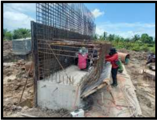
ภาพแสดงงานเทคอนกรีตฐานราก P18
