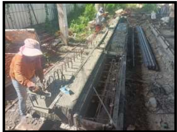
ภาพแสดงงานเทคอนกรีตค้ำหินปิดทางเท้า และแบรีเออทางเท้า
