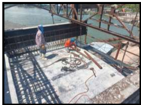
ภาพแสดงงานเข้าแบบพื้นบน งาน Balance P8 Type H-H
