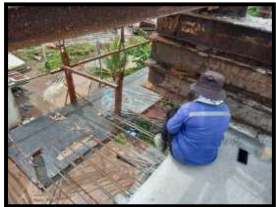
ภาพแสดงงานร้อยลวดอัดแรงตามยาว งาน Balance P8 Type H-H
