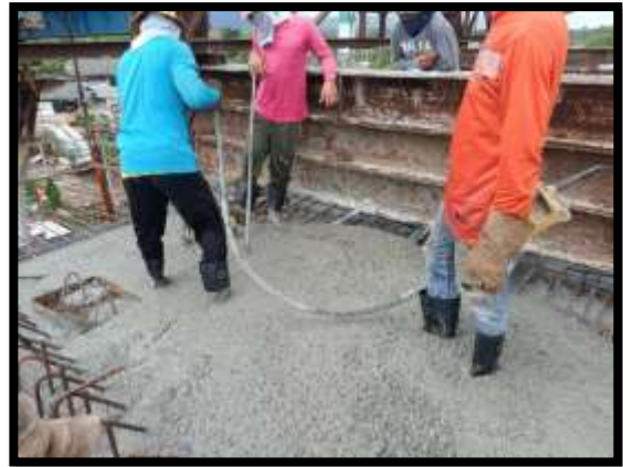
ภาพแสดงงานเทคอนกรีตพื้นบน งาน Balance P8 Type H-H
