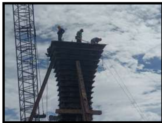
ภาพแสดงงานเทคอนกรีตโครงสร้างเสาตอม่อ P12
