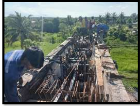
ภาพแสดงงานติดตั้งท่อร้อยลวดอัดแรงตามขวาง Pier Head P15
