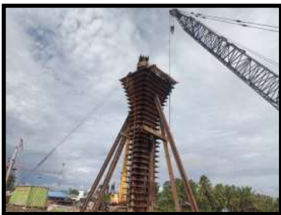
ภาพแสดงงานเทคอนกรีตโครงสร้างเสาตอม่อ P12
