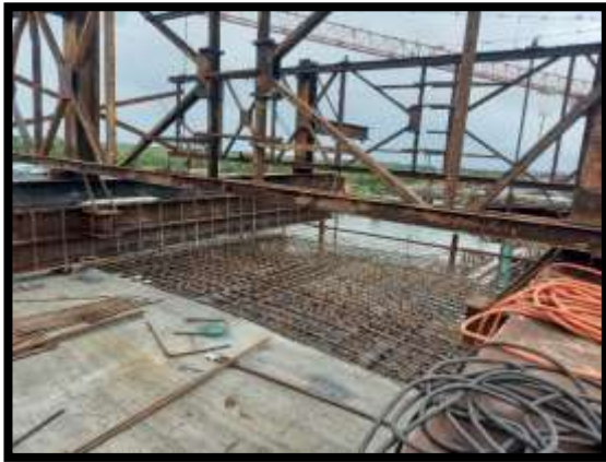
ภาพแสดงงานผูกเหล็กพื้นบนพร้อมติดตั้งท่อร้อยลวดอัดแรงตามขวาง และตามยาว งาน Balance P8 Type G-G
