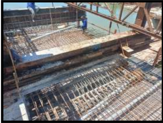
ภาพแสดงงานผูกเหล็กพื้นบนพร้อมติดตั้งท่อร้อยลวดอัดแรงดาวขวาง และตามยาว งาน Balance P8 Type H-H
