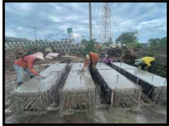
ภาพแสดงงานเทคอนกรีตรางน้ำ งาน Transition
