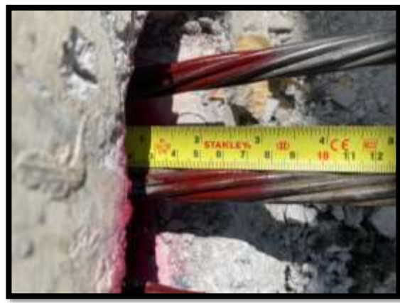
ภาพแสดงงานดึงลวดอัดแรงตามขวาง งาน Balance P8 Type G-G
