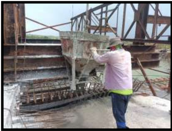
ภาพแสดงงานเทคอนกรีตผนังข้าง งาน Balance P8 Type H-H
