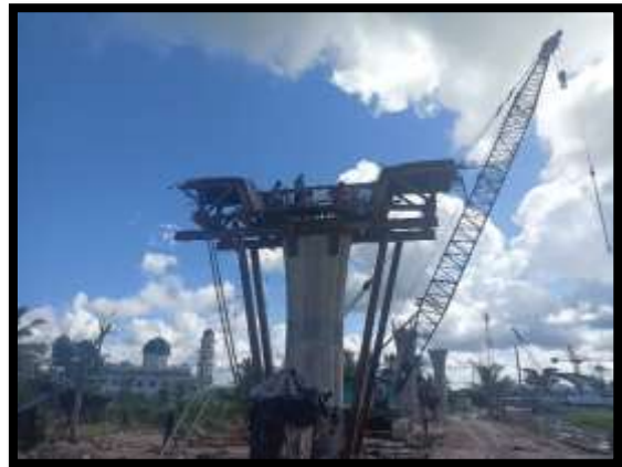
ภาพแสดงงานติดตั้งนั่งร้าน Pier Head P14
