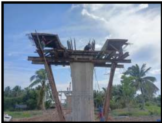
ภาพแสดงงานติดตั้งแบบ Pier Head P15
