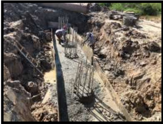
ภาพแสดงงานเทคอนกรีตหยาบ P18
