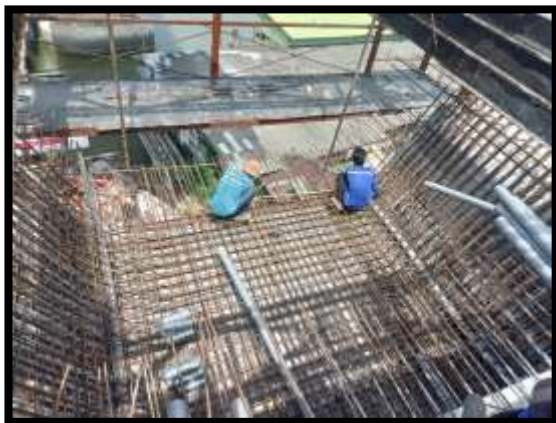
ภาพแสดงงานผูกเหล็กพื้นล่าง และ ผนังข้าง งาน Balance P8 Type H-H
