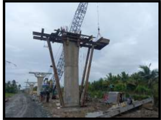
ภาพแสดงงานติดตั้งนั่งร้าน Pier Head P13
