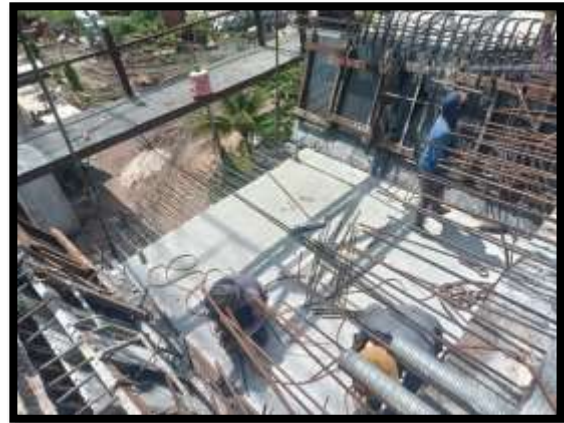
ภาพแสดงงานเข้าแบบข้าง งาน Balance P8 Type H-H
