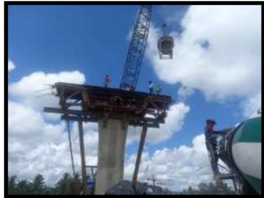
ภาพแสดงงานเทคอนกรีต Pier Head P14
