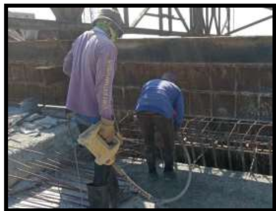
ภาพแสดงงานเทคอนกรีตผนังข้าง งาน Balance P8 Type G-G
