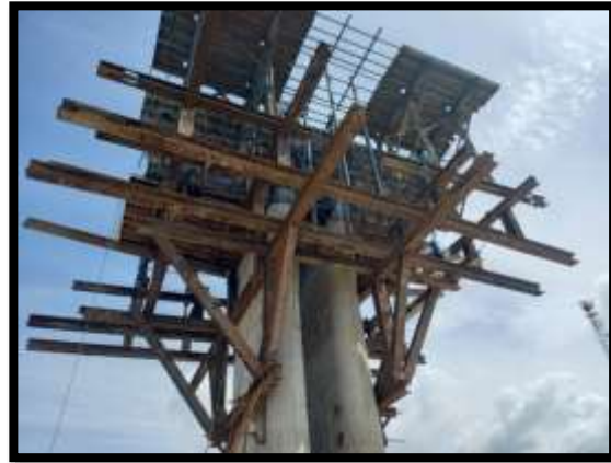
ภาพแสดงงานติดตั้ง From Traveler งาน Balance P10
