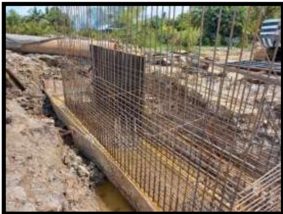
ภาพแสดงงานผูกเหล็กฐานราก P18
