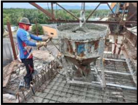
ภาพแสดงงานเทคอนกรีตพื้นบน งาน Balance P8 Type H-H
