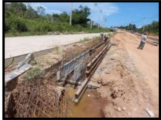
ภาพแสดงงานผูกเหล็กรางน้ำ งานกำแพงกันดิน
