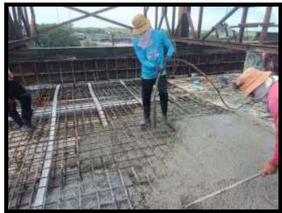
ภาพแสดงงานเทคอนกรีตพื้นบน งาน Balance P8 Type G-G
