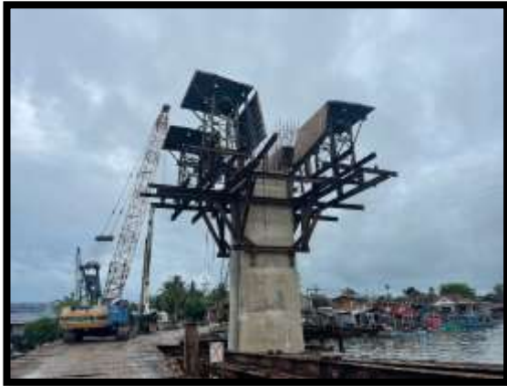
ภาพแสดงงานติดตั้ง From Traveler งาน Balance P10
