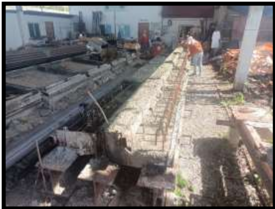
ภาพแสดงงานเทคอนกรีตค้ำหินปิดทางเท้า และแบรีเออทางเท้า
