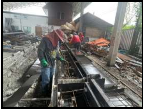
ภาพแสดงงานผูกเหล็กค้ำหินปิดทางเท้า และแบรีเออทางเท้า
