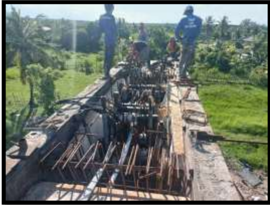
ภาพแสดงงานติดตั้งท่อร้อยลวดอัดแรงตามขวาง Pier Head P15
