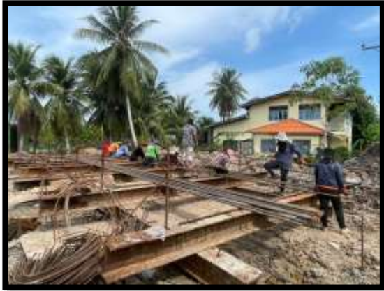
ภาพแสดงงานผูกเหล็กโครงสร้างเสาตอม่อ P11
