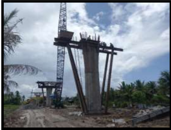
ภาพแสดงงานติดตั้งนั่งร้าน Pier Head P13
