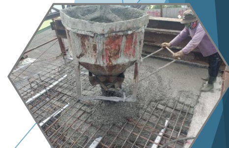
งานเทคอนกรีตพื้นบน Balance P8 Type F-F'
