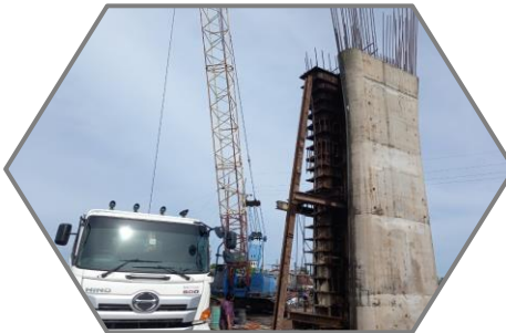
งานเทคอนกรีต โครงสร้างเสาตอม่อ P10 และ P14 - P17
