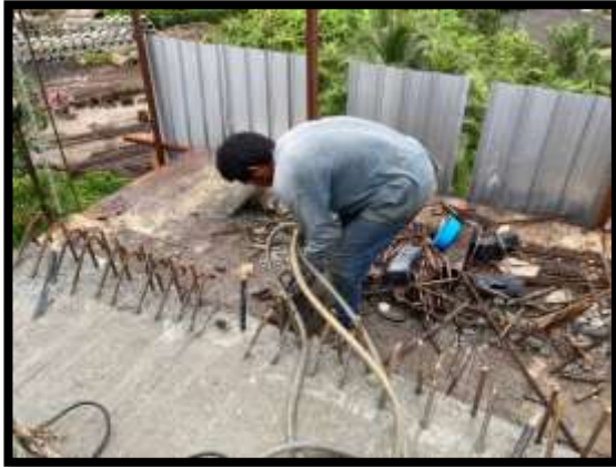
ภาพแสดงงานติดตั้งอัดแรงตามขวาง งาน Balance P8 Type D-D
