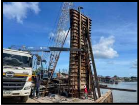
ภาพแสดงงานเข้าแบบโครงสร้างเสาตอม่อ P10 ต้นที่ 1
