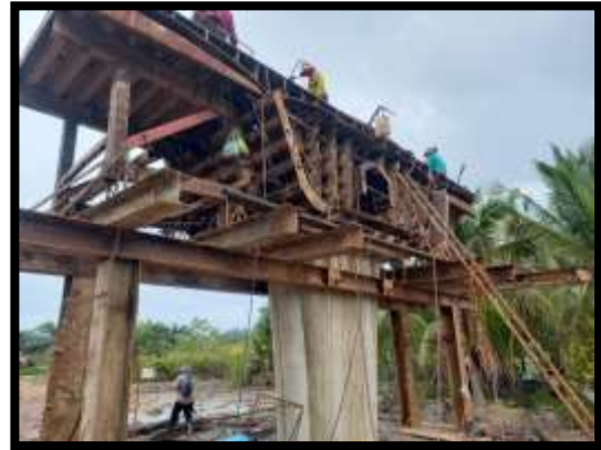
ภาพแสดงงานผูกเหล็ก Pier Head P17
