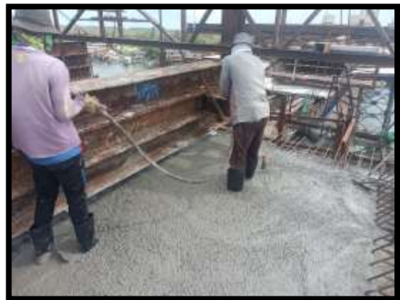
ภาพแสดงงานภาพแสดงงานเทคอนกรีตพื้นบน งาน Balance P8 Type F-F
