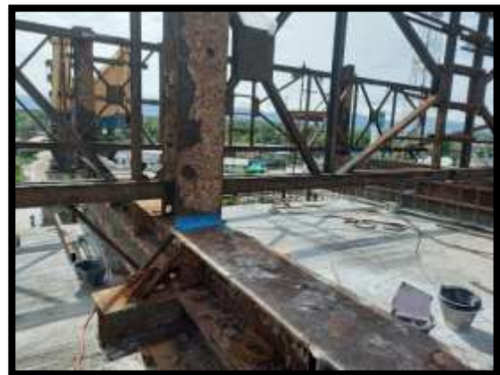
ภาพแสดงงานติดตั้งแบบพื้นล่าง งาน Balance P8 Type F-F
