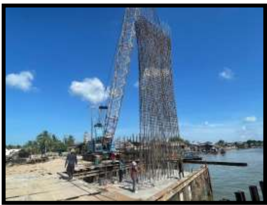
ภาพแสดงงานติดตั้งเหล็กโครงสร้างเสาตอม่อ P10 ต้นที่ 1
