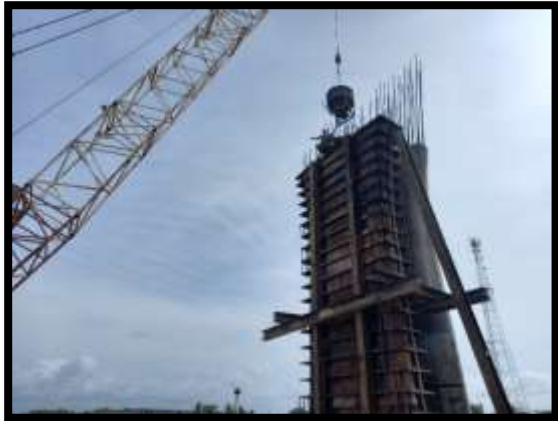
ภาพแสดงงานเทคอนกรีตโครงสร้างเสาตอม่อ P10 ต้นที่ 2
