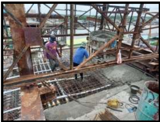
ภาพแสดงงานเทคอนกรีตพื้นบน งาน Balance P8 Type E-E
