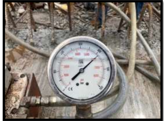
ภาพแสดงงานติดตั้งอัดแรงตามขวาง งาน Balance P8 Type D-D
