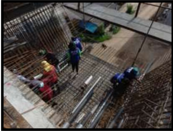
ภาพแสดงงานผูกเหล็กพื้นล่าง งาน Balance P8 Type F-F
