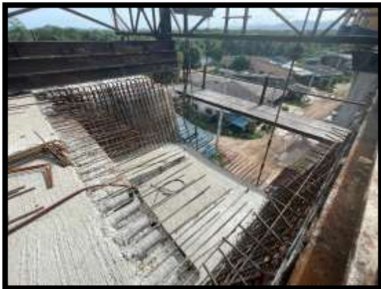
ภาพแสดงงานผูกเหล็กพร้อมเข้าแบบผนังข้าง งาน Balance P8 Type D-D
