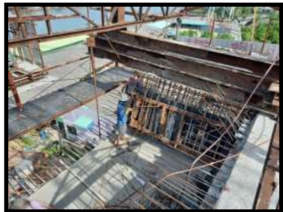
ภาพแสดงงานผูกเหล็กพร้อมเข้าแบบผนังข้าง งาน Balance P8 Type F-F
