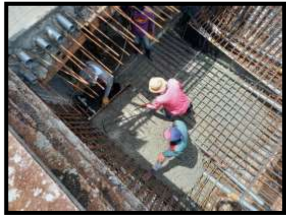
ภาพแสดงงานเทคอนกรีตพื้นล่าง งาน Balance P8 Type E-E
