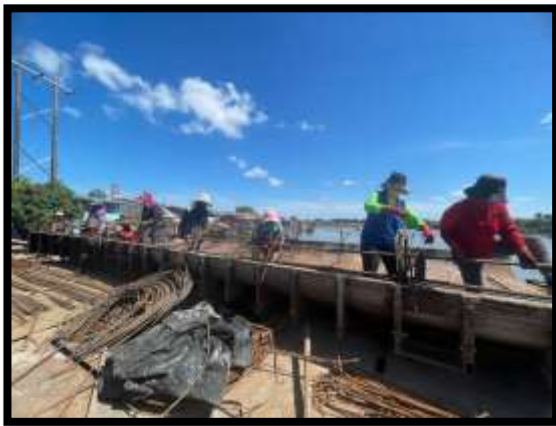
ภาพแสดงงานผูกเหล็กโครงสร้างเสาตอม่อ P10 ต้นที่ 1
