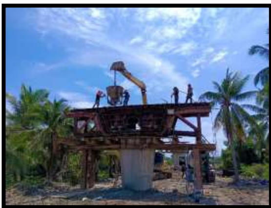
ภาพแสดงงานเทคอนกรีต Pier Head P17
