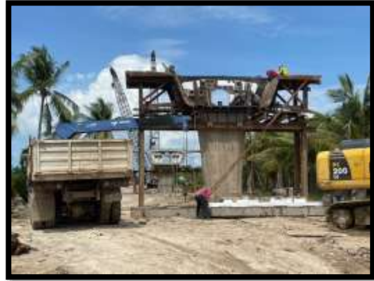
ภาพแสดงงานติดตั้งแบบ Pier Head P16
