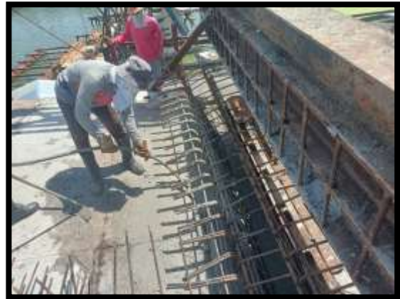
ภาพแสดงงานเทคอนกรีตผนังข้าง งาน Balance P8 Type F-F
