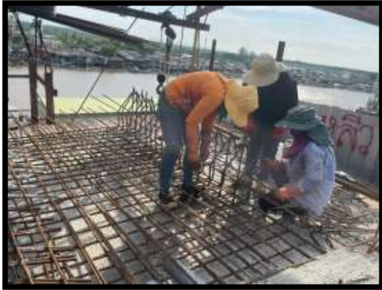
ภาพแสดงงานผูกเหล็กพื้นบน Balance P8 Type D-D
