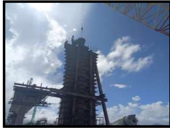
ภาพแสดงงานเทคอนกรีตโครงสร้างเสาตอม่อ P10 ต้นที่ 1
