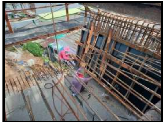
ภาพแสดงงานผูกเหล็กพร้อมเข้าแบบผนังข้าง งาน Balance P8 Type D-D
