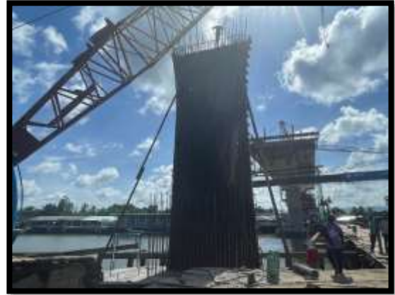
ภาพแสดงงานเข้าแบบโครงสร้างเสาตอม่อ P10 ต้นที่ 1
