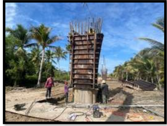
ภาพแสดงงานเข้าแบบโครงสร้างเสาตอม่อ P16
