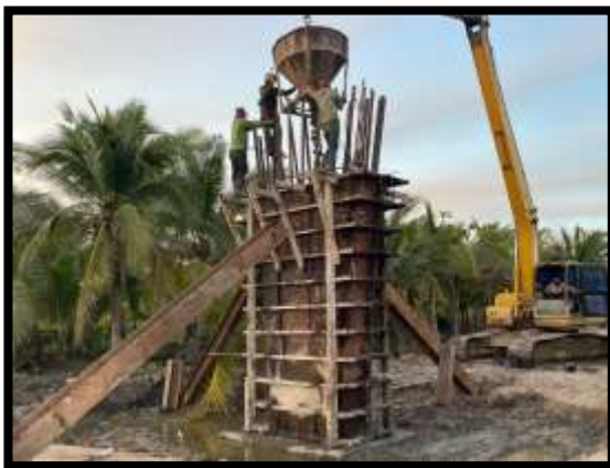
ภาพแสดงงานเทคอนกรีตโครงสร้างเสาตอม่อ P17
