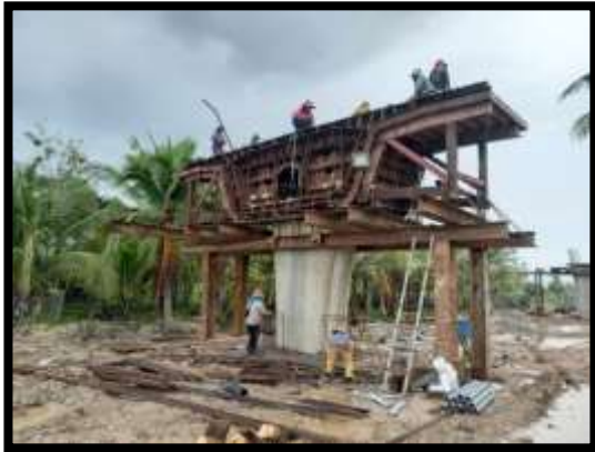
ภาพแสดงงานผูกเหล็ก Pier Head P17
