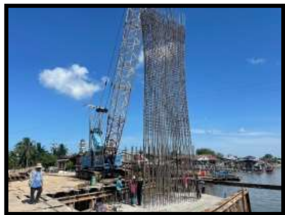
ภาพแสดงงานติดตั้งเหล็กโครงสร้างเสาตอม่อ P10 ต้นที่ 1
