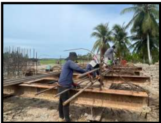
ภาพแสดงงานผูกเหล็กโครงสร้างเสาตอม่อ P11
