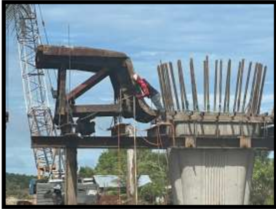
ภาพแสดงงานติดตั้งแบบพร้อมให้ระดับ Pier Head P17
