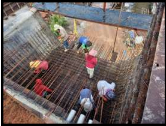
ภาพแสดงงานผูกเหล็กพื้นล่าง งาน Balance P8 Type E-E
