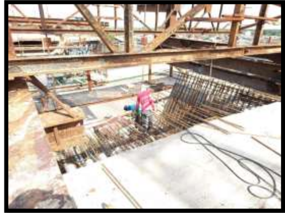
ภาพแสดงงานผูกเหล็กพื้นล่าง งาน Balance P8 Type F-F
