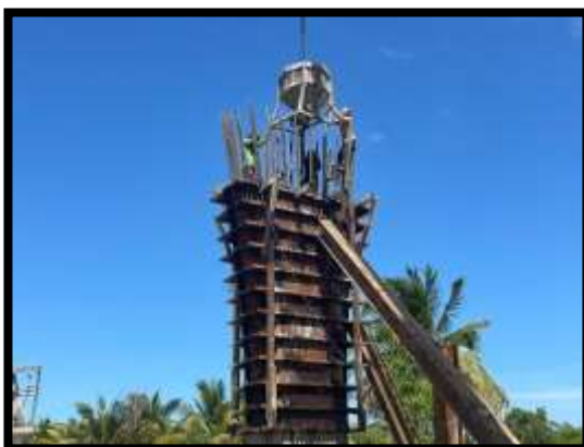
ภาพแสดงงานเทคอนกรีตโครงสร้างเสาตอม่อ P15
