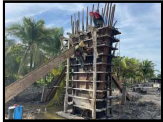
ภาพแสดงงานเข้าแบบโครงสร้างเสาตอม่อ P17
