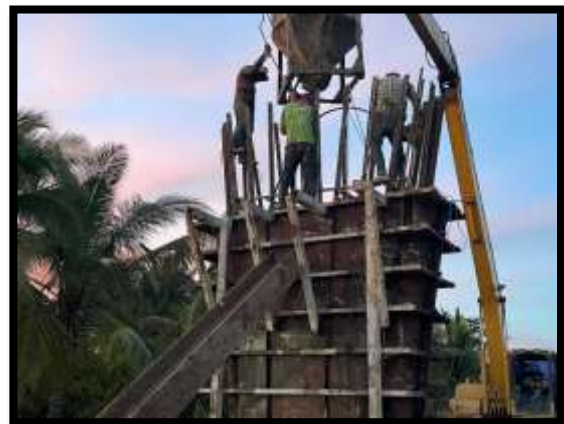
ภาพแสดงงานเทคอนกรีตโครงสร้างเสาตอม่อ P17
