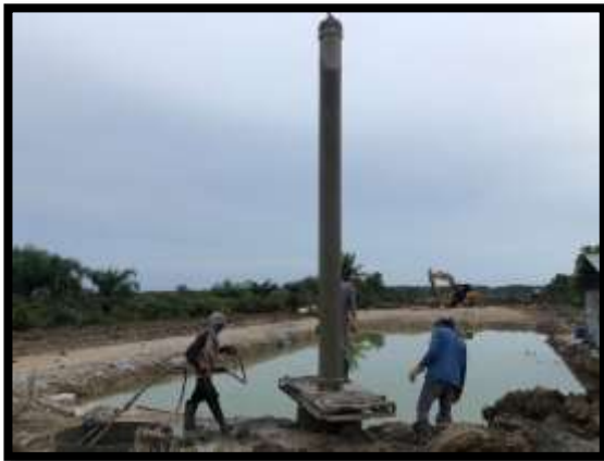
ภาพแสดงงานลงท่อ Timmy พร้อมเทคอนกรีต งานเสาเข็มเจาะ P18 ต้นที่ 4-10
