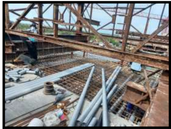
ภาพแสดงงานติดตั้งท่อลวดอัดแรงตามยาว และ ตามขวาง งาน Balance P8 Type E-E
