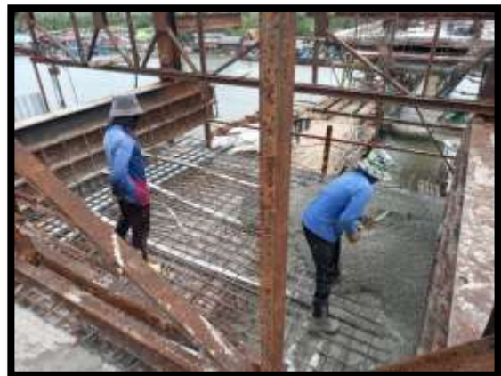
ภาพแสดงงานเทคอนกรีตพื้นบน งาน Balance P8 Type E-E
