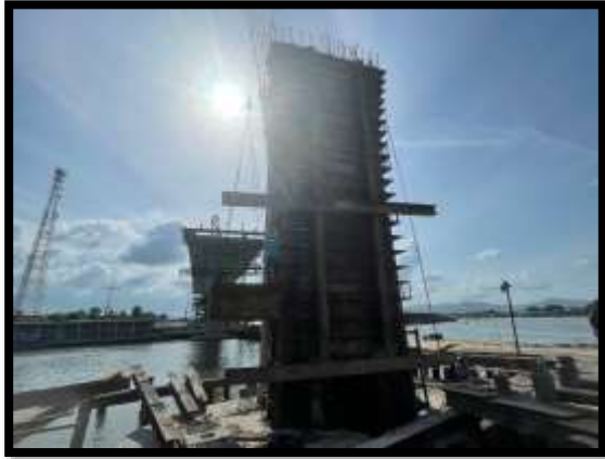
ภาพแสดงงานเข้าแบบโครงสร้างเสาตอม่อ P10 ต้นที่ 2
