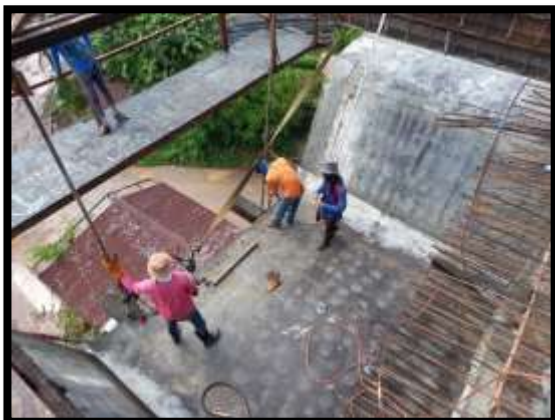
ภาพแสดงงานเข้าแบบพื้นล่าง งาน Balance P8 Type E-E
