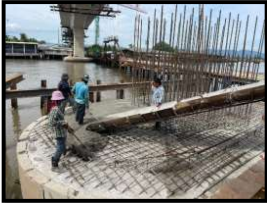
ภาพแสดงงานเทคอนกรีตฐานราก P10
