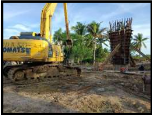
ภาพแสดงงานเทคอนกรีตโครงสร้างเสาตอม่อ P16
