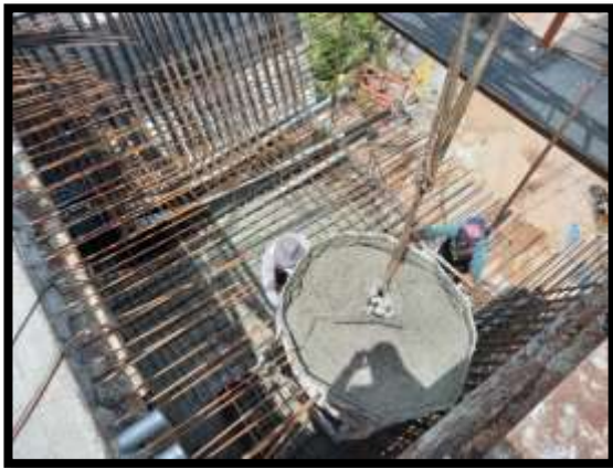
ภาพแสดงงานเทคอนกรีตพื้นล่าง งาน Balance P8 Type E-E
