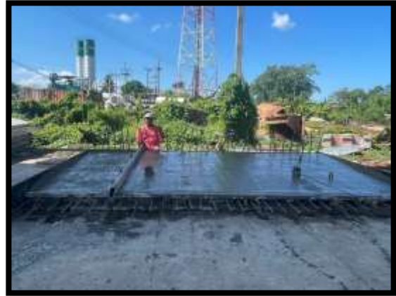
ภาพแสดงงานเทคอนกรีตกำแพง L2 ถึง L4 Transition (ฝั่งเกาะ)
