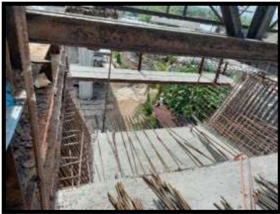
ภาพแสดงงานเทคอนกรีตพื้นล่าง งาน Balance P8 Type F-F
