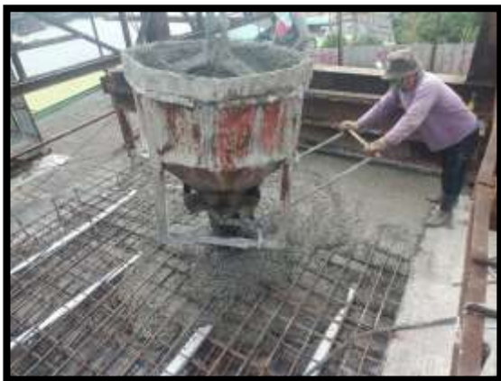
ภาพแสดงงานภาพแสดงงานเทคอนกรีตพื้นบน งาน Balance P8 Type F-F
