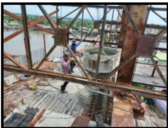
ภาพแสดงงานเทคอนกรีตผนังข้าง งาน Balance P8 Type D-D
