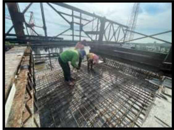
ภาพแสดงงานผูกเหล็กพื้นบน Balance P8 Type D-D
