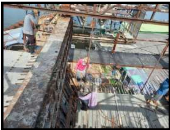
ภาพแสดงงานผูกเหล็กพร้อมเข้าแบบผนังข้าง งาน Balance P8 Type F-F
