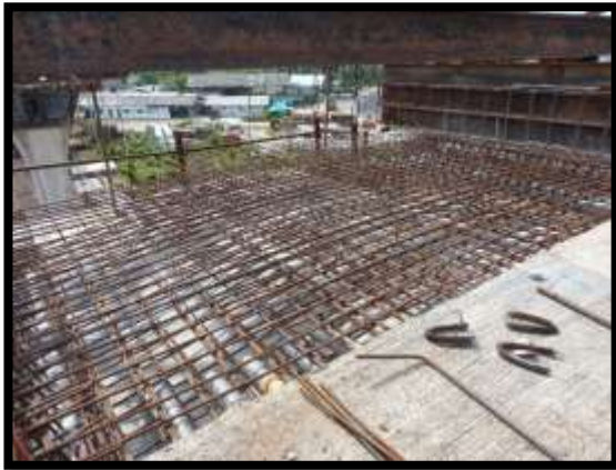
ภาพแสดงงานผูกเหล็กพื้นบน งาน Balance P8 Type E-E
