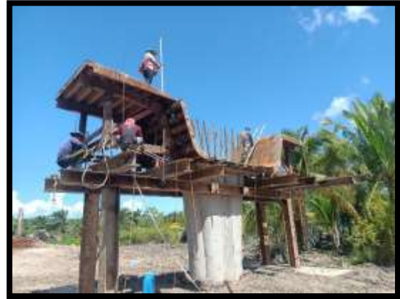
ภาพแสดงงานติดตั้งแบบพร้อมให้ระดับ Pier Head P17
