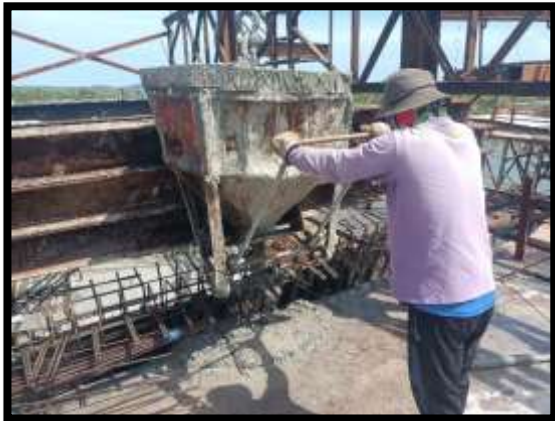
ภาพแสดงงานเทคอนกรีตผนังข้าง งาน Balance P8 Type F-F
