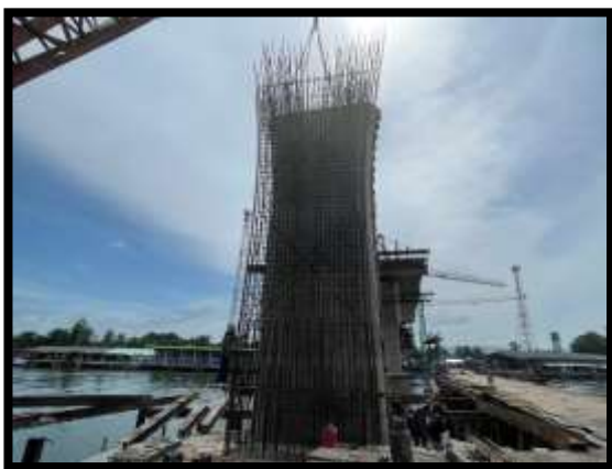
ภาพแสดงงานติดตั้งเหล็กโครงสร้างเสาตอม่อ P10 ต้นที่ 2
