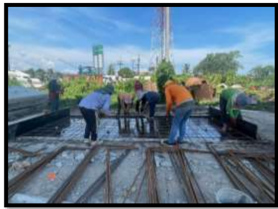
ภาพแสดงงานเข้าแบบและผูกเหล็กกำแพง L2 ถึง L4 Transition (ฝั่งเกาะ)
