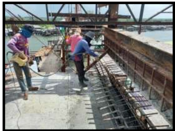
ภาพแสดงงานเทคอนกรีตผนังข้าง งาน Balance P8 Type E-E
