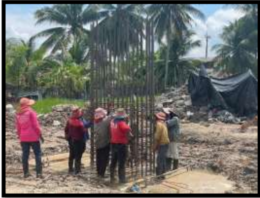
ภาพแสดงงานผูกเหล็กโครงสร้างเสาตอม่อ P12
