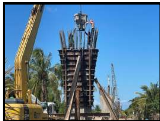
ภาพแสดงงานเทคอนกรีตโครงสร้างเสาตอม่อ P15
