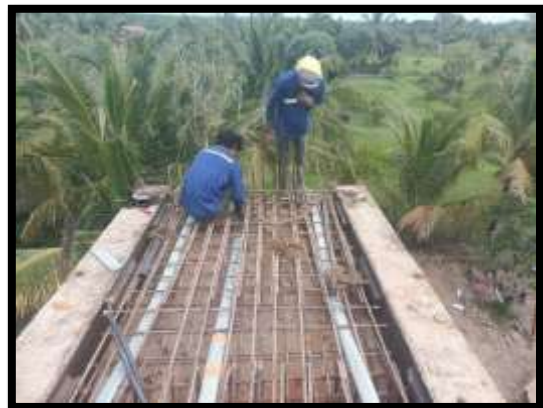
ภาพแสดงงานผูกเหล็ก Pier Head P16
