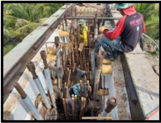
ภาพแสดงงานติดตั้งแบบ Pier Head P16
