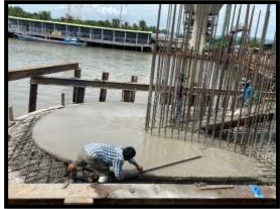
ภาพแสดงงานเทคอนกรีตฐานราก P10
