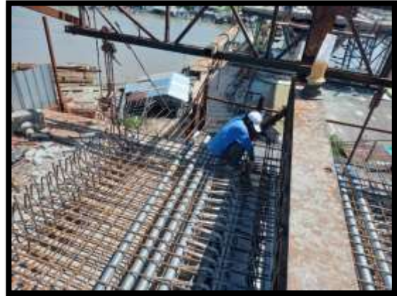
ภาพแสดงงานติดตั้งท่อลวดอัดแรงตามยาว และ ตามขวาง งาน Balance P8 Type D-D
