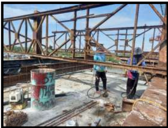
ภาพแสดงงานติดตั้งแบบพื้นล่าง งาน Balance P8 Type F-F
