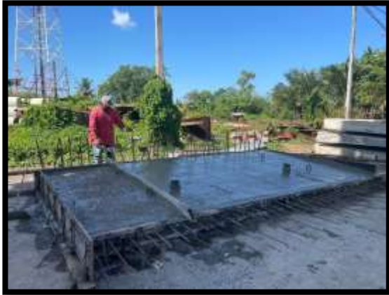
ภาพแสดงงานเทคอนกรีตกำแพง L2 ถึง L4 Transition (ฝั่งเกาะ)
