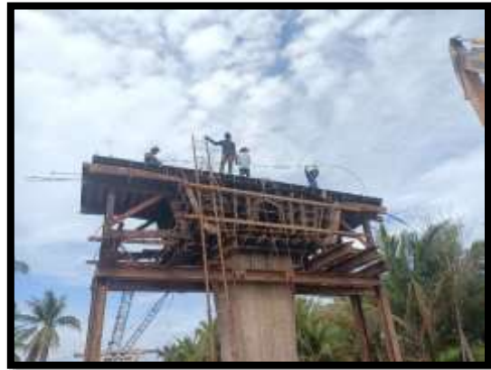
ภาพแสดงงานติดตั้งแบบ Pier Head P16
