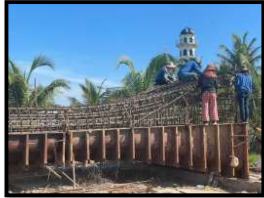
ภาพแสดงงานผูกเหล็กโครงสร้างเสาตอม่อ P12
