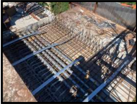
ภาพแสดงงานติดตั้งท่อลวดอัดแรงตามยาว และ ตามขวาง งาน Balance P8 Type D-D
