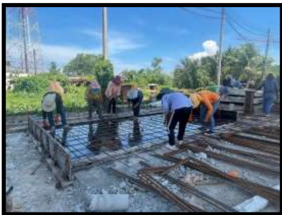
ภาพแสดงงานเข้าแบบและผูกเหล็กกำแพง L2 ถึง L4 Transition (ฝั่งเกาะ)
