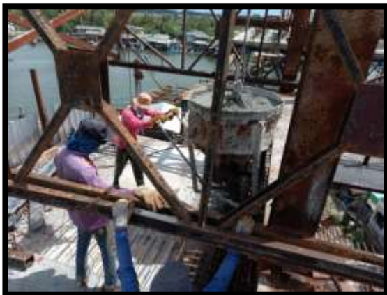
ภาพแสดงงานเทคอนกรีตผนังข้าง งาน Balance P8 Type E-E
