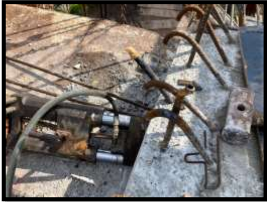
ภาพแสดงงานติดตั้งวัดแรงตามขวาง งาน Balance P8 Type E-E
