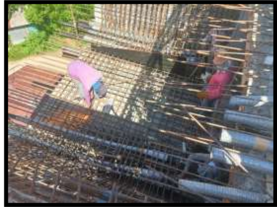
ภาพแสดงงานผูกเหล็กพื้นล่าง งาน Balance P8 Type E-E
