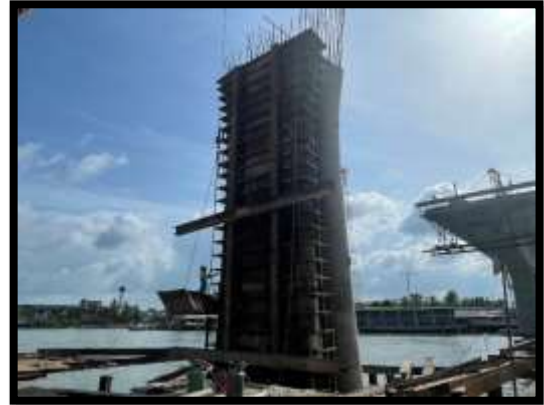
ภาพแสดงงานเข้าแบบโครงสร้างเสาตอม่อ P10 ต้นที่ 2
