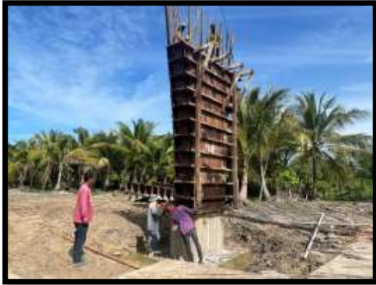
ภาพแสดงงานเข้าแบบโครงสร้างเสาตอม่อ P16
