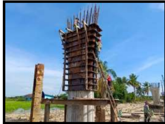
ภาพแสดงงานเข้าแบบโครงสร้างเสาตอม่อ P15
