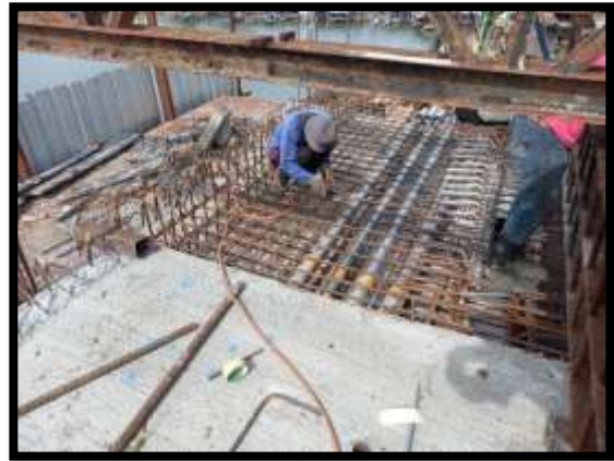
ภาพแสดงงานผูกเหล็กพื้นบน งาน Balance P8 Type E-E
