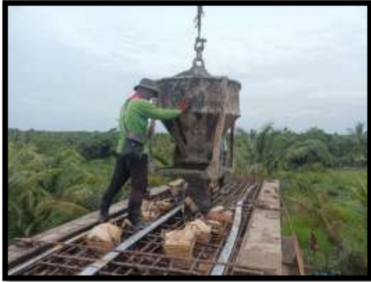
ภาพแสดงงานเทคอนกรีต Pier Head P16
