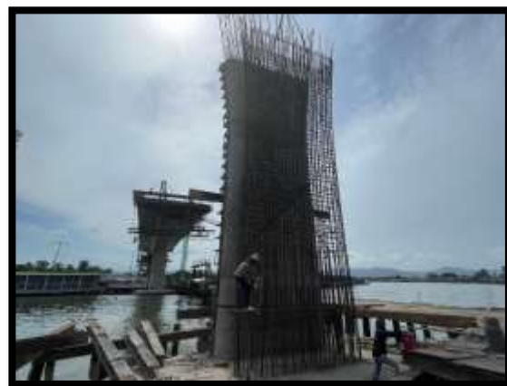
ภาพแสดงงานติดตั้งเหล็กโครงสร้างเสาตอม่อ P10 ต้นที่ 2
