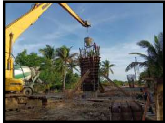
ภาพแสดงงานเทคอนกรีตโครงสร้างเสาตอม่อ P16
