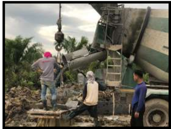
ภาพแสดงงานลงท่อ Timmy พร้อมเทคอนกรีต งานเสาเข็มเจาะ P18 ต้นที่ 4-10
