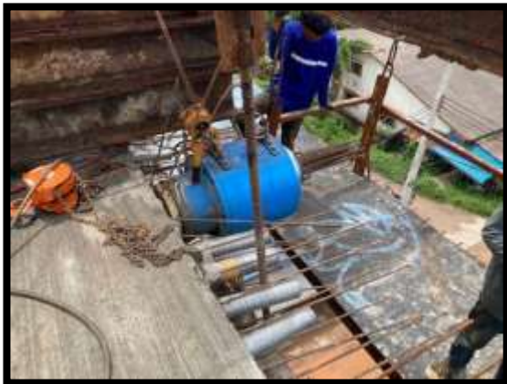
ภาพแสดงงานติดตั้งอัดแรงตามยาว งาน Balance P8 Type D-D
