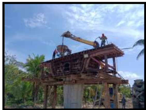
ภาพแสดงงานเทคอนกรีต Pier Head P17
