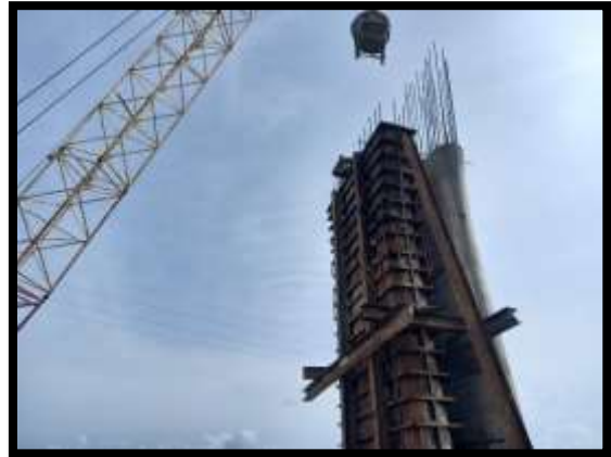
ภาพแสดงงานเทคอนกรีตโครงสร้างเสาตอม่อ P10 ต้นที่ 2
