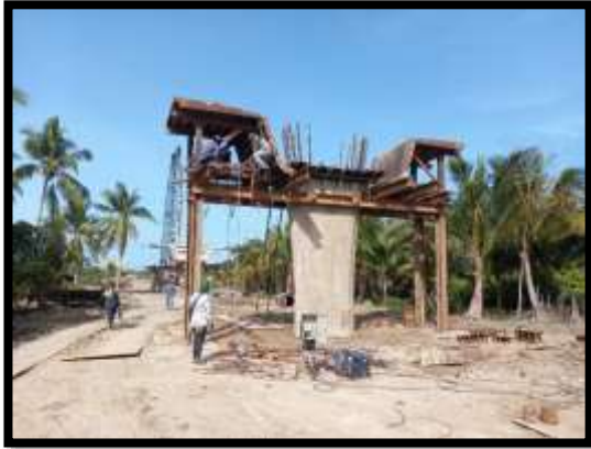
ภาพแสดงงานติดตั้งแบบ Pier Head P16
