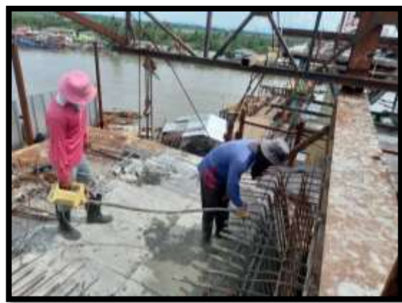
ภาพแสดงงานเทคอนกรีตผนังข้าง งาน Balance P8 Type D-D
