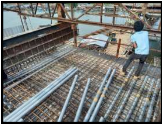
ภาพแสดงงานติดตั้งท่อลวดอัดแรงตามยาว และ ตามขวาง งาน Balance P8 Type E-E
