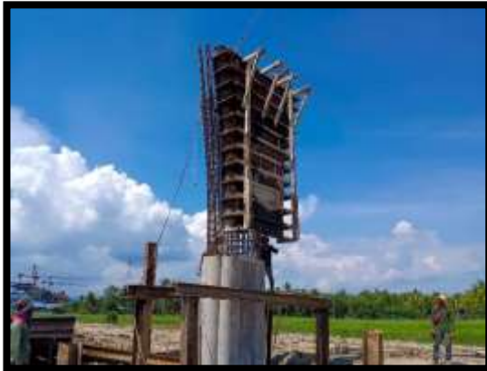
ภาพแสดงงานเข้าแบบโครงสร้างเสาตอม่อ P15
