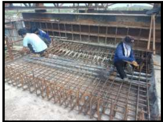
ภาพแสดงงานผูกเหล็กพื้นบนพร้อมวางท่อลอดอัดแรงตามขวางและตามยาว งาน Balance P8 Type F-F
