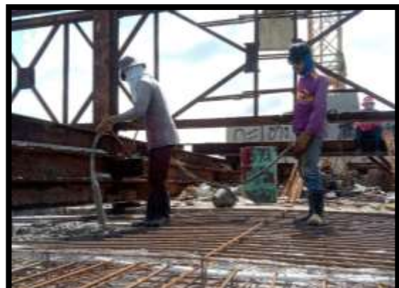
ภาพแสดงงานเทคอนกรีตพื้นบน งาน Balance P8 Type D-D
