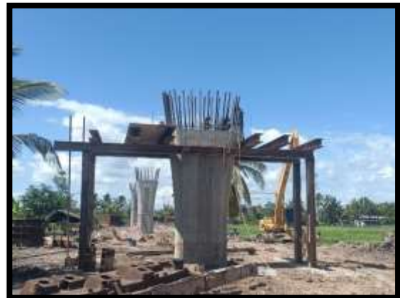
ภาพแสดงงานติดตั้งนั่งร้านรับ Pier Head P16
