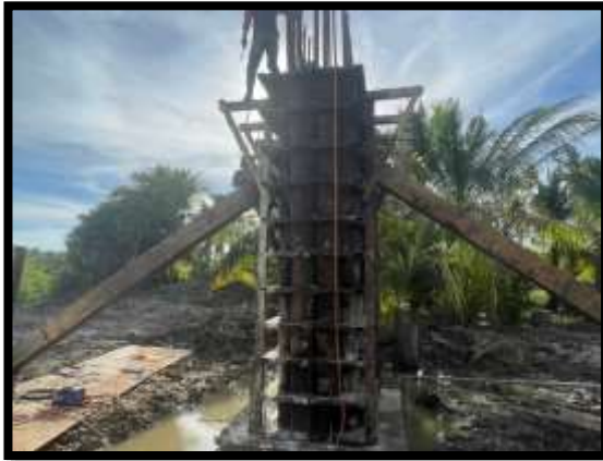
ภาพแสดงงานเข้าแบบโครงสร้างเสาตอม่อ P17
