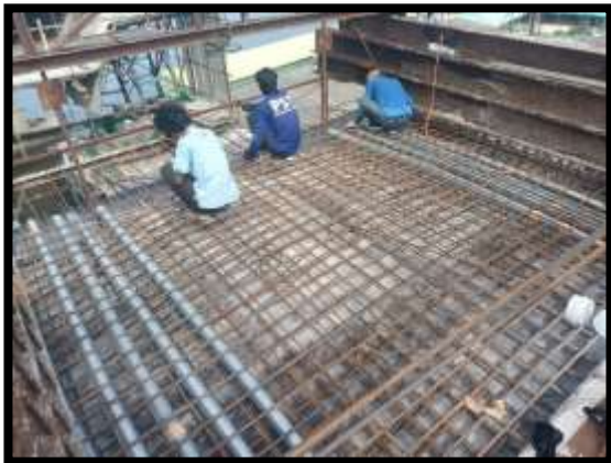
ภาพแสดงงานผูกเหล็กพื้นบนพร้อมวางท่อลอดอัดแรงตามขวางและตามยาว งาน Balance P8 Type F-F
