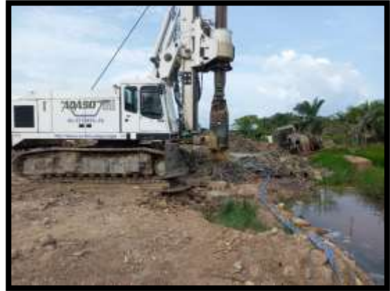
ภาพแสดงงานเจาะเสาเข็ม งานเสาเข็มเจาะ P18 ต้นที่ 4-10
