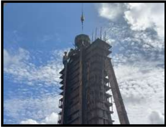
ภาพแสดงงานเทคอนกรีตโครงสร้างเสาตอม่อ P10 ต้นที่ 1
