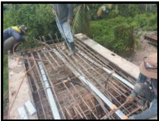
ภาพแสดงงานผูกเหล็ก Pier Head P16
