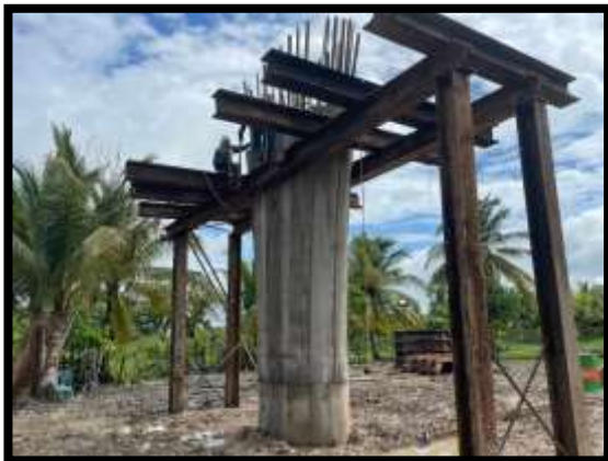
ภาพแสดงงานติดตั้งนั่งร้านรับ Pier Head P16
