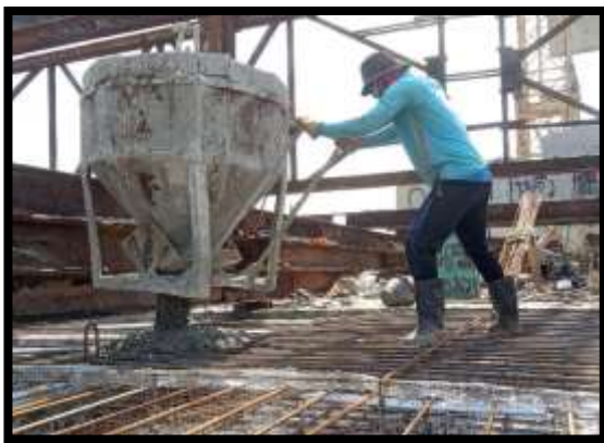
ภาพแสดงงานเทคอนกรีตพื้นบน งาน Balance P8 Type D-D
