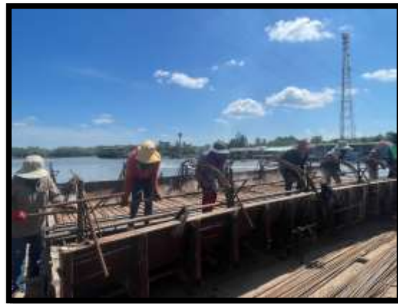
ภาพแสดงงานผูกเหล็กโครงสร้างเสาตอม่อ P10 ต้นที่ 1
