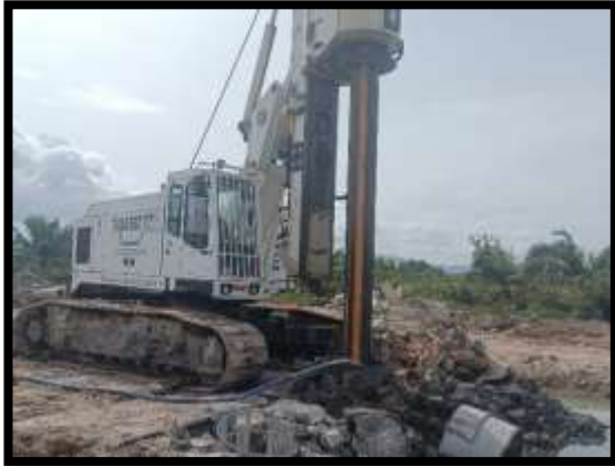
ภาพแสดงงานเจาะเสาเข็ม งานเสาเข็มเจาะ P18 ต้นที่ 4-10
