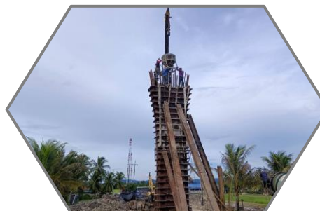
งานเทคอนกรีตโครงสร้างเสาตอม่อ P13 P14
