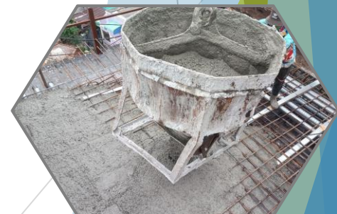
งานเทคอนกรีตพื้นบน Balance P8 Type C-C'
