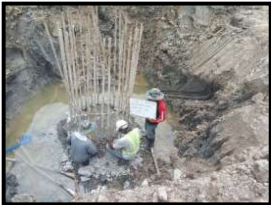
ภาพแสดงงานทดสอบความสมบูรณ์ของเสาเข็มเจาะ ด้วยวิธี Seismic (ฝังเกาะ)
