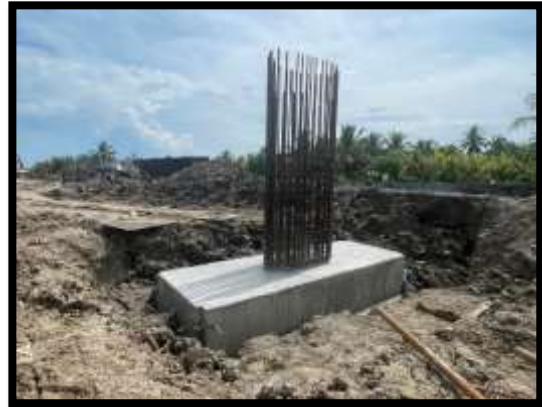
ภาพแสดงงานเทคอนกรีตฐานราก P13
