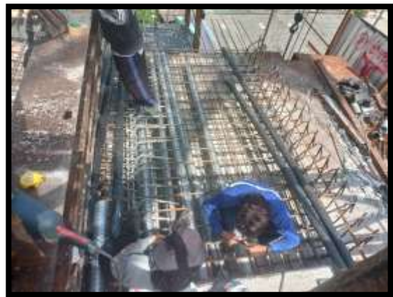
ภาพแสดงงานติดตั้งท่อลวดอัดแรงตามยาว และ ตามขวาง งาน Balance P8 Type C-C
