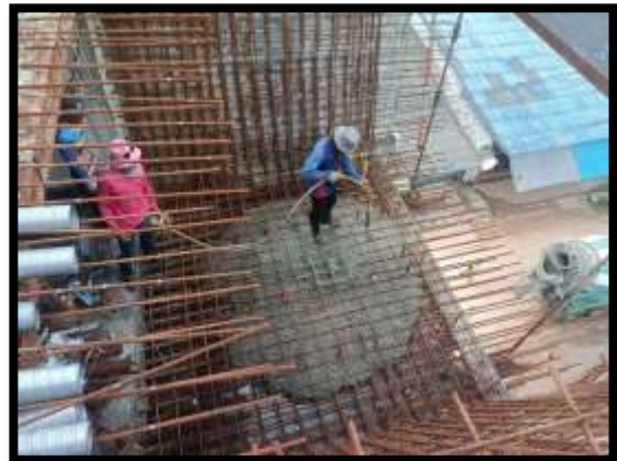
ภาพแสดงงานเทคอนกรีตพื้นล่าง งาน Balance P8 Type B-B
