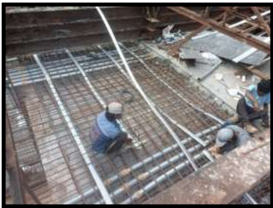
ภาพแสดงงานติดตั้งท่อลวดอัดแรงตามยาว และ ตามขวาง งาน Balance P8 Type C-C
