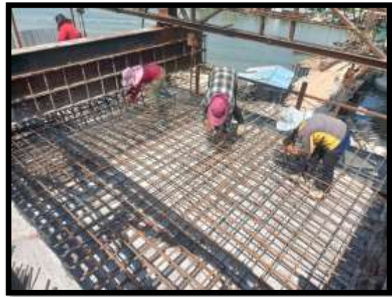
ภาพแสดงงานผูกเหล็กพื้นบน งาน Balance P8 Type C-C
