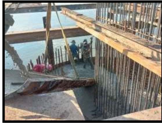
ภาพแสดงงานเทคอนกรีตฐานราก P10 ครั้งที่ 1
