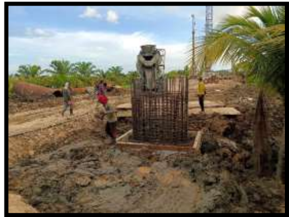
ภาพแสดงงานเทคอนกรีตฐานราก P17
