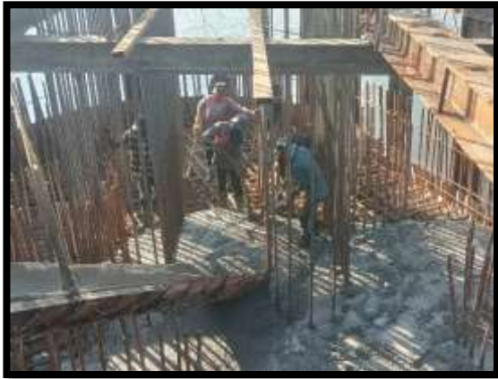
ภาพแสดงงานเทคอนกรีตฐานราก P10 ครั้งที่ 1
