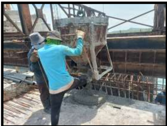
ภาพแสดงงานเทคอนกรีตผนังข้าง งาน Balance P8 Type B-B
