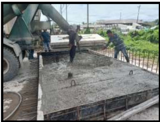
ภาพแสดงงานเทคอนกรีตกำแพง Transition (ฝั่งเกาะ)
