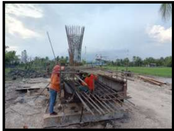
ภาพแสดงงานผูกเหล็กโครงสร้างเสาตอม่อ P16
