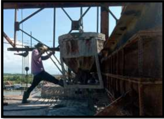
ภาพแสดงงานเทคอนกรีตผนังข้าง งาน Balance P8 Type C-C
