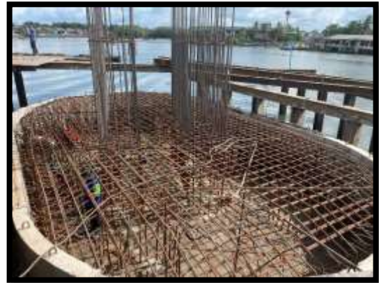
ภาพแสดงงานผูกเหล็กฐานราก P10
