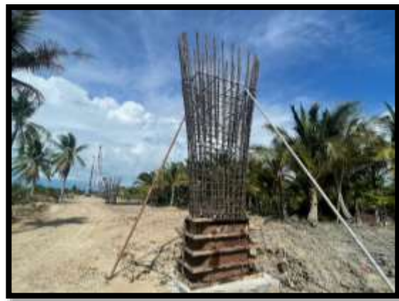
ภาพแสดงงานติดตั้งโครงสร้างเสาตอม่อ P16
