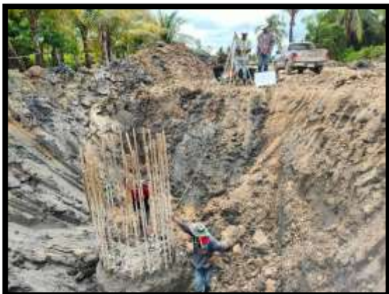
ภาพแสดงงานทดสอบความสมบูรณ์ของเสาเข็มเจาะ ด้วยวิธี Sonic logging (ฝังเกาะ)
