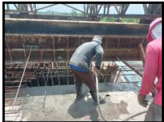
ภาพแสดงงานเทคอนกรีตผนังข้าง งาน Balance P8 Type B-B
