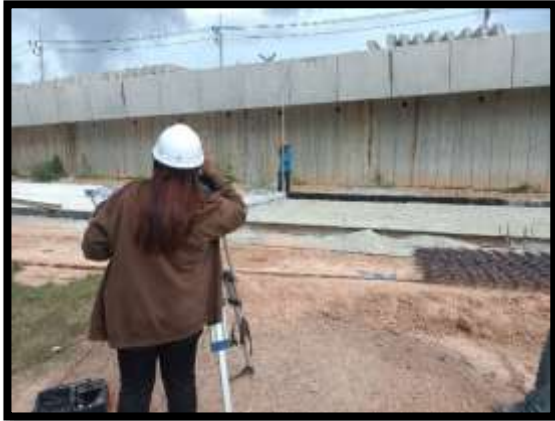
ภาพแสดงงานตรวจระดับแบบข้าง และ ทราซายาบ งานถนน Sta.0+500 ถึง Sta.0+540 และ Sta.0620 ถึง Sta.0+690 RT
