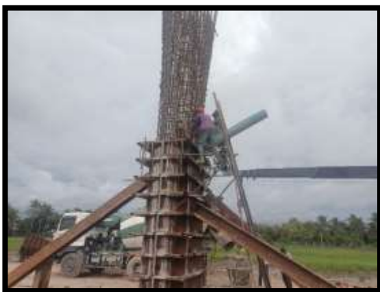
ภาพแสดงงานเข้าแบบพร้อมเทคอนกรีตโครงสร้างเสาตอม่อ P14
