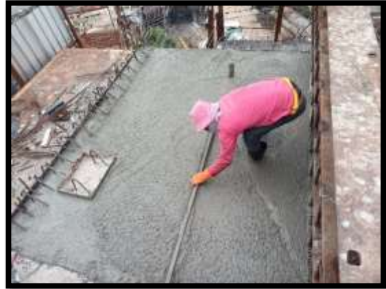
ภาพแสดงงานเทคอนกรีตพื้นบน งาน Balance P8 Type C-C
