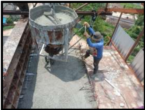
ภาพแสดงงานเทคอนกรีตพื้นบน งาน Balance P8 Type B-B
