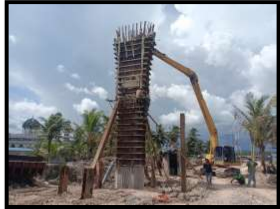
ภาพแสดงงานเข้าแบบโครงสร้างเสาตอม่อ P13
