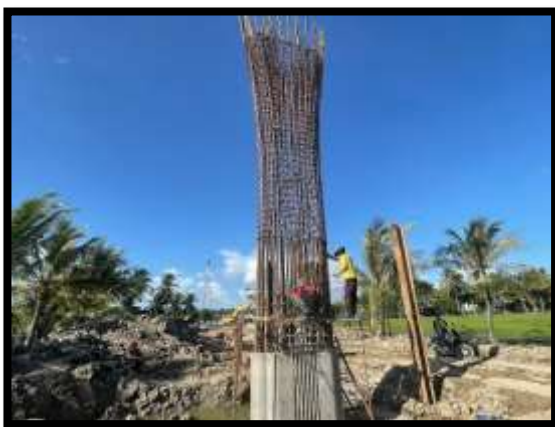
ภาพแสดงงานติดตั้งโครงสร้างเสาตอม่อ P13
