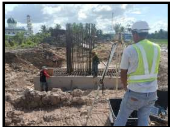
ภาพแสดงงานทดสอบความสมบูรณ์ของเสาเข็มเจาะ ด้วยวิธี Sonic logging (ฝังเกาะ)
