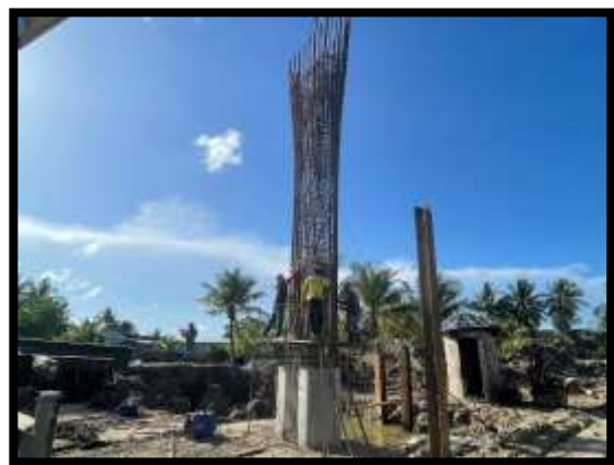
ภาพแสดงงานติดตั้งโครงสร้างเสาตอม่อ P13
