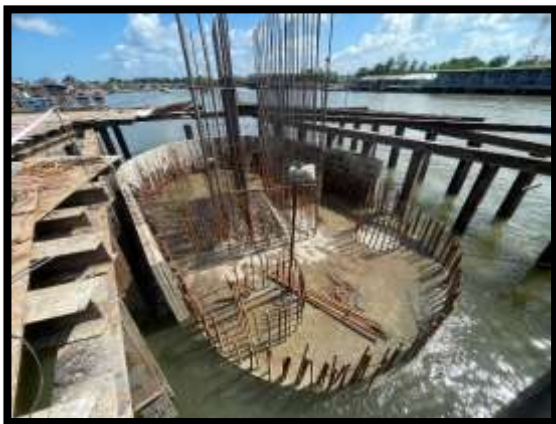
ภาพแสดงงานติดตั้ง Precast Skirt P10
