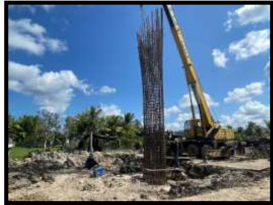
ภาพแสดงงานติดตั้งโครงสร้างเสาตอม่อ P14
