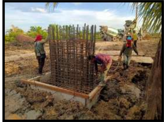
ภาพแสดงงานผูกเหล็กฐานราก P17
