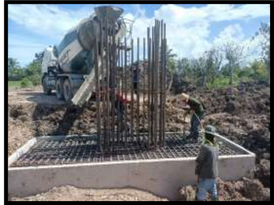
ภาพแสดงงานเทคอนกรีตฐานราก P14
