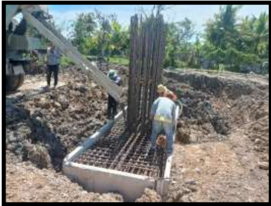
ภาพแสดงงานเทคอนกรีตฐานราก P13
