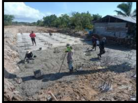
ภาพแสดงงานเทคอนกรีตทรายหยาบเสาะเข็มตอก งาน Transition (ฝั่งเกาะ)
