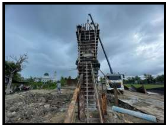
ภาพแสดงงานเข้าแบบพร้อมเทคอนกรีตโครงสร้างเสาตอม่อ P14
