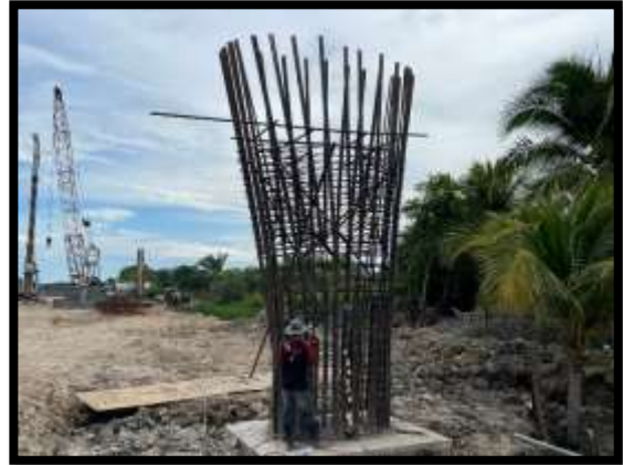
ภาพแสดงงานติดตั้งโครงสร้างเสาตอม่อ P17
