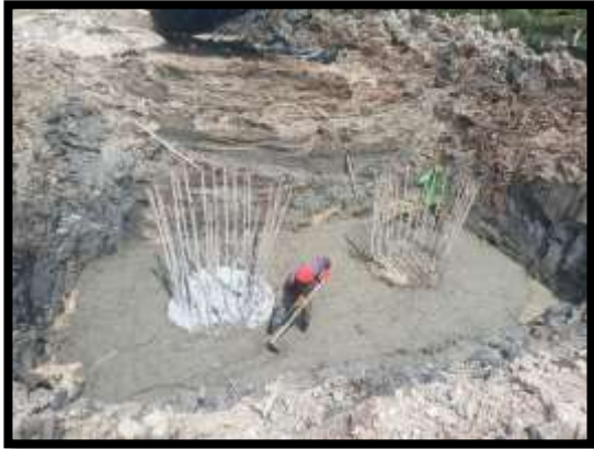
ภาพแสดงงานเทคอนกรีตหยาบ P12
