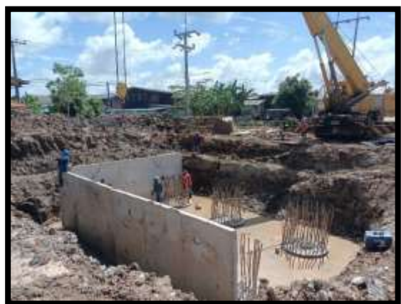
ภาพแสดงงานติดตั้ง Precast Skirt P11
