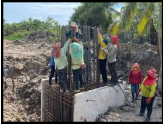
ภาพแสดงงานผูกเหล็กฐานราก P17
