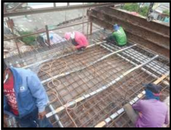
ภาพแสดงงานผูกเหล็กพื้นบนพร้อมติดตั้งท่อลวดอัดแรงตามยาว ตามขวาง งาน Balance P8 Type B-B
