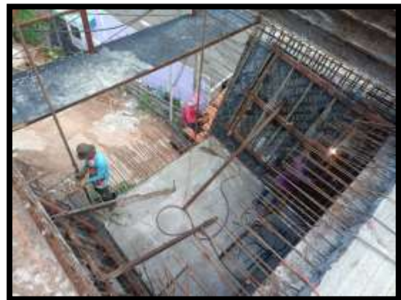
ภาพแสดงงานเข้าแบบผนังข้าง งาน Balance P8 Type C-C
