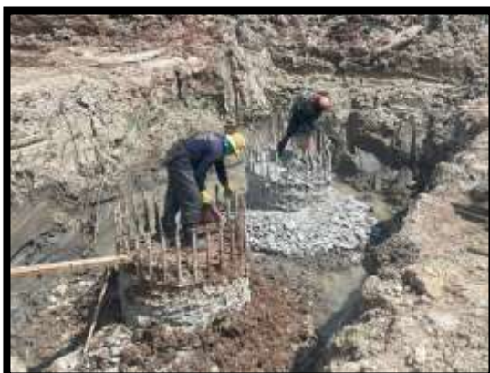
ภาพแสดงงานตัดตกแต่งเสาเข็มเจาะ P12
