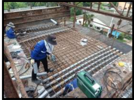
ภาพแสดงงานผูกเหล็กพื้นบนพร้อมติดตั้งท่อลวดอัดแรงตามยาว ตามขวาง งาน Balance P8 Type B-B
