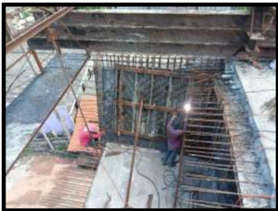
ภาพแสดงงานเข้าแบบผนังข้าง งาน Balance P8 Type C-C
