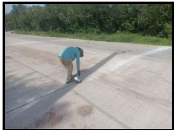
ภาพแสดงงานตัดรอยต่อ พร้อมยาแนวรอยต่อ ตามขวางและตามยาว งานถนน Sta.0+370 ถึง Sta.0+700
