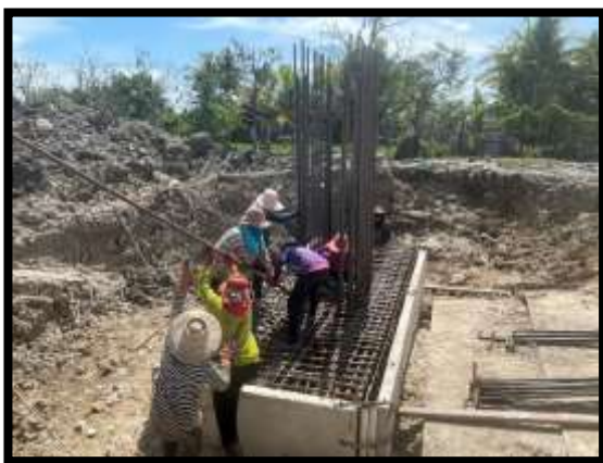
ภาพแสดงงานผูกเหล็กฐานราก และ โครงสร้างเสาตอม่อ P14
