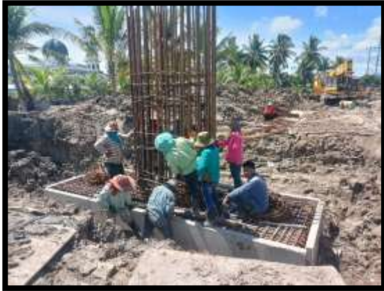
ภาพแสดงงานผูกเหล็กฐานราก และ โครงสร้างเสาตอม่อ P13
