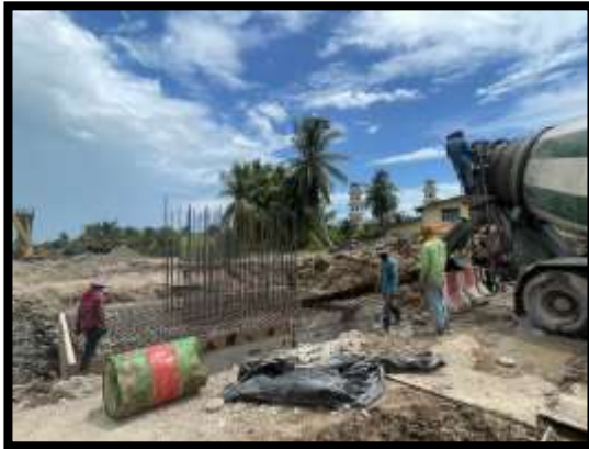
ภาพแสดงงานเทคอนกรีตฐานราก P11
