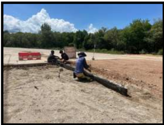
ภาพแสดงงานเข้าแบบข้าง และ บดอัดทรายหยาบ งานถนน Sta.0+500 ถึง Sta.0+540 และ Sta.0620 ถึง Sta.0+690 RT
