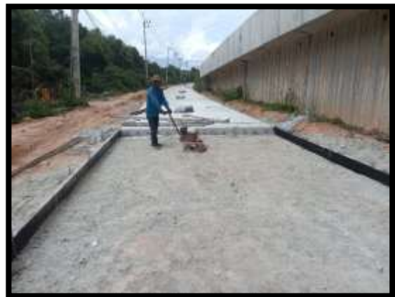
ภาพแสดงงานเข้าแบบข้าง และ บดอัดทรายหยาบ งานถนน Sta.0+500 ถึง Sta.0+540 และ Sta.0620 ถึง Sta.0+690 RT
