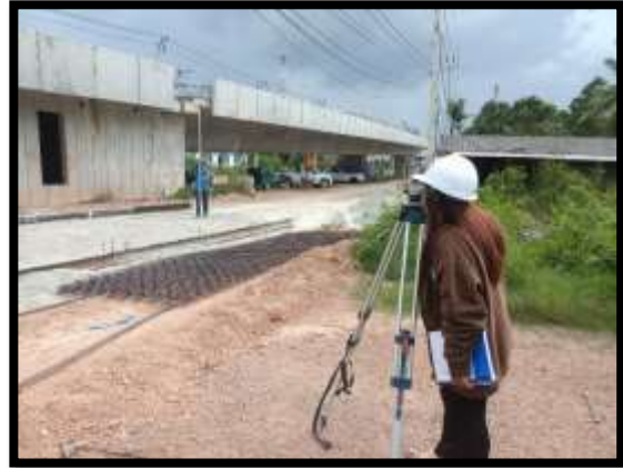
ภาพแสดงงานตรวจระดับแบบข้าง และ ทราซายาบ งานถนน Sta.0+500 ถึง Sta.0+540 และ Sta.0620 ถึง Sta.0+690 RT
