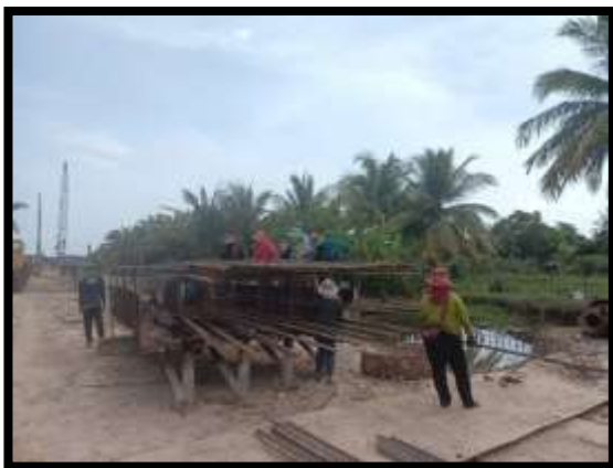
ภาพแสดงงานผูกเหล็กโครงสร้างเสาตอม่อ P17
