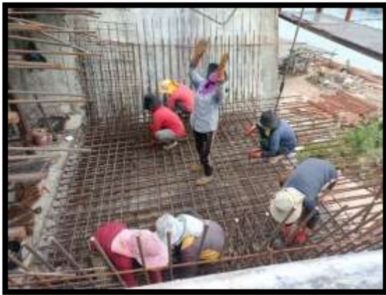
ภาพแสดงงานผูกเหล็กพื้นล่าง และ ผนังข้าง งาน Balance P8 Type D-D
