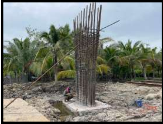
ภาพแสดงงานติดตั้งโครงสร้างเสาตอม่อ P17
