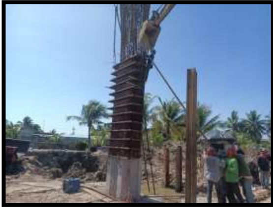
ภาพแสดงงานเข้าแบบโครงสร้างเสาตอม่อ P13
