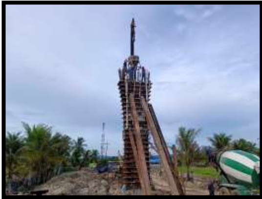
ภาพแสดงงานเทคอนกรีตโครงสร้างเสาตอม่อ P13
