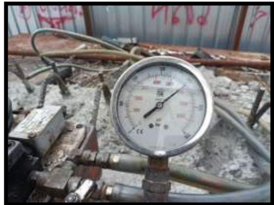
ภาพแสดงงานติดตั้งอัดแรงตามขวาง งาน Balance P8 Type C-C
