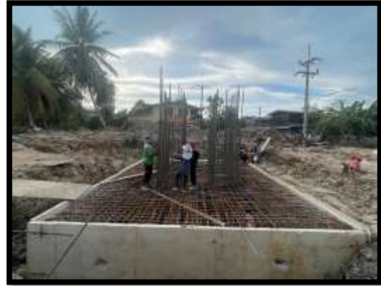
ภาพแสดงงานผูกเหล็กฐานรากและโครงสร้างเสาตอม่อ P11
