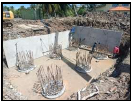
ภาพแสดงงานติดตั้ง Precast Skirt P11
