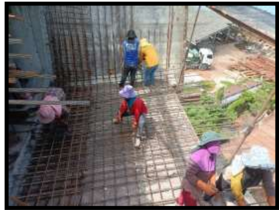
ภาพแสดงงานผูกเหล็กพื้นล่าง งาน Balance P8 Type C-C
