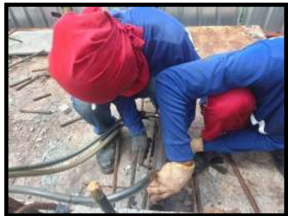
ภาพแสดงงานดึงลวดอัดแรงตามขวาง งาน Balance P8 Type B-B
