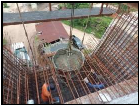
ภาพแสดงงานเทคอนกรีตพื้นล่าง งาน Balance P8 Type B-B
