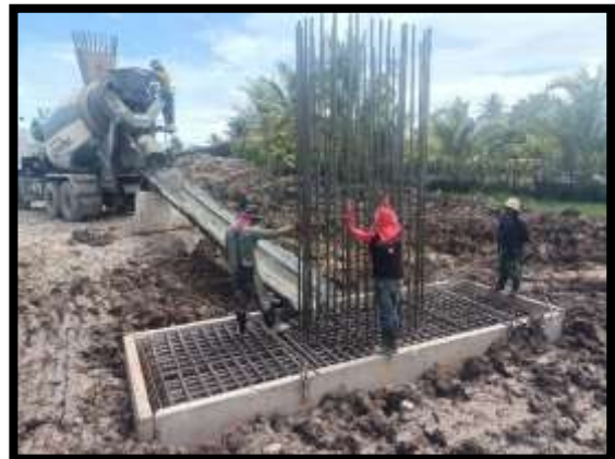
ภาพแสดงงานเทคอนกรีตฐานราก P12
