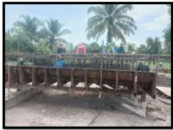
ภาพแสดงงานผูกเหล็กโครงสร้างเสาตอม่อ P17
