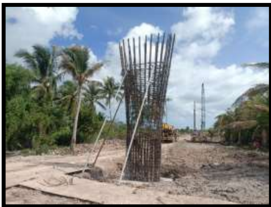
ภาพแสดงงานติดตั้งโครงสร้างเสาตอม่อ P16
