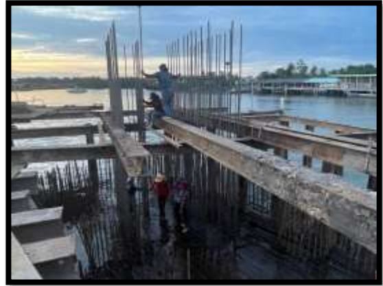
ภาพแสดงงานผูกเหล็กโครงสร้างเสาตอม่อ P10
