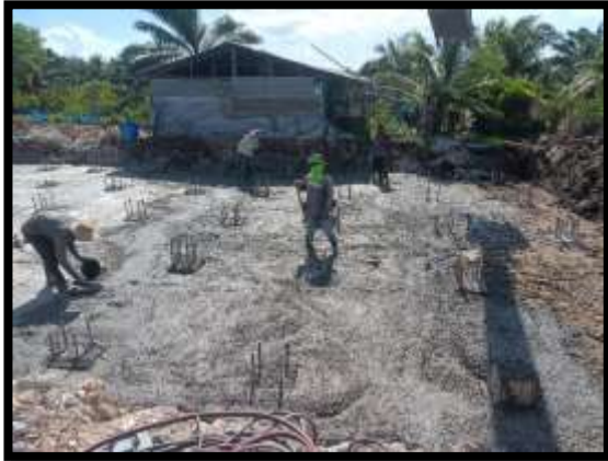
ภาพแสดงงานเทคอนกรีตทรายหยาบเสาะเข็มตอก งาน Transition (ฝั่งเกาะ)
