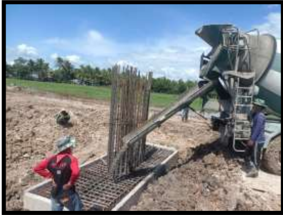
ภาพแสดงงานเทคอนกรีตฐานราก P14
