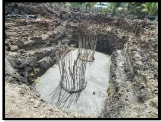
ภาพแสดงงานเทคอนกรีตหยาบ P12
