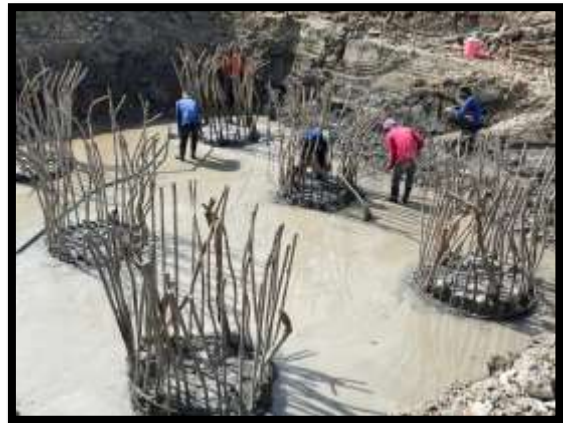
ภาพแสดงงานผูกเหล็กฐานราก P10
