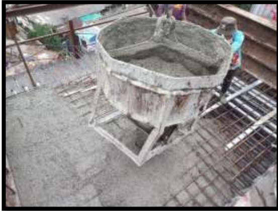
ภาพแสดงงานเทคอนกรีตพื้นบน งาน Balance P8 Type C-C
