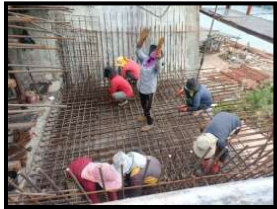
ภาพแสดงงานผูกเหล็กพื้นล่าง และ ผนังข้าง งาน Balance P8 Type D-D
