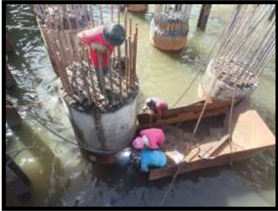
ภาพแสดงงานตัดตกแต่งเสาเข็มเจาะ P10
