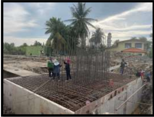
ภาพแสดงงานผูกเหล็กฐานรากและโครงสร้างเสาตอม่อ P11
