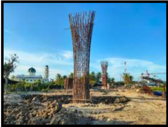
ภาพแสดงงานติดตั้งโครงสร้างเสาตอม่อ P14
