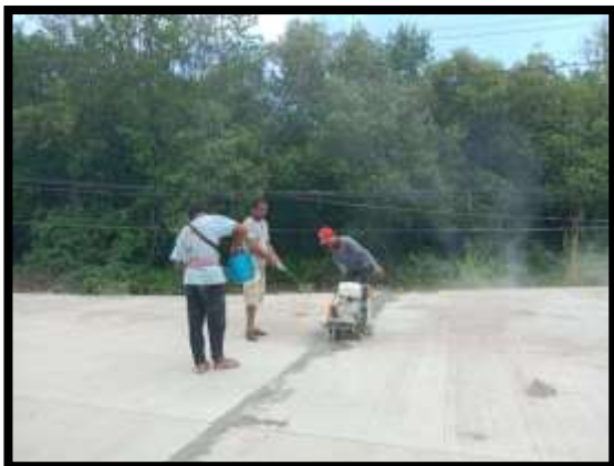
ภาพแสดงงานตัดรอยต่อ พร้อมยาแนวรอยต่อ ตามขวางและตามยาว งานถนน Sta.0+370 ถึง Sta.0+700
