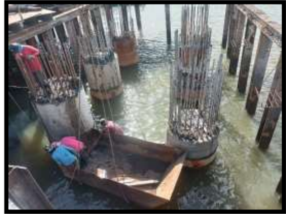
ภาพแสดงงานตัดตกแต่งเสาเข็มเจาะ P10
