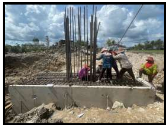
ภาพแสดงงานผูกเหล็กฐานราก และ โครงสร้างเสาตอม่อ P14
