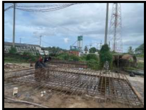
ภาพแสดงงานเข้าแบบ พร้อมผูกเหล็กกำแพง Transition (ฝั่งเกาะ)
