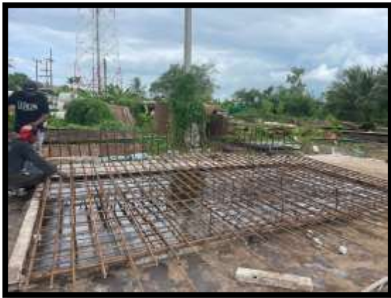
ภาพแสดงงานเข้าแบบ พร้อมผูกเหล็กกำแพง Transition (ฝั่งเกาะ)
