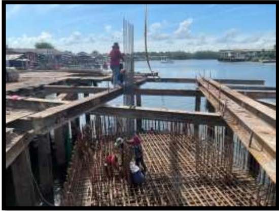
ภาพแสดงงานผูกเหล็กโครงสร้างเสาตอม่อ P10
