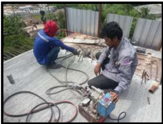
ภาพแสดงงานดึงลวดอัดแรงตามขวาง งาน Balance P8 Type B-B
