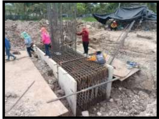
ภาพแสดงงานผูกเหล็กฐานราก P12
