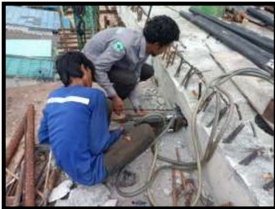
ภาพแสดงงานติดตั้งอัดแรงตามขวาง งาน Balance P8 Type C-C
