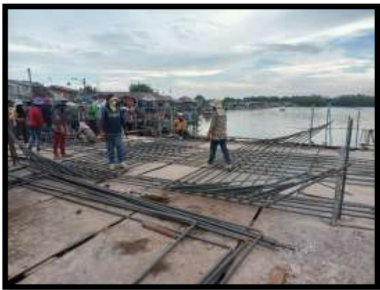
ภาพแสดงงานผูกเหล็กฐานราก P10
