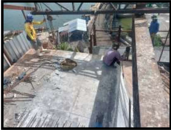
ภาพแสดงงานเข้าแบบพื้นล่าง งาน Balance P8 Type D-D
