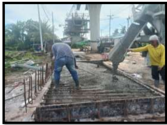
ภาพแสดงงานเทคอนกรีตกำแพง Transition (ฝั่งเกาะ)
