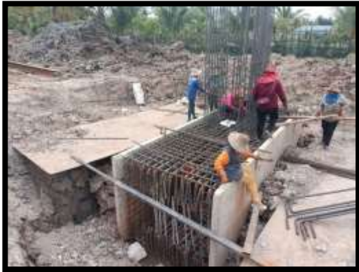
ภาพแสดงงานผูกเหล็กฐานราก P12
