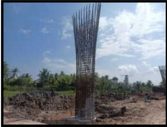
ภาพแสดงงานติดตั้งโครงสร้างเสาตอม่อ P15
