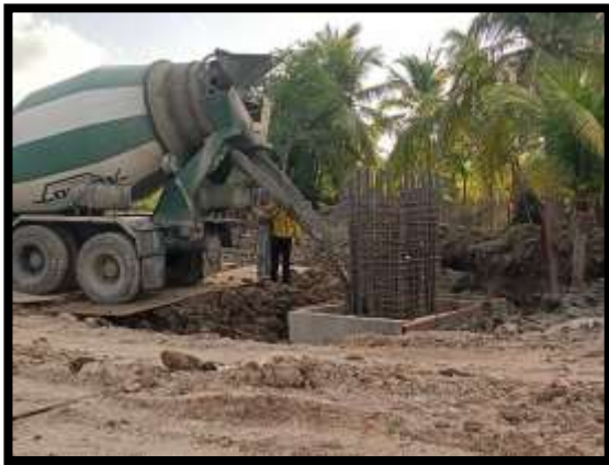
ภาพแสดงงานเทคอนกรีตฐานราก P17
