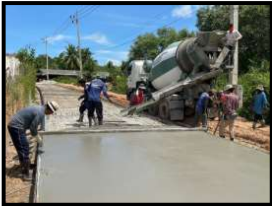
ภาพแสดงงานเทคอนกรีต งานถนน Sta.0+500 ถึง Sta.0+540 และ Sta.0620 ถึง Sta.0+690 RT
