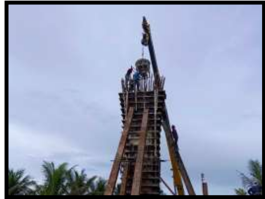
ภาพแสดงงานเทคอนกรีตโครงสร้างเสาตอม่อ P13
