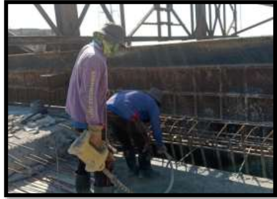
ภาพแสดงงานเทคอนกรีตผนังข้าง งาน Balance P8 Type C-C
