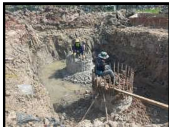
ภาพแสดงงานตัดตกแต่งเสาเข็มเจาะ P12
