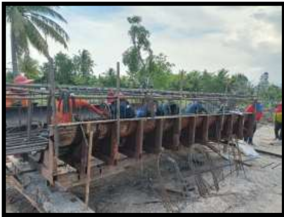
ภาพแสดงงานผูกเหล็กโครงสร้างเสาตอม่อ P16
