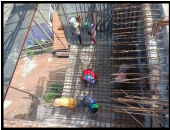
ภาพแสดงงานผูกเหล็กพื้นล่าง งาน Balance P8 Type C-C
