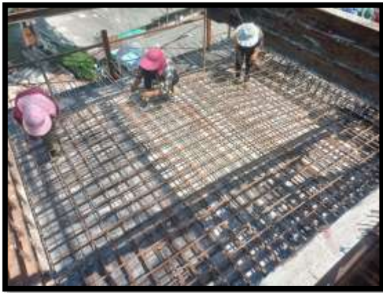
ภาพแสดงงานผูกเหล็กพื้นบน งาน Balance P8 Type C-C
