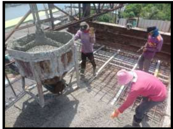
ภาพแสดงงานเทคอนกรีตพื้นบน งาน Balance P8 Type B-B
