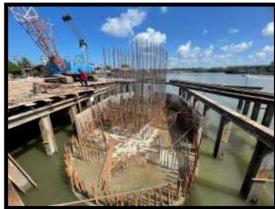
ภาพแสดงงานติดตั้ง Precast Skirt P10
