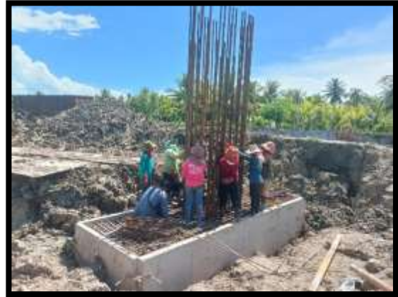
ภาพแสดงงานผูกเหล็กฐานราก และ โครงสร้างเสาตอม่อ P13
