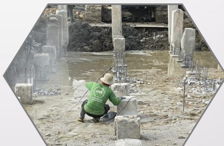
ตัดตกแต่งงานเสาเข็มตอก (Transition) ฟังเกาะ
