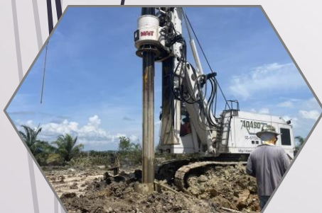
งานเจาะชั้นดินเสาเข็มเจาะ P10 และ P14 ถึง P18
