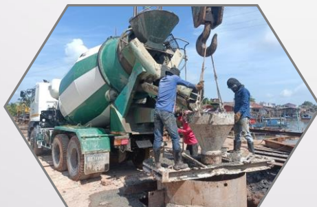
งานเทคอนกรีตเสาเข็มเจาะ P10 และ P14 ถึง P18
