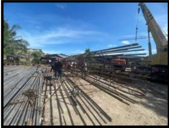
ภาพแสดงงานผูกเหล็ก งานเสาเข็มเจาะ P14 ต้นที่ 1
