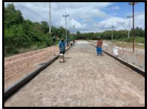
ภาพแสดงงานเข้าแบบข้าง พร้อมบดอัดทรายหยาบ งานถนน Sta.0+540 ถึง Sta.0+620 RT
