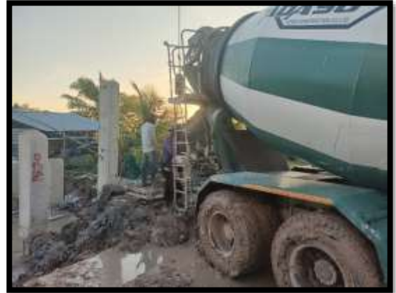
ภาพแสดงงานเทคอนกรีต งานเสาเข็มเจาะ P18 ต้นที่ 1
