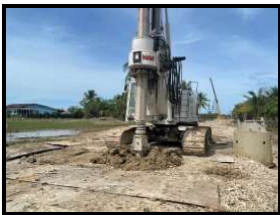
ภาพแสดงงานเจาะเสาเข็ม งานเสาเข็มเจาะ P15
