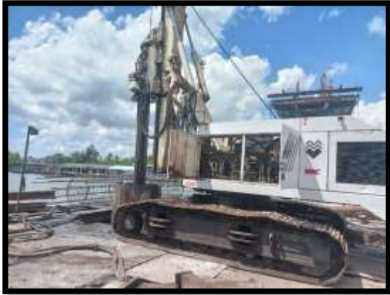
ภาพแสดงงานเจาะเสาเข็ม งานเสาเข็มเจาะ P10 ต้นที่ 2
