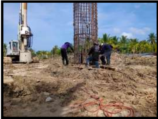
ภาพแสดงงานลงเหล็ก งานเสาเข็มเจาะ P14 ต้นที่ 1
