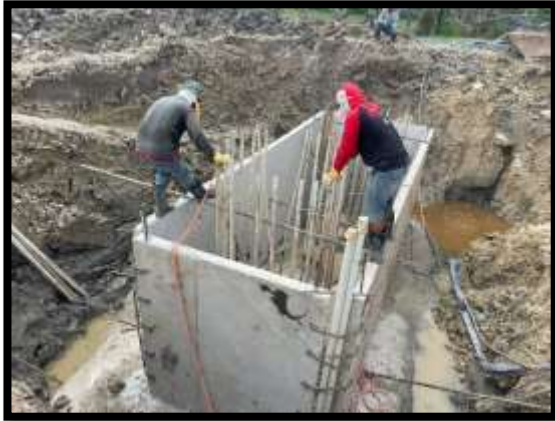
ภาพแสดงงานติดตั้ง Precast Skirt P14
