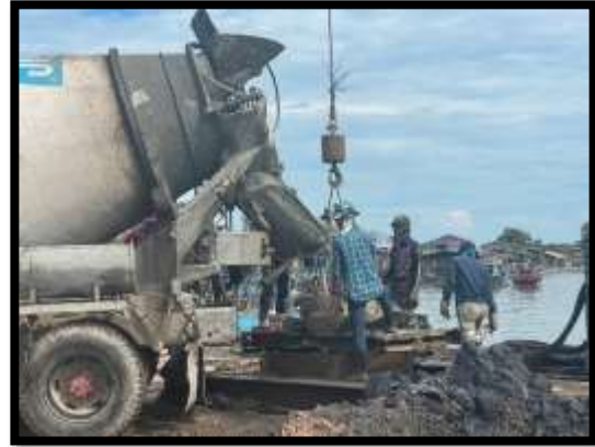
ภาพแสดงงานเทคอนกรีต งานเสาเข็มเจาะ P10 ต้นที่ 3
