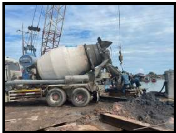
ภาพแสดงงานเทคอนกรีต งานเสาเข็มเจาะ P10 ต้นที่ 2
