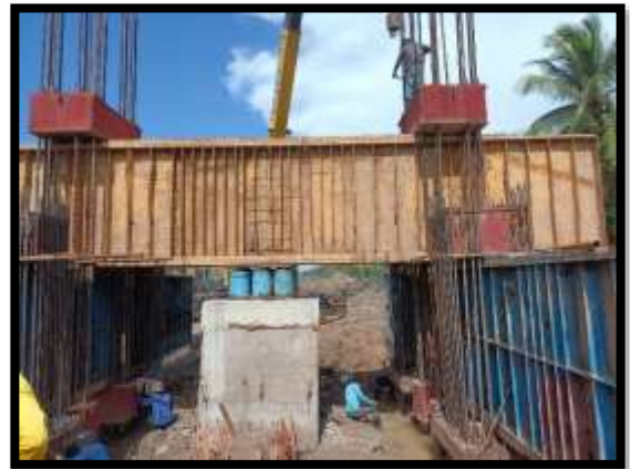
ภาพแสดงงานติดตั้งชุด Static Load Test
