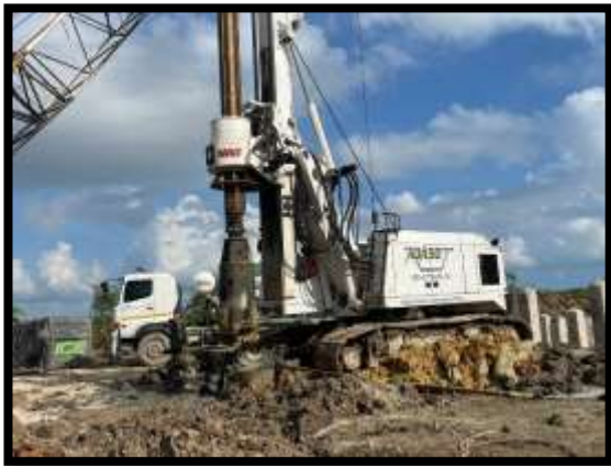
ภาพแสดงงานเจาะเสาเข็ม งานเสาเข็มเจาะ P18 ต้นที่ 3
