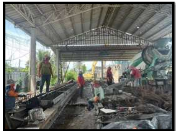
ภาพแสดงงานผูกเหล็กพร้อมเทคอนกรีตคั่นหินปิดทางเท้า
