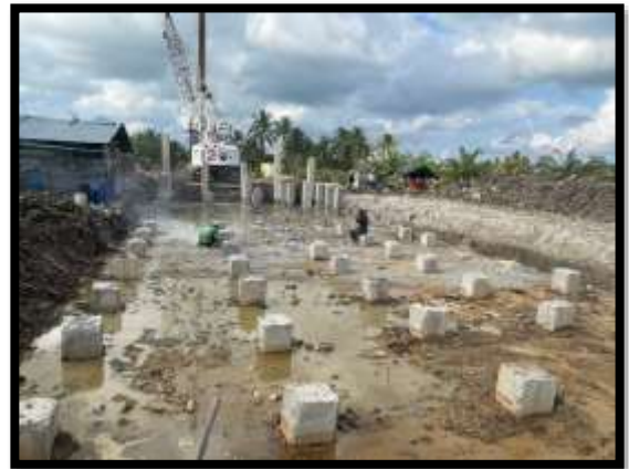
ภาพแสดงงานตัดตกแต่งเสาเข็มตอก งาน Transition (ฝั่งเกาะ)
