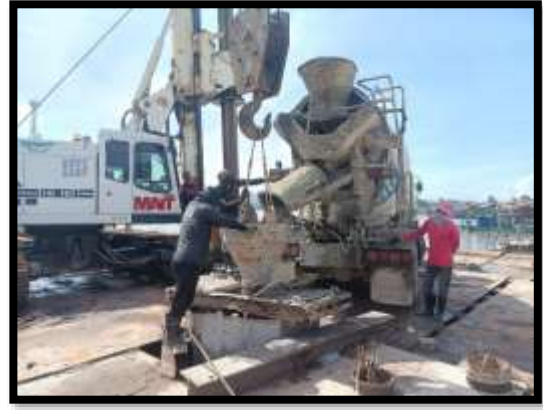
ภาพแสดงงานเทคอนกรีต งานเสาเข็มเจาะ P10 ต้นที่ 4
