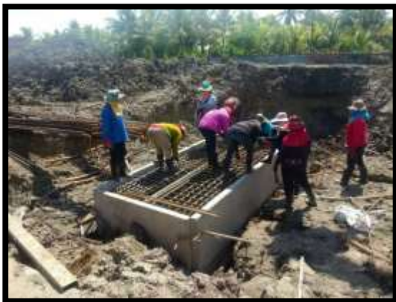
ภาพแสดงงานผูกเหล็กโครงสร้างเสาตอม่อ P13
