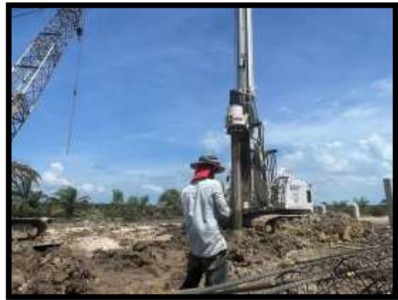
ภาพแสดงงานเจาะเสาเข็ม งานเสาเข็มเจาะ P18 ต้นที่ 3
