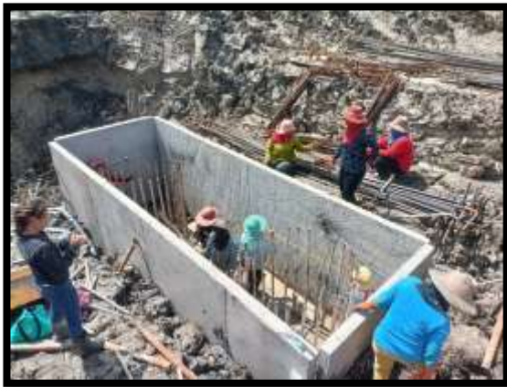
ภาพแสดงงานติดตั้ง Precast Skirt P13
