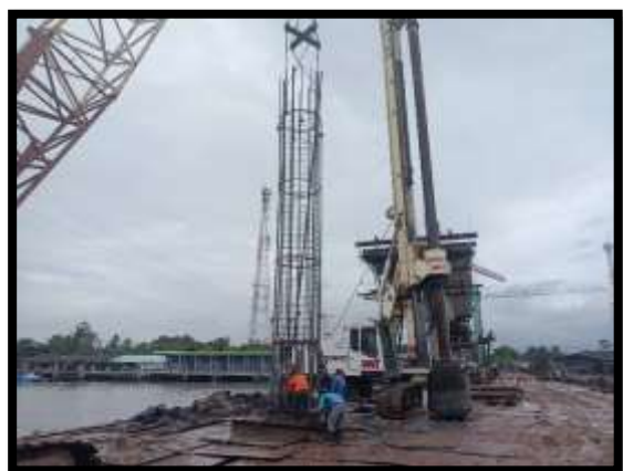
ภาพแสดงงานลงเหล็ก งานเสาเข็มเจาะ P10 ต้นที่ 3
