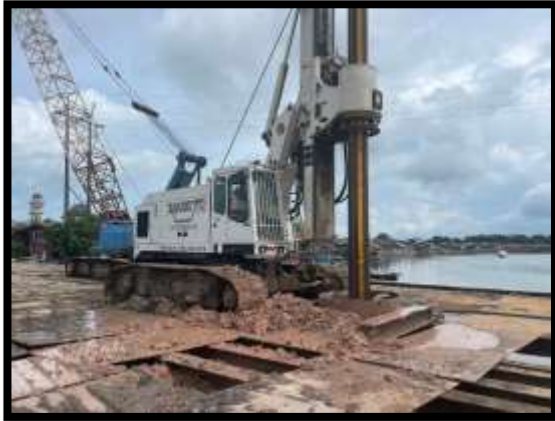
ภาพแสดงงานเจาะเสาเข็ม งานเสาเข็มเจาะ P10 ต้นที่ 6
