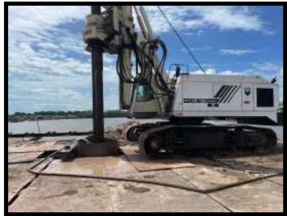
ภาพแสดงงานปัก Casing งานเสาเข็มเจาะ P10 ต้นที่ 3
