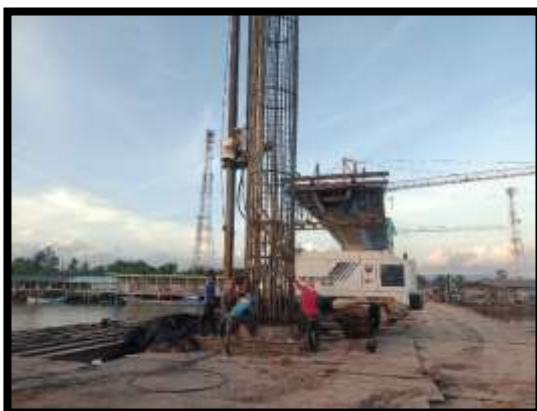
ภาพแสดงงานลงเหล็ก งานเสาเข็มเจาะ P10 ต้นที่ 4
