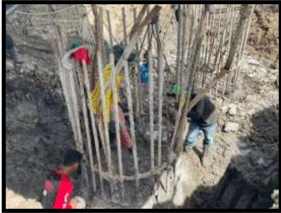
ภาพแสดงงานตัดตกแต่งเสาเข็มเจาะ P13
