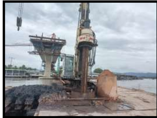
ภาพแสดงงานเจาะเสาเข็ม งานเสาเข็มเจาะ P10 ต้นที่ 4
