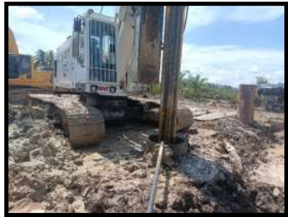
ภาพแสดงงานเจาะเสาเข็ม งานเสาเข็มเจาะ P18 ต้นที่ 1
