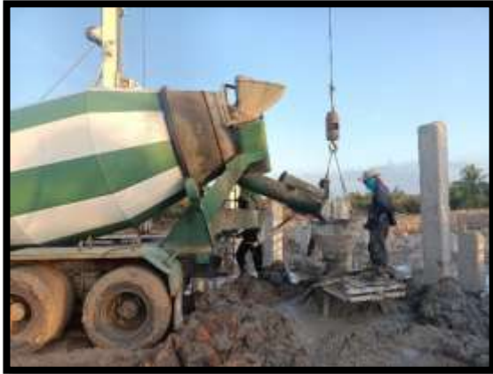
ภาพแสดงงานเทคอนกรีต งานเสาเข็มเจาะ P18 ต้นที่ 1
