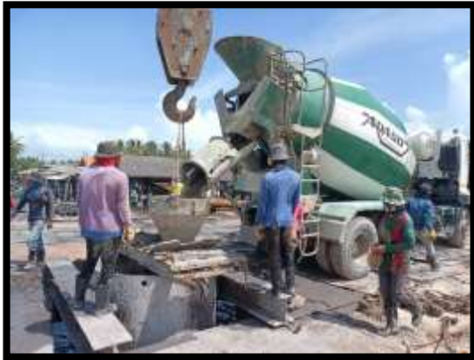
ภาพแสดงงานเทคอนกรีต งานเสาเข็มเจาะ P10 ต้นที่ 6
