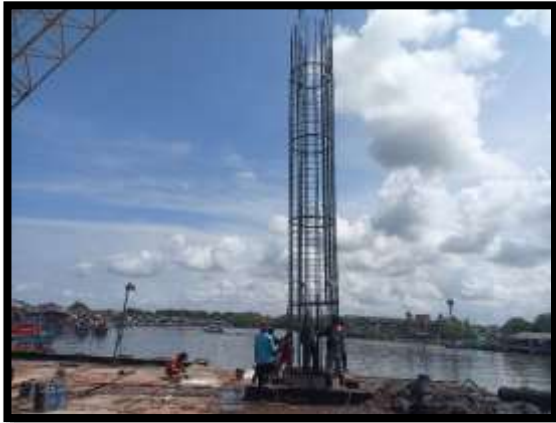
ภาพแสดงงานลงเหล็ก งานเสาเข็มเจาะ P10 ต้นที่ 2
