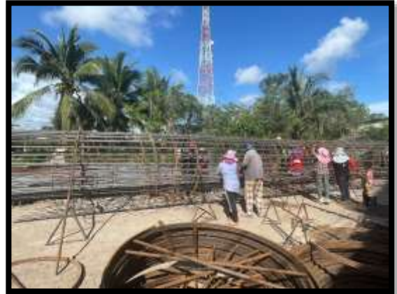
ภาพแสดงงานผูกเหล็ก งานเสาเข็มเจาะ P14 ต้นที่ 1
