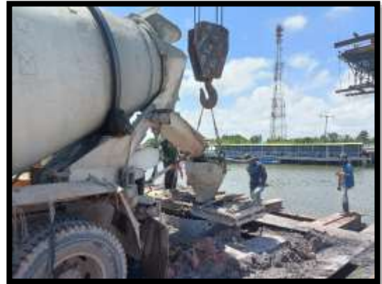
ภาพแสดงงานเทคอนกรีต งานเสาเข็มเจาะ P10 ต้นที่ 6
