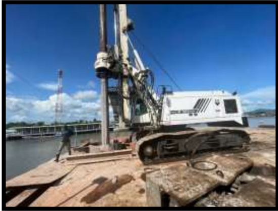
ภาพแสดงงานเจาะเสาเข็ม งานเสาเข็มเจาะ P10 ต้นที่ 1
