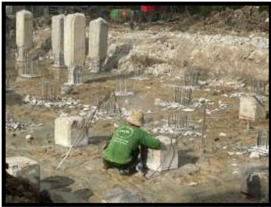
ภาพแสดงงานตัดตกแต่งเสาเข็มตอก งาน Transition (ฝั่งเกาะ)
