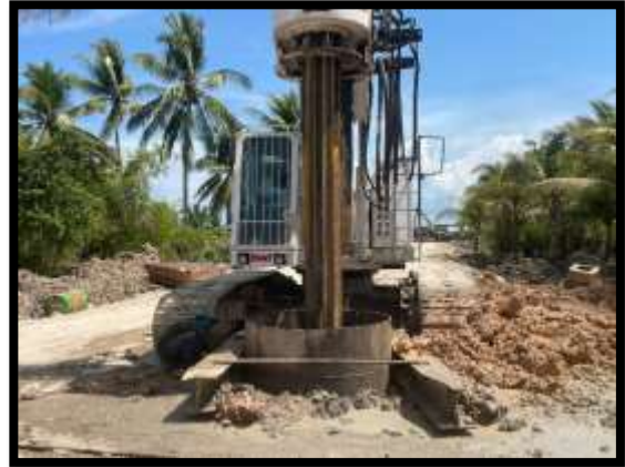
ภาพแสดงงานเจาะเสาเข็ม งานเสาเข็มเจาะ P16
