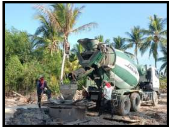
ภาพแสดงงานเทคอนกรีต งานเสาเข็มเจาะ P16
