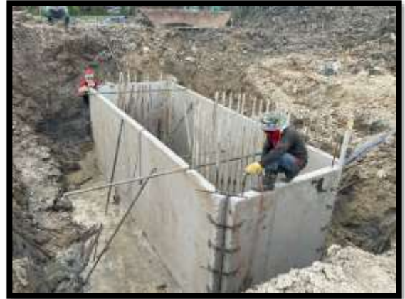
ภาพแสดงงานติดตั้ง Precast Skirt P14
