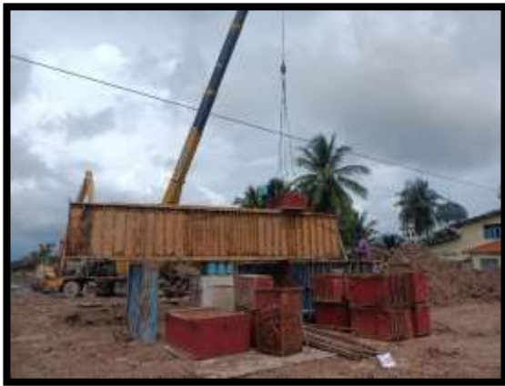
ภาพแสดงงานติดตั้งชุด Static Load Test
