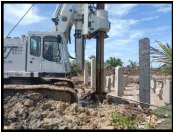
ภาพแสดงงานเจาะเสาเข็ม งานเสาเข็มเจาะ P18 ต้นที่ 1
