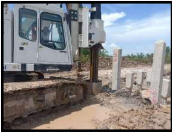
ภาพแสดงงานเจาะเสาเข็ม งานเสาเข็มเจาะ P18 ต้นที่ 2
