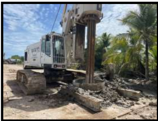
ภาพแสดงงานเจาะเสาเข็ม งานเสาเข็มเจาะ P17
