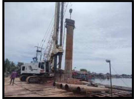
ภาพแสดงงานปัก Casing งานเสาเข็มเจาะ P10 ต้นที่ 3
