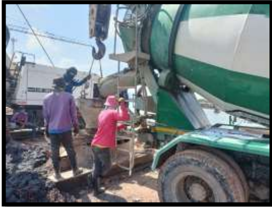
ภาพแสดงงานเทคอนกรีต งานเสาเข็มเจาะ P10 ต้นที่ 3
