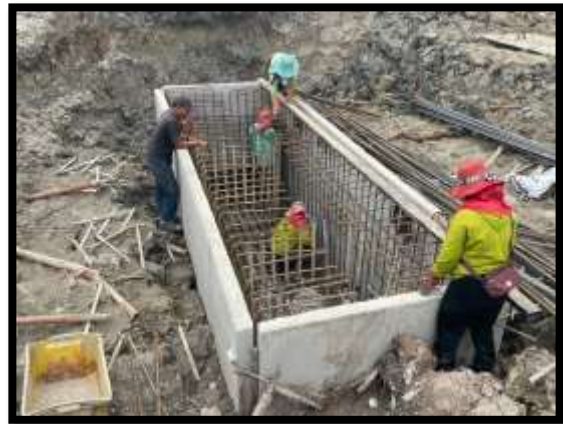
ภาพแสดงงานติดตั้ง Precast Skirt P13
