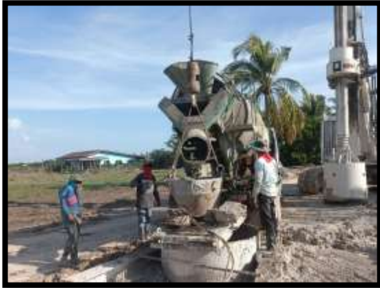
ภาพแสดงงานเทคอนกรีต งานเสาเข็มเจาะ P17
