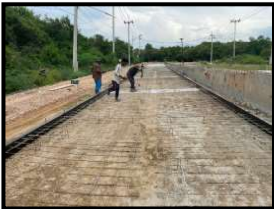
ภาพแสดงงานผูกเหล็ก งานถนน Sta.0+540 ถึง Sta.0+620 RT
