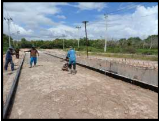
ภาพแสดงงานเข้าแบบข้าง พร้อมบดอัดทรายหยาบ งานถนน Sta.0+540 ถึง Sta.0+620 RT
