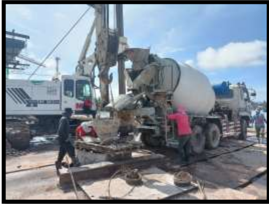
ภาพแสดงงานเทคอนกรีต งานเสาเข็มเจาะ P10 ต้นที่ 4
