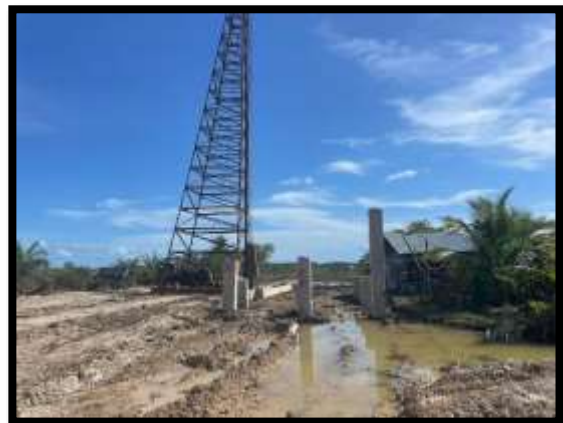
ภาพแสดงงานตอกเสาเข็ม งาน Transition (ฝั่งเกาะ)
