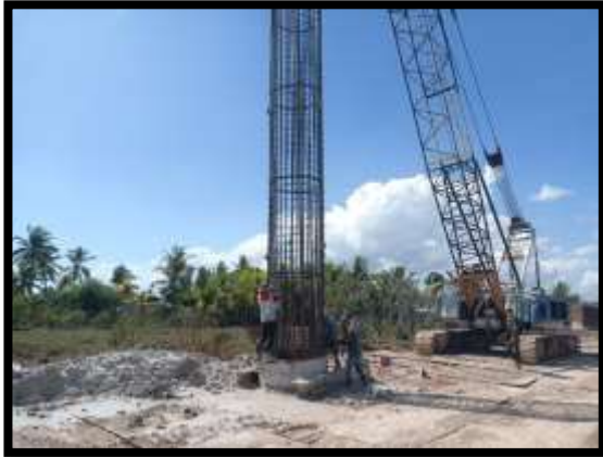
ภาพแสดงงานลงเหล็ก งานเสาเข็มเจาะ P15
