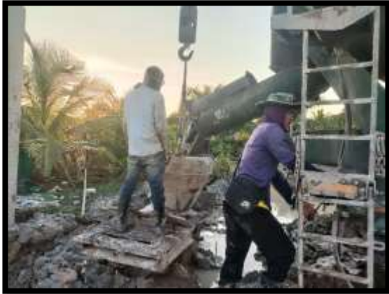
ภาพแสดงงานเทคอนกรีต งานเสาเข็มเจาะ P18 ต้นที่ 2
