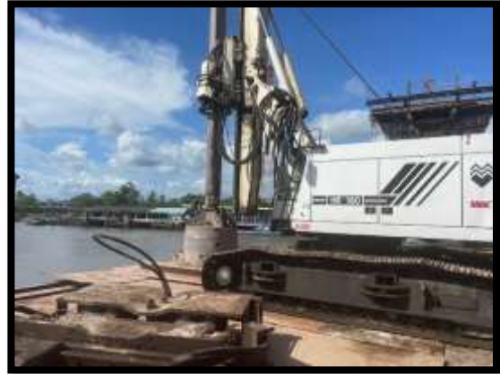
ภาพแสดงงานเจาะเสาเข็ม งานเสาเข็มเจาะ P10 ต้นที่ 1
