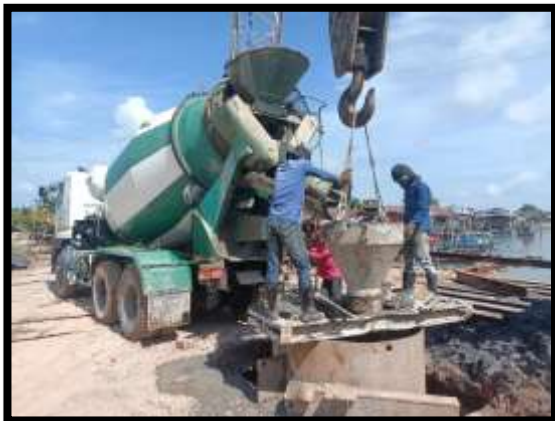
ภาพแสดงงานเทคอนกรีต งานเสาเข็มเจาะ P10 ต้นที่ 5
