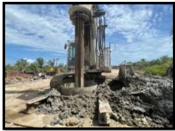
ภาพแสดงงานเจาะเสาเข็ม งานเสาเข็มเจาะ P17
