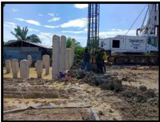
ภาพแสดงงานลงเหล็ก งานเสาเข็มเจาะ P18 ต้นที่ 2
