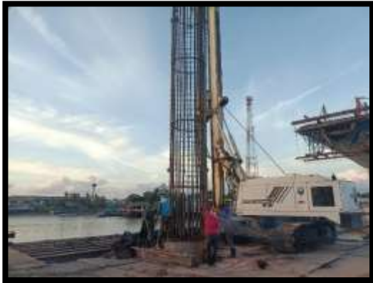
ภาพแสดงงานลงเหล็ก งานเสาเข็มเจาะ P10 ต้นที่ 5
