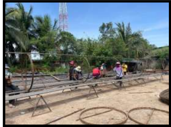
ภาพแสดงงานผูกเหล็ก งานเสาเข็มเจาะ P14 ต้นที่ 2
