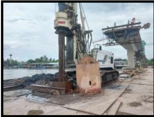
ภาพแสดงงานเจาะเสาเข็ม งานเสาเข็มเจาะ P10 ต้นที่ 4
