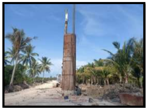
ภาพแสดงงานปัก Casing งานเสาเข็มเจาะ P16
