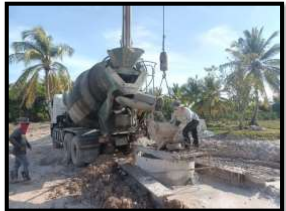
ภาพแสดงงานเทคอนกรีต งานเสาเข็มเจาะ P15
