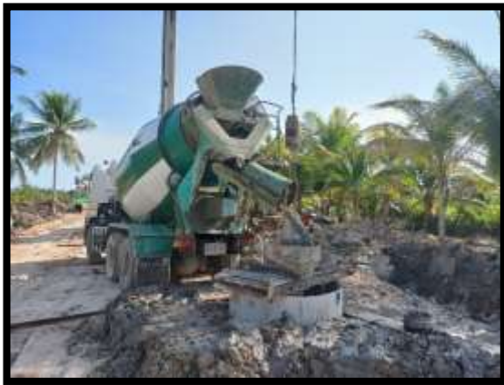
ภาพแสดงงานเทคอนกรีต งานเสาเข็มเจาะ P16
