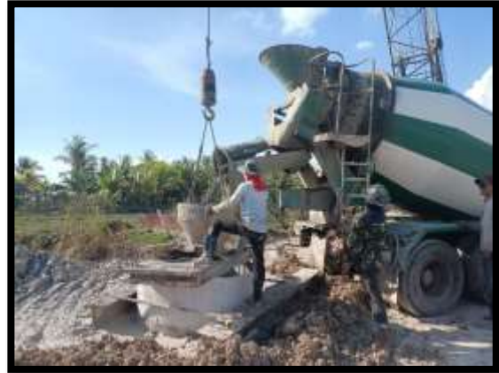
ภาพแสดงงานเทคอนกรีต งานเสาเข็มเจาะ P17
