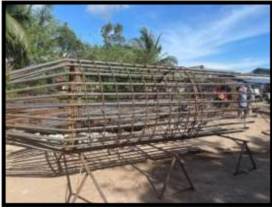
ภาพแสดงงานผูกเหล็ก งานเสาเข็มเจาะ P10 ต้นที่ 1
