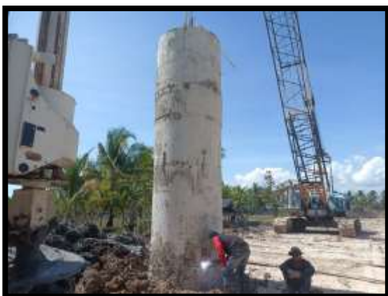
ภาพแสดงงานปัก Casing งานเสาเข็มเจาะ P16
