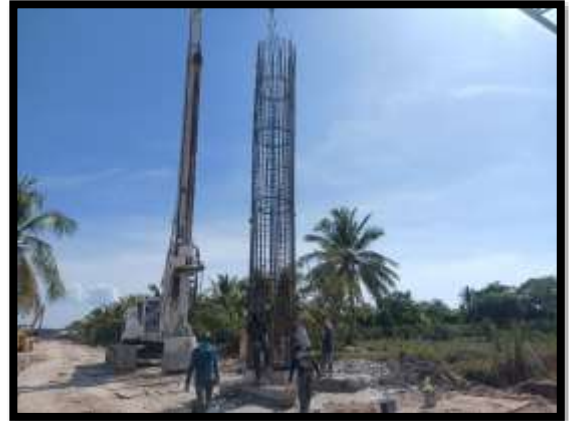
ภาพแสดงงานลงเหล็ก งานเสาเข็มเจาะ P15
