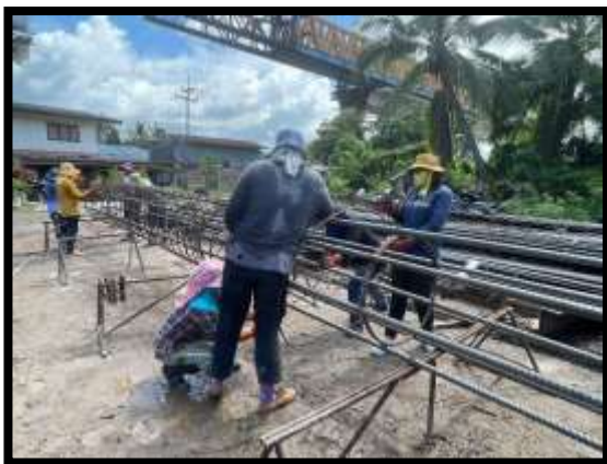
ภาพแสดงงานผูกเหล็ก งานเสาเข็มเจาะ P18 ต้นที่ 1
