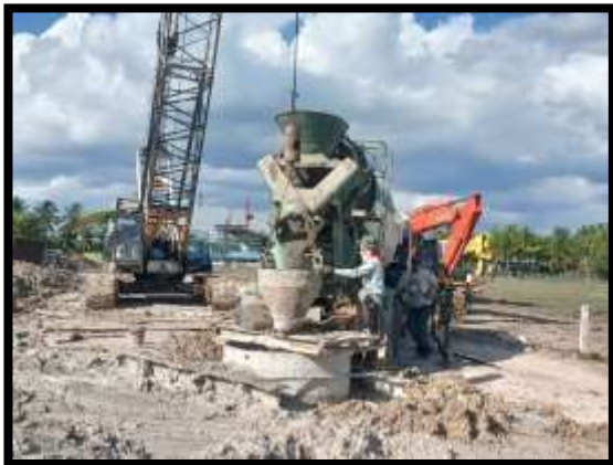
ภาพแสดงงานเทคอนกรีต งานเสาเข็มเจาะ P15
