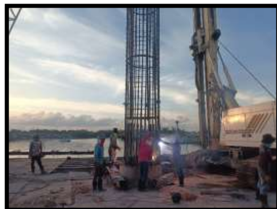
ภาพแสดงงานลงเหล็ก งานเสาเข็มเจาะ P10 ต้นที่ 4
