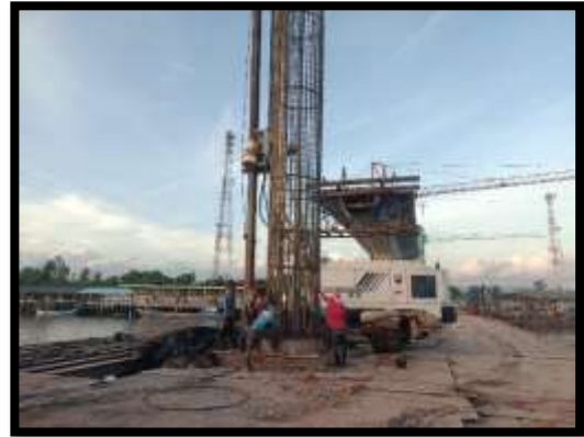
ภาพแสดงงานลงเหล็ก งานเสาเข็มเจาะ P10 ต้นที่ 5
