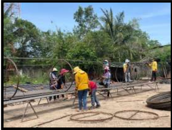
ภาพแสดงงานผูกเหล็ก งานเสาเข็มเจาะ P14 ต้นที่ 2
