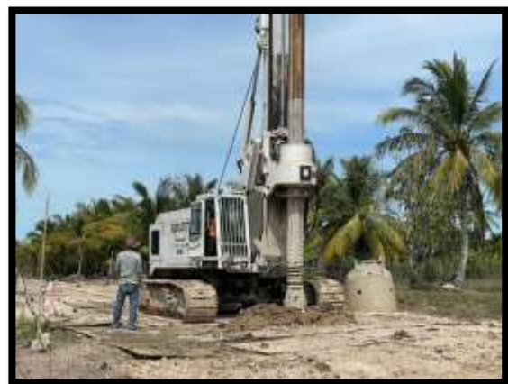
ภาพแสดงงานเจาะเสาเข็ม งานเสาเข็มเจาะ P15
