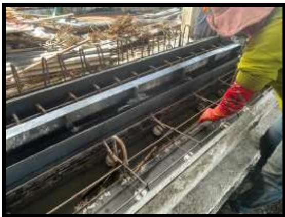
ภาพแสดงงานผูกเหล็กพร้อมเทคอนกรีตคั่นหินปิดทางเท้า
