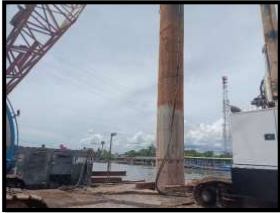
ภาพแสดงงานปัก Casing งานเสาเข็มเจาะ P10 ต้นที่ 3
