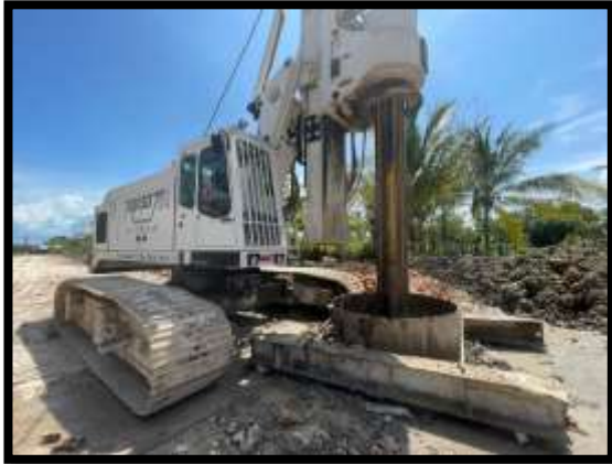
ภาพแสดงงานเจาะเสาเข็ม งานเสาเข็มเจาะ P16
