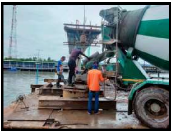
ภาพแสดงงานเทคอนกรีต งานเสาเข็มเจาะ P10 ต้นที่ 1
