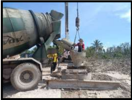
ภาพแสดงงานเทคอนกรีต งานเสาเข็มเจาะ P14 ต้นที่ 2
