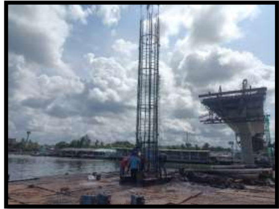
ภาพแสดงงานลงเหล็ก งานเสาเข็มเจาะ P10 ต้นที่ 2
