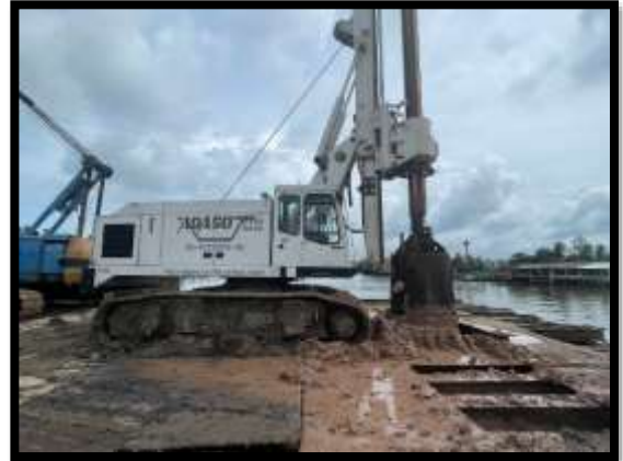
ภาพแสดงงานเจาะเสาเข็ม งานเสาเข็มเจาะ P10 ต้นที่ 6
