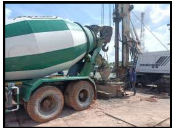
ภาพแสดงงานเทคอนกรีต งานเสาเข็มเจาะ P10 ต้นที่ 5
