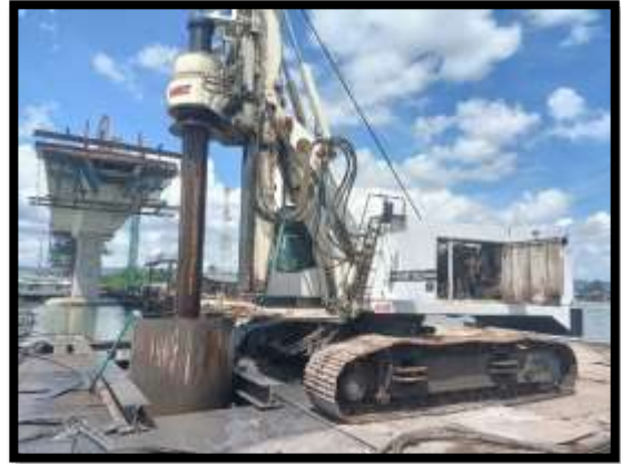
ภาพแสดงงานเจาะเสาเข็ม งานเสาเข็มเจาะ P10 ต้นที่ 2
