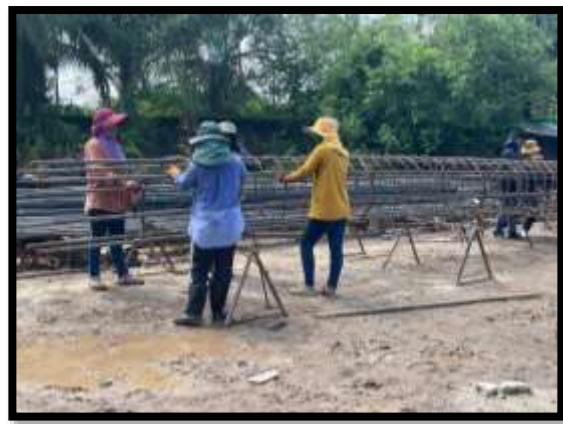
ภาพแสดงงานผูกเหล็ก งานเสาเข็มเจาะ P18 ต้นที่ 1
