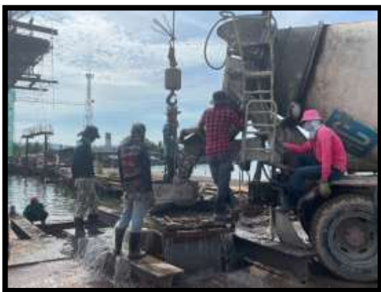
ภาพแสดงงานเทคอนกรีต งานเสาเข็มเจาะ P10 ต้นที่ 2
