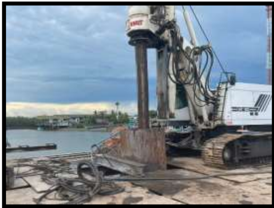
ภาพแสดงงานปัก Casing งานเสาเข็มเจาะ P10 ต้นที่ 3
