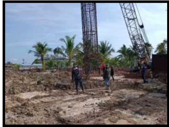
ภาพแสดงงานลงเหล็ก งานเสาเข็มเจาะ P14 ต้นที่ 1
