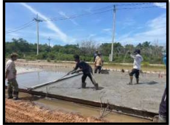
ภาพแสดงงานเทคอนกรีต งานถนน Sta.0+540 ถึง Sta.0+620 RT
