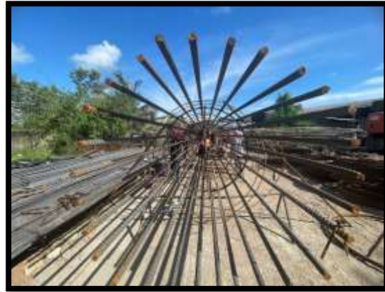
ภาพแสดงงานผูกเหล็ก งานเสาเข็มเจาะ P10 ต้นที่ 1
