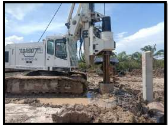
ภาพแสดงงานเจาะเสาเข็ม งานเสาเข็มเจาะ P18 ต้นที่ 2
