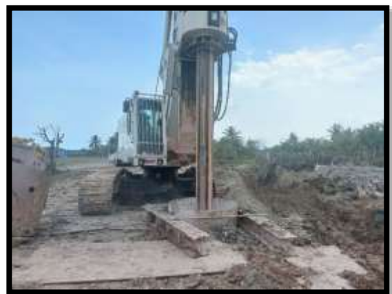
ภาพแสดงงานเจาะเสาเข็ม งานเสาเข็มเจาะ P14 ต้นที่ 1
