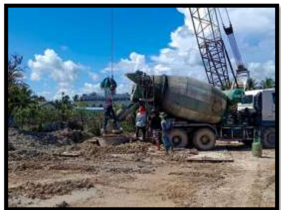
ภาพแสดงงานลงเหล็ก งานเสาเข็มเจาะ P14 ต้นที่ 1
