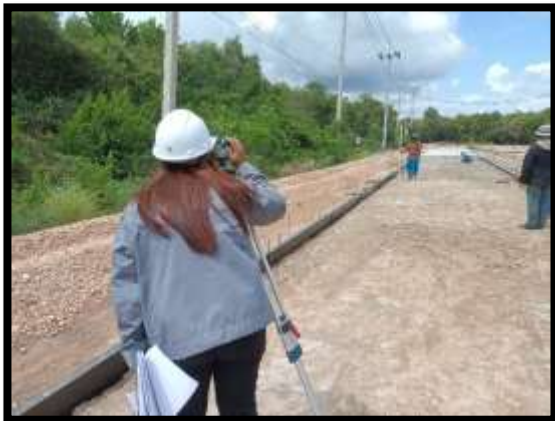
ภาพแสดงงานตรวจสอบระดับหลังแบบ และระดับชั้นทรายหยาบ งานถนน Sta.0+540 ถึง Sta.0+620 RT
