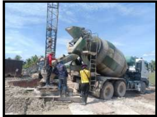
ภาพแสดงงานเทคอนกรีต งานเสาเข็มเจาะ P14 ต้นที่ 2
