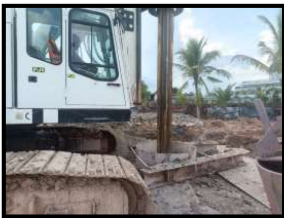
ภาพแสดงงานเจาะเสาเข็ม งานเสาเข็มเจาะ P14 ต้นที่ 1
