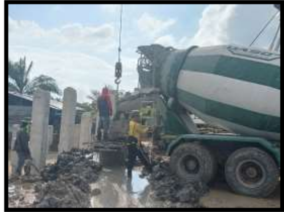
ภาพแสดงงานเทคอนกรีต งานเสาเข็มเจาะ P18 ต้นที่ 2
