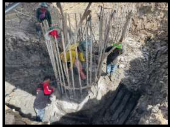
ภาพแสดงงานตัดตกแต่งเสาเข็มเจาะ P13
