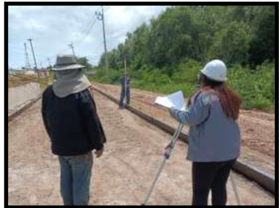
ภาพแสดงงานตรวจสอบระดับหลังแบบ และระดับชั้นทรายหยาบ งานถนน Sta.0+540 ถึง Sta.0+620 RT
