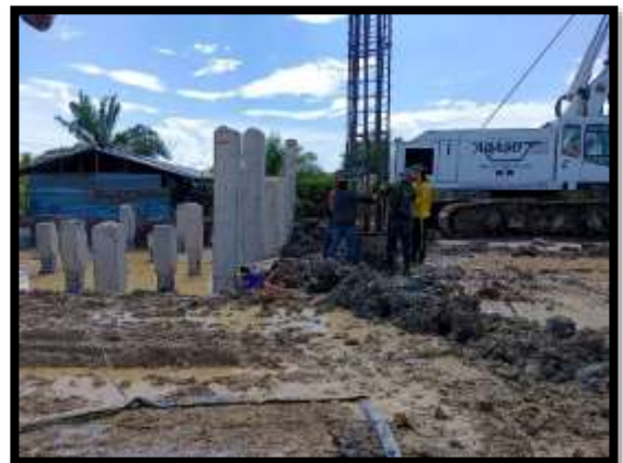
ภาพแสดงงานลงเหล็ก งานเสาเข็มเจาะ P18 ต้นที่ 2
