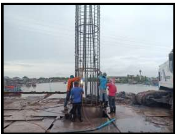
ภาพแสดงงานลงเหล็ก งานเสาเข็มเจาะ P10 ต้นที่ 3
