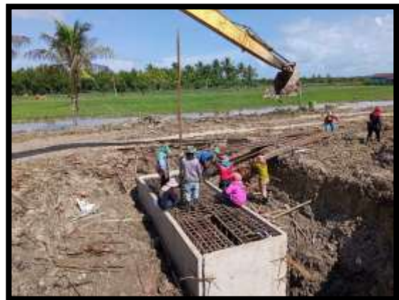
ภาพแสดงงานผูกเหล็กโครงสร้างเสาตอม่อ P13
