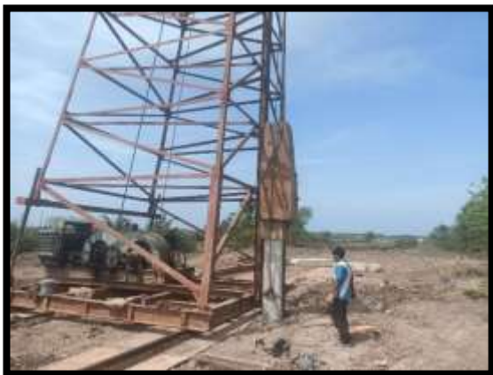
ภาพแสดงงานตอกเสาเข็ม งาน Transition (ฝั่งเกาะ)
