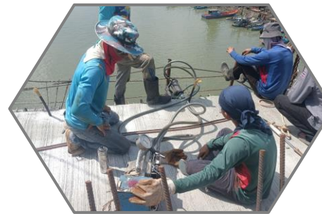
งานดิ่งลวดอัดแรง Balance P9 Type J-J
