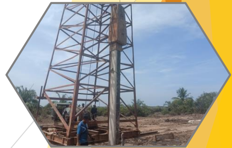
งานเสาเข็มตอก (Transition) ฝั่งเกาะ
