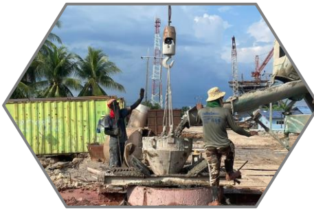
งานเทคอนกรีตเสาเข็มเจาะ P12 และ P13
