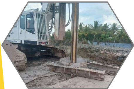
งานเจาะชั้นดินเสาเข็มเจาะ P12 และ P13
