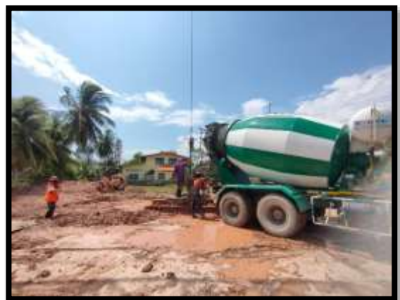
ภาพแสดงงานลงท่อ Timmy พร้อมเทคอนกรีต งานเสาเข็มเจาะ P11/3 และ P11/6
