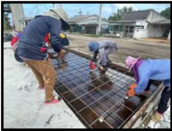
ภาพแสดงงานเข้าแบบ ผูกเหล็ก Skirt P11
