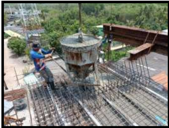
ภาพแสดงงานเทคอนกรีตพื้นบน งาน Balance P9 Type J-J
