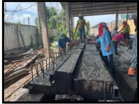
ภาพแสดงงานเข้าแบบ ผูกเหล็ก พร้อมเทคอนกรีต คั่นหินปิดทางเท้า
