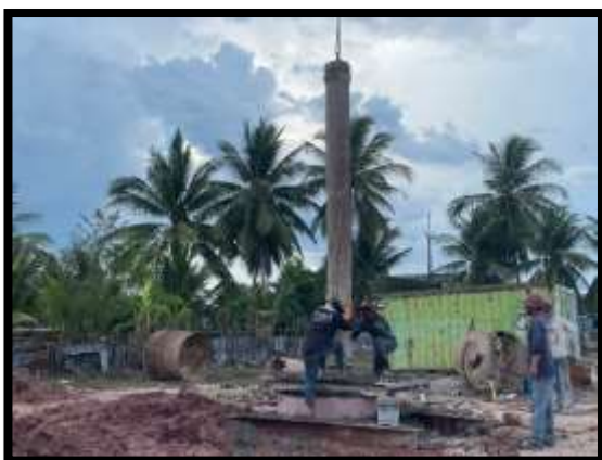
ภาพแสดงงานลงท่อ Timmy พร้อมเทคอนกรีต งานเสาเข็มเจาะ P12/2
