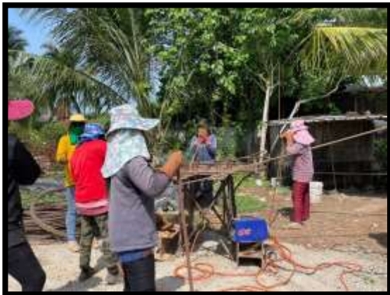
ภาพแสดงงานตัด ดัด และผูกเหล็กเสาเข็ม งานเสาเข็มเจาะ P12/2
