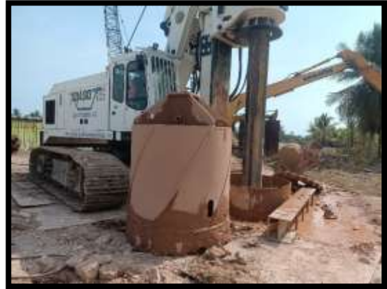
ภาพแสดงงานเจาะเสาเข็ม งานเสาเข็มเจาะ P11/5
