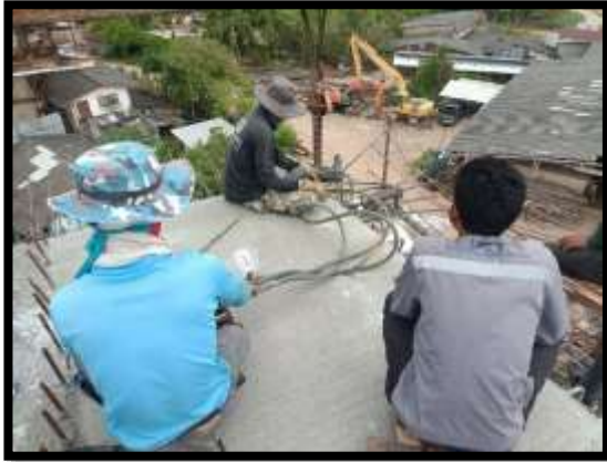
ภาพแสดงงานติดตั้งลวดอัดแรงตามขวาง งาน Balance P9 Type I-I
