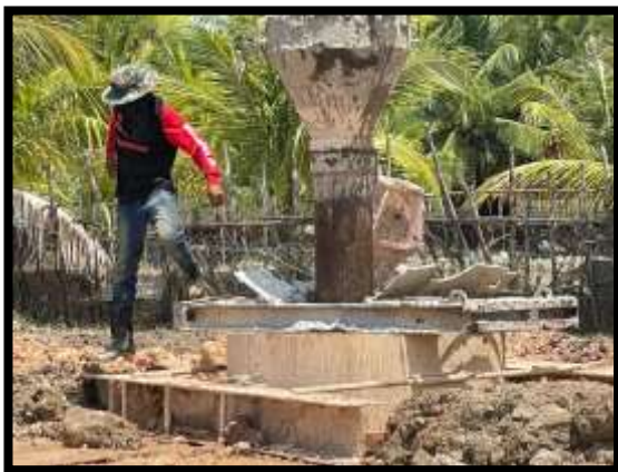
ภาพแสดงงานเทคอนกรีต งานเสาเข็มเจาะ P12/1
