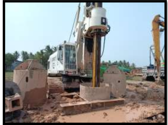
ภาพแสดงงานเจาะเสาเข็ม งานเสาเข็มเจาะ P12/1
