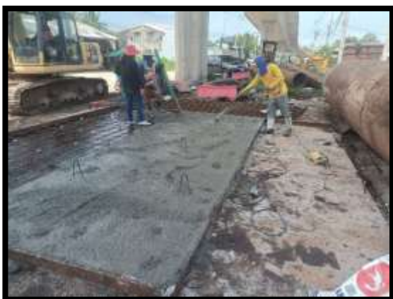
ภาพแสดงงานเทคอนกรีต Skirt P11
