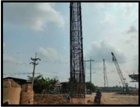
ภาพแสดงงานลงเหล็ก งานเสาเข็มเจาะ P11/3 และ P11/6
