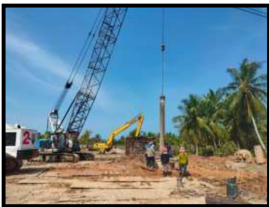
ภาพแสดงงานลงท่อ Timmy พร้อมเทคอนกรีต งานเสาเข็มเจาะ P11/3 และ P11/6
