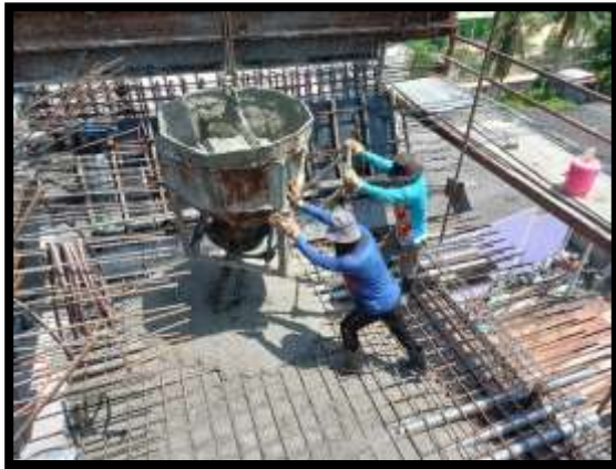
ภาพแสดงงานเทคอนกรีตพื้นล่าง งาน Balance P9 Type J-J
