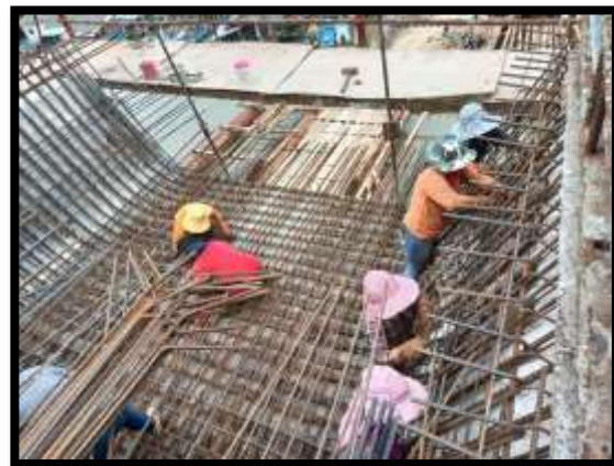
ภาพแสดงงานผูกเหล็กพื้นล่างและผนังข้าง งาน Balance P9 Type J-J
