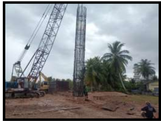
ภาพแสดงงานลงเหล็ก งานเสาเข็มเจาะ P11/4
