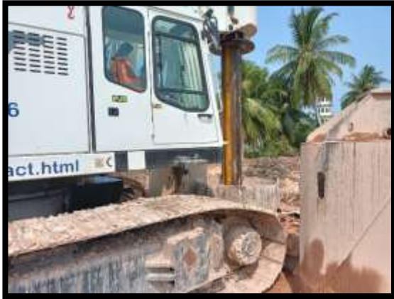
ภาพแสดงงานเจาะเสาเข็ม งานเสาเข็มเจาะ P12/1
