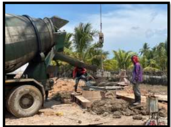
ภาพแสดงงานเทคอนกรีต งานเสาเข็มเจาะ P12/1
