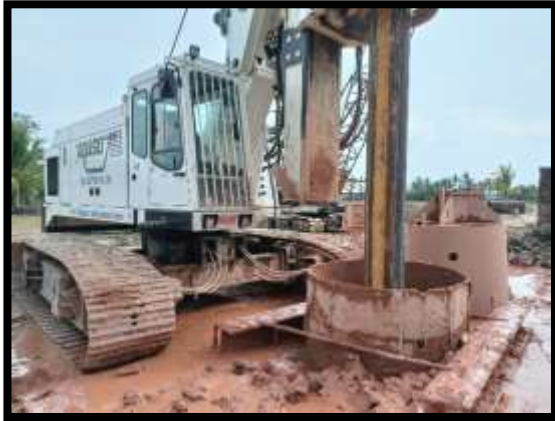
ภาพแสดงงานเจาะเสาเข็ม งานเสาเข็มเจาะ P11/3 และ P11/6
