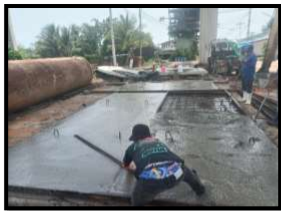
ภาพแสดงงานเทคอนกรีต Skirt P11
