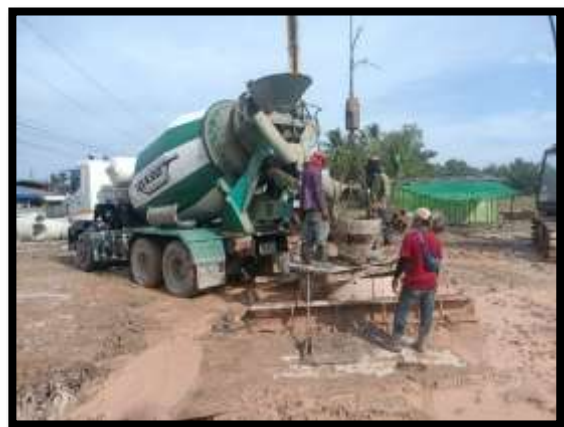
ภาพแสดงงานลงท่อ Timmy พร้อมเทคอนกรีต งานเสาเข็มเจาะ P11/5
