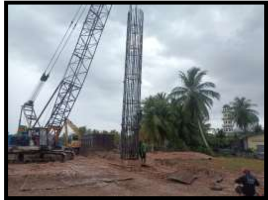
ภาพแสดงงานลงเหล็ก งานเสาเข็มเจาะ P11/5
