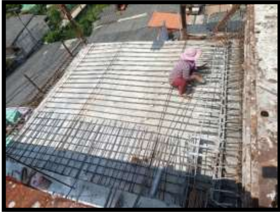
ภาพแสดงงานผูกเหล็กพื้นบน งาน Balance P9 Type I-I
