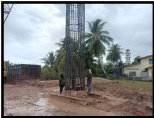
ภาพแสดงงานลงเหล็ก งานเสาเข็มเจาะ P11/4
