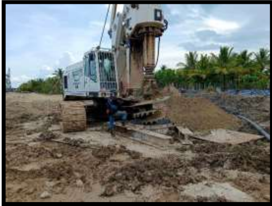
ภาพแสดงงานเจาะเสาเข็ม งานเสาเข็มเจาะ P13/1 และ P13/2
