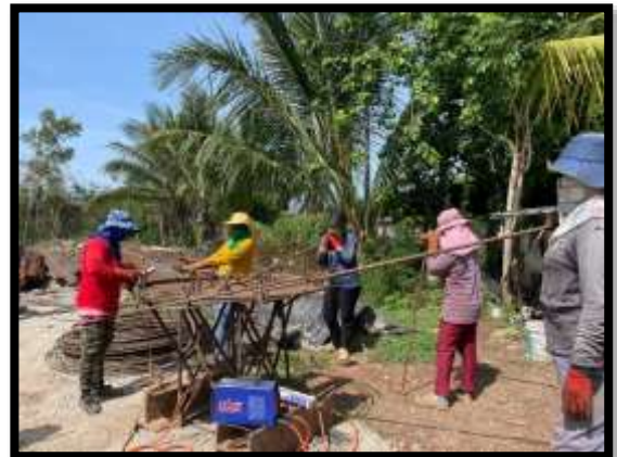
ภาพแสดงงานตัด ดัด และผูกเหล็กเสาเข็ม งานเสาเข็มเจาะ P12/2
