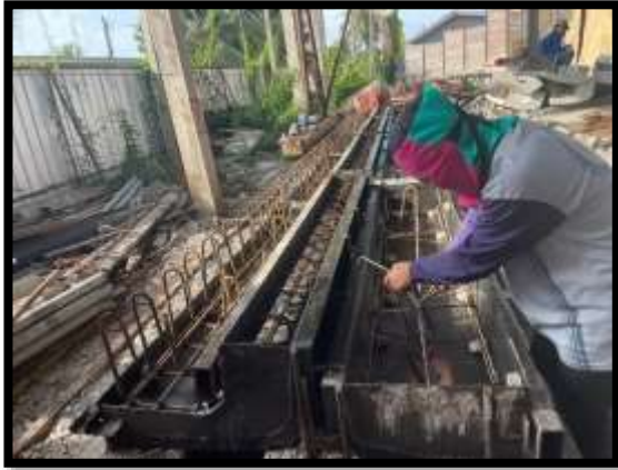
ภาพแสดงงานเข้าแบบ ผูกเหล็ก พร้อมเทคอนกรีต คั่นหินปิดทางเท้า
