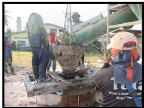
ภาพแสดงงานลงท่อ Timmy พร้อมเทคอนกรีต งานเสาเข็มเจาะ P11/4
