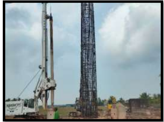
ภาพแสดงงานลงเหล็ก งานเสาเข็มเจาะ P12/1
