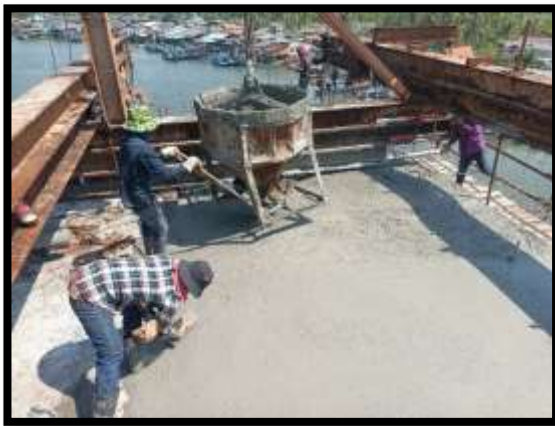
ภาพแสดงงานเทคอนกรีตพื้นบน งาน Balance P9 Type I-I
