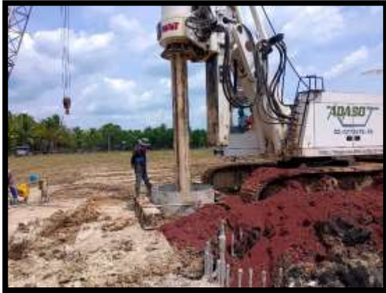
ภาพแสดงงานเจาะเสาเข็ม งานเสาเข็มเจาะ P12/2
