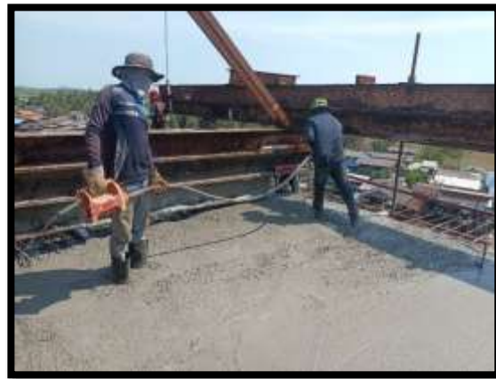
ภาพแสดงงานเทคอนกรีตพื้นบน งาน Balance P9 Type I-I
