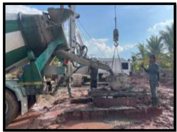
ภาพแสดงงานลงท่อ Timmy พร้อมเทคอนกรีต งานเสาเข็มเจาะ P12/2
