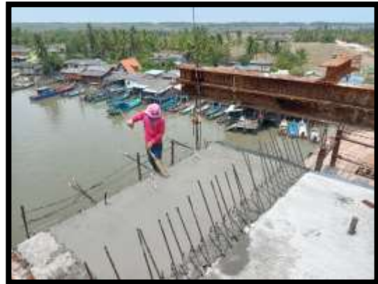
ภาพแสดงงานเทคอนกรีตพื้นบน งาน Balance P9 Type J-J
