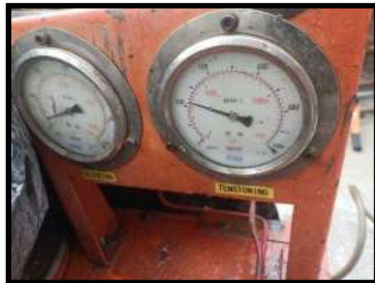
ภาพแสดงงานดึงลวดอัดแรงตามยาว งาน Balance P9 Type J-J
