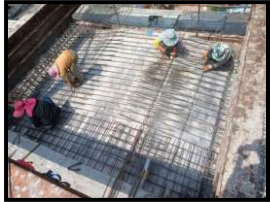
ภาพแสดงงานผูกเหล็กพื้นบน งาน Balance P9 Type I-I
