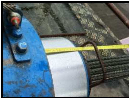
ภาพแสดงงานดึงลวดอัดแรงตามยาว งาน Balance P9 Type J-J
