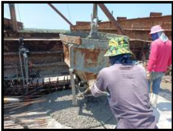
ภาพแสดงงานเทคอนกรีตพื้นล่าง งาน Balance P9 Type J-J
