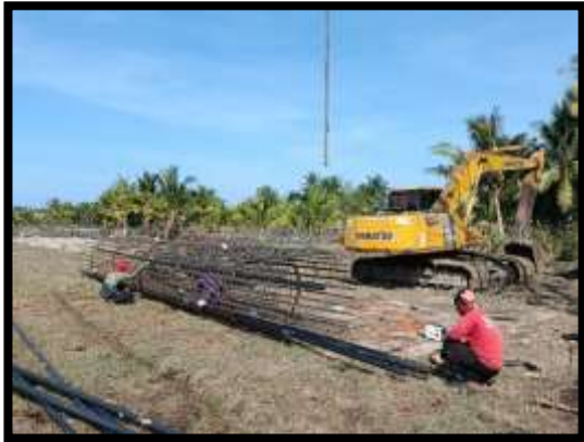
ภาพแสดงงานลงเหล็ก งานเสาเข็มเจาะ P11/5
