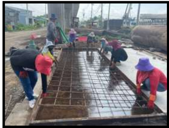
ภาพแสดงงานเข้าแบบ ผูกเหล็ก Skirt P11
