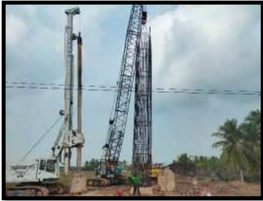
ภาพแสดงงานลงเหล็ก งานเสาเข็มเจาะ P12/1
