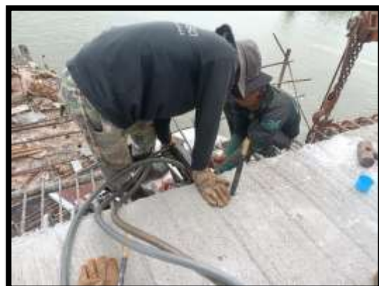
ภาพแสดงงานดึงลวดอัดแรงตามขวาง งาน Balance P9 Type J-J
