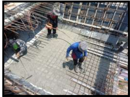
ภาพแสดงงานเทคอนกรีตพื้นล่าง งาน Balance P9 Type J-J
