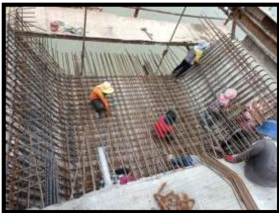
ภาพแสดงงานผูกเหล็กพื้นล่างและผนังข้าง งาน Balance P9 Type J-J
