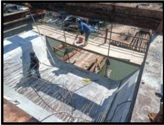
ภาพแสดงงานติดตั้งแบบ งาน Balance P9 Type J-J
