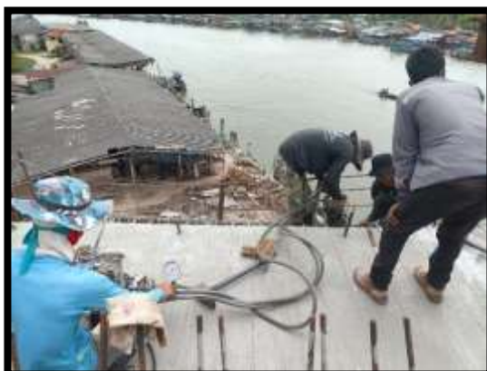
ภาพแสดงงานดึงลวดอัดแรงตามขวาง งาน Balance P9 Type J-J
