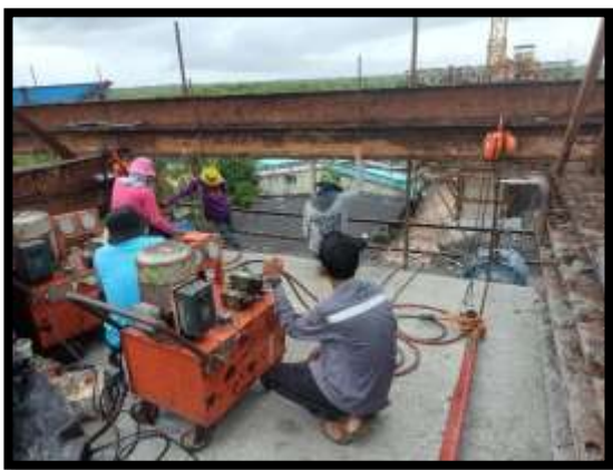
ภาพแสดงงานดึงลวดอัดแรงตามยาว งาน Balance P9 Type I-I
