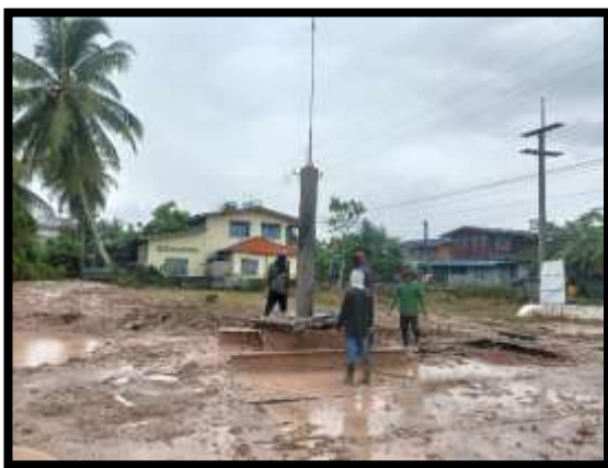
ภาพแสดงงานลงท่อ Timmy พร้อมเทคอนกรีต งานเสาเข็มเจาะ P11/5
