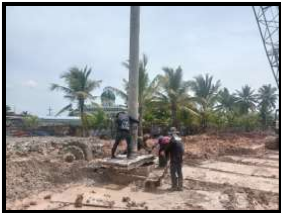
ภาพแสดงงานลงท่อ Timmy พร้อมเทคอนกรีต งานเสาเข็มเจาะ P13/1 และ P13/2
