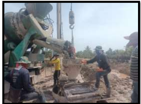
ภาพแสดงงานลงท่อ Timmy พร้อมเทคอนกรีต งานเสาเข็มเจาะ P13/1 และ P13/2
