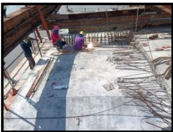
ภาพแสดงงานผูกเหล็กพื้นบน งาน Balance P9 Type J-J
