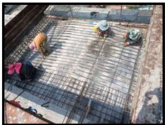
ภาพแสดงงานผูกเหล็กพื้นบน งาน Balance P9 Type J-J
