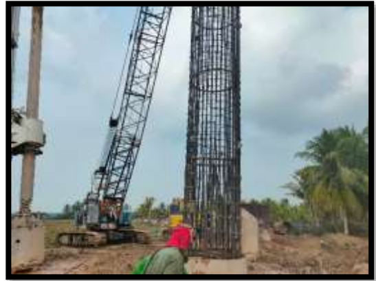
ภาพแสดงงานลงเหล็ก งานเสาเข็มเจาะ P11/3 และ P11/6
