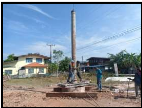
ภาพแสดงงานลงท่อ Timmy พร้อมเทคอนกรีต งานเสาเข็มเจาะ P11/4
