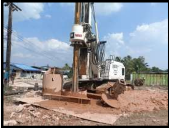
ภาพแสดงงานเจาะเสาเข็ม งานเสาเข็มเจาะ P11/5
