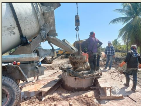
เทคอนกรีตเสาเข็มเจาะ P11/1
