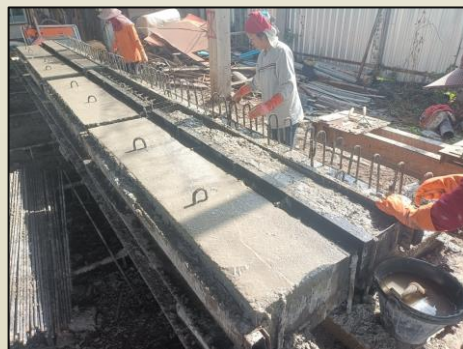
เทคอนกรีตคันทาง
