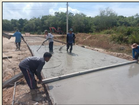
เทคอนกรีตพื้นถนน
