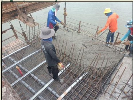
เทคอนกรีตพื้น Balance Type H-H' P9
