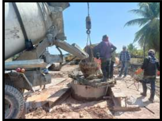
ภาพแสดงงานหล่อ Timmy พร้อมเทคอนกรีตเสาเข็มเจาะ P11/1
