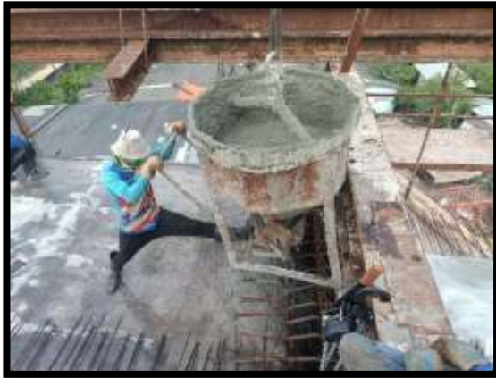
ภาพแสดงงานเทคอนกรีตพื้นล่าง และผนังข้าง งาน Balance P9 Type G-G
