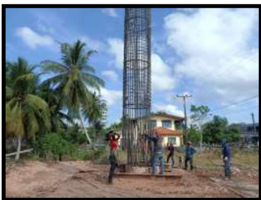
ภาพแสดงงานลงเหล็กเสาเข็ม งานเสาเข็มเจาะ P11/1
