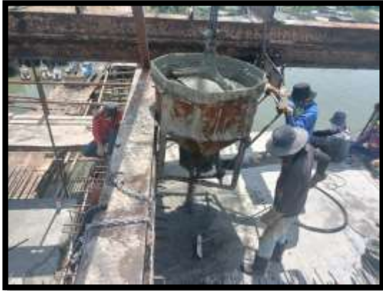
ภาพแสดงงานเทคอนกรีตผนังข้าง งาน Balance P9 Type H-H
