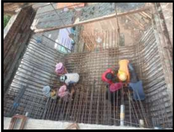
ภาพแสดงงานผูกเหล็กพื้นล่าง งาน Balance P9 Type I-I
