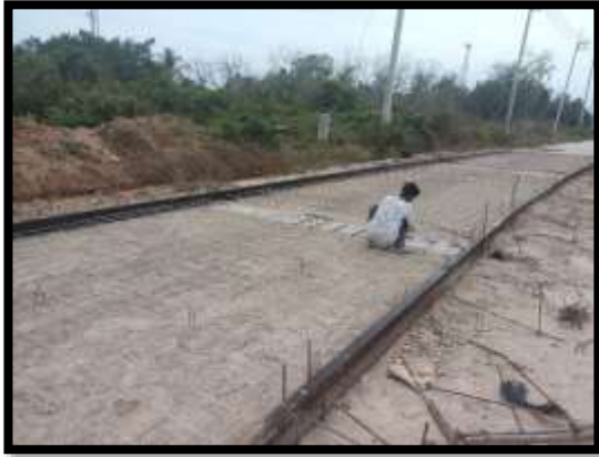
ภาพแสดงงานเข้าแบบ ผูกเหล็ก งานถนน Sta.0+510 ถึง Sta.0+540 LT
