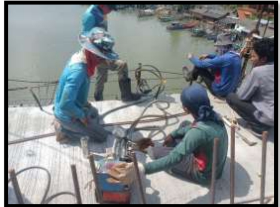
ภาพแสดงงานตั้งลวดอัดแรงตามขวาง งาน Balance P9 Type H-H
