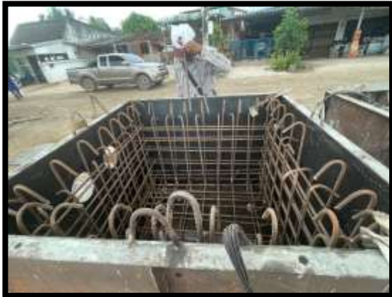
ภาพแสดงงานผูกเหล็ก เข้าแบบ บ่อพัก
