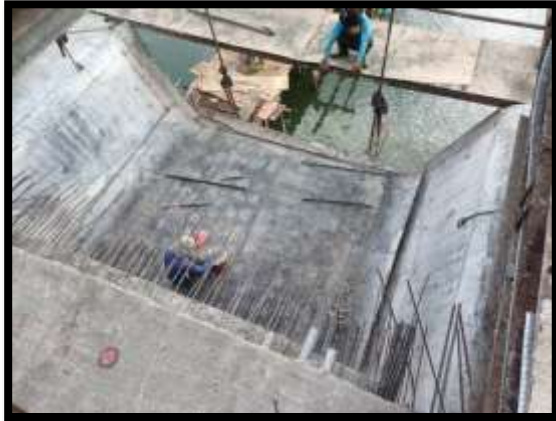
ภาพแสดงงานเตรียมแบบ งาน Balance P9 Type H-H
