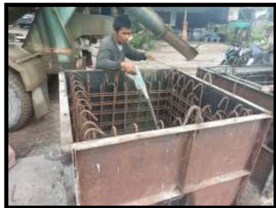
ภาพแสดงงานเทคอนกรีตบ่อพัก
