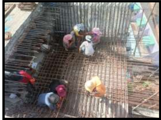
ภาพแสดงงานผูกเหล็กพื้นล่าง งาน Balance P9 Type I-I
