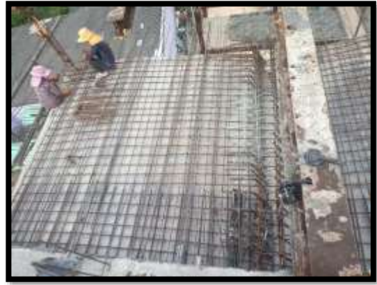
ภาพแสดงงานผูกเหล็กพื้นบน งาน Balance P9 Type H-H
