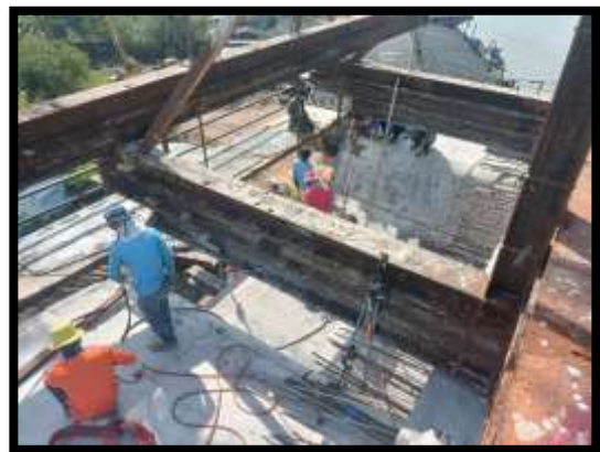
ภาพแสดงงานเตรียมแบบพื้นล่าง งาน Balance P9 Type I-I
