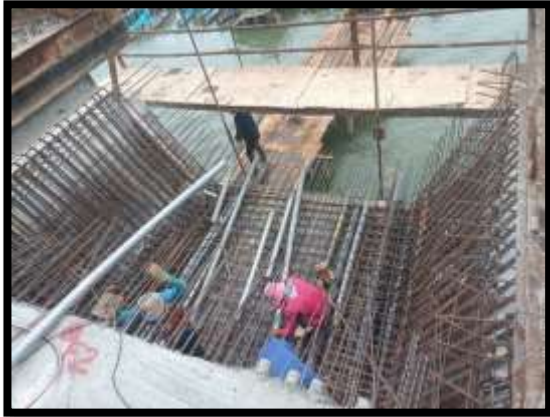
ภาพแสดงงานติดตั้งท่อร้อยลวดอัดแรงตามขวาง พื้นล่าง งาน Balance P9 Type G-G
