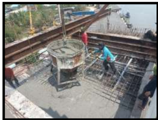
ภาพแสดงงานเทคอนกรีตพื้นบน งาน Balance P9 Type H-H
