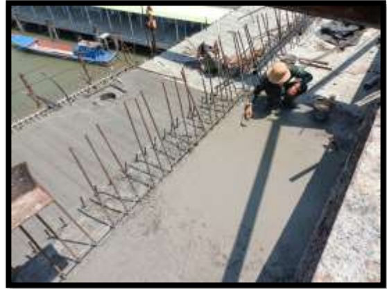
ภาพแสดงงานเทคอนกรีตพื้นบน งาน Balance P9 Type G-G
