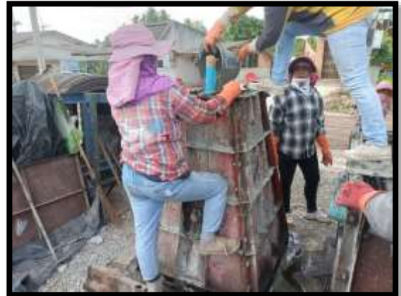
ภาพแสดงงานเทคอนกรีตฐานเสาไฟฟ้า
