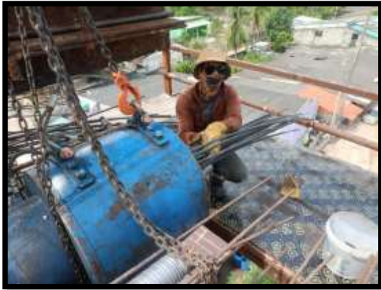
ภาพแสดงงานติดตั้งอัดแรงตามยาว งาน Balance P9 Type G-G
