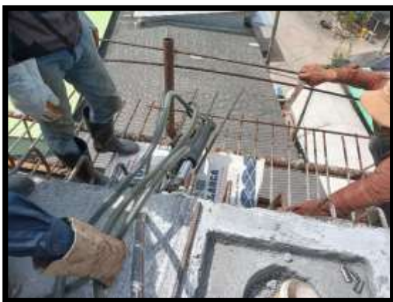
ภาพแสดงงานติดตั้งอัดแรงตามขวาง งาน Balance P9 Type G-G
