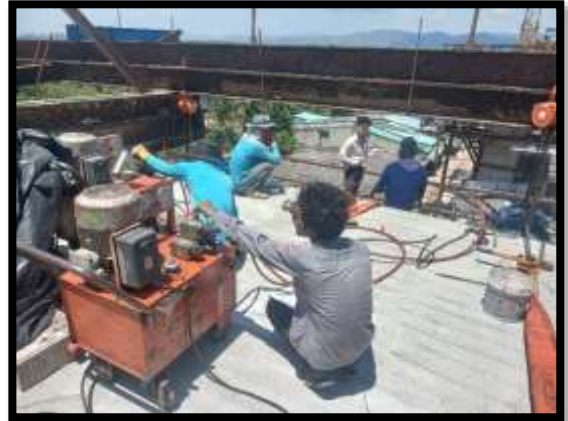
ภาพแสดงงานตั้งลวดอัดแรงตามยาว งาน Balance P9 Type H-H
