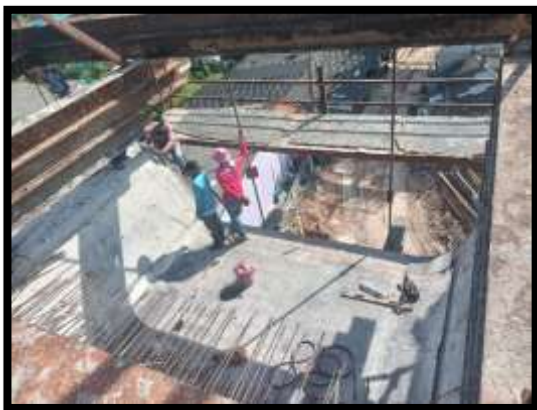
ภาพแสดงงานเตรียมแบบพื้นล่าง งาน Balance P9 Type I-I
