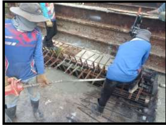
ภาพแสดงงานเทคอนกรีตพื้นล่าง และผนังข้าง งาน Balance P9 Type G-G
