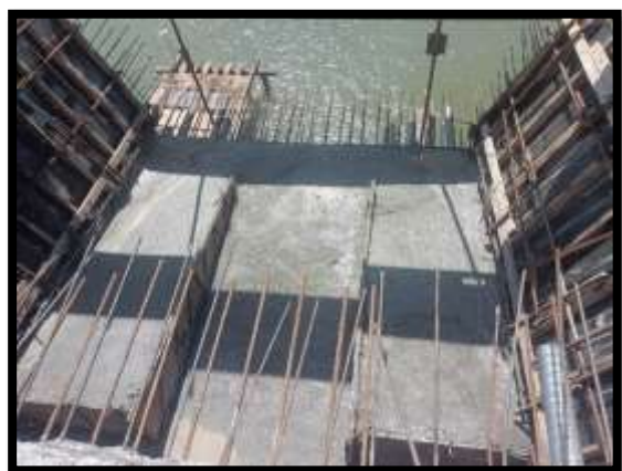
ภาพแสดงงานเทคอนกรีตพื้นล่าง งาน Balance P9 Type H-H
