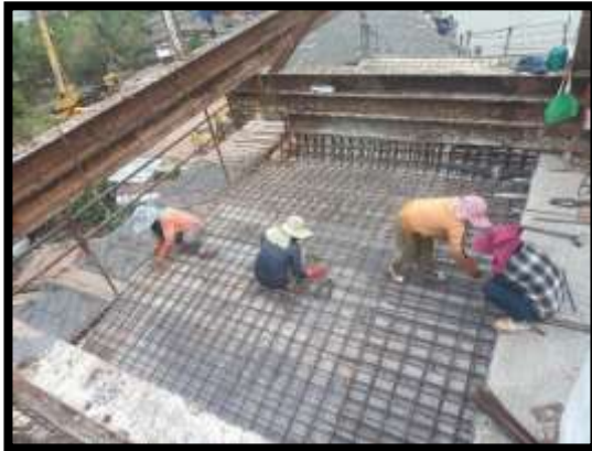
ภาพแสดงงานผูกเหล็กพื้นบน งาน Balance P9 Type H-H
