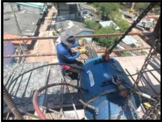
ภาพแสดงงานตั้งลวดอัดแรงตามยาว งาน Balance P9 Type H-H
