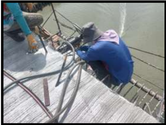
ภาพแสดงงานตั้งลวดอัดแรงตามขวาง งาน Balance P9 Type H-H
