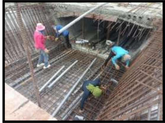
ภาพแสดงงานติดตั้งท่อร้อยลวดอัดแรงตามขวาง พื้นล่าง งาน Balance P9 Type G-G
