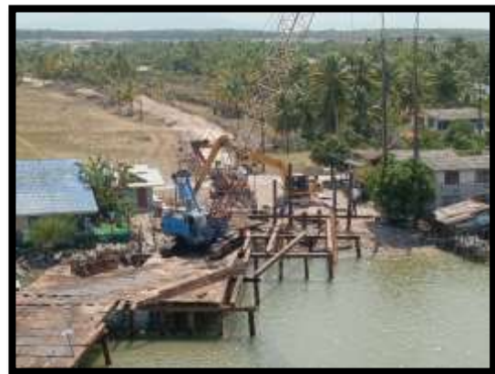
ภาพแสดงงานติดตั้ง Beam พร้อมพื้น งาน Jetty
