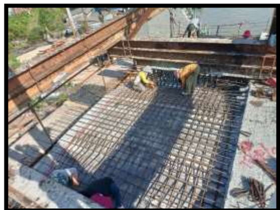
ภาพแสดงงานผูกเหล็กพื้นบน งาน Balance P9 Type G-G
