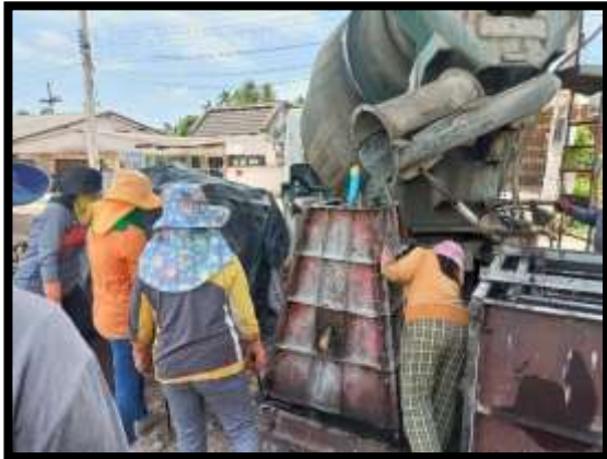
ภาพแสดงงานเทคอนกรีตฐานเสาไฟฟ้า
