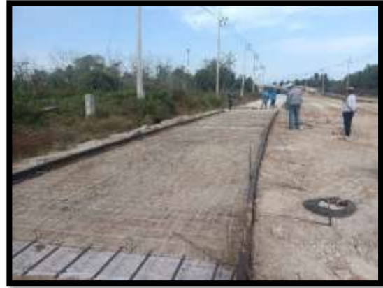
ภาพแสดงงานเข้าแบบ ผูกเหล็ก งานถนน Sta.0+510 ถึง Sta.0+540 LT
