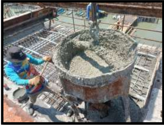
ภาพแสดงงานเทคอนกรีตพื้นบน งาน Balance P9 Type G-G
