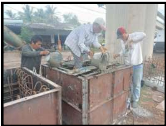
ภาพแสดงงานเทคอนกรีตบ่อพัก
