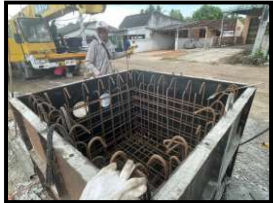
ภาพแสดงงานผูกเหล็ก เข้าแบบ บ่อพัก
