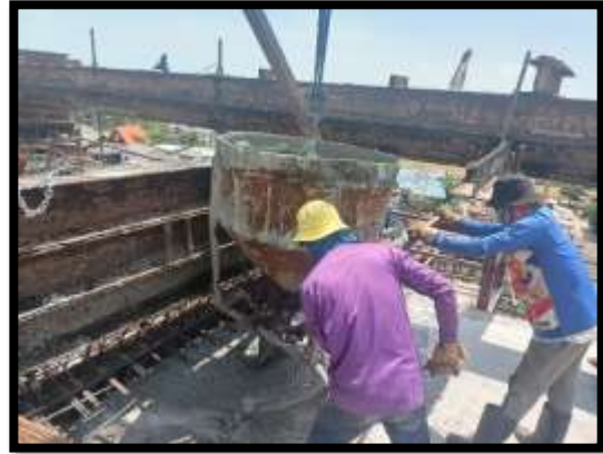
ภาพแสดงงานเทคอนกรีตผนังข้าง งาน Balance P9 Type H-H
