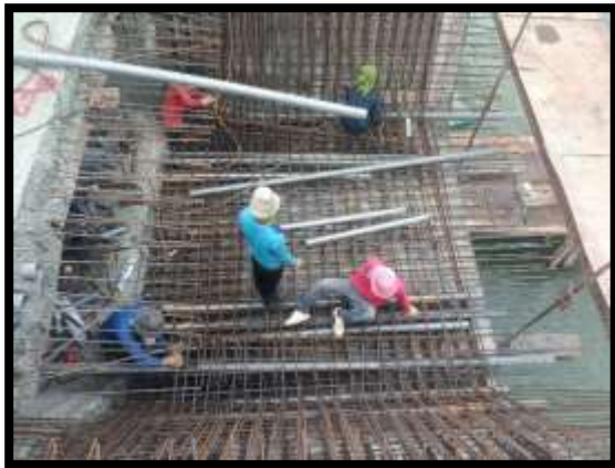
ภาพแสดงงานเตรียมแบบ งาน Balance P9 Type H-H
