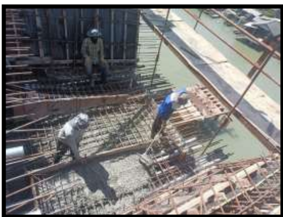
ภาพแสดงงานเทคอนกรีตพื้นล่าง งาน Balance P9 Type H-H
