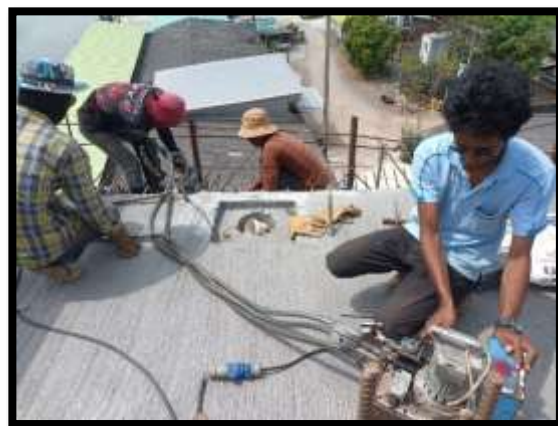
ภาพแสดงงานติดตั้งอัดแรงตามขวาง งาน Balance P9 Type G-G
