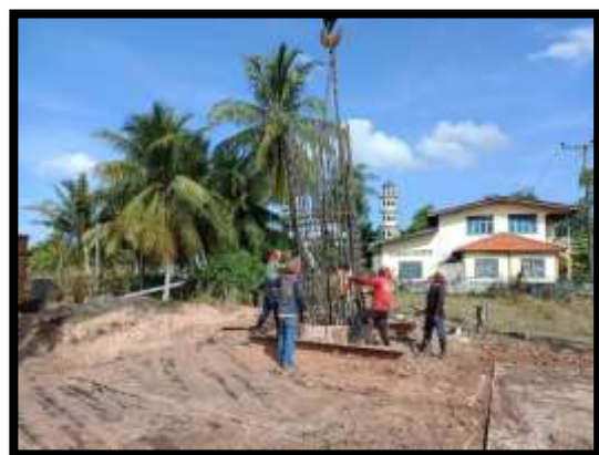
ภาพแสดงงานลงเหล็กเสาเข็ม งานเสาเข็มเจาะ P11/1
