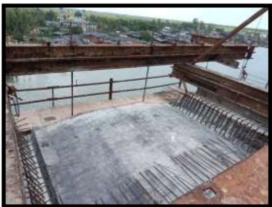
ภาพแสดงงานผูกเหล็กพื้นบน งาน Balance P9 Type G-G
