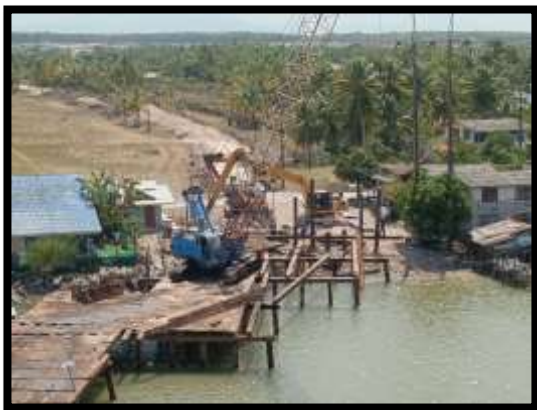
ภาพแสดงงานติดตั้ง Beam พร้อมพื้น งาน Jetty
