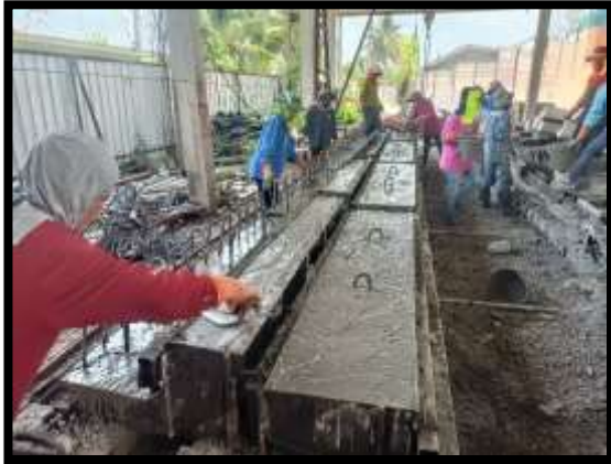
ภาพแสดงงานเทคอนกรีตคันทันหินปิดทางเท้า
