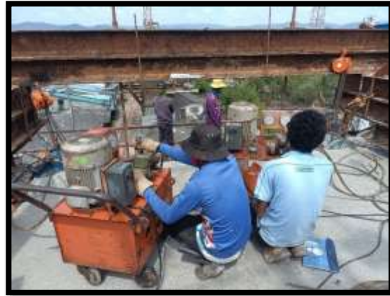
ภาพแสดงงานติดตั้งอัดแรงตามยาว งาน Balance P9 Type G-G
