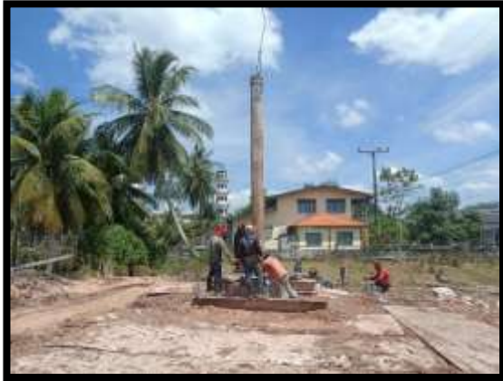
ภาพแสดงงานหล่อ Timmy พร้อมเทคอนกรีตเสาเข็มเจาะ P11/1
