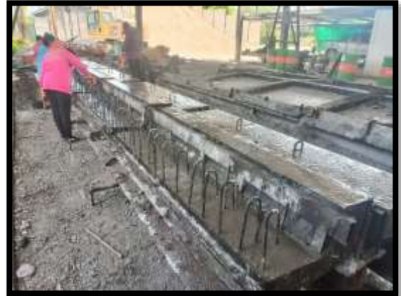
ภาพแสดงงานเทคอนกรีตคันทันหินปิดทางเท้า
