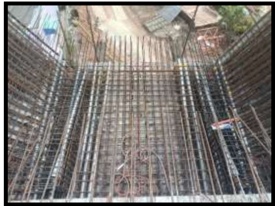
ภาพแสดงงานเตรียมแบบ งาน Balance P9 Type H-H
