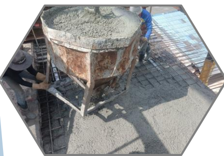
เทคอนกรีต Balance P8 Type A-A'
