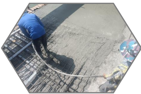
เทคอนกรีต Balance P9 Type F-F'
