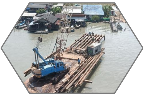
ติดตั้ง H-Beam งาน Jetty
