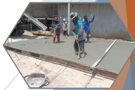
เทคอนกรีตงานถนน
