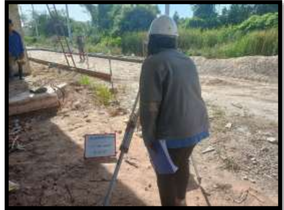
ภาพแสดงงานเข้าแบบข้าง พร้อมตรวจระดับหลังแบบ และระดับชั้นทรายหยาบ งานถนน Sta.0+590 ถึง Sta.0+690 LT
