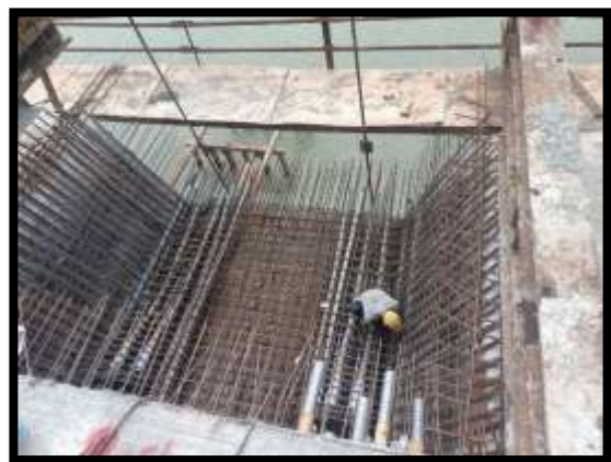
ภาพแสดงงานผูกเหล็กพื้นล่าง และผนังข้าง งาน Balance P9 Type F-F
