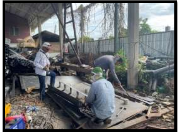
ภาพแสดงงานเตรียมแบบราวสะพานทางเดินเท้า
