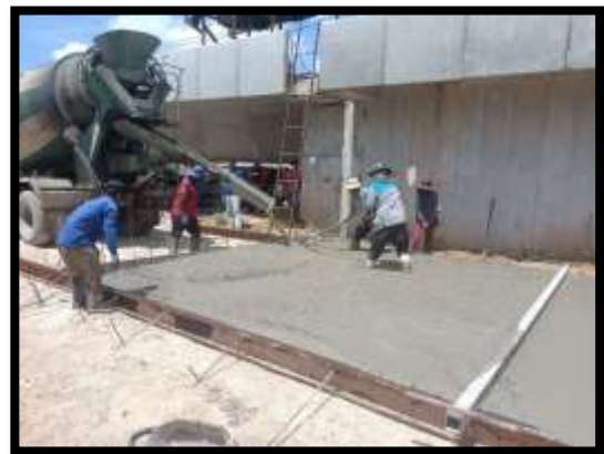
ภาพแสดงงานเทคอนกรีต งานถนน Sta.0+590 ถึง Sta.0+690 LT
