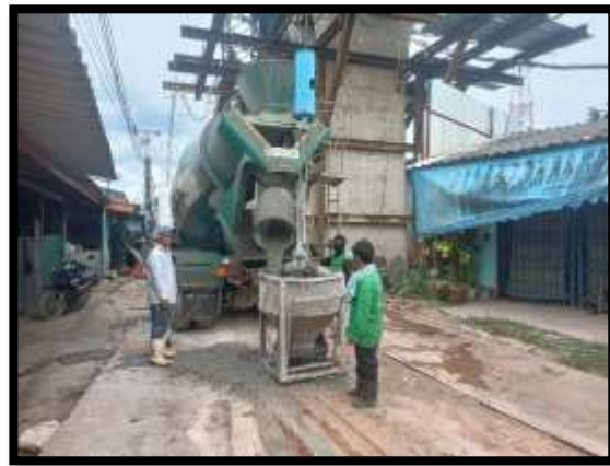
ภาพแสดงงานเทคอนกรีตพื้นล่าง และผนังข้าง งาน Balance P8 Type A-A
