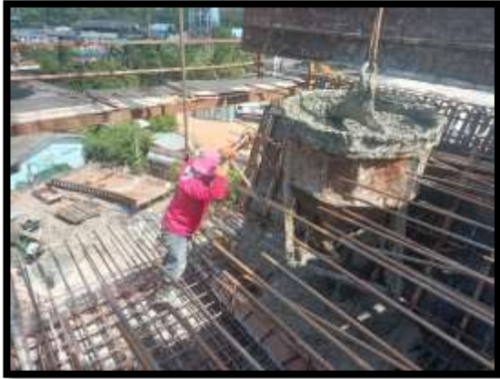
ภาพแสดงงานเทคอนกรีตพื้นล่าง งาน Balance P9 Type F-F
