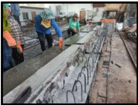
ภาพแสดงงานเทคอนกรีตราวสะพานทางเดินเท้า และคันทันปิดทางเท้า
