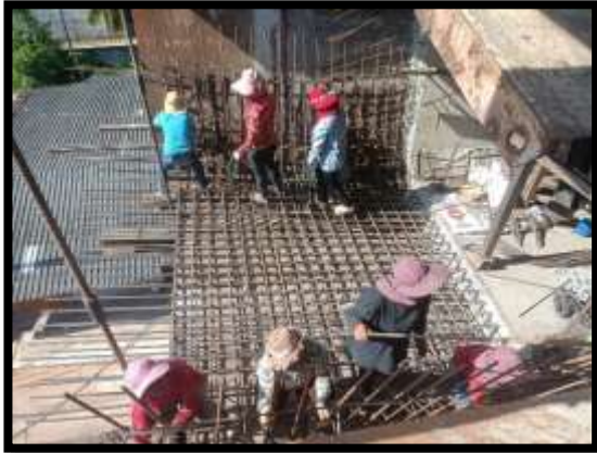
ภาพแสดงงานผูกเหล็กพื้นล่าง และผนังข้าง งาน Balance P8 Type A-A
