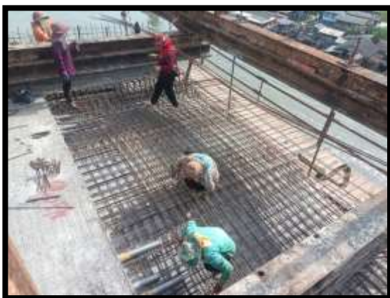
ภาพแสดงงานผูกเหล็กพื้นบน งาน Balance P9 Type F-F
