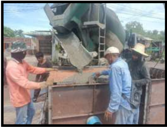
ภาพแสดงงานเทคอนกรีตบ่อพัก Receptor
