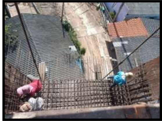
ภาพแสดงงานผูกเหล็กพื้นล่าง และผนังข้าง งาน Balance P8 Type A-A
