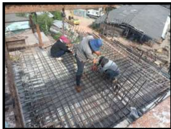
ภาพแสดงงานผูกเหล็กพื้นบน งาน Balance P9 Type F-F
