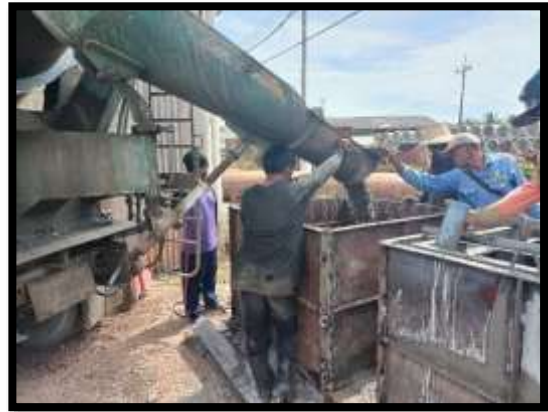
ภาพแสดงงานเทคอนกรีตบ่อพัก Receptor
