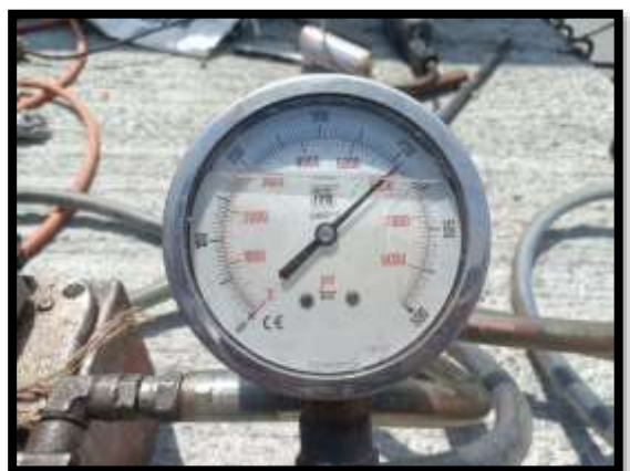
ภาพแสดงงานติดตั้งอัดแรงตามขวาง งาน Balance P9 Type F-F
