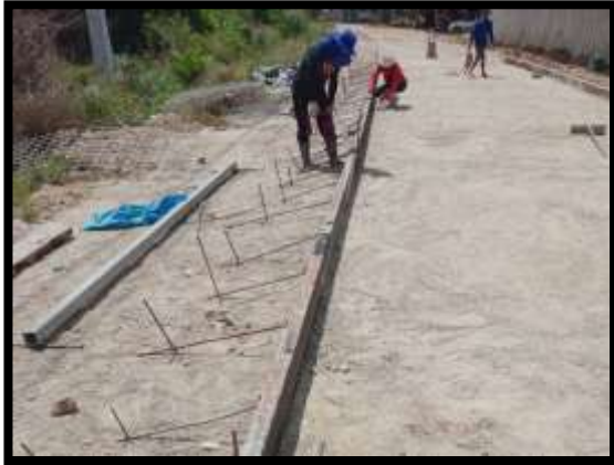
ภาพแสดงงานเข้าแบบข้าง พร้อมตรวจระดับหลังแบบ และระดับชั้นทรายหยาบ งานถนน Sta.0+590 ถึง Sta.0+690 LT
