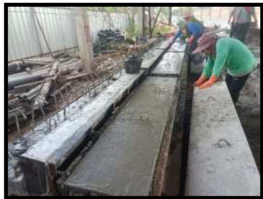
ภาพแสดงงานเทคอนกรีตราวสะพานทางเดินเท้า และคันทันปิดทางเท้า
