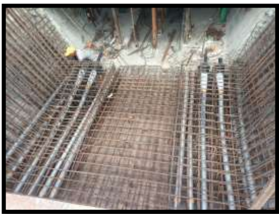
ภาพแสดงงานผูกเหล็กพื้นล่าง และผนังข้าง งาน Balance P9 Type F-F
