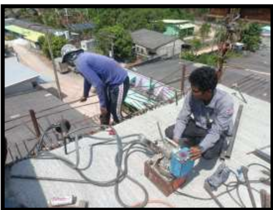
ภาพแสดงงานติดตั้งอัดแรงตามขวาง งาน Balance P9 Type F-F
