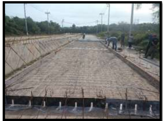
ภาพแสดงงานติดตั้งเหล็กเสริมคอนกรีต งานถนน Sta.0+590 ถึง Sta.0+690 LT
