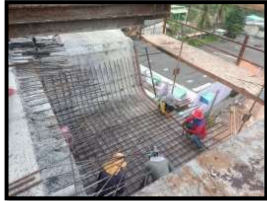
ภาพแสดงงานผูกเหล็กพื้นล่าง และผนัง งาน Balance P9 Type G-G
