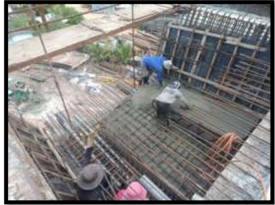
ภาพแสดงงานเทคอนกรีตพื้นล่าง งาน Balance P9 Type F-F
