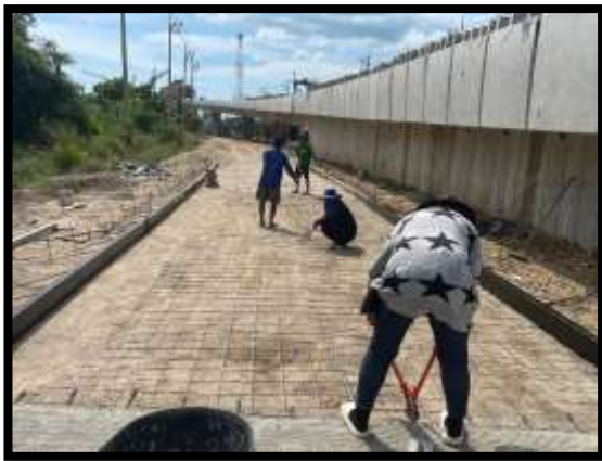
ภาพแสดงงานติดตั้งเหล็กเสริมคอนกรีต งานถนน Sta.0+590 ถึง Sta.0+690 LT
