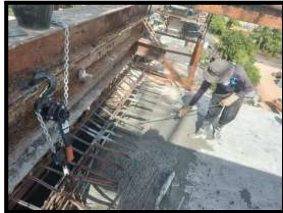
ภาพแสดงงานเทคอนกรีตผนังข้าง งาน Balance P9 Type F-F
