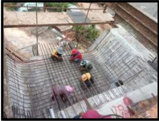
ภาพแสดงงานผูกเหล็กพื้นล่าง และผนัง งาน Balance P9 Type G-G
