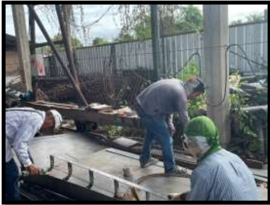
ภาพแสดงงานเตรียมแบบราวสะพานทางเดินเท้า
