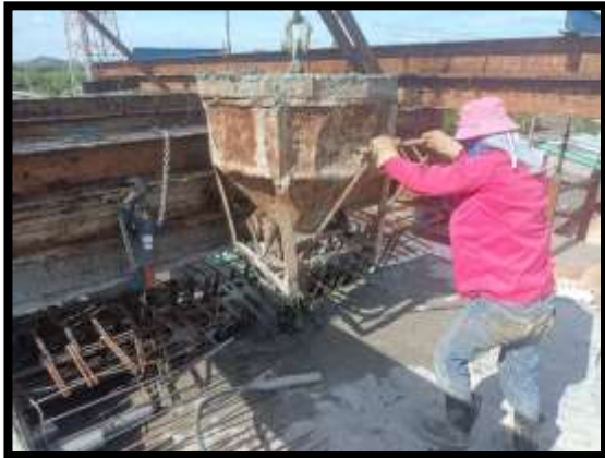
ภาพแสดงงานเทคอนกรีตผนังข้าง งาน Balance P9 Type F-F
