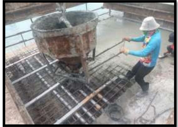
ภาพแสดงงานเทคอนกรีตพื้นบน งาน Balance P9 Type F-F
