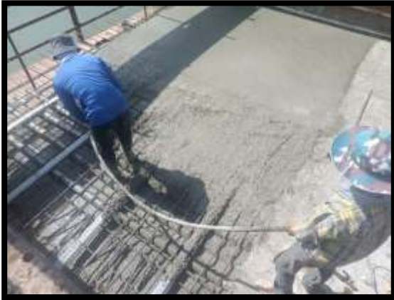
ภาพแสดงงานเทคอนกรีตพื้นบน งาน Balance P9 Type F-F
