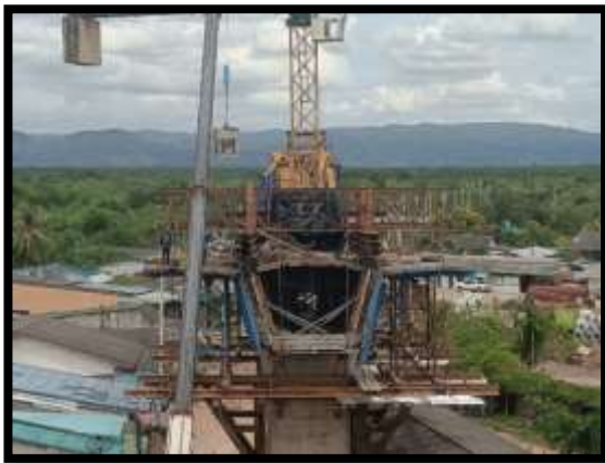
ภาพแสดงงานเทคอนกรีตพื้นล่าง และผนังข้าง งาน Balance P8 Type A-A
