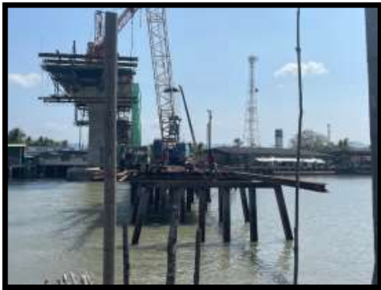
ภาพแสดงงานติดตั้ง H-Beam งาน Jetty
