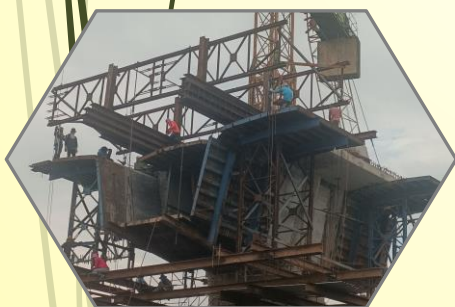
ติดตั้ง Form Traveler Balance P8 Type A-A'
