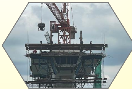
งานเทคอนกรีตพื้นบน Balance P9 Type E-E'
