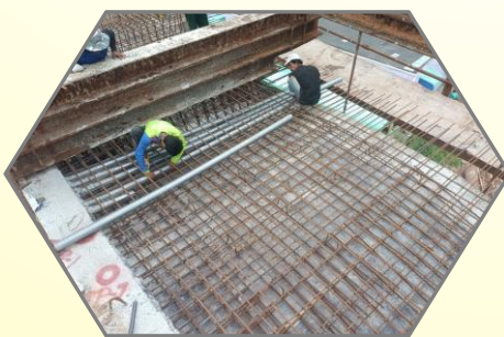
ติดตั้งท่อลวดอัดแรงพื้นบน Balance P9 Type E-E'
