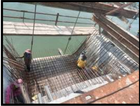
ภาพแสดงงานผูกเหล็กผนังข้าง Balance P9 Type E-E
