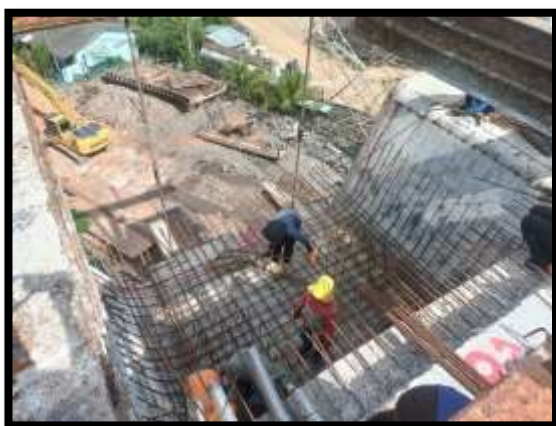
ภาพแสดงงานผูกเหล็กพื้นล่าง Balance P9 Type E-E
