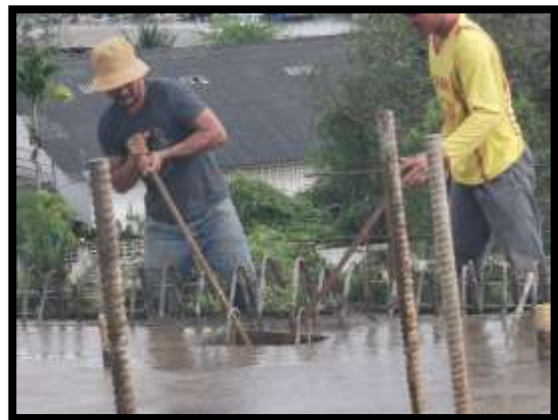
ภาพแสดงงานเทคอนกรีตพื้นบน Pier Head Segment P8
