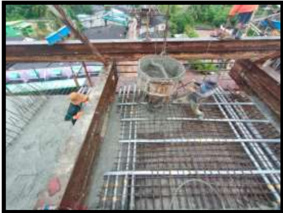
ภาพแสดงงานเทคอนกรีตพื้นบน งาน Balance P9 Type E-E
