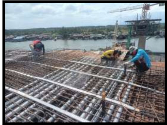
ภาพแสดงงานติดตั้งท่อลวดอัดแรง ตามขวาง และตามยาว Pier Head Segment P8
