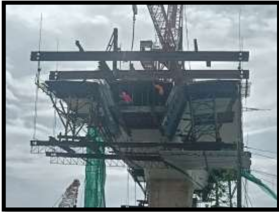
ภาพแสดงงานเข้าแบบพื้นบน งาน Balance P9 Type E-E
