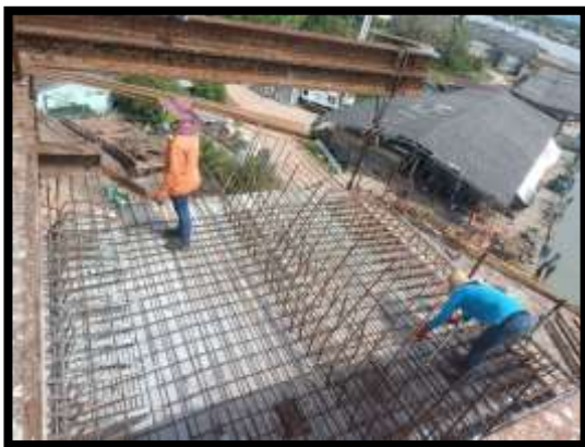
ภาพแสดงงานผูกเหล็กพื้นบน งาน Balance P9 Type E-E
