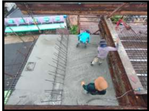
ภาพแสดงงานเทคอนกรีตพื้นบน งาน Balance P9 Type E-E
