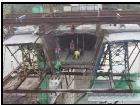
ภาพแสดงงานเทคอนกรีตพื้นล่าง งาน Balance P9 Type E-E
