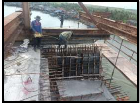
ภาพแสดงงานเทคอนกรีตผนังข้าง งาน Balance P9 Type E-E
