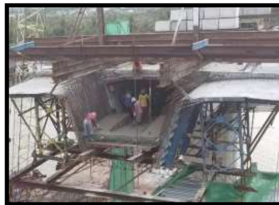
ภาพแสดงงานเทคอนกรีตพื้นล่าง งาน Balance P9 Type E-E
