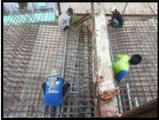
ภาพแสดงงานติดตั้งท่อลอดอัดแรง ตามยาว และ ตามขวาง งาน Balance P9 Type E-E
