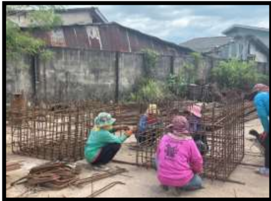
ภาพแสดงงานผูกเหล็กบ่อพัก Receptor
