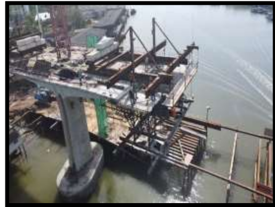
ภาพแสดงงานติดตั้งแบบ Balance P9 Type E-E
