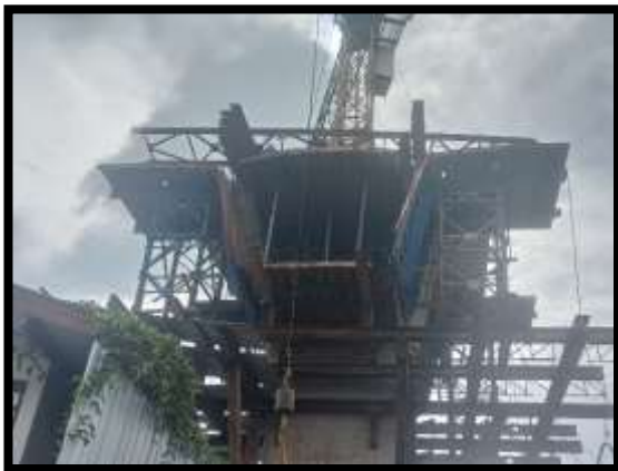
ภาพแสดงงานติดตั้ง Form Traveler งาน Balance P8 Type A-A
