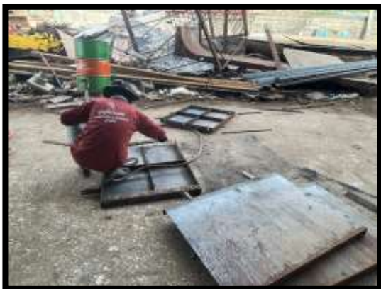
ภาพแสดงงานเตรียมแบบ่อพัก Receptor
