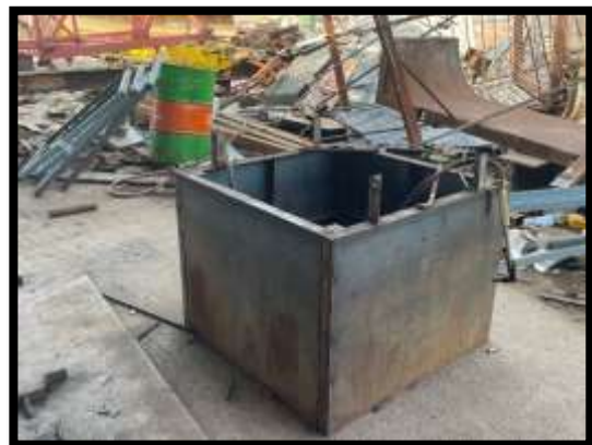
ภาพแสดงงานเตรียมแบบ่อพัก Receptor
