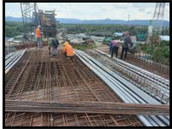
ภาพแสดงงานผูกเหล็กพื้นบน Pier Head Segment P8
