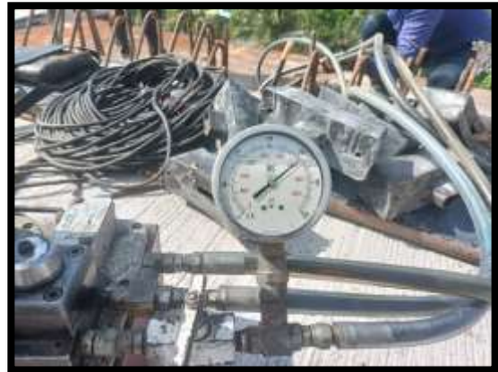
ภาพแสดงงานติดตั้งลวดอัดแรง ตามขวาง Pier Head Segment P8
