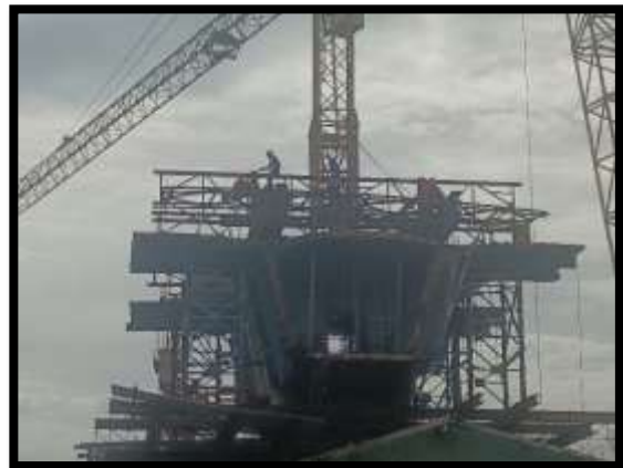
ภาพแสดงงานติดตั้ง Form Traveler งาน Balance P8 Type A-A
