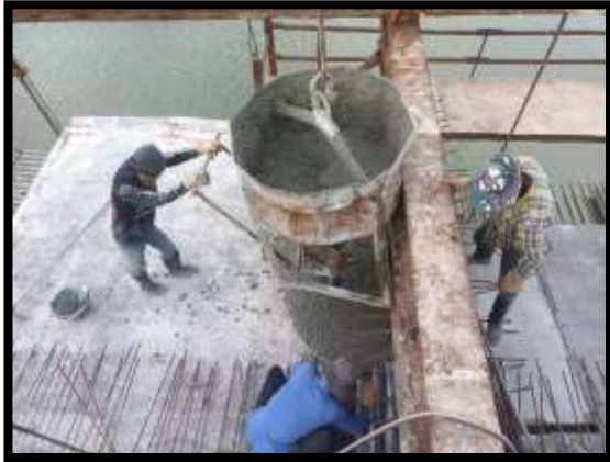
ภาพแสดงงานเทคอนกรีตผนังข้าง งาน Balance P9 Type E-E
