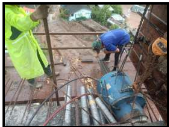
ภาพแสดงงานติดตั้งลวดอัดแรงตามยาว งาน Balance P9 Type D-D
