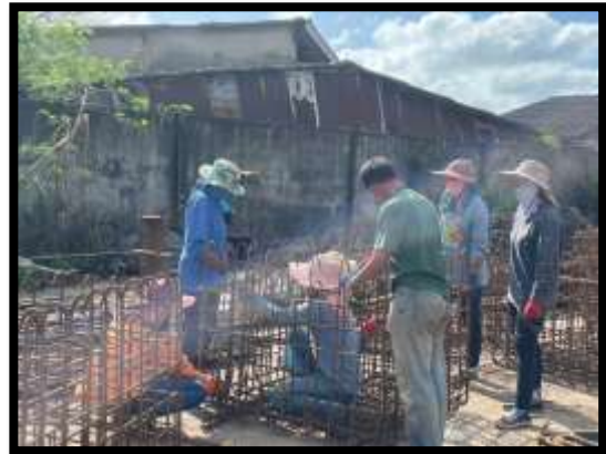
ภาพแสดงงานผูกเหล็กบ่อพัก Receptor
