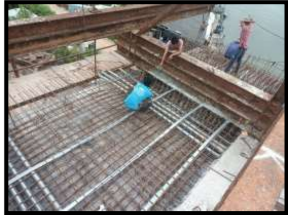
ภาพแสดงงานติดตั้งท่อลอดอัดแรง ตามยาว และ ตามขวาง งาน Balance P9 Type E-E
