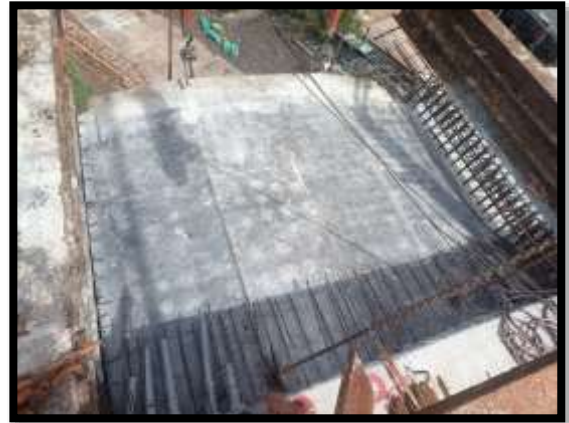
ภาพแสดงงานเข้าแบบพื้นบน งาน Balance P9 Type E-E
