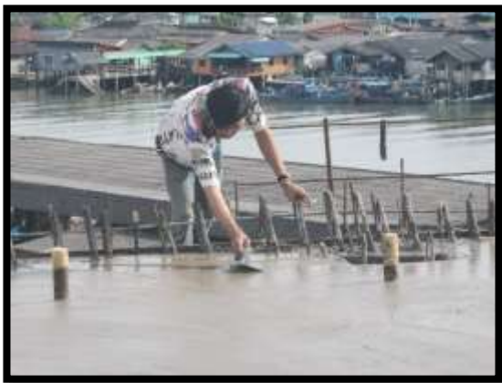
ภาพแสดงงานเทคอนกรีตพื้นบน Pier Head Segment P8
