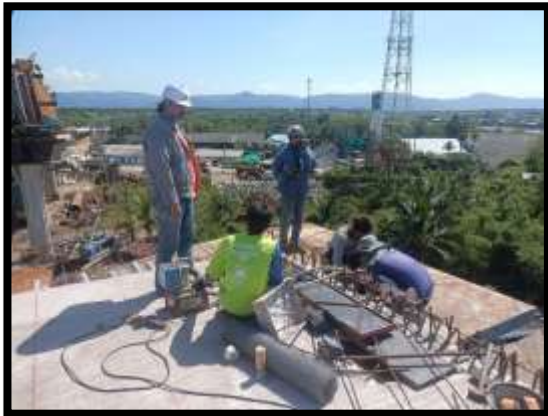
ภาพแสดงงานติดตั้งลวดอัดแรง ตามขวาง Pier Head Segment P8
