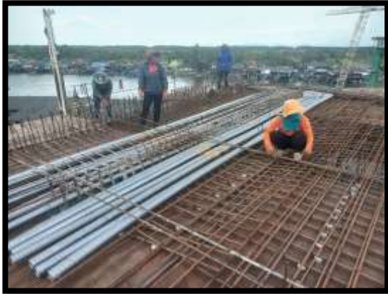
ภาพแสดงงานผูกเหล็กพื้นบน Pier Head Segment P8
