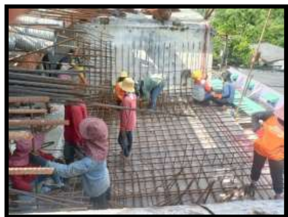
ภาพแสดงงานผูกเหล็กพื้นล่าง Balance P9 Type E-E
