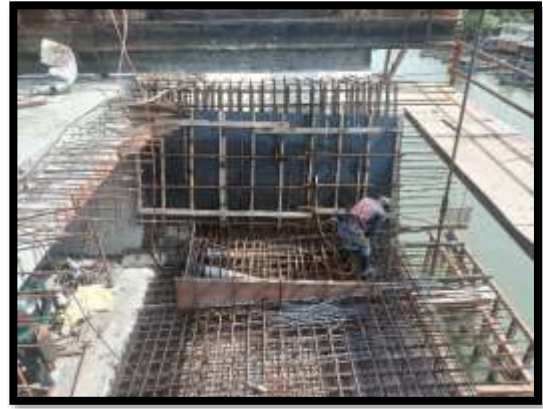
ภาพแสดงงานเข้าแบบผนัง งาน Balance P9 Type E-E
