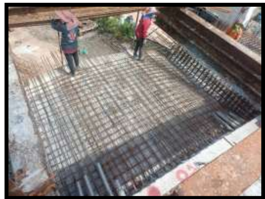
ภาพแสดงงานผูกเหล็กพื้นบน งาน Balance P9 Type E-E
