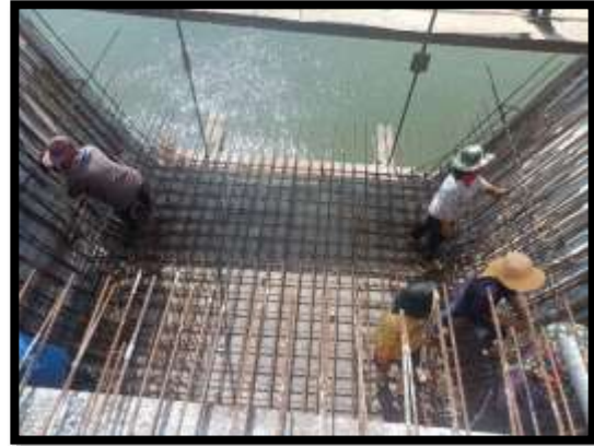
ภาพแสดงงานผูกเหล็กผนังข้าง Balance P9 Type E-E
