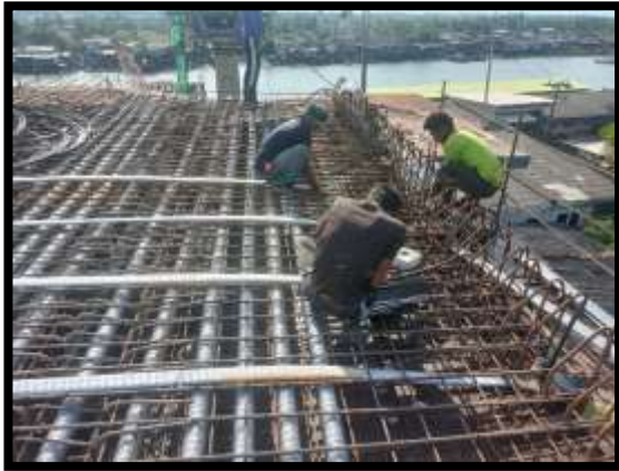
ภาพแสดงงานติดตั้งท่อลวดอัดแรง ตามขวาง และตามยาว Pier Head Segment P8
