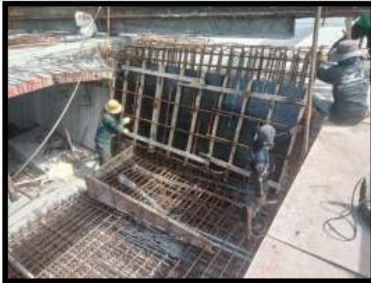
ภาพแสดงงานเข้าแบบผนัง งาน Balance P9 Type E-E
