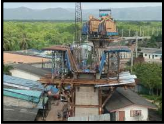
ภาพแสดงงานเข้าแบบ Pier Head Segment P8
