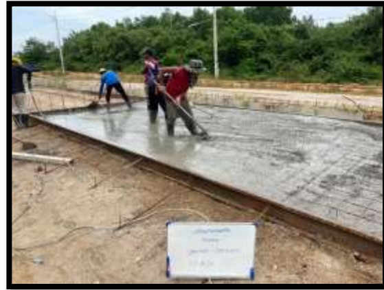
ภาพแสดงงานเทคอนกรีต งานถนน จาก Sta.0+540 ถึง Sta.0+590 LT
