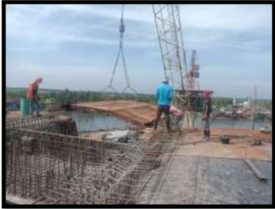
ภาพแสดงงานเตรียมแบบพื้นบน Pier Head Segment P8
