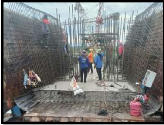
ภาพแสดงงานผูกเหล็กผนัง Pier Head Segment P8
