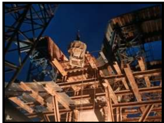
ภาพแสดงงานเทคอนกรีตพื้นล่าง Pier Head Segment P8
