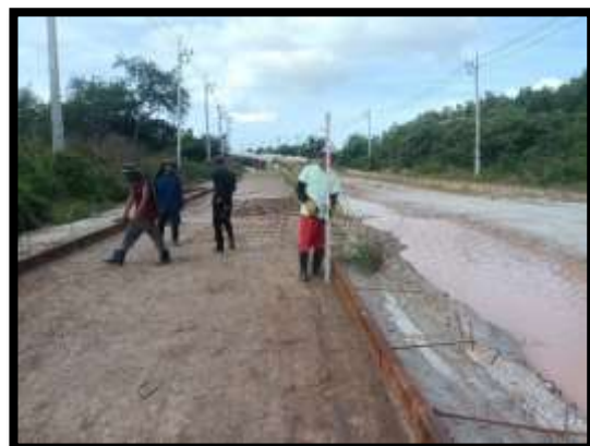
ภาพแสดงงานตรวจสอบระดับหลังแบบ และระดับชั้นทรายหยาบ งานถนน จาก Sta.0+540 ถึง Sta.0+610 LT
