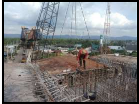
ภาพแสดงงานเตรียมแบบพื้นบน Pier Head Segment P8
