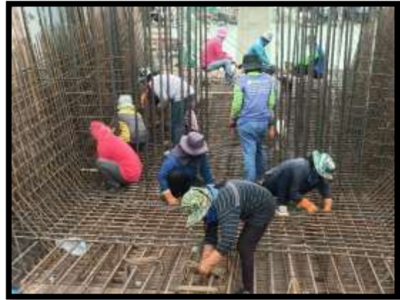
ภาพแสดงงานผูกเหล็กพื้นล่าง Pier Head Segment P8
