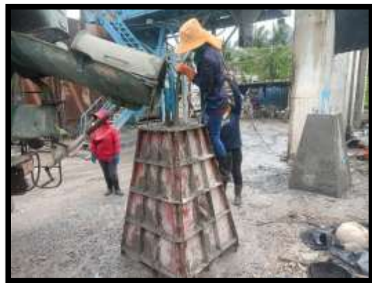
ภาพแสดงงานเทคอนกรีตฐานเสาไฟฟ้าคอนกรีต
