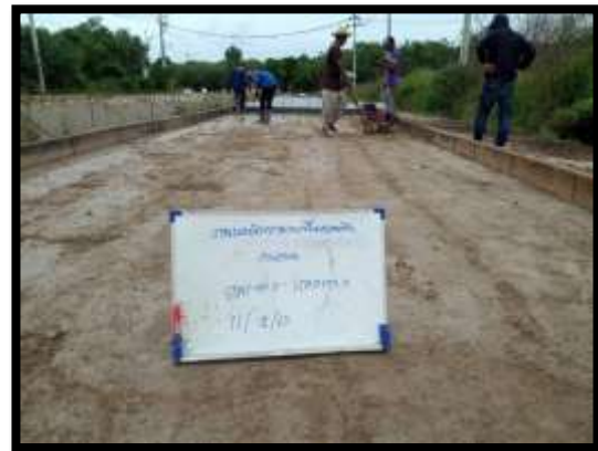
ภาพแสดงงานบดอัดชั้นทรายหยาบ งานถนน จาก Sta.0+540 ถึง Sta.0+610 LT
