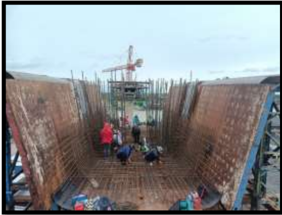
ภาพแสดงงานผูกเหล็กพื้นล่าง Pier Head Segment P8
