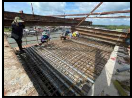
ภาพแสดงงานผูกเหล็กพื้นบน งาน Balance P9 Type D-D
