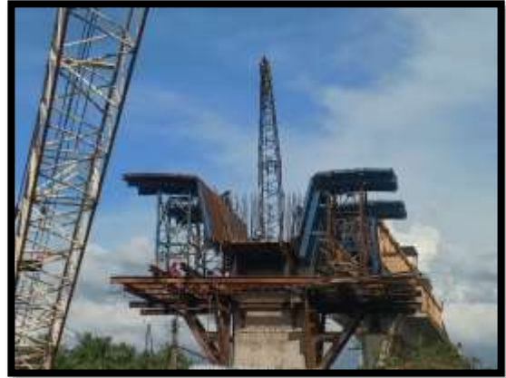
ภาพแสดงงานเข้าแบบ Pier Head Segment P8
