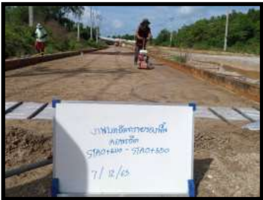
ภาพแสดงงานบดอัดชั้นทรายหยาบ งานถนน จาก Sta.0+540 ถึง Sta.0+610 LT
