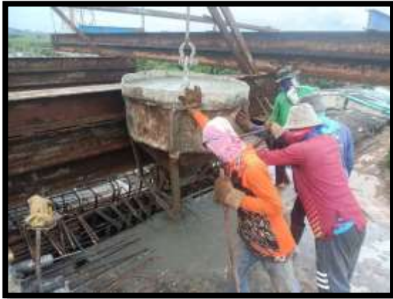
ภาพแสดงงานเทคอนกรีตผนัง งาน Balance P9 Type D-D
