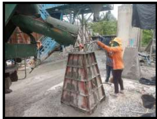
ภาพแสดงงานเทคอนกรีตฐานเสาไฟฟ้าคอนกรีต
