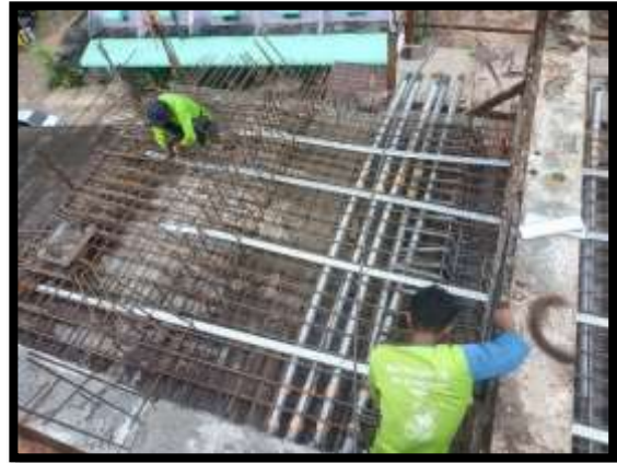
ภาพแสดงงานติดตั้งท่อลวดอัดแรงตามขวาง งาน Balance P9 Type D-D
