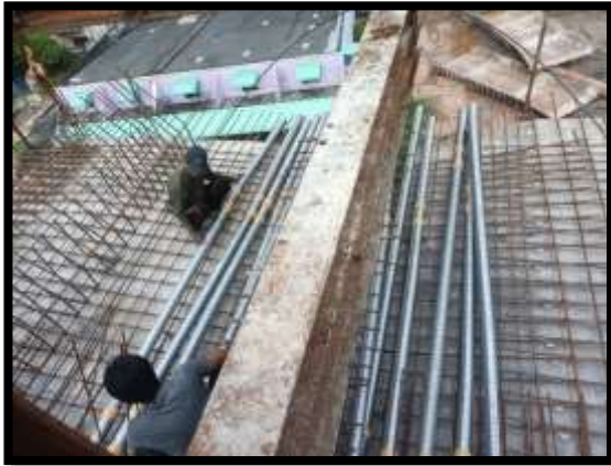
ภาพแสดงงานติดตั้งท่อลวดอัดแรงตามขวาง งาน Balance P9 Type D-D
