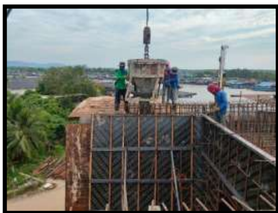
ภาพแสดงงานเทคอนกรีตผนัง Pier Head Segment P8
