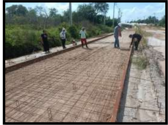
ภาพแสดงงานผูกเหล็ก งานถนน จาก Sta.0+540 ถึง Sta.0+610 LT
