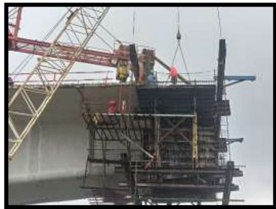
ภาพแสดงงานเตรียมแบบพื้นบน งาน Balance P9 Type D-D
