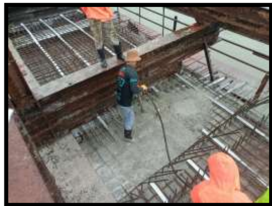
ภาพแสดงงานเทคอนกรีตพื้นบน งาน Balance P9 Type D-D
