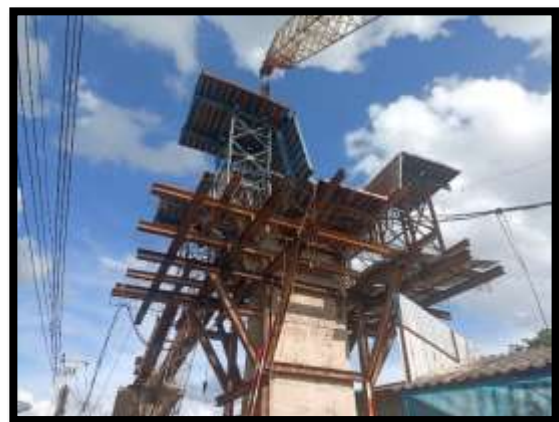
ภาพแสดงงานติดตั้งแบบ Pier Head Segment P8
