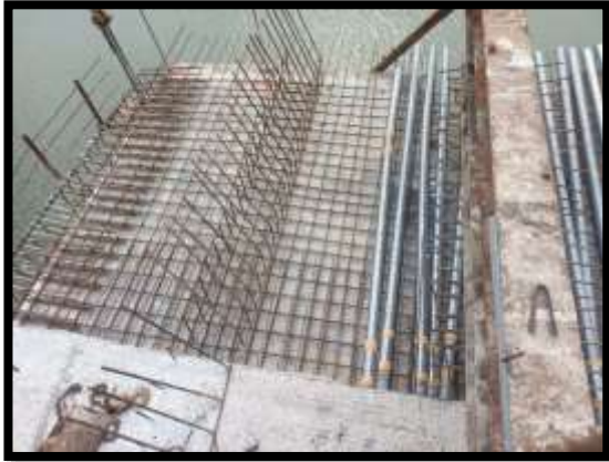
ภาพแสดงงานผูกเหล็กพื้นบน งาน Balance P9 Type D-D
