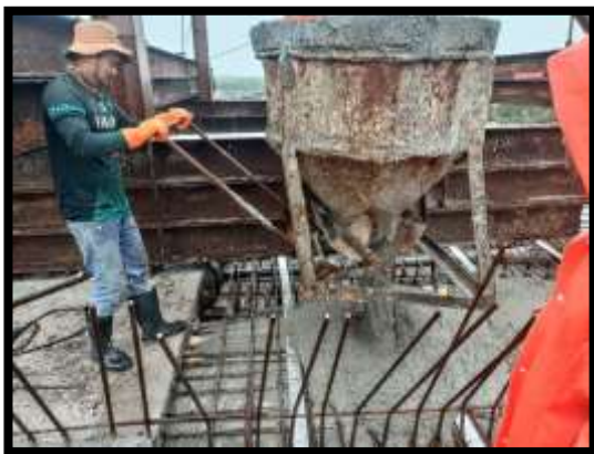
ภาพแสดงงานเทคอนกรีตพื้นบน งาน Balance P9 Type D-D
