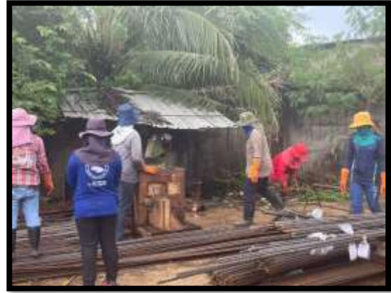
ภาพแสดงงานตัด ตัด เหล็กงาน Pier Head Segment P8
