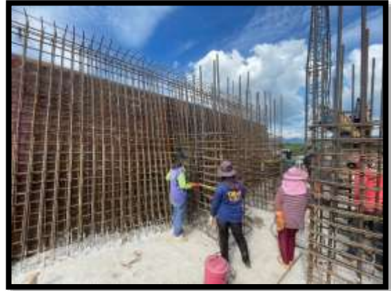
ภาพแสดงงานผูกเหล็กผนัง Pier Head Segment P8
