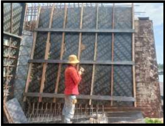
ภาพแสดงงานผูกเหล็กผนัง Pier Head Segment P8
