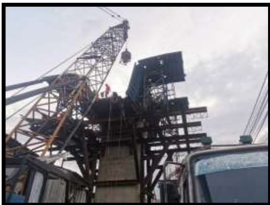
ภาพแสดงงานเทคอนกรีตพื้นล่าง Pier Head Segment P8
