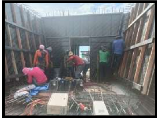
ภาพแสดงงานผูกเหล็กผนัง Pier Head Segment P8
