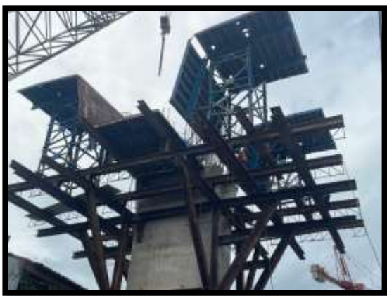
ภาพแสดงงานติดตั้งแบบ Pier Head Segment P8
