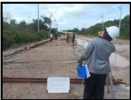
ภาพแสดงงานตรวจสอบระดับหลังแบบ และระดับชั้นทรายหยาบ งานถนน จาก Sta.0+540 ถึง Sta.0+610 LT
