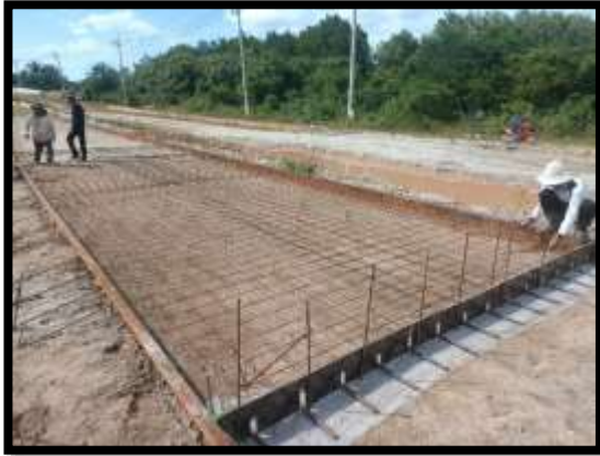
ภาพแสดงงานผูกเหล็ก งานถนน จาก Sta.0+540 ถึง Sta.0+610 LT
