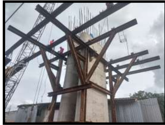
ภาพแสดงงานเตรียมงานแบบ Pier Head Segment P8
