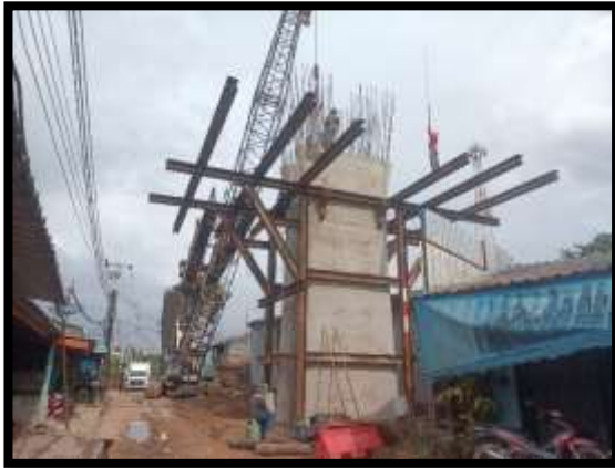
ภาพแสดงงานเตรียมงานแบบ Pier Head Segment P8
