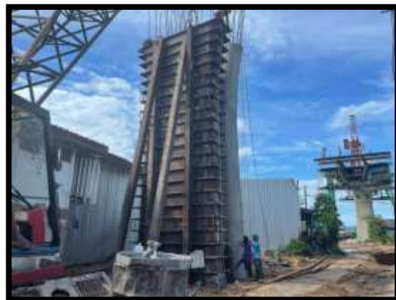
ภาพแสดงงานเข้าแบบโครงสร้างเสาตอม่อ P8 ต้นที่ 2
