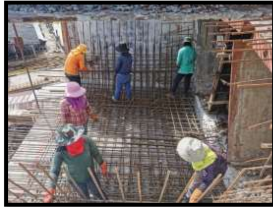
ภาพแสดงงานผูกเหล็กพื้นล่าง และผนัง Balance P9 Type D-D
