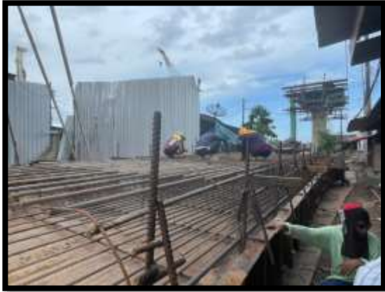
ภาพแสดงงานผูกเหล็กโครงสร้างเสาตอม่อ P8 ต้นที่ 2
