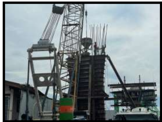
ภาพแสดงงานเทคอนกรีตโครงสร้างเสาตอม่อ P8 ต้นที่ 1
