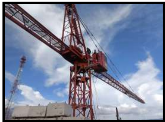
ภาพแสดงงานติดตั้ง Tower Crane บน Balance P9
