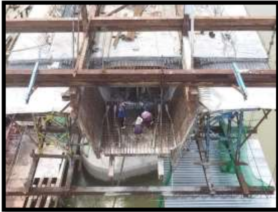
ภาพแสดงงานผูกเหล็กพื้นล่าง และผนัง Balance P9 Type D-D
