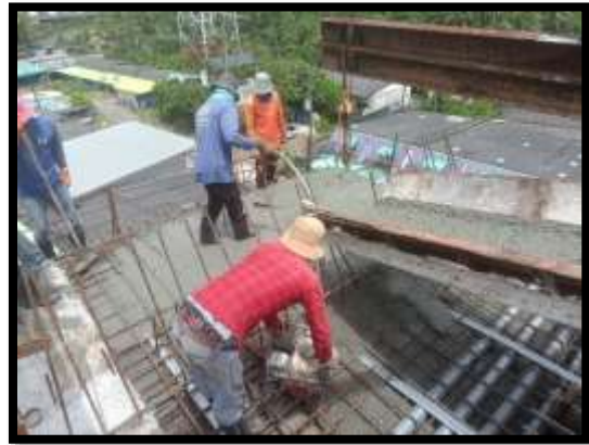
ภาพแสดงงานเทคอนกรีตโครงสร้างเสาตอม่อ P8 ต้นที่ 2
