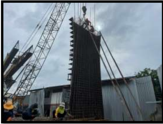
ภาพแสดงงานเข้าแบบโครงสร้างเสาตอม่อ P8 ต้นที่ 1
