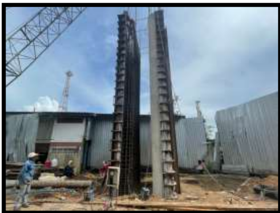
ภาพแสดงงานเข้าแบบโครงสร้างเสาตอม่อ P8 ต้นที่ 2
