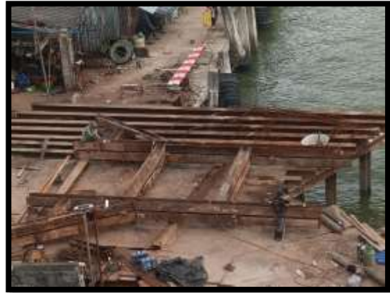
ภาพแสดงงานเตรียมแบบ Pier Head P8
