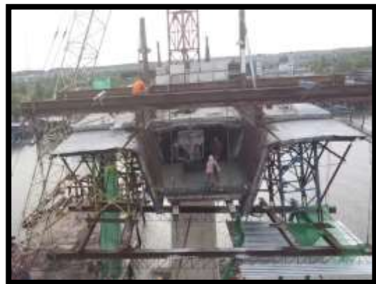
ภาพแสดงงานเทคอนกรีตพื้นล่าง Balance P9 Type D-D
