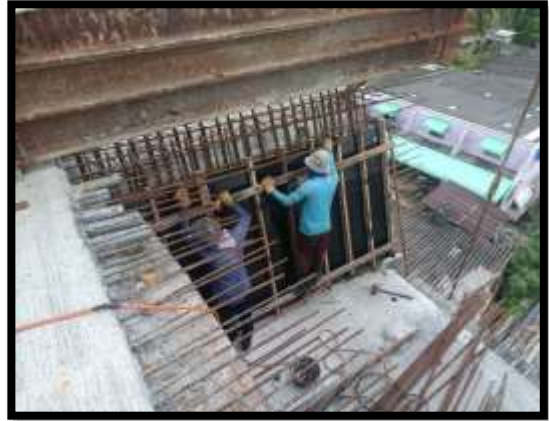
ภาพแสดงงานเข้าแบบผนัง Balance P9 Type D-D
