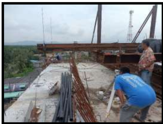
ภาพแสดงงานตรวจสอบระดับ งาน Balance P9 Type C-C
