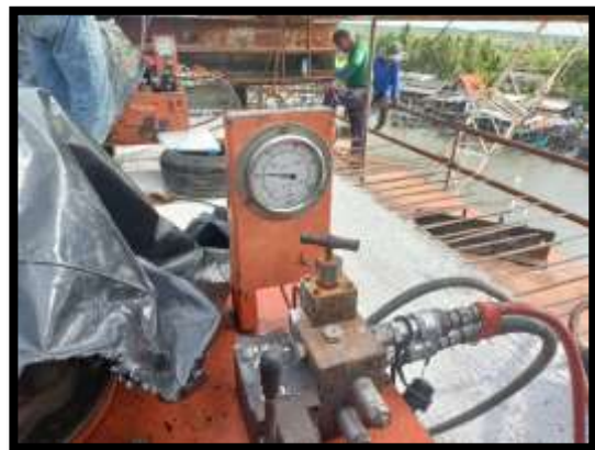
ภาพแสดงงานตั้งลวดอัดแรงตามยาว งาน Balance P9 Type C-C
