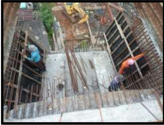
ภาพแสดงงานเข้าแบบผนัง Balance P9 Type D-D
