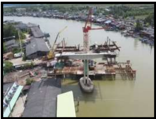
ภาพแสดงงานติดตั้ง Tower Crane บน Balance P9
