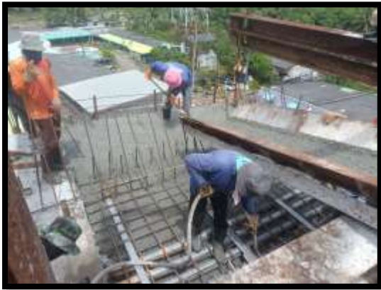
ภาพแสดงงานเทคอนกรีตโครงสร้างเสาตอม่อ P8 ต้นที่ 2
