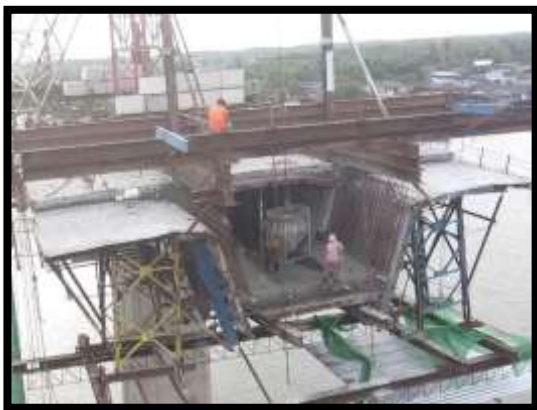
ภาพแสดงงานเทคอนกรีตพื้นล่าง Balance P9 Type D-D
