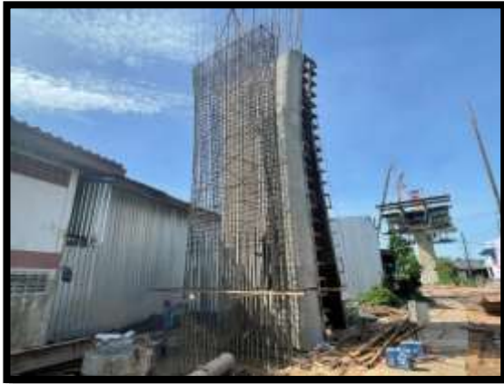
ภาพแสดงงานติดตั้งเหล็กโครงสร้างเสาตอม่อ P8 ต้นที่ 2
