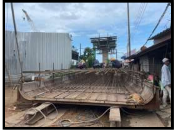
ภาพแสดงงานผูกเหล็กโครงสร้างเสาตอม่อ P8 ต้นที่ 2
