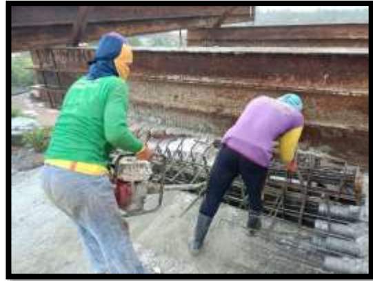
ภาพแสดงงานเทคอนกรีตผนัง Balance P9 Type D-D
