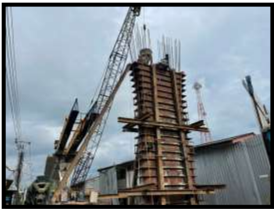
ภาพแสดงงานเทคอนกรีตโครงสร้างเสาตอม่อ P8 ต้นที่ 1
