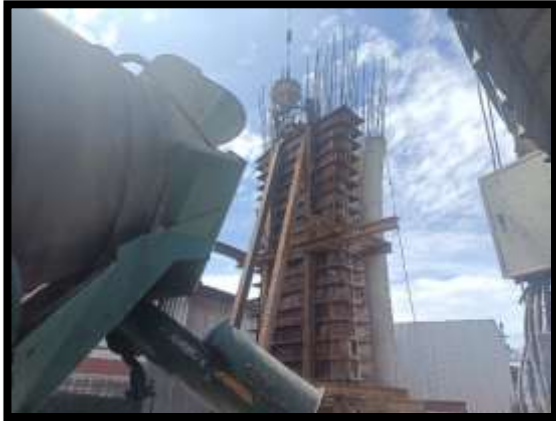
ภาพแสดงงานเทคอนกรีตโครงสร้างเสาตอม่อ P8 ต้นที่ 2
