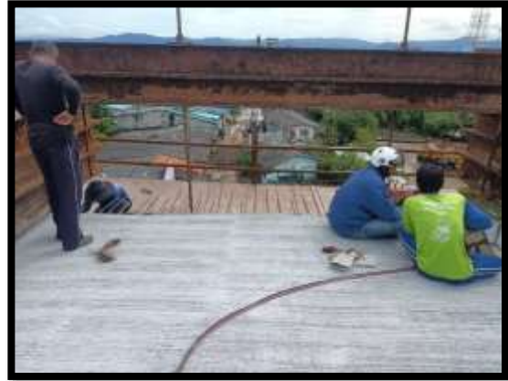
ภาพแสดงงานร้อยลวดอัดแรงตามยาว งาน Balance P9 Type C-C
