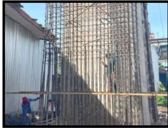
ภาพแสดงงานติดตั้งเหล็กโครงสร้างเสาตอม่อ P8 ต้นที่ 2
