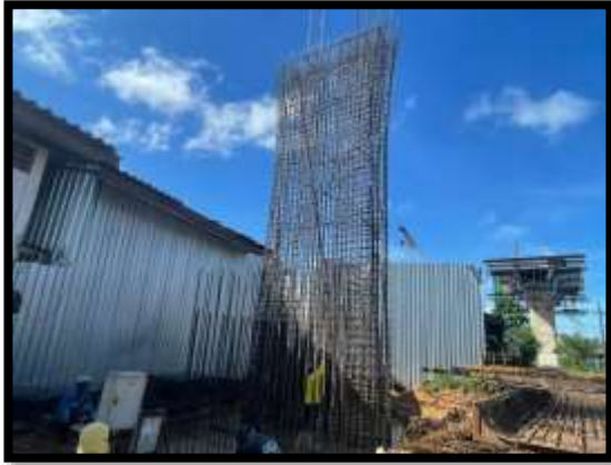
ภาพแสดงงานผูกเหล็กและติดตั้งโครงสร้างเสาตอม่อ P8 ต้นที่ 1
