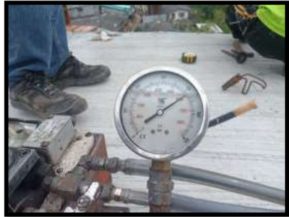
ภาพแสดงงานตั้งลวดอัดแรงตามขวาง งาน Balance P9 Type C-C
