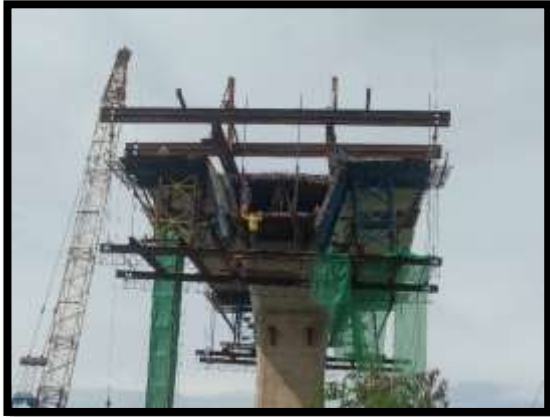
ภาพแสดงงานเข้าแบบ งาน Balance P9 Type D-D
