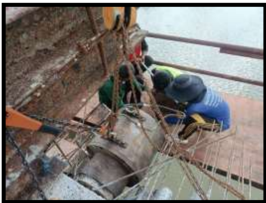
ภาพแสดงงานตั้งลวดอัดแรงตามยาว งาน Balance P9 Type C-C
