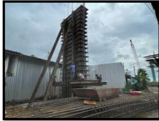
ภาพแสดงงานเข้าแบบโครงสร้างเสาตอม่อ P8 ต้นที่ 1
