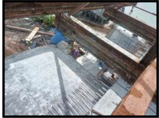
ภาพแสดงงานเข้าแบบ งาน Balance P9 Type D-D
