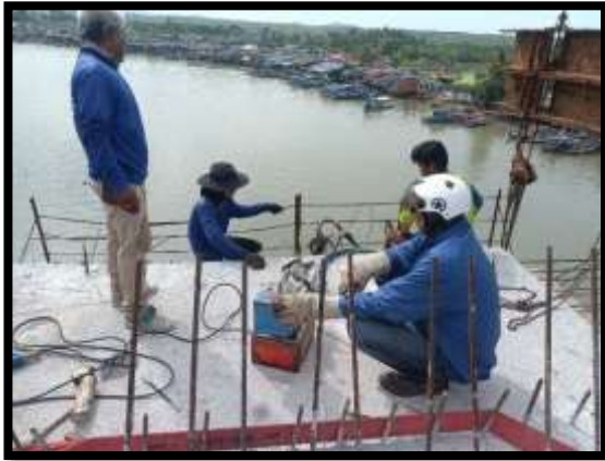
ภาพแสดงงานตั้งลวดอัดแรงตามขวาง งาน Balance P9 Type C-C
