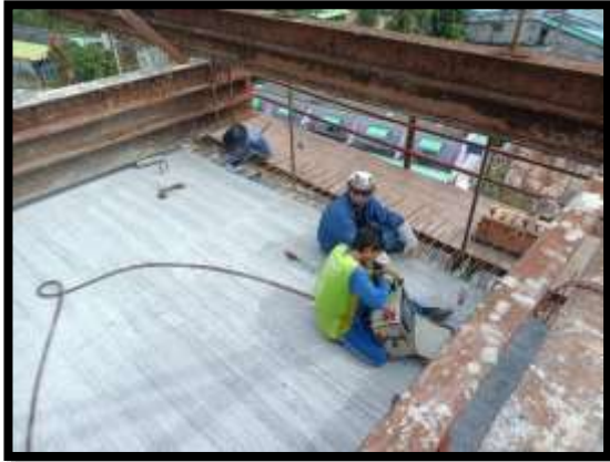
ภาพแสดงงานร้อยลวดอัดแรงตามยาว งาน Balance P9 Type C-C
