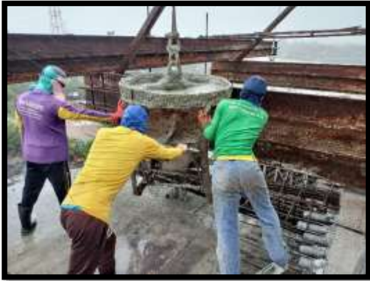
ภาพแสดงงานเทคอนกรีตผนัง Balance P9 Type D-D
