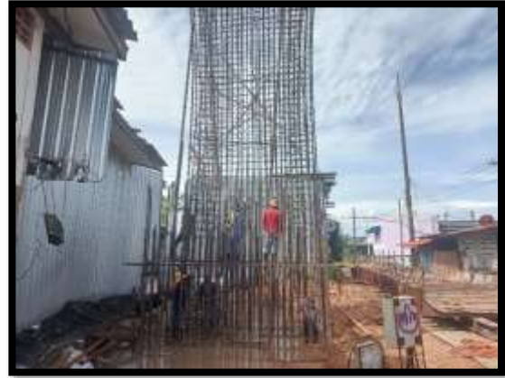
ภาพแสดงงานผูกเหล็กและติดตั้งโครงสร้างเสาตอม่อ P8 ต้นที่ 1
