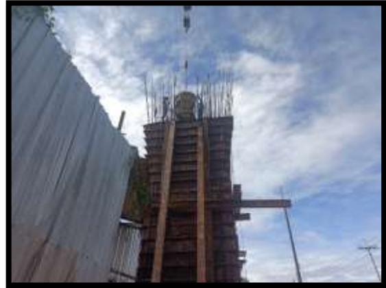
ภาพแสดงงานเทคอนกรีตโครงสร้างเสาตอม่อ P8 ต้นที่ 2
