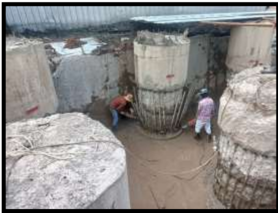
ภาพแสดงงานตัดตกแต่งเสาเข็มเจาะ P8
