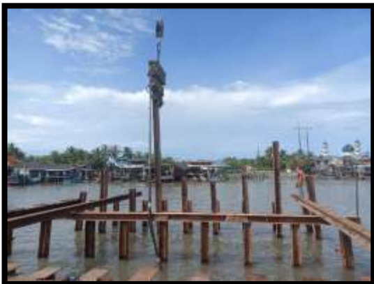
ภาพแสดงงานปัก Beam งาน Jetty
