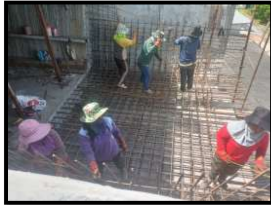
ภาพแสดงงานผูกเหล็กพื้นล่าง และผนัง Balance P9 Type C-C
