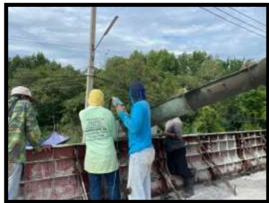
ภาพแสดงงานเทคอนกรีตราวกันตก
