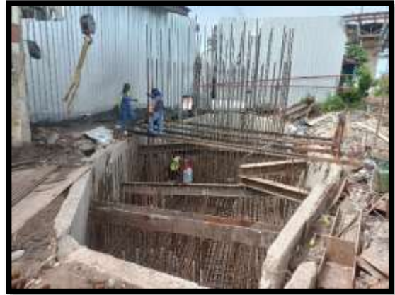
ภาพแสดงงานผูกเหล็กโครงสร้างเสาตอม่อ P8
