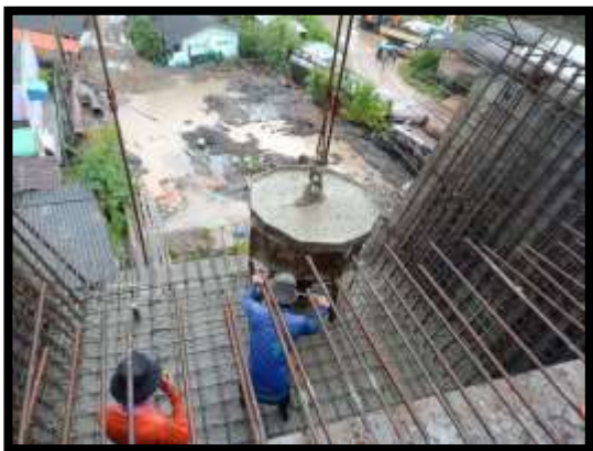
ภาพแสดงงานเทคอนกรีตพื้นล่าง Balance P9 Type C-C
