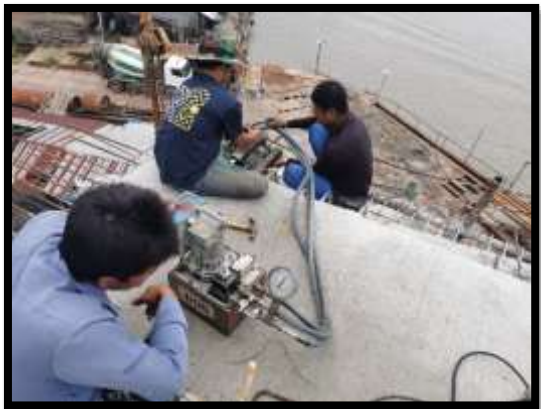
ภาพแสดงงานดึงลวดอัดแรง ตามขวาง Balance P9 Type B-B
