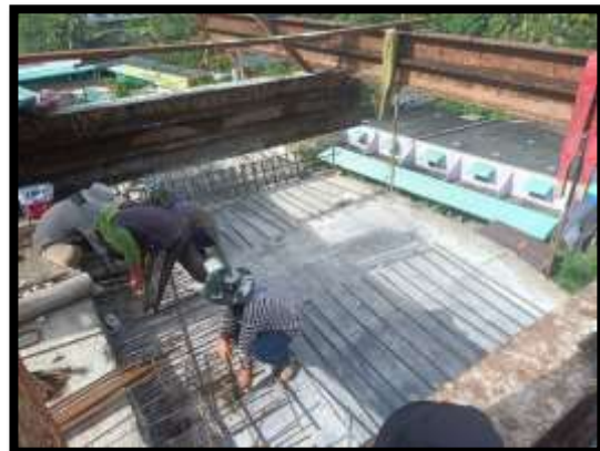
ภาพแสดงงานผูกเหล็กพื้นบน Balance P9 Type C-C
