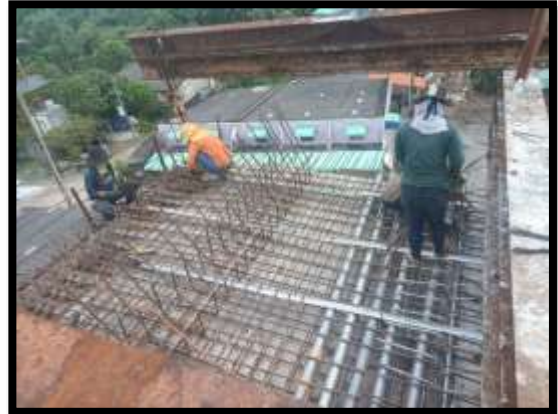
ภาพแสดงงานติดตั้งท่อลอดอัดแรงตามยาว Balance P9 Type C-C
