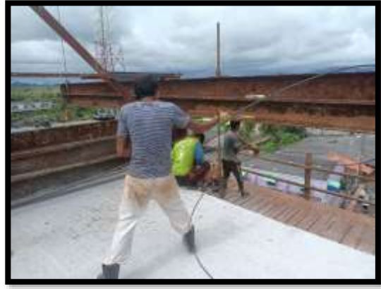
ภาพแสดงงานติดตั้งลวดอัดแรง Balance P9 Type B-B
