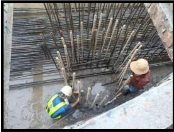
ภาพแสดงงานทดสอบเสาเข็มเจาะ โดยวิธี Seismic Test ตำแหน่ง P8/6,P8/7,P8/8
