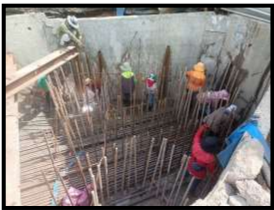
ภาพแสดงงานผูกเหล็กฐานราก P8
