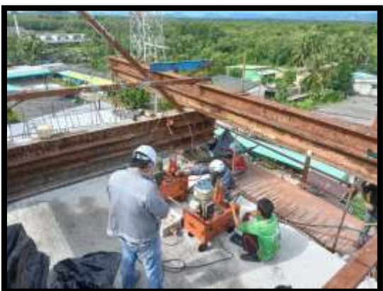
ภาพแสดงงานดึงลวดอัดแรง ตามยาว Balance P9 Type B-B
