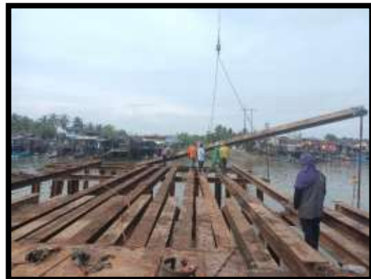
ภาพแสดงงานปัก Beam งาน Jetty
