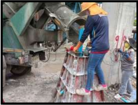
ภาพแสดงงานเทคอนกรีตฐานเสาไฟคอนกรีต
