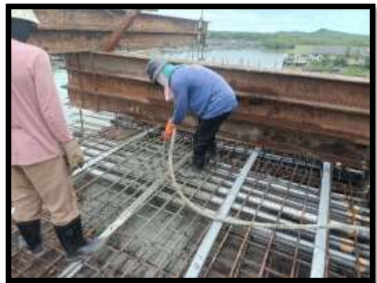
ภาพแสดงงานเทคอนกรีตพื้น Balance P9 Type B-B
