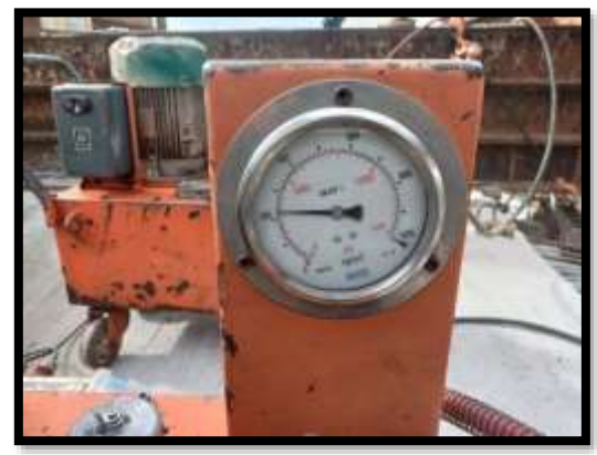
ภาพแสดงงานดึงลวดอัดแรง ตามยาว Balance P9 Type B-B
