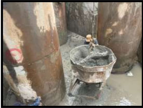
ภาพแสดงงานเทคอนกรีตหยาบฐานราก P8
