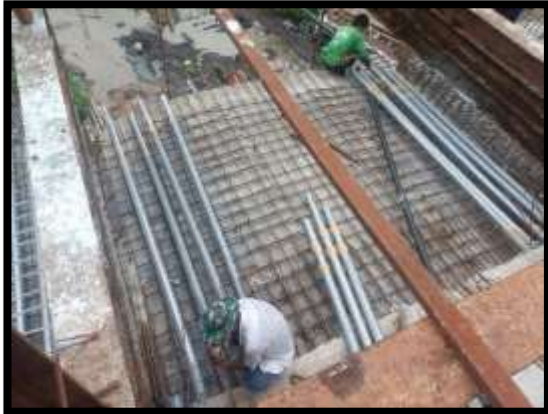
ภาพแสดงงานติดตั้งท่อลอดอัดแรงตามยาว Balance P9 Type C-C
