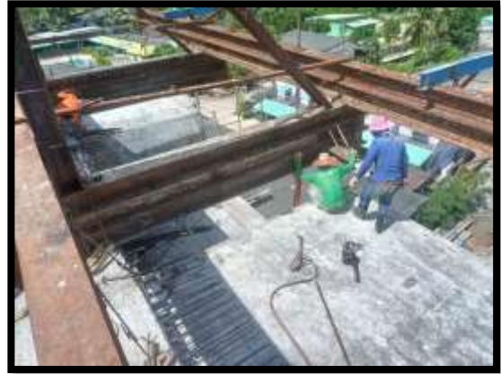
ภาพแสดงงานเข้าแบบ Balance P9 Type C-C
