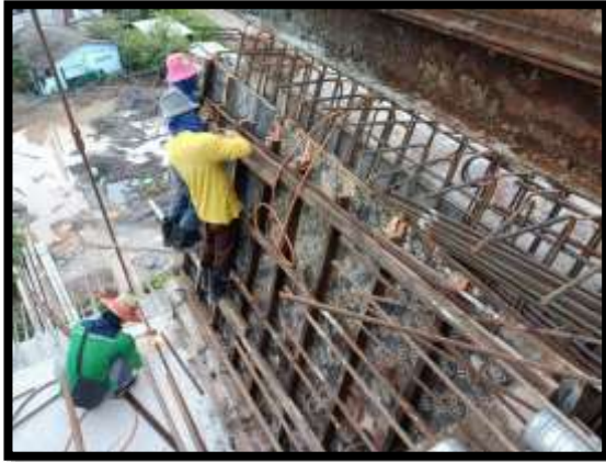
ภาพแสดงงานเข้าแบบผนัง Balance P9 Type C-C
