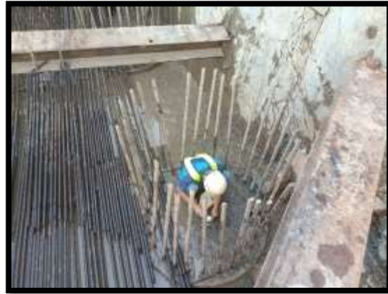
ภาพแสดงงานทดสอบเสาเข็มเจาะ โดยวิธี Seismic Test ตำแหน่ง P8/6,P8/7,P8/8
