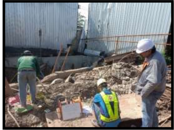
ภาพแสดงงานทดสอบเสาเข็มเจาะ โดยวิธี Sonic Logging Test ตำแหน่ง P8/6,P8/7,P8/8
