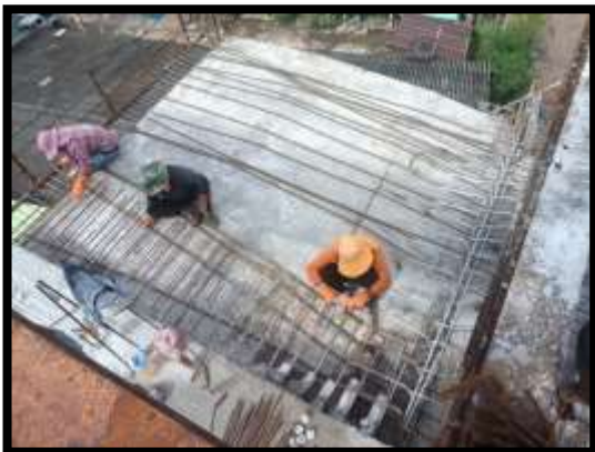
ภาพแสดงงานผูกเหล็กพื้นบน Balance P9 Type C-C
