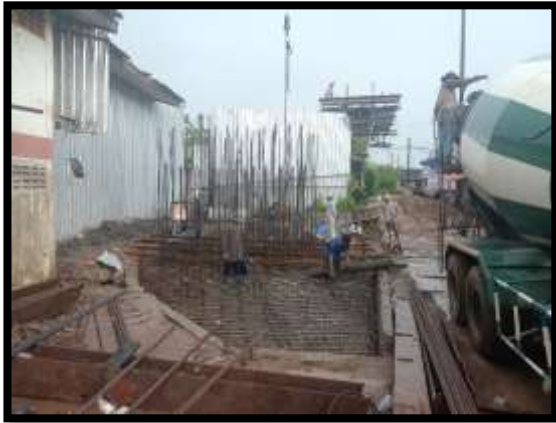
ภาพแสดงงานเทคอนกรีตฐานราก P8
