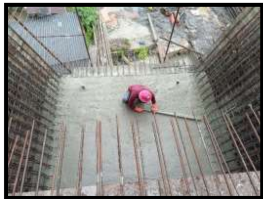
ภาพแสดงงานเทคอนกรีตพื้นล่าง Balance P9 Type C-C
