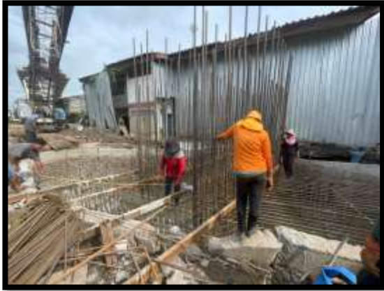
ภาพแสดงงานผูกเหล็กโครงสร้างเสาตอม่อ P8
