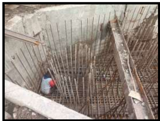
ภาพแสดงงานผูกเหล็กฐานราก P8
