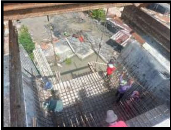
ภาพแสดงงานผูกเหล็กพื้นล่าง และผนัง Balance P9 Type C-C
