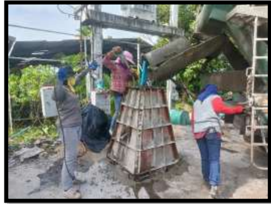
ภาพแสดงงานเทคอนกรีตฐานเสาไฟคอนกรีต
