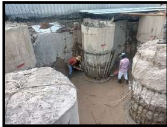
ภาพแสดงงานตัดตกแต่งเสาเข็มเจาะ P8
