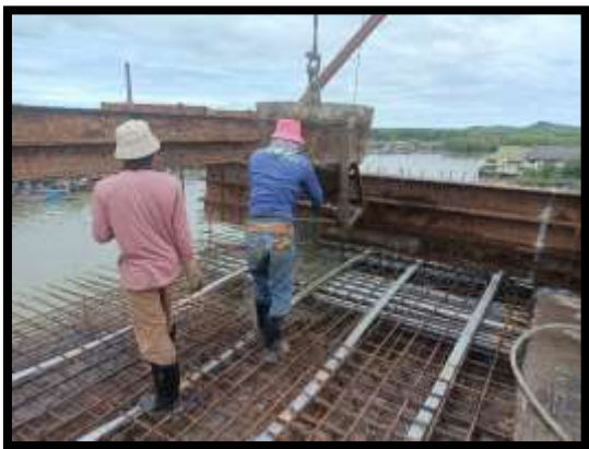
ภาพแสดงงานเทคอนกรีตพื้น Balance P9 Type B-B
