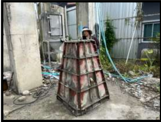
ภาพแสดงงานเข้าแบบฐานเสาไฟคอนกรีต
