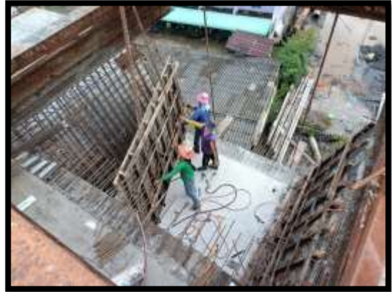
ภาพแสดงงานเข้าแบบผนัง Balance P9 Type C-C
