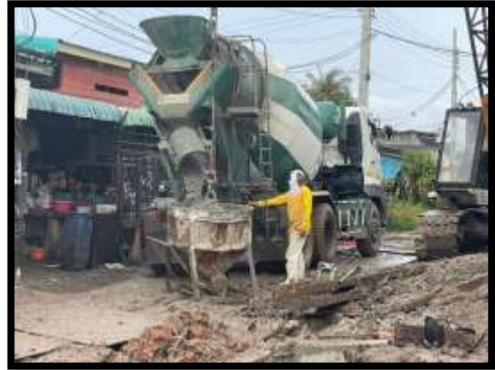
ภาพแสดงงานเทคอนกรีตหยาบฐานราก P8
