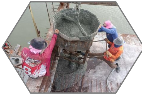
งานเทคอนกรีตผนัง Balance P9 Type B-B
