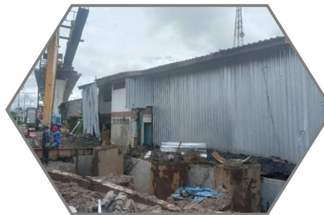
งานติดตั้งผนังป้องกันดิน พังทลาย P8
