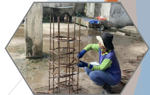
งานผูกเหล็กฐานเสาไฟฟ้า คอนกรีต
