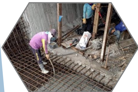
งานเทคอนกรีตพื้นล่าง Balance P9 Type B-B
