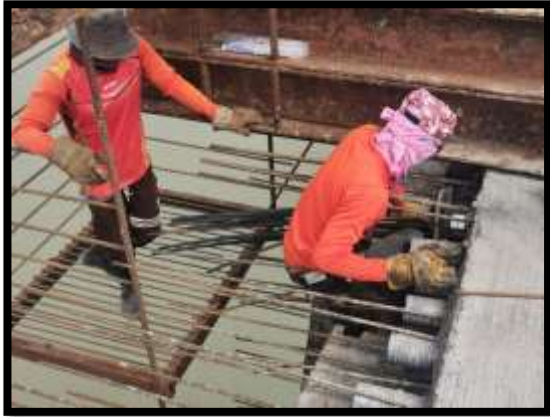
ภาพแสดงงานติดตั้งอุปกรณ์ดึงลวดอัดแรง ตามยาว และ ตามขวาง งาน Balance P9 Type A-A
