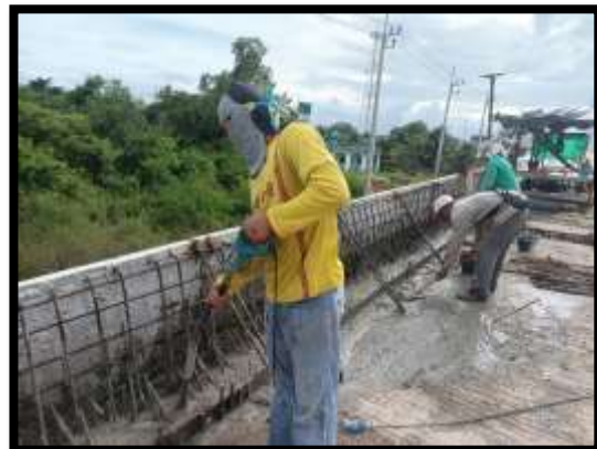
ภาพแสดงงานเทคอนกรีตฐานราก ราวกันตก
