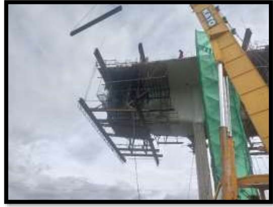
ภาพแสดงงานเตรียมงาน Balance P9 Type B-B
