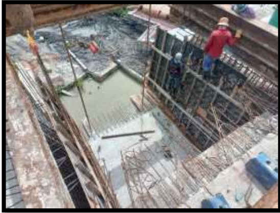
ภาพแสดงงานเข้าแบบผนัง Balance P9 Type B-B
