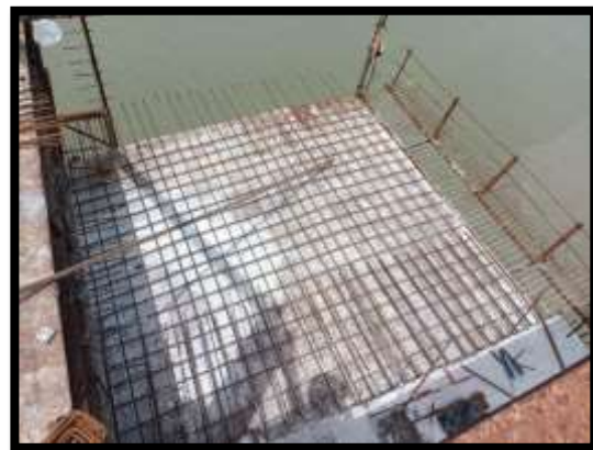
ภาพแสดงงานผูกเหล็ก พื้นบน Balance P9 Type B-B
