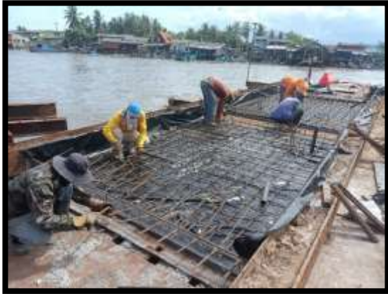
ภาพแสดงงานเข้าแบบ ผูกเหล็ก Skirt ฐานราก P8
