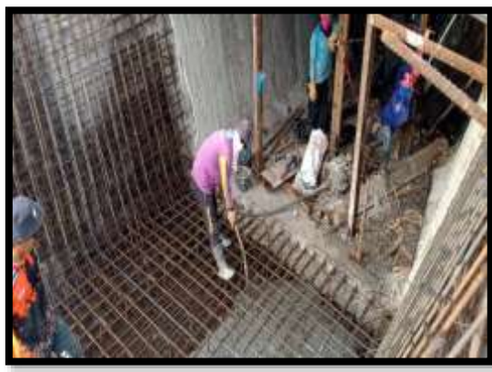
ภาพแสดงงานเทคอนกรีต พื้นล่าง Balance P9 Type B-B
