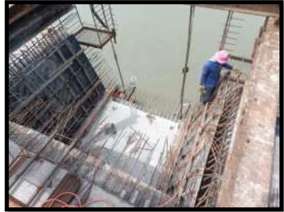
ภาพแสดงงานเข้าแบบผนัง Balance P9 Type B-B
