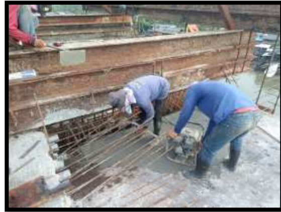
ภาพแสดงงานเทคอนกรีตผนัง Balance P9 Type B-B
