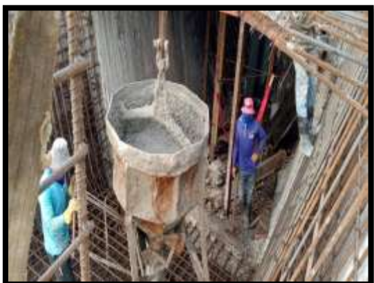
ภาพแสดงงานเทคอนกรีต พื้นล่าง Balance P9 Type B-B
