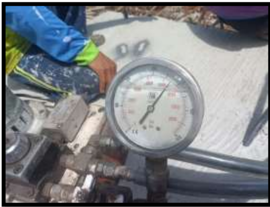
ภาพแสดงงานดึงลวดอัดแรง ตามขวาง งาน Balance P9 Type A-A
