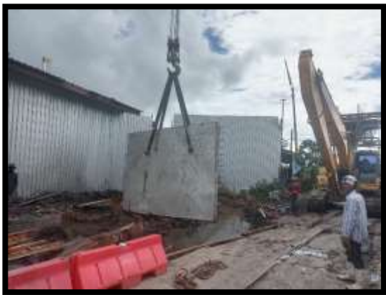
ภาพแสดงงานติดตั้งผนังป้องกันดินพังทลาย ฐานราก P8
