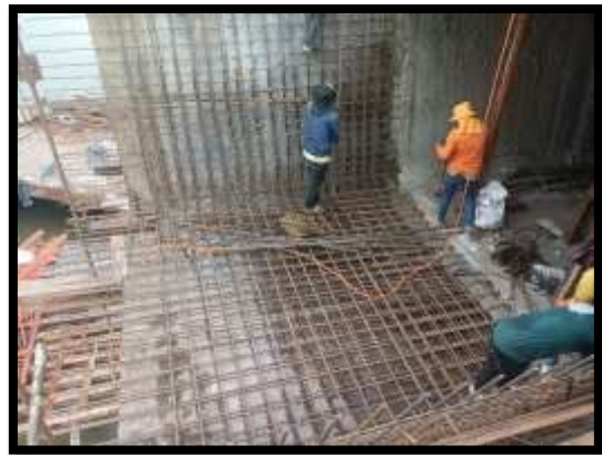
ภาพแสดงงานผูกเหล็ก พื้นล่าง Balance P9 Type B-B
