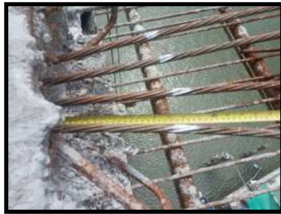
ภาพแสดงงานดึงลวดอัดแรง ตามขวาง งาน Balance P9 Type A-A
