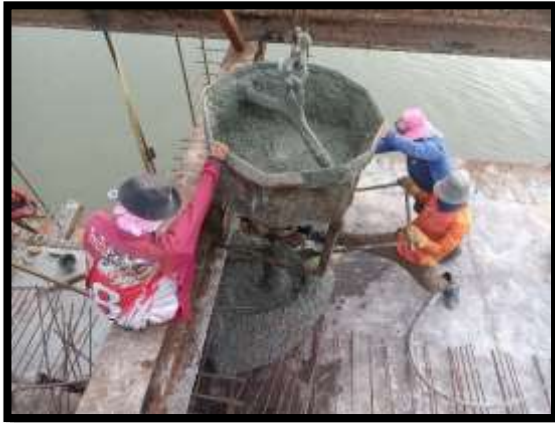
ภาพแสดงงานเทคอนกรีตผนัง Balance P9 Type B-B
