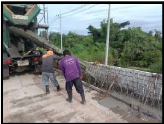
ภาพแสดงงานเทคอนกรีตฐานราก ราวกันตก
