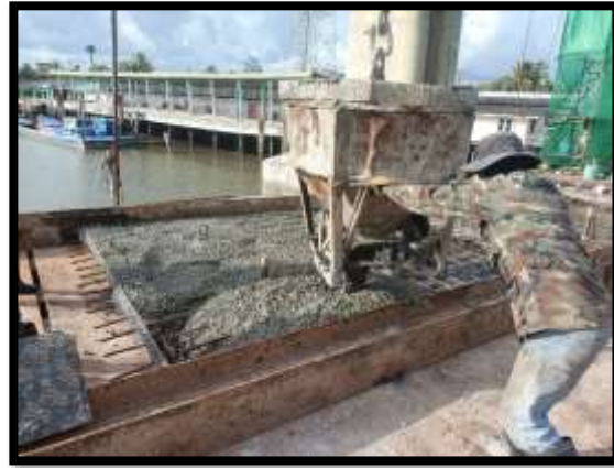
ภาพแสดงงานเทคอนกรีต Skirt ฐานราก P8
