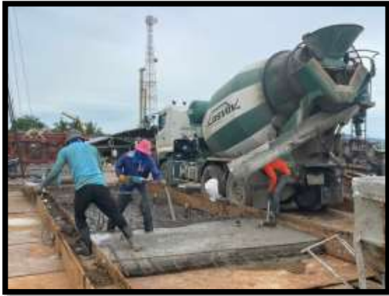
ภาพแสดงงานเทคอนกรีต Skirt ฐานราก P8
