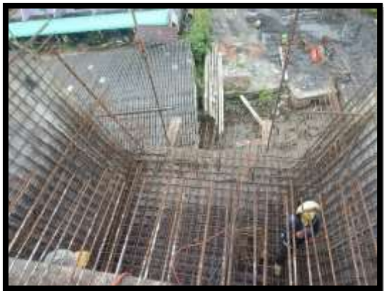
ภาพแสดงงานผูกเหล็ก พื้นล่าง Balance P9 Type B-B
