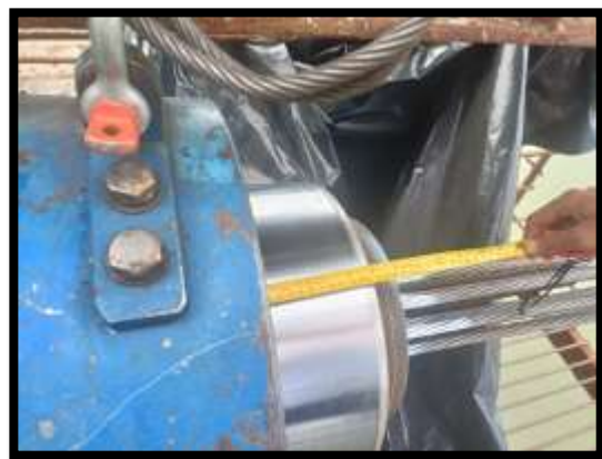
ภาพแสดงงานดึงลวดอัดแรง ตามยาว งาน Balance P9 Type A-A
