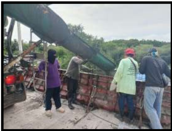
ภาพแสดงงานเทคอนกรีตราวกันตก
