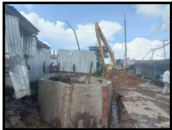
ภาพแสดงงานติดตั้งผนังป้องกันดินพังทลาย ฐานราก P8
