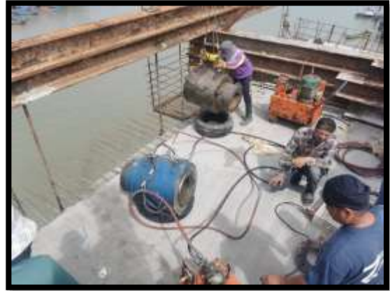
ภาพแสดงงานติดตั้งอุปกรณ์ดึงลวดอัดแรง ตามยาว และ ตามขวาง งาน Balance P9 Type A-A
