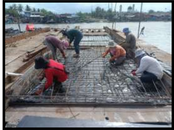
ภาพแสดงงานเข้าแบบ ผูกเหล็ก Skirt ฐานราก P8
