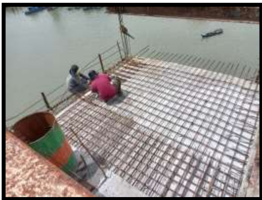
ภาพแสดงงานผูกเหล็ก พื้นบน Balance P9 Type B-B
