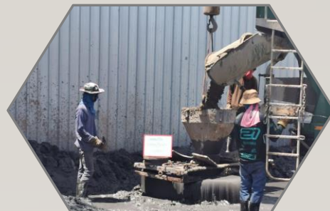
เทคอนกรีตเสาเข็มเจาะ P8 ต้นที่ 7
