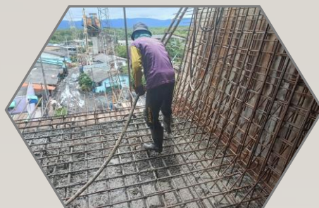
เทคอนกรีตพื้นล่าง Balance P9 Type A-A
