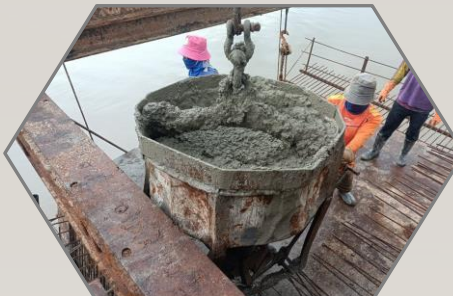
เทคอนกรีตผนัง Balance P9 Type A-A
