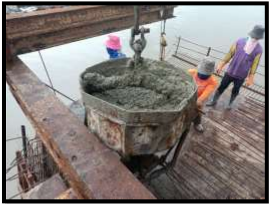
ภาพแสดงงานเทคอนกรีตผนัง Balance ช่วง P9 Type A-A
