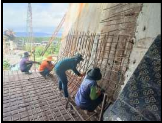
ภาพแสดงงานผูกเหล็ก Balance ช่วง P9 Type A-A
