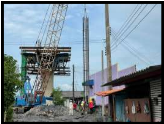
ภาพแสดงงานลงเหล็กโครงสร้างเสาเข็มเจาะ R2 งานบันไดสะพาน RT (ฝั่งแผ่นดิน)
