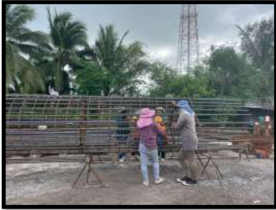
ภาพแสดงงานผูกเหล็กโครงสร้างเสาเข็มเจาะ P8 ต้นที่ 7
