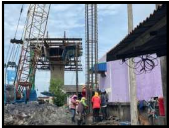
ภาพแสดงงานลงเหล็กโครงสร้างเสาเข็มเจาะ R2 งานบันไดสะพาน RT (ฝั่งแผ่นดิน)
