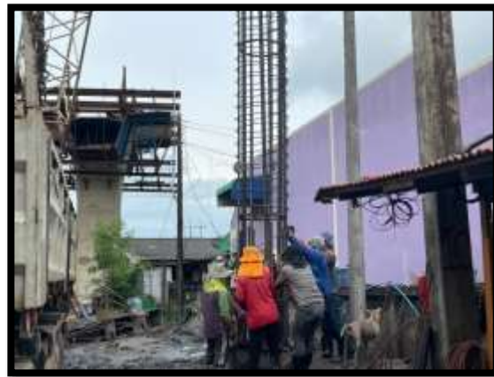
ภาพแสดงงานลงเหล็กโครงสร้างเสาเข็มเจาะ R4 งานบันไดสะพาน RT (ฝั่งแผ่นดิน)
