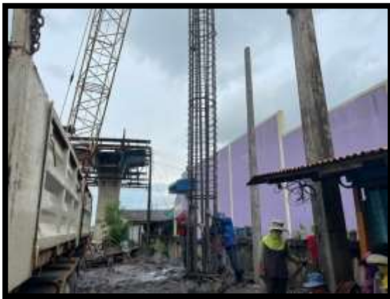
ภาพแสดงงานลงเหล็กโครงสร้างเสาเข็มเจาะ R4 งานบันไดสะพาน RT (ฝั่งแผ่นดิน)
