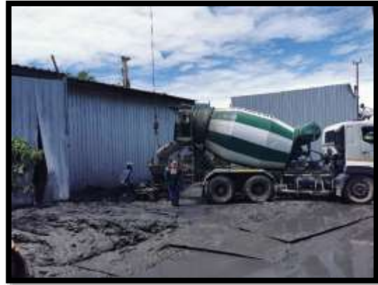
ภาพแสดงงานลงเหล็ก และ เทคอนกรีตโครงสร้างเสาเข็มเจาะ P8 ต้นที่ 7
