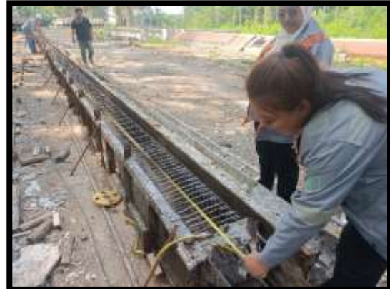
ภาพแสดงงานตรวจสอบเหล็ก งานเสาเข็มตอก Transition (ฝั่งเกาะ)
