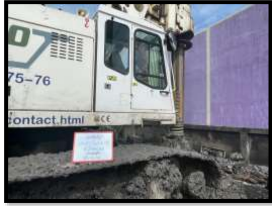
ภาพแสดงงานปักท่อ Casing พร้อมเจาะชั้นดิน เสาะเข็มเจาะ R2 งานบันไดสะพาน RT (ฝั่งแผ่นดิน)
