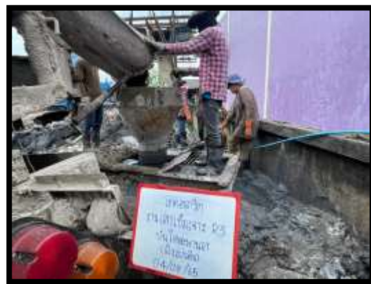
ภาพแสดงงานเทคอนกรีตเสาค้ำเจาะ R3 งานบันไดสะพาน RT (ฝั่งแผ่นดิน)
