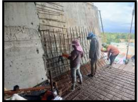
ภาพแสดงงานผูกเหล็ก Balance ช่วง P9 Type A-A
