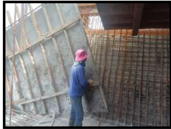
ภาพแสดงงานเข้าแบบผนัง Balance ช่วง P9 Type A-A
