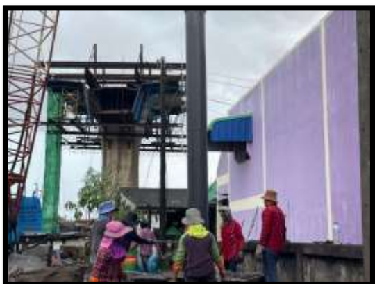
ภาพแสดงงานลงท่อ Timmy และ เทคอนกรีตเสาเข็มเจาะ R2 งานบันไดสะพาน RT (ฝั่งแผ่นดิน)
