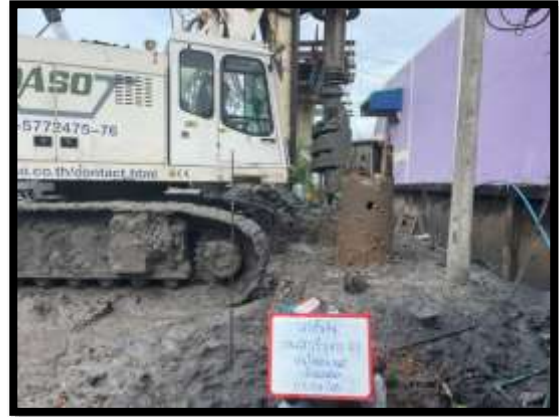
ภาพแสดงงานปักท่อ Casing พร้อมเจาะชั้นดิน เสาค้ำเจาะ R3 งานบันไดสะพาน RT (ฝั่งแผ่นดิน)
