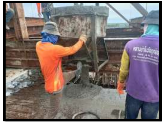
ภาพแสดงงานเทคอนกรีตผนัง Balance ช่วง P9 Type A-A
