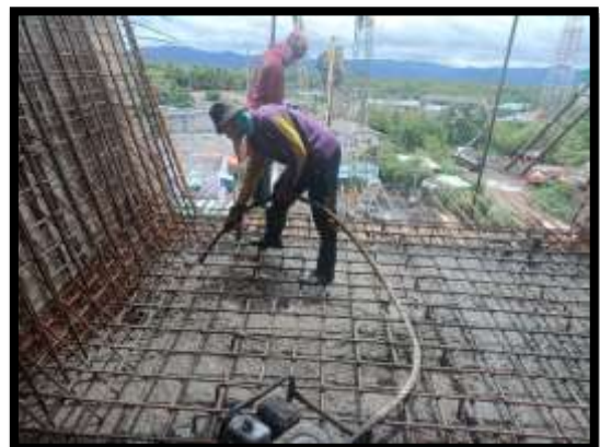
ภาพแสดงงานเทคอนกรีตพื้นสะพาน Balance ช่วง P9-P8 Type A-A
