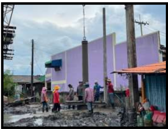
ภาพแสดงงานลงท่อ Timmy และ เทคอนกรีตเสาเข็มเจาะ R4 งานบันไดสะพาน RT (ฝั่งแผ่นดิน)
