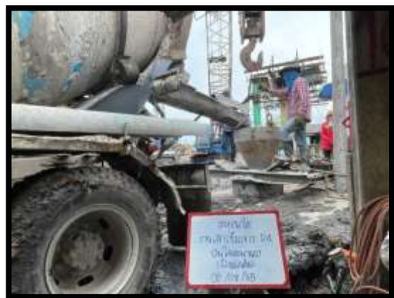
ภาพแสดงงานลงท่อ Timmy และ เทคอนกรีตเสาเข็มเจาะ R4 งานบันไดสะพาน RT (ฝั่งแผ่นดิน)
