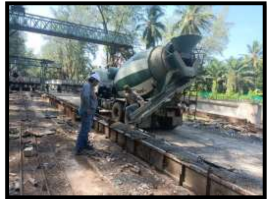
ภาพแสดงงานเทคอนกรีต งานเสาเข็มตอก Transition (ฝั่งเกาะ)
