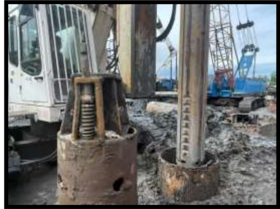
ภาพแสดงงานเจาะเสาเข็ม R4 งานบันไดสะพาน RT (ฝั่งแผ่นดิน)
