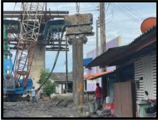
ภาพแสดงงานปักท่อ Casing พร้อมเจาะชั้นดิน เสาค้ำเจาะ R3 งานบันไดสะพาน RT (ฝั่งแผ่นดิน)
