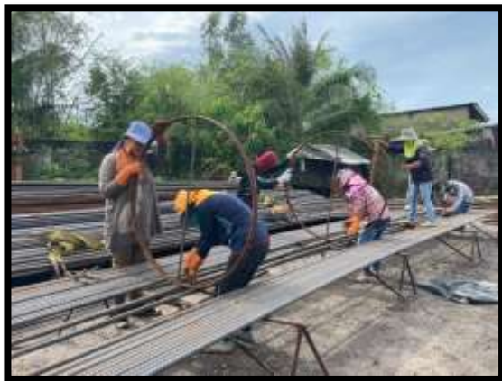
ภาพแสดงงานผูกเหล็กและลงเหล็กโครงสร้างเสาเข็มเจาะ P8 ต้นที่ 6
