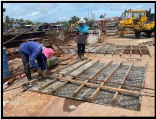
ภาพแสดงงานเข้าแบบผนัง Balance ช่วง P9 Type A-A
