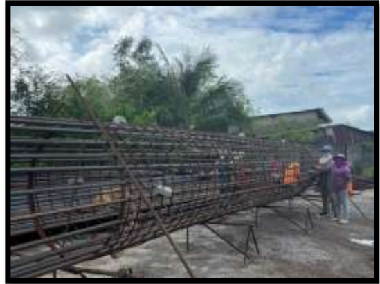
ภาพแสดงงานผูกเหล็กโครงสร้างเสาเข็มเจาะ P8 ต้นที่ 7
