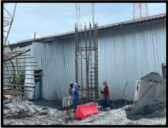
ภาพแสดงงานลงเหล็ก และ เทคอนกรีตโครงสร้างเสาเข็มเจาะ P8 ต้นที่ 7
