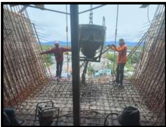
ภาพแสดงงานเทคอนกรีตพื้นสะพาน Balance ช่วง P9-P8 Type A-A
