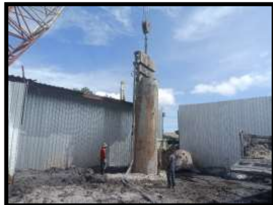
ภาพแสดงงานปักท่อ Casing งานเสาเข็มเจาะ P8 ต้นที่ 6
