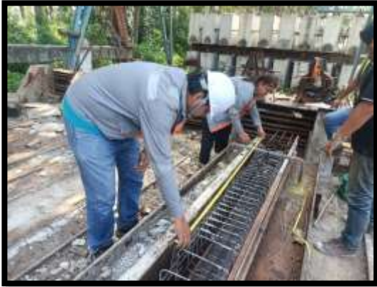
ภาพแสดงงานตรวจสอบเหล็ก งานเสาเข็มตอก Transition (ฝั่งเกาะ)
