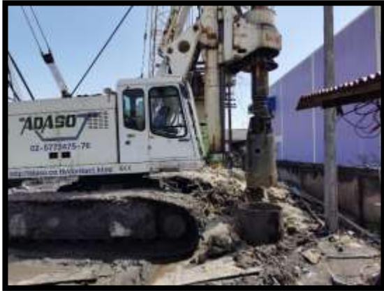
ภาพแสดงงานเจาะเสาเข็ม R4 งานบันไดสะพาน RT (ฝั่งแผ่นดิน)
