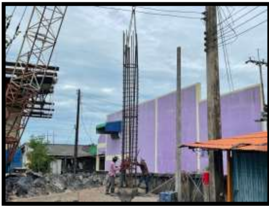
ภาพแสดงงานลงเหล็กโครงสร้างเสาค้ำเจาะ R3 งานบันไดสะพาน RT (ฝั่งแผ่นดิน)
