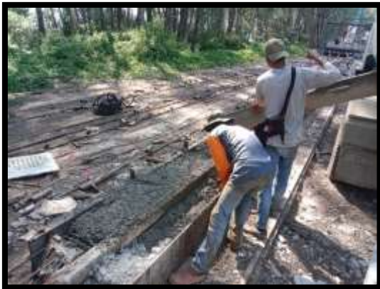
ภาพแสดงงานเทคอนกรีต งานเสาเข็มตอก Transition (ฝั่งเกาะ)
