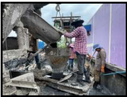
ภาพแสดงงานเทคอนกรีตเสาค้ำเจาะ R3 งานบันไดสะพาน RT (ฝั่งแผ่นดิน)
