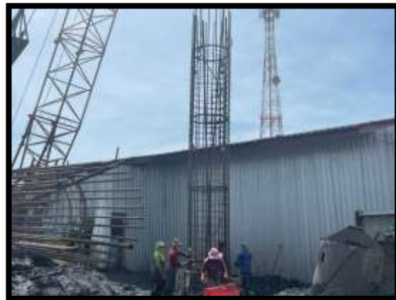
ภาพแสดงงานผูกเหล็กและลงเหล็กโครงสร้างเสาเข็มเจาะ P8 ต้นที่ 6
