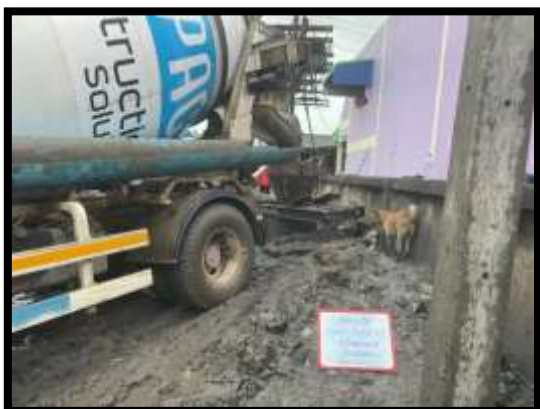
ภาพแสดงงานลงท่อ Timmy และ เทคอนกรีตเสาเข็มเจาะ R2 งานบันไดสะพาน RT (ฝั่งแผ่นดิน)
