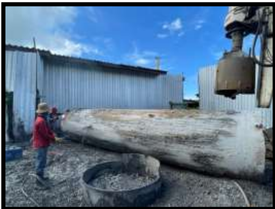
ภาพแสดงงานปักท่อ Casing งานเสาเข็มเจาะ P8 ต้นที่ 6
