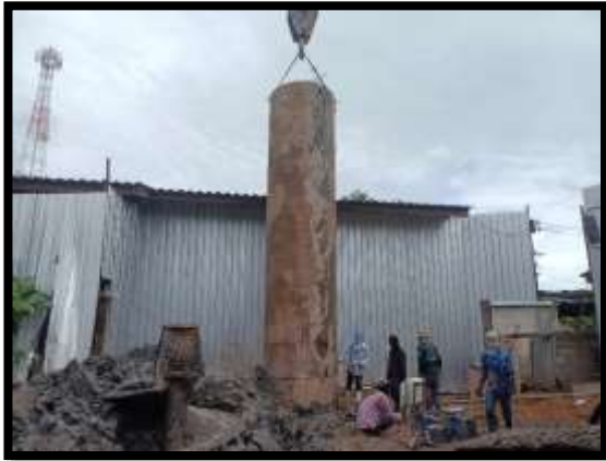
ภาพแสดงงานปักท่อ Casing งานเสาเข็มเจาะ P8 ต้นที่ 7
