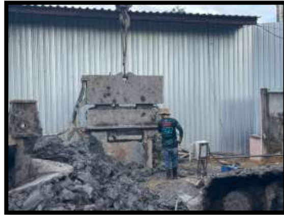
ภาพแสดงงานปักท่อ Casing งานเสาเข็มเจาะ P8 ต้นที่ 7
