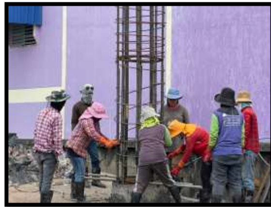
ภาพแสดงงานลงเหล็กโครงสร้างเสาค้ำเจาะ R3 งานบันไดสะพาน RT (ฝั่งแผ่นดิน)
