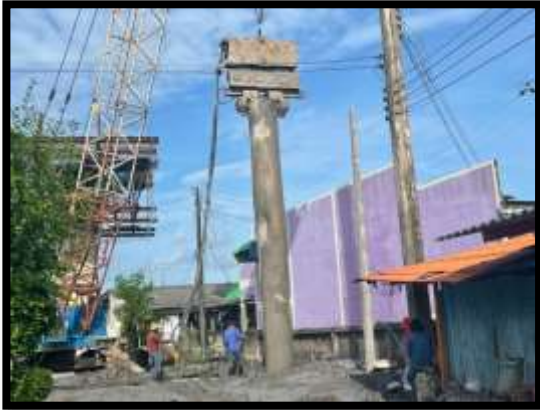
ภาพแสดงงานปักท่อ Casing พร้อมเจาะชั้นดิน เสาะเข็มเจาะ R2 งานบันไดสะพาน RT (ฝั่งแผ่นดิน)
