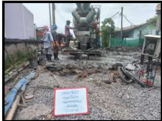
ภาพแสดงงานลงท่อ Timmy พร้อมเทคอนกรีตเสาเข็มเจาะ R5 งานบันไดสะพาน RT (ฝั่งแผ่นดิน)
