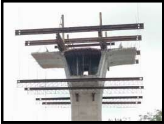
ภาพแสดงงานติดตั้ง Form Traveler ช่วง Pier ถึง Type A-A P9
