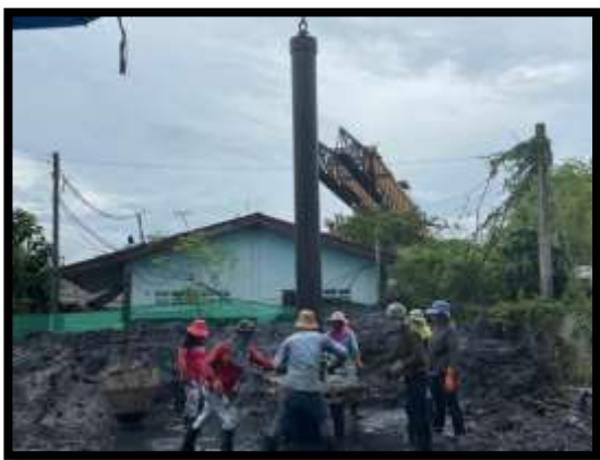
ภาพแสดงงานลงท่อ Timmy และ เทคอนกรีตเสาเข็มเจาะ A5 งานทางลาดผู้พิการ LT (ฝั่งแผ่นดิน)
