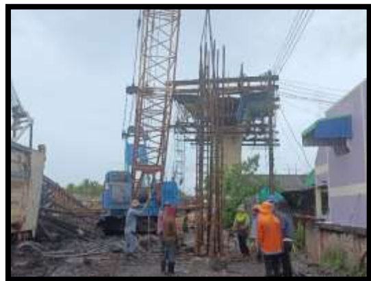
ภาพแสดงงานลงเหล็กโครงสร้างเสาเข็มเจาะ R5 งานบันไดสะพาน RT (ฝั่งแผ่นดิน)
