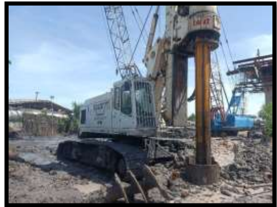
ภาพแสดงงานปักท่อ Casing และ เจาะเสาเข็ม R4 งานบันไดสะพาน RT (ฝั่งแผ่นดิน)
