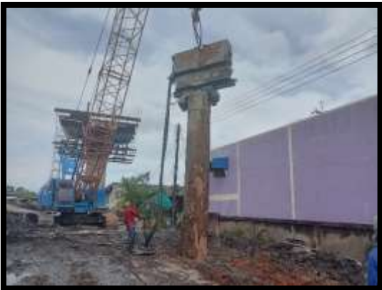
ภาพแสดงงานปักท่อ Casing และ เจาะเสาเข็ม R6 งานบันไดสะพาน RT (ฝั่งแผ่นดิน)
