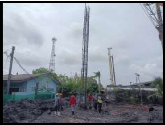
ภาพแสดงงานลงเหล็กโครงสร้างเสาเข็มเจาะ A4 งานทางลาดผู้พิการ LT (ฝั่งแผ่นดิน)
