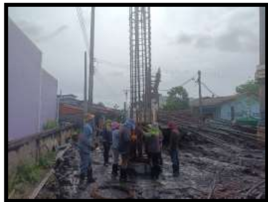
ภาพแสดงงานลงเหล็กโครงสร้างเสาเข็มเจาะ R5 งานบันไดสะพาน RT (ฝั่งแผ่นดิน)
