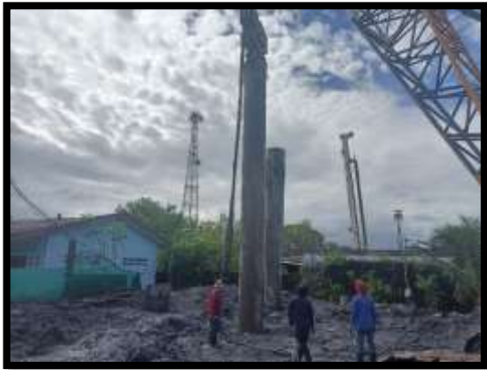
ภาพแสดงงานปักท่อ Casing และ เจาะเสาเข็ม A4 งานทางลาดผู้พิการ LT (ฝั่งแผ่นดิน)
