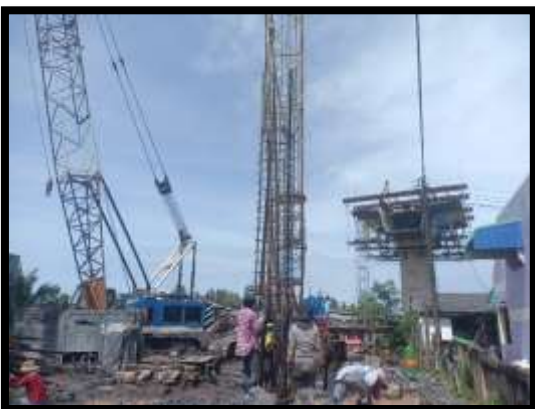
ภาพแสดงงานลงเหล็กโครงสร้างเสาเข็มเจาะ R6 งานบันไดสะพาน RT (ฝั่งแผ่นดิน)
