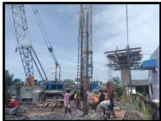
ภาพแสดงงานลงเหล็กโครงสร้างเสาเข็มเจาะ R6 งานบันไดสะพาน RT (ฝั่งแผ่นดิน)
