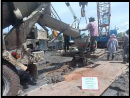
ภาพแสดงงานเทคอนกรีตเสาเข็มเจาะ R6 งานบันไดสะพาน RT (ฝั่งแผ่นดิน)
