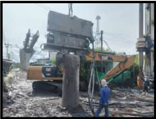
ภาพแสดงงานปักท่อ Casing และ เจาะเสาเข็ม R8 งานบันไดสะพาน RT (ฝั่งแผ่นดิน)
