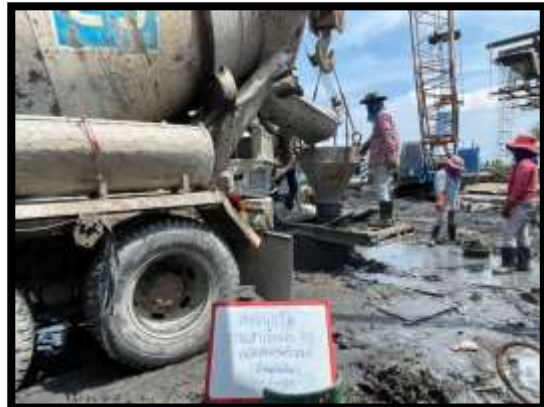
ภาพแสดงงานลงท่อ Timmy พร้อมเทคอนกรีตเสาเข็มเจาะ R8 งานบันไดสะพาน RT (ฝั่งแผ่นดิน)
