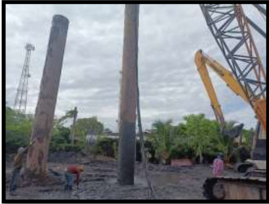
ภาพแสดงงานปักท่อ Casing งานเสาเข็มเจาะ A1 งานทางลาดผู้พิการ LT (ฝังแผ่นดิน)
