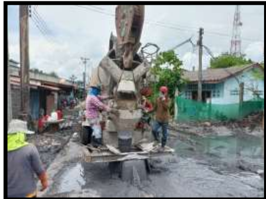
ภาพแสดงงานลงท่อ Timmy พร้อมเทคอนกรีตเสาเข็มเจาะ R7 งานบันไดสะพาน RT (ฝั่งแผ่นดิน)
