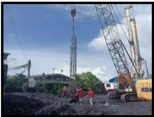
ภาพแสดงงานผูกเหล็กเสาเข็มเจาะ A3 งานทางลาดผู้พิการ LT (ฝั่งแผ่นดิน)
