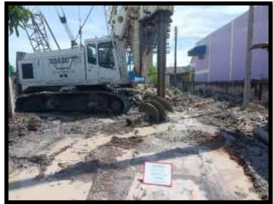
ภาพแสดงงานปักท่อ Casing และ เจาะเสาเข็ม R8 งานบันไดสะพาน RT (ฝั่งแผ่นดิน)
