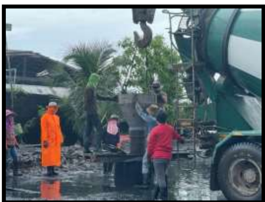
ภาพแสดงงานลงเหล็กและเทคอนกรีต โครงสร้างเสาเข็มเจาะ A2 งานทางลาดผู้พิการ LT (ฝั่งแผ่นดิน)
