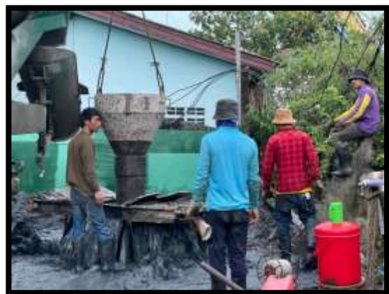
ภาพแสดงงานลงท่อ Timmy และ เทคอนกรีตเสาเข็มเจาะ A5 งานทางลาดผู้พิการ LT (ฝั่งแผ่นดิน)
