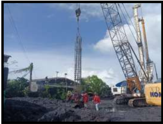
ภาพแสดงงานลงเหล็กและเทคอนกรีต โครงสร้างเสาเข็มเจาะ A1 งานทางลาดผู้พิการ LT (ฝั่งแผ่นดิน)
