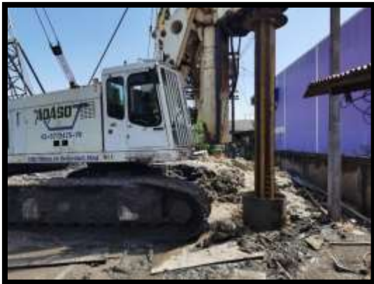
ภาพแสดงงานเสาเข็มเจาะ R7 งานบันไดสะพาน RT (ฝั่งแผ่นดิน)
