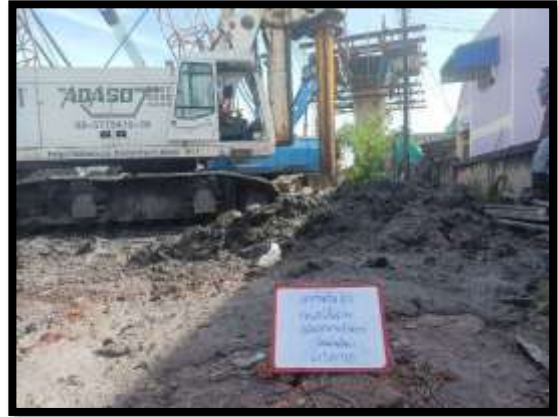
ภาพแสดงงานปักท่อ Casing และ เจาะเสาเข็ม R5 งานบันไดสะพาน RT (ฝั่งแผ่นดิน)
