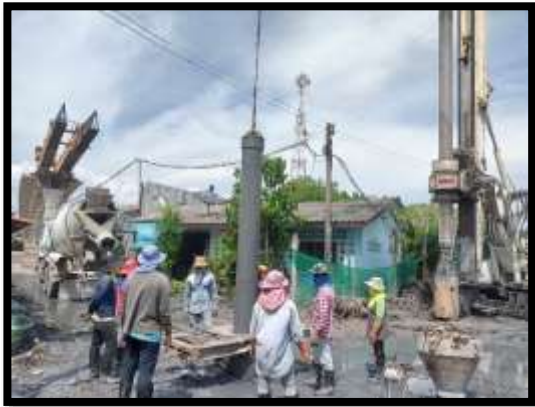
ภาพแสดงงานลงท่อ Timmy พร้อมเทคอนกรีตเสาเข็มเจาะ R7 งานบันไดสะพาน RT (ฝั่งแผ่นดิน)
