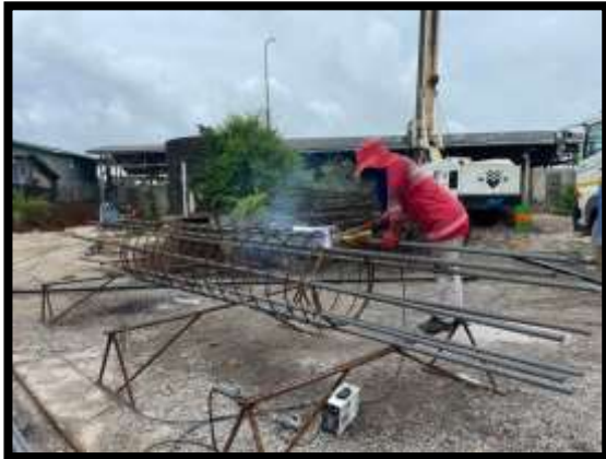
ภาพแสดงงานผูกเหล็กเสาเข็มเจาะ A3 งานทางลาดผู้พิการ LT (ฝั่งแผ่นดิน)
