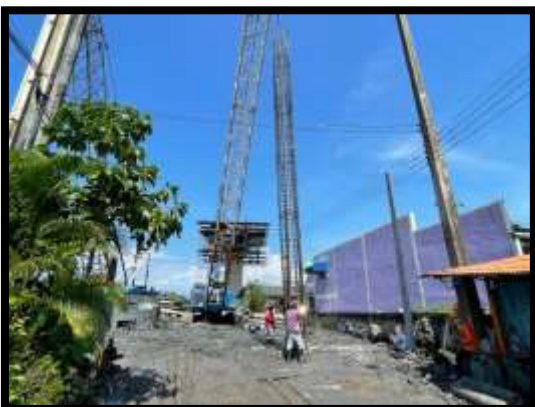
ภาพแสดงงานลงเหล็กโครงสร้างเสาเข็มเจาะ R8 งานบันไดสะพาน RT (ฝั่งแผ่นดิน)
