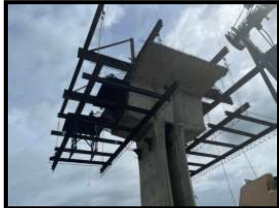
ภาพแสดงงานติดตั้ง Form Traveler ช่วง Pier ถึง Type A-A P9
