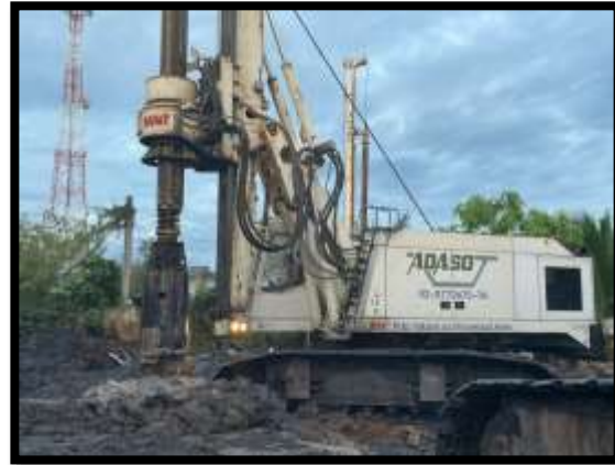
ภาพแสดงงานเจาะเสาเข็ม A1 งานทางลาดผู้พิการ LT (ฝังแผ่นดิน)
