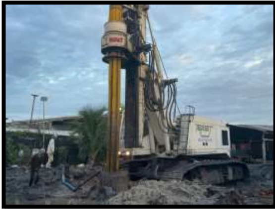
ภาพแสดงงานเจาะเสาเข็ม A1 งานทางลาดผู้พิการ LT (ฝังแผ่นดิน)
