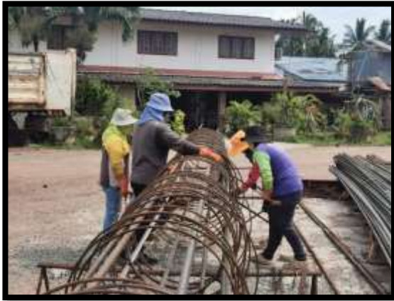
ภาพแสดงงานผูกเหล็กเสาเข็มเจาะ R5 งานบันไดสะพาน RT (ฝั่งแผ่นดิน)
