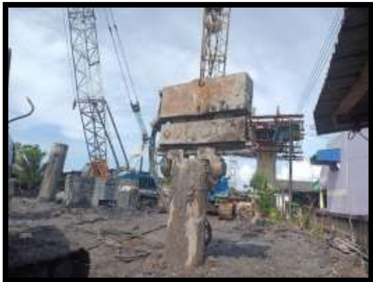
ภาพแสดงงานปักท่อ Casing และ เจาะเสาเข็ม R4 งานบันไดสะพาน RT (ฝั่งแผ่นดิน)
