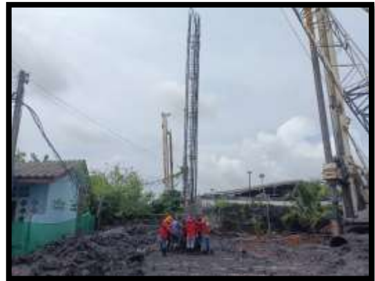
ภาพแสดงงานลงเหล็กโครงสร้างเสาเข็มเจาะ A4 งานทางลาดผู้พิการ LT (ฝั่งแผ่นดิน)
