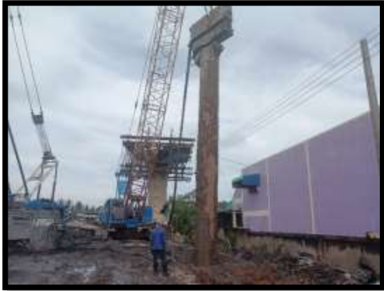
ภาพแสดงงานปักท่อ Casing และ เจาะเสาเข็ม R5 งานบันไดสะพาน RT (ฝั่งแผ่นดิน)
