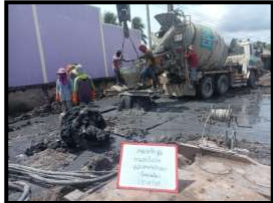
ภาพแสดงงานเทคอนกรีตเสาเข็มเจาะ R6 งานบันไดสะพาน RT (ฝั่งแผ่นดิน)
