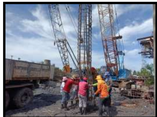
ภาพแสดงงานผูกเหล็ก และ ลงเหล็กโครงสร้างเสาเข็มเจาะ R7 งานบันไดสะพาน RT (ฝั่งแผ่นดิน)
