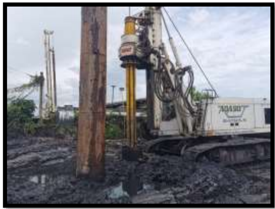
ภาพแสดงงานเจาะเสาเข็ม A2 งานทางลาดผู้พิการ LT (ฝั่งแผ่นดิน)
