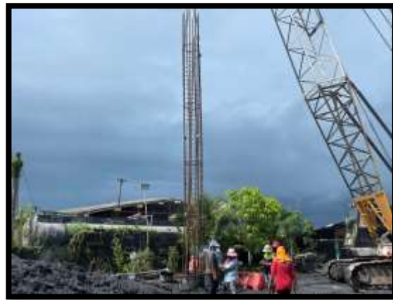
ภาพแสดงงานผูกเหล็ก และ ลงเหล็กโครงสร้างเสาเข็มเจาะ A5 งานทางลาดผู้พิการ LT (ฝั่งแผ่นดิน)
