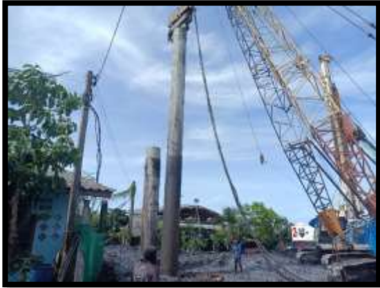
ภาพแสดงงานปักท่อ Casing และ เจาะเสาเข็ม A3 งานทางลาดผู้พิการ LT (ฝั่งแผ่นดิน)
