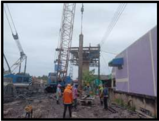
ภาพแสดงงานลงท่อ Timmy พร้อมเทคอนกรีตเสาเข็มเจาะ R5 งานบันไดสะพาน RT (ฝั่งแผ่นดิน)
