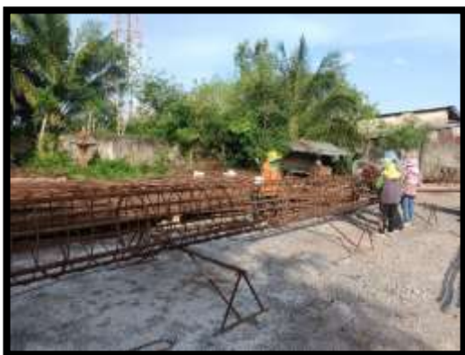
ภาพแสดงงานผูกเหล็กเสาเข็มเจาะ A1 และ A2 งานทางลาดผู้พิการ LT (ฝังแผ่นดิน)
