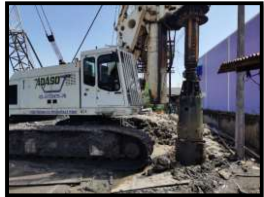
ภาพแสดงงานเสาเข็มเจาะ R7 งานบันไดสะพาน RT (ฝั่งแผ่นดิน)
