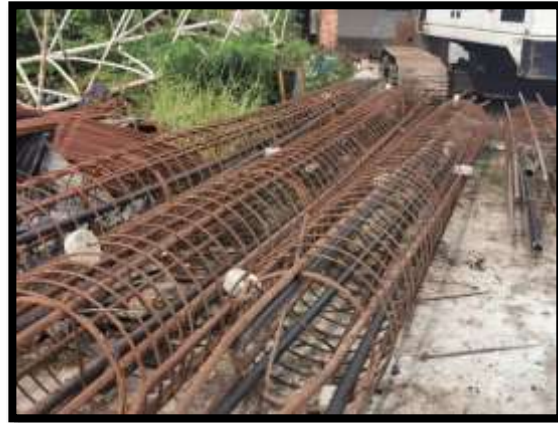
ภาพแสดงงานผูกเหล็กเสาเข็มเจาะ R5 งานบันไดสะพาน RT (ฝั่งแผ่นดิน)
