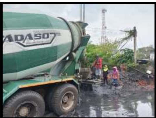
ภาพแสดงงานเทคอนกรีตเสาเข็มเจาะ A4 งานทางลาดผู้พิการ LT (ฝั่งแผ่นดิน)
