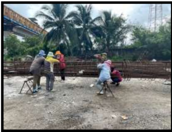
ภาพแสดงงานผูกเหล็ก และ ลงเหล็กโครงสร้างเสาเข็มเจาะ A5 งานทางลาดผู้พิการ LT (ฝั่งแผ่นดิน)
