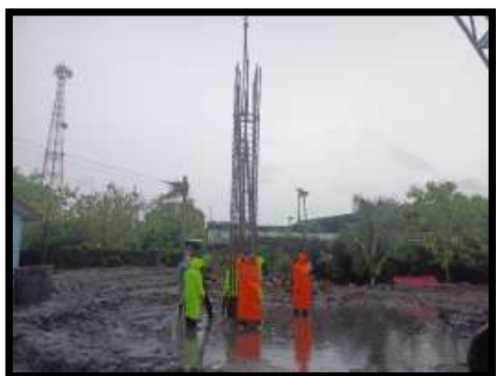
ภาพแสดงงานลงเหล็กและเทคอนกรีต โครงสร้างเสาเข็มเจาะ A2 งานทางลาดผู้พิการ LT (ฝั่งแผ่นดิน)
