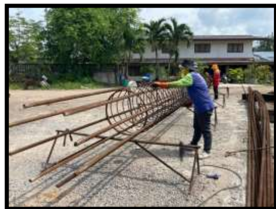
ภาพแสดงงานผูกเหล็กเสาเข็มเจาะ A1 และ A2 งานทางลาดผู้พิการ LT (ฝังแผ่นดิน)
