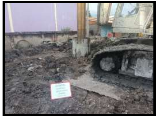
ภาพแสดงงานปักท่อ Casing และ เจาะเสาเข็ม R6 งานบันไดสะพาน RT (ฝั่งแผ่นดิน)
