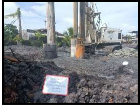
ภาพแสดงงานปักท่อ Casing และ เจาะเสาเข็ม A3 งานทางลาดผู้พิการ LT (ฝั่งแผ่นดิน)
