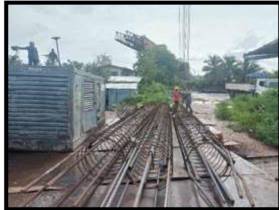
ภาพแสดงงานผูกเหล็กเสาเข็มเจาะ A3 งานทางลาดผู้พิการ LT (ฝั่งแผ่นดิน)
