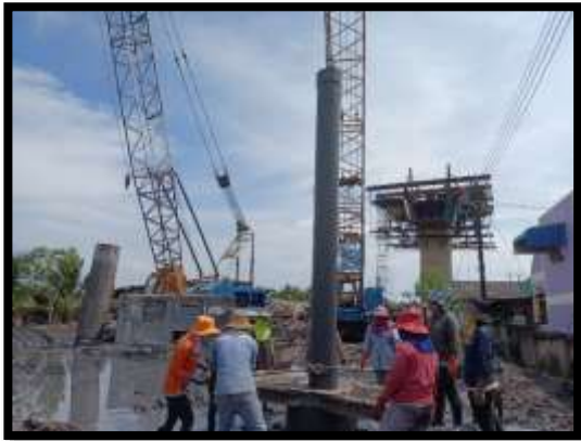
ภาพแสดงงานลงท่อ Timmy พร้อมเทคอนกรีตเสาเข็มเจาะ R8 งานบันไดสะพาน RT (ฝั่งแผ่นดิน)
