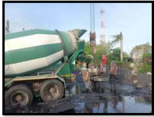
ภาพแสดงงานลงเหล็กและเทคอนกรีต โครงสร้างเสาเข็มเจาะ A1 งานทางลาดผู้พิการ LT (ฝั่งแผ่นดิน)
