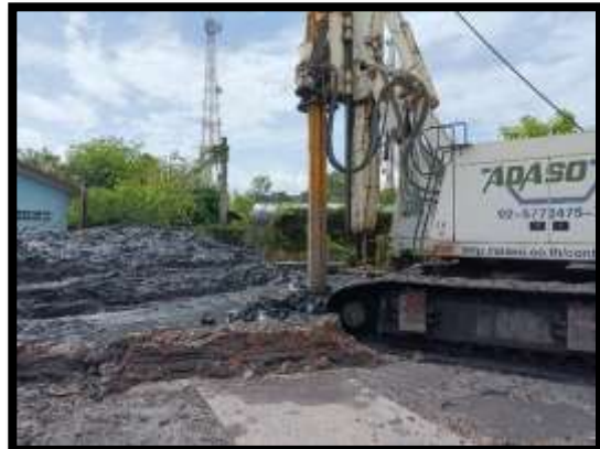
ภาพแสดงงานปักท่อ Casing และ เจาะเสาเข็ม A4 งานทางลาดผู้พิการ LT (ฝั่งแผ่นดิน)
