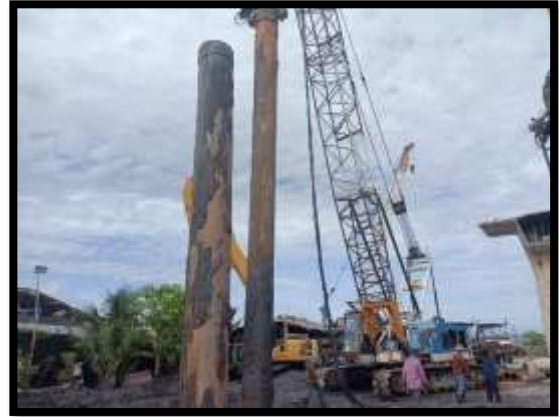
ภาพแสดงงานปักท่อ Casing งานเสาเข็มเจาะ A1 งานทางลาดผู้พิการ LT (ฝังแผ่นดิน)
