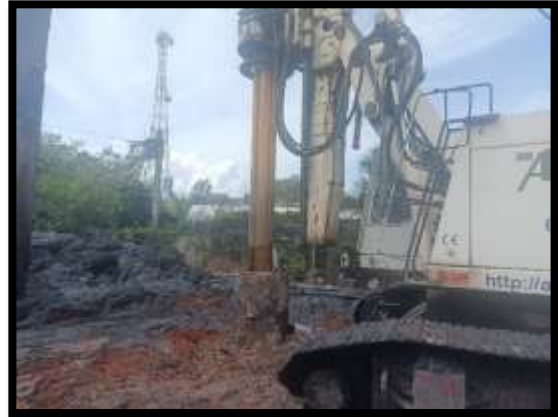
ภาพแสดงงานเจาะเสาเข็ม A5 งานทางลาดผู้พิการ LT (ฝั่งแผ่นดิน)
