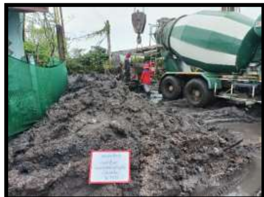
ภาพแสดงงานเทคอนกรีตเสาเข็มเจาะ A4 งานทางลาดผู้พิการ LT (ฝั่งแผ่นดิน)
