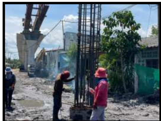
ภาพแสดงงานลงเหล็กโครงสร้างเสาเข็มเจาะ R8 งานบันไดสะพาน RT (ฝั่งแผ่นดิน)
