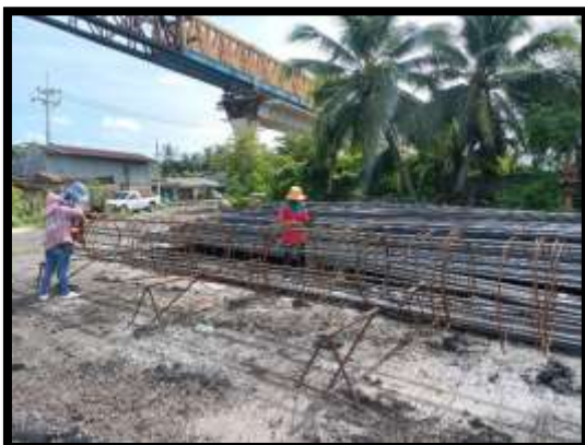
ภาพแสดงงานผูกเหล็ก และ ลงเหล็กโครงสร้างเสาเข็มเจาะ R7 งานบันไดสะพาน RT (ฝั่งแผ่นดิน)
