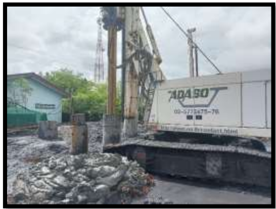
ภาพแสดงงานเจาะเสาเข็ม A2 งานทางลาดผู้พิการ LT (ฝั่งแผ่นดิน)
