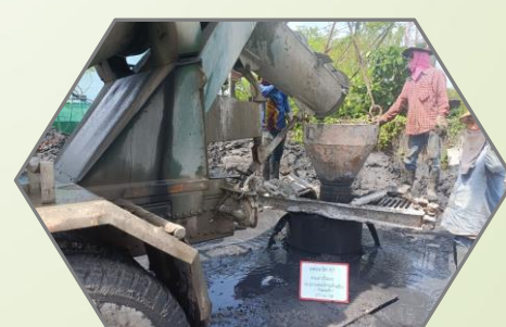
งานหล่อคอนกรีตเสาเข็มเจาะทางลาดคนพิการ
