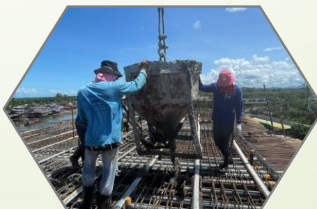
งานหล่อคอนกรีตส่วนหัวด้านบน P9
