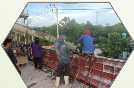
งานหล่อคอนกรีตราวกันตัก
