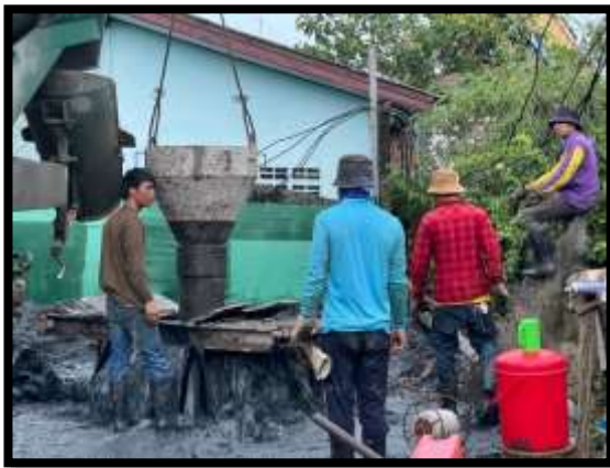
ภาพแสดงงานลงเทคอนกรีตเส้าเข็มเจาะ A๘ งานทางลาดผู้พิการ LT (ฝั่งแผ่นดิน)
