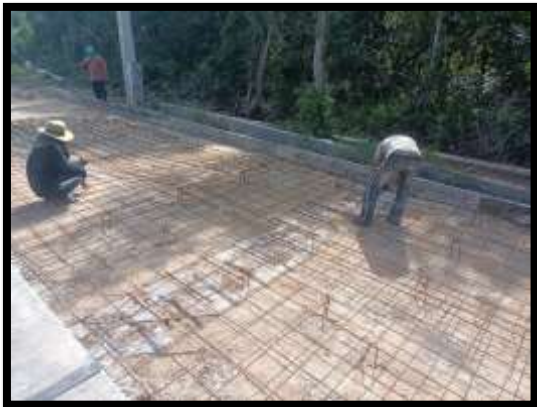
ภาพแสดงงานผูกเหล็กงานถนน Sta.๐+๓๕๘ ถึงSta.๐+๕๐๐ RT
