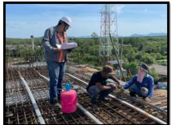
ภาพแสดงงานวางท่อลวดอัดแรงตามขวาง Pier Head Segment P๙
