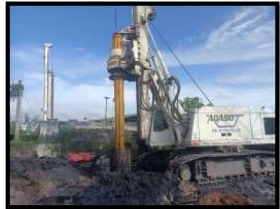
ภาพแสดงงานเจาะเสาเข็ม Ab งานทางลาดผู้พิการ LT (ฝั่งแผ่นดิน)
