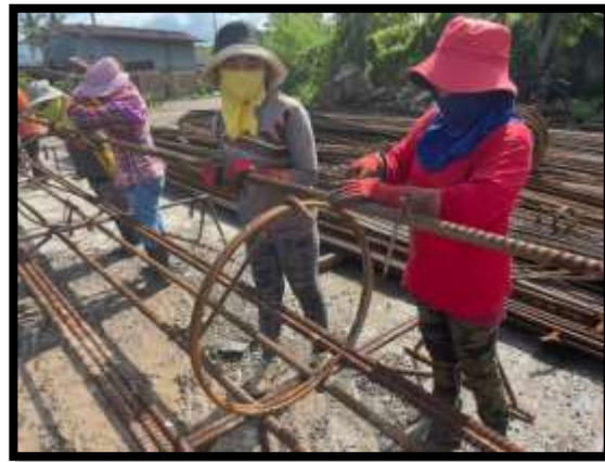
ภาพแสดงงานผูกเหล็กเสาเข็มเจาะ A๘ งานทางลาดผู้พิการ LT (ฝั่งแผ่นดิน)
