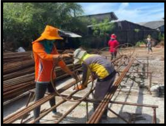
ภาพแสดงงานผูกเหล็กเสาเข็มเจาะ A๗ งานทางลาดผู้พิการ LT (ฝั่งแผ่นดิน)
