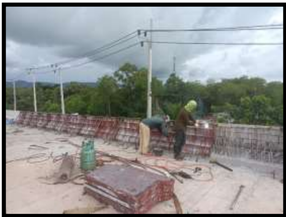
ภาพแสดงงานเทคอนกรีตฐานราวกันตก
