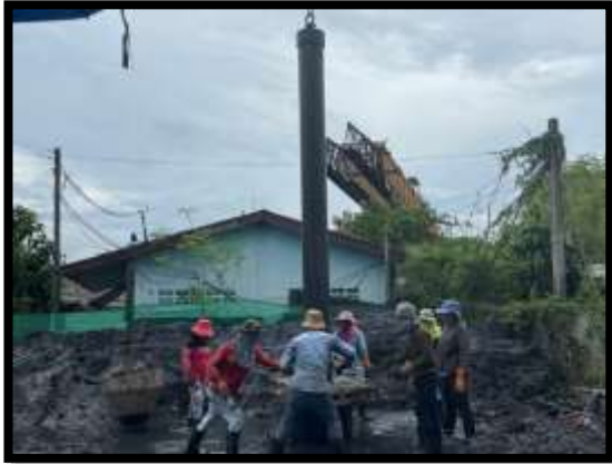
ภาพแสดงงานหล่อ Timmy เสาค้ำเข็มเจาะ A๖ งานทางลาดผู้พิการ LT (ฝั่งแผ่นดิน)
