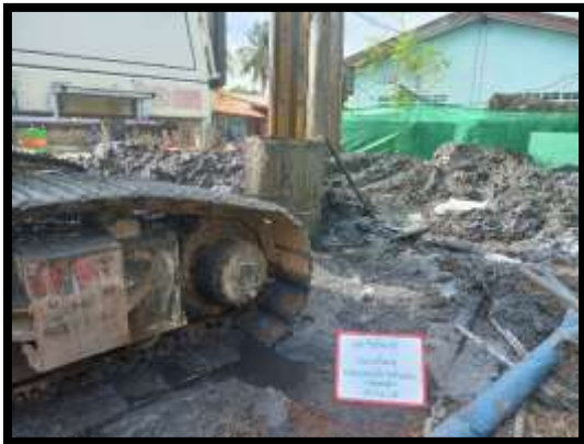
ภาพแสดงงานเจาะเสาเข็ม A๗ งานทางลาดผู้พิการ LT (ฝั่งแผ่นดิน)
