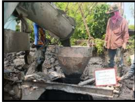
ภาพแสดงงานลงเทคอนกรีตเสาค้ำเข็มเจาะ A๗ งานทางลาดผู้พิการ LT (ฝั่งแผ่นดิน)
