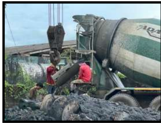
ภาพแสดงงานลงเทคอนกรีตเส้าเข็มเจาะ A๘ งานทางลาดผู้พิการ LT (ฝั่งแผ่นดิน)
