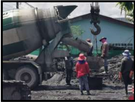
ภาพแสดงงานลงเทคอนกรีตเสาค้ำเข็มเจาะ A๗ งานทางลาดผู้พิการ LT (ฝั่งแผ่นดิน)
