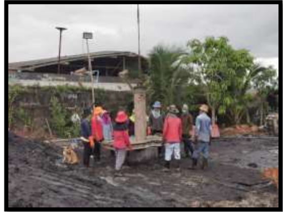
ภาพแสดงงานหล่อ Timmy เสาค้ำเข็มเจาะ A๖ งานทางลาดผู้พิการ LT (ฝั่งแผ่นดิน)
