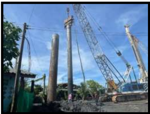
ภาพแสดงงานลงเทคอนกรีตเส้าเข็มเจาะ A๘ งานทางลาดผู้พิการ LT (ฝั่งแผ่นดิน)
