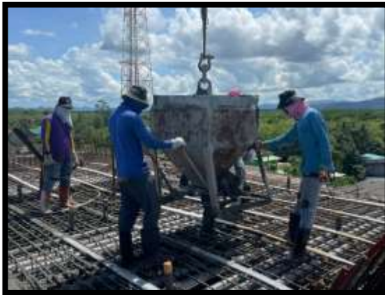
ภาพแสดงงานเทคอนกรีต Pier Head Segment P๙
