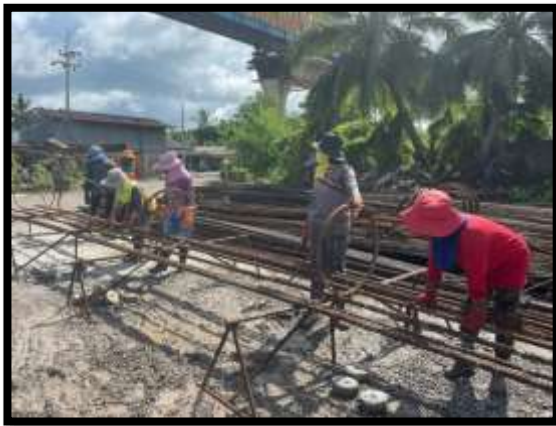
ภาพแสดงงานผูกเหล็กเสาเข็มเจาะ A๘ งานทางลาดผู้พิการ LT (ฝั่งแผ่นดิน)
