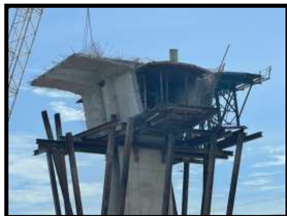
ภาพแสดงงานรื้อแบบ Pier Head Segment P๙
