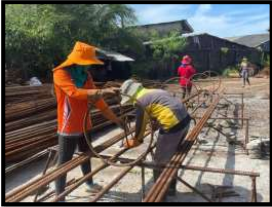
ภาพแสดงงานผูกเหล็กเสาเข็มเจาะ Ab งานทางลาดผู้พิการ LT (ฝั่งแผ่นดิน)
