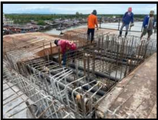
ภาพแสดงงานวางท่อลวดอัดแรงตามขวาง Pier Head Segment P๙
