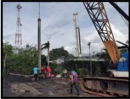
ภาพแสดงงานหล่อ Timmy เส้าเข็มเจาะ A๘ งานทางลาดผู้พิการ LT (ฝั่งแผ่นดิน)
