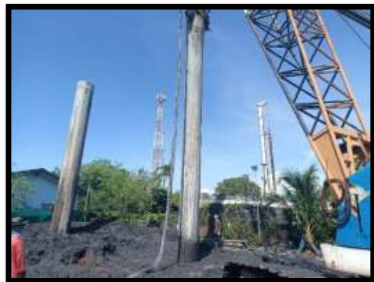
ภาพแสดงงานปักท่อ Casing งานเสาค้ำเข็มเจาะ A๖ งานทางลาดผู้พิการ LT (ฝั่งแผ่นดิน)
