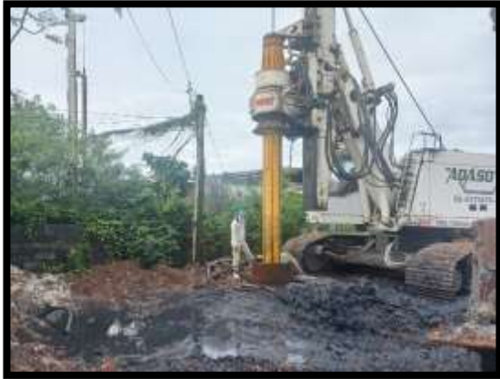
ภาพแสดงงานเจาะเสาเข็ม A๘ งานทางลาดผู้พิการ LT (ฝั่งแผ่นดิน)
