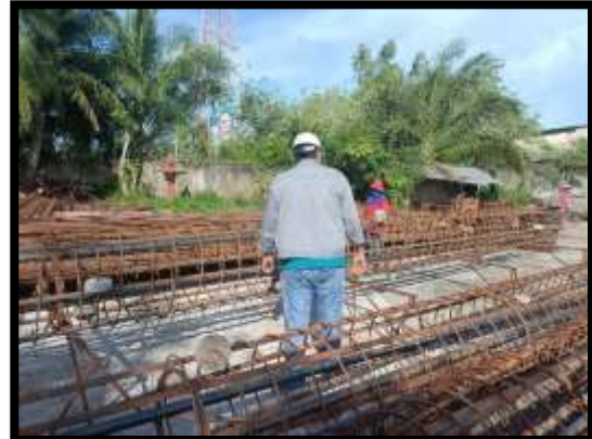
ภาพแสดงงานผูกเหล็กเสาเข็มเจาะ Ab งานทางลาดผู้พิการ LT (ฝั่งแผ่นดิน)
