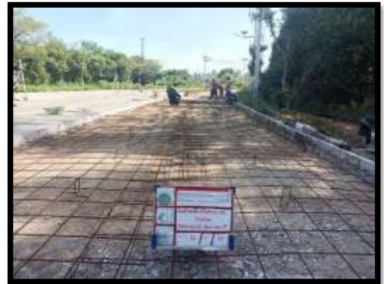
ภาพแสดงงานผูกเหล็กงานถนน Sta.๐+๓๕๘ ถึงSta.๐+๕๐๐ RT
