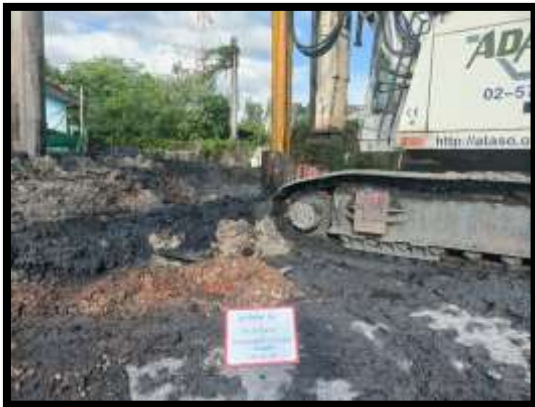
ภาพแสดงงานเจาะเสาเข็ม Ab งานทางลาดผู้พิการ LT (ฝั่งแผ่นดิน)
