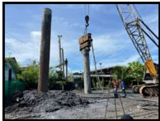
ภาพแสดงงานปักท่อ Casing งานเส้าเข็มเจาะ A๗ งานทางลาดผู้พิการ LT (ฝั่งแผ่นดิน)
