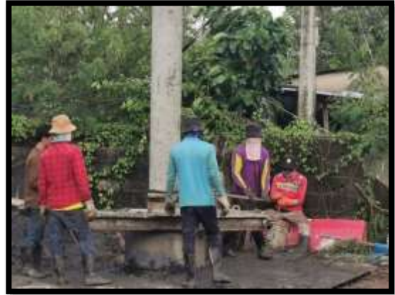
ภาพแสดงงานหล่อ Timmy เส้าเข็มเจาะ A๘ งานทางลาดผู้พิการ LT (ฝั่งแผ่นดิน)
