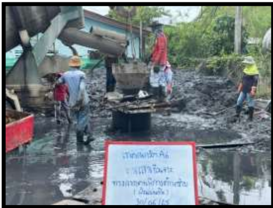
ภาพแสดงงานลงเทคอนกรีตเสาค้ำเข็มเจาะ A๖ งานทางลาดผู้พิการ LT (ฝั่งแผ่นดิน)
