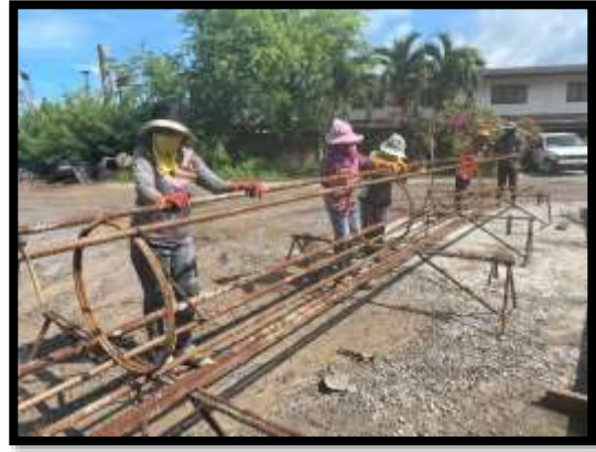
ภาพแสดงงานผูกเหล็กเสาเข็มเจาะ A๗ งานทางลาดผู้พิการ LT (ฝั่งแผ่นดิน)
