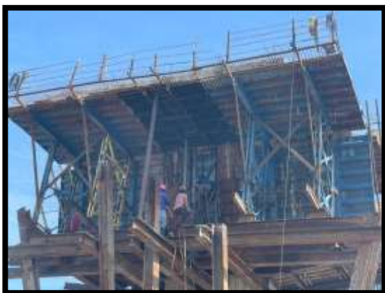
ภาพแสดงงานรื้อแบบ Pier Head Segment P๙
