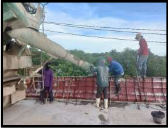
ภาพแสดงงานเทคอนกรีตราวกันตอก
