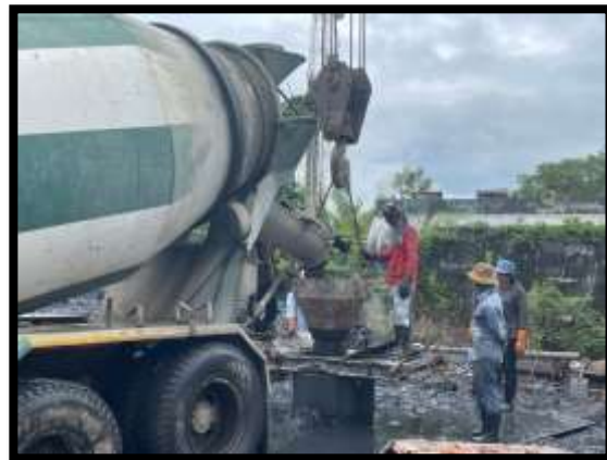
ภาพแสดงงานลงเทคอนกรีตเสาค้ำเข็มเจาะ A๖ งานทางลาดผู้พิการ LT (ฝั่งแผ่นดิน)
