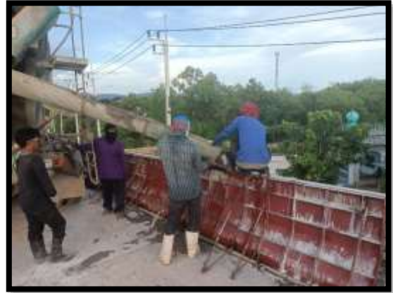
ภาพแสดงงานเทคอนกรีตราวกันตอก
