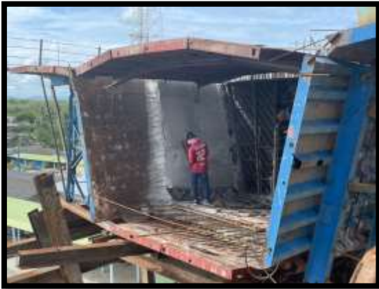
ภาพแสดงงานติดตั้งแบบ Pier Head Segment P๙
