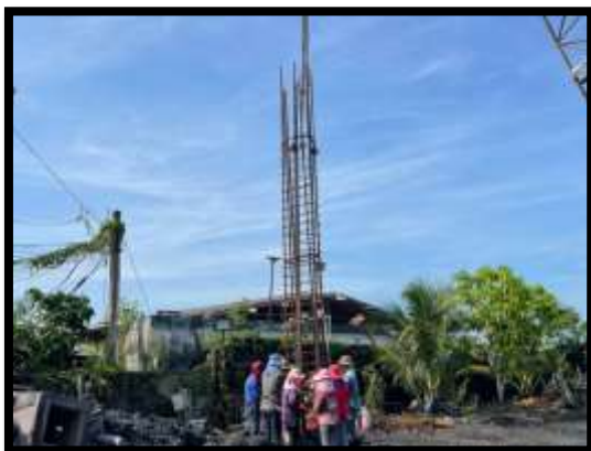
ภาพแสดงงานลงเหล็กโครงสร้างเสาเข็มเจาะ A๗ งานทางลาดผู้พิการ LT (ฝั่งแผ่นดิน)
