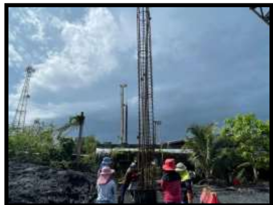
ภาพแสดงงานลงเหล็กโครงสร้างเสาเข็มเจาะ Ab งานทางลาดผู้พิการ LT (ฝั่งแผ่นดิน)
