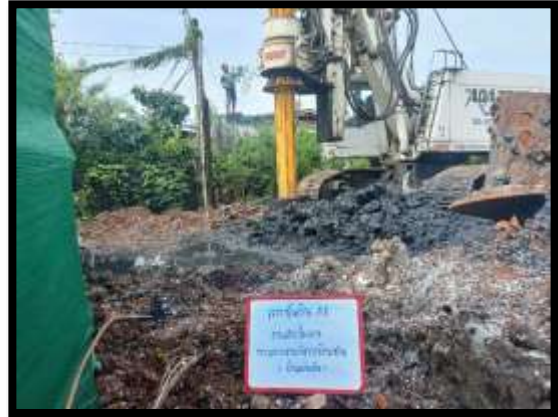
ภาพแสดงงานเจาะเสาเข็ม A๘ งานทางลาดผู้พิการ LT (ฝั่งแผ่นดิน)
