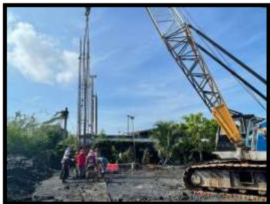
ภาพแสดงงานลงเหล็กโครงสร้างเสาเข็มเจาะ A๗ งานทางลาดผู้พิการ LT (ฝั่งแผ่นดิน)
