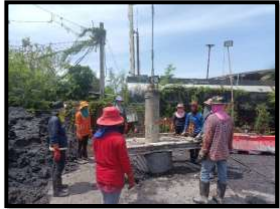
ภาพแสดงงานหล่อ Timmy เสาค้ำเข็มเจาะ A๗ งานทางลาดผู้พิการ LT (ฝั่งแผ่นดิน)
