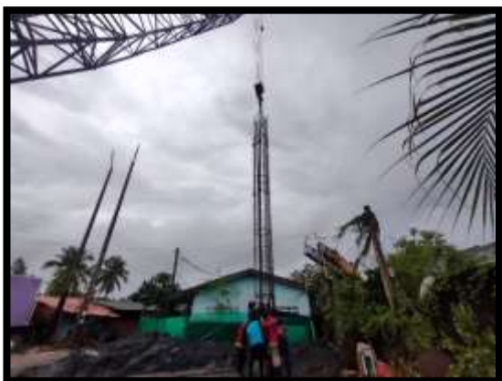
ภาพแสดงงานลงเหล็กโครงสร้างเสาเข็มเจาะ A๘ งานทางลาดผู้พิการ LT (ฝั่งแผ่นดิน)
