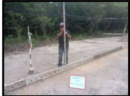
ภาพแสดงงานตรวจสอบระดับหลังแบบ และระดับชั้นทรายหยาบ Sta.๐+๓๕๘ ถึงSta.๐+๕๐๐ RT
