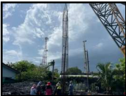
ภาพแสดงงานลงเหล็กโครงสร้างเสาเข็มเจาะ Ab งานทางลาดผู้พิการ LT (ฝั่งแผ่นดิน)
