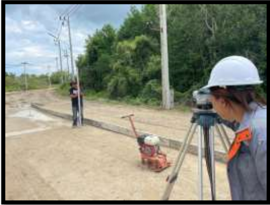
ภาพแสดงงานตรวจสอบระดับหลังแบบ และระดับชั้นทรายหยาบ Sta.๐+๓๕๘ ถึงSta.๐+๕๐๐ RT
