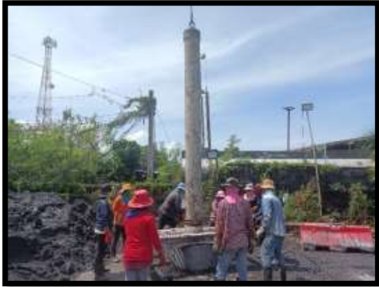
ภาพแสดงงานหล่อ Timmy เสาค้ำเข็มเจาะ A๗ งานทางลาดผู้พิการ LT (ฝั่งแผ่นดิน)
