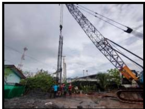
ภาพแสดงงานลงเหล็กโครงสร้างเสาเข็มเจาะ A๘ งานทางลาดผู้พิการ LT (ฝั่งแผ่นดิน)
