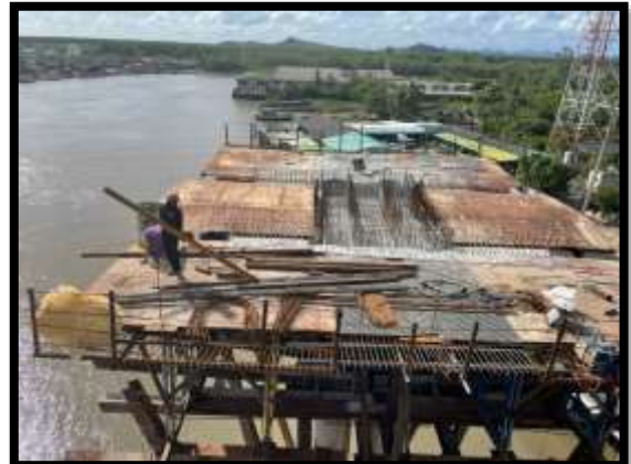
ภาพแสดงงานติดตั้งแบบ Pier Head Segment P๙
