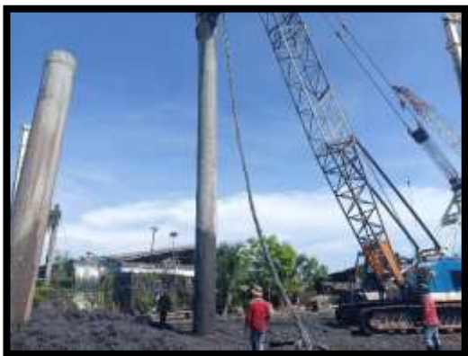
ภาพแสดงงานลงเทคอนกรีตเสาค้ำเข็มเจาะ A๗ งานทางลาดผู้พิการ LT (ฝั่งแผ่นดิน)
