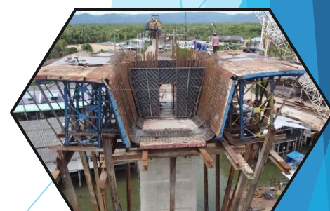
งานเข้าแบบและผูกเหล็ก Pier Head Segment P9
