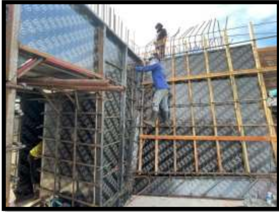
ภาพแสดงงานเข้าแบบ Pier Head Segment P๙
