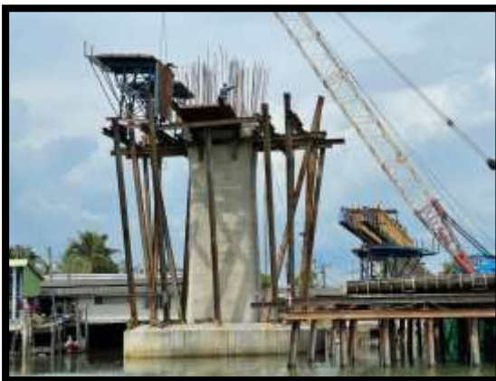
ภาพแสดงงานติดตั้งแบบ Pier Head Segment P๘
