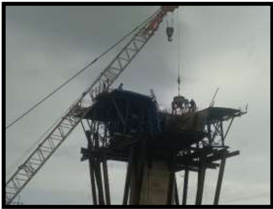
ภาพแสดงงานเทคอนกรีต Pier Head Segment P๙ ครั้งที่ ๒ และ ครั้งที่ ๓
