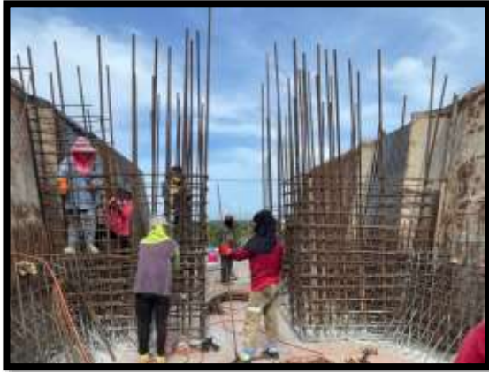
ภาพแสดงงานผูกเหล็ก Pier Head Segment P๙
