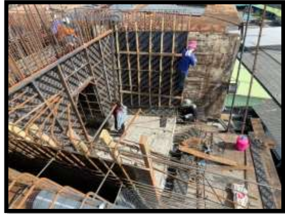
ภาพแสดงงานเข้าแบบ Pier Head Segment P๙
