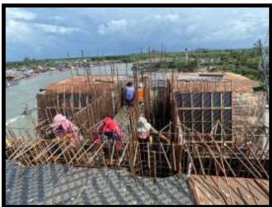
ภาพแสดงงานผูกเหล็ก Pier Head Segment P๙
