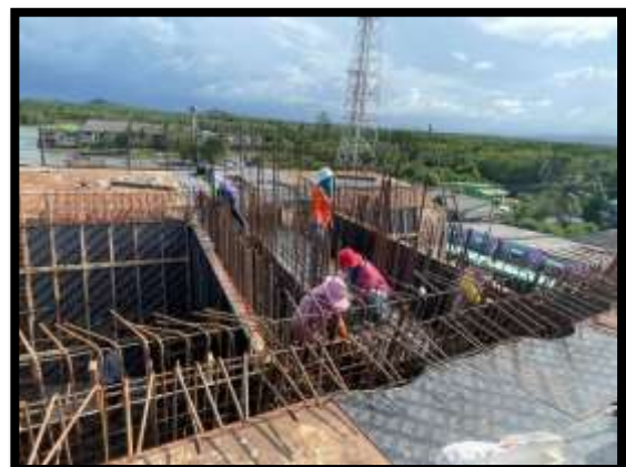
ภาพแสดงงานผูกเหล็ก Pier Head Segment P๙
