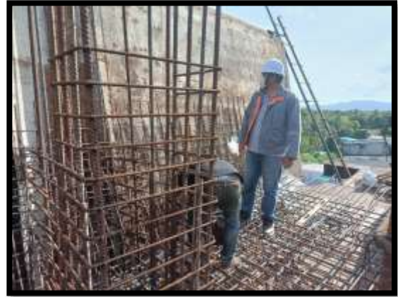
ภาพแสดงงานผูกเหล็ก Pier Head Segment P๙
