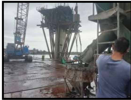
ภาพแสดงงานเทคอนกรีต Pier Head Segment P๙ ครั้งที่ ๒ และ ครั้งที่ ๓
