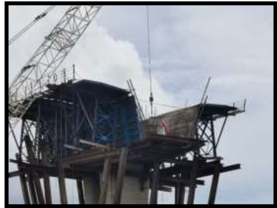
ภาพแสดงงานเทคอนกรีต Pier Head Segment P๙ ครั้งที่ ๑
