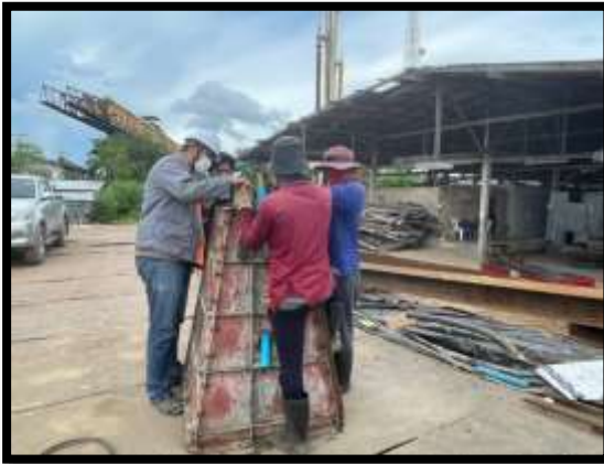
ภาพแสดงงานเข้าแบบ และเทคอนกรีตงานฐานเสาไฟฟ้าคอนกรีต
