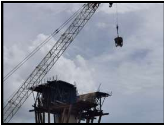
ภาพแสดงงานเทคอนกรีต Pier Head Segment P๙ ครั้งที่ ๑
