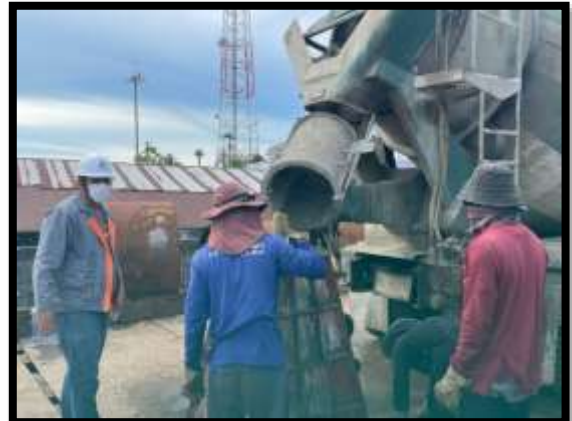
ภาพแสดงงานเข้าแบบ และเทคอนกรีตงานฐานเสาไฟฟ้าคอนกรีต
