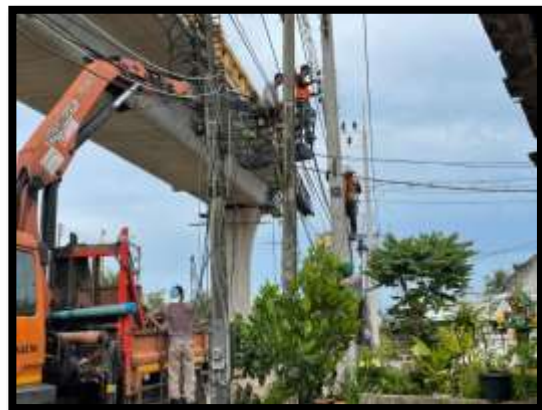
ภาพแสดงงานเปลี่ยนหม้อแปลงไฟฟ้า โดยเจ้าของหน่วยงาน
