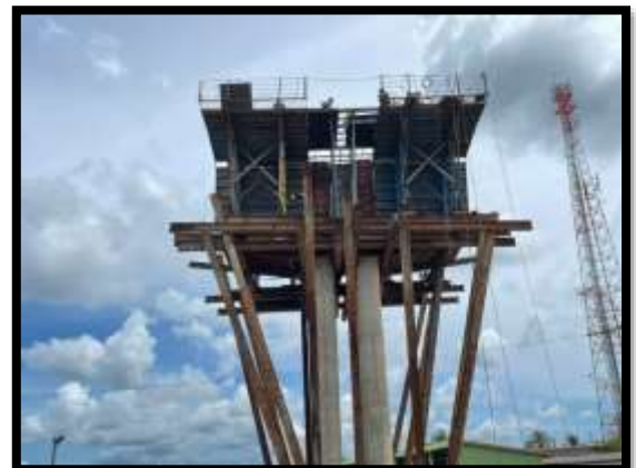
ภาพแสดงงานติดตั้งแบบ Pier Head Segment P๘
