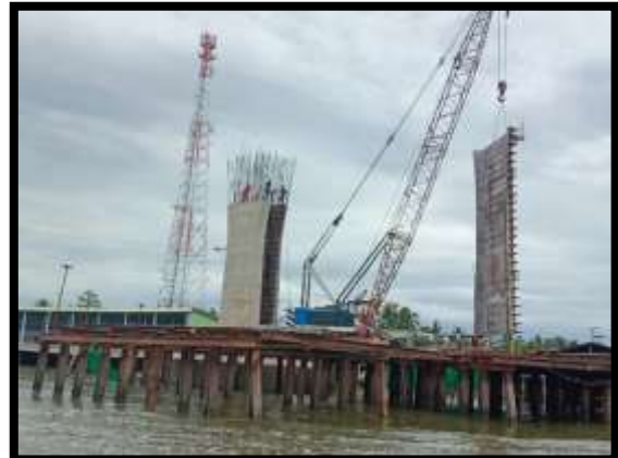
ภาพแสดงงานรื้อแบบโครงสร้างเสาตอม่อ P๙
