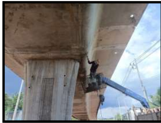
ภาพแสดงงานตบแต่งรอยต่อ Box Segment ช่วง P๒ ถึง P๓
