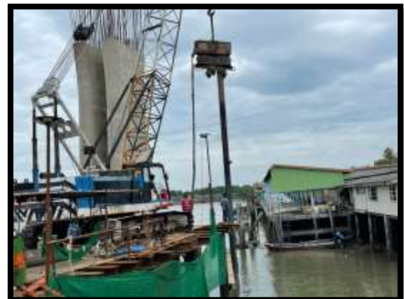
ภาพแสดงงานปักเสา H-Beam เตรียมติดตั้งนั่งร้าน Pier P๙
