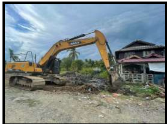
ภาพแสดงงานกรุยทางทางป่า งานถนน Sta.๒+๑๐๐ ถึง Sta.๒+๗๕๐ (ฝั่งเกาะ)
