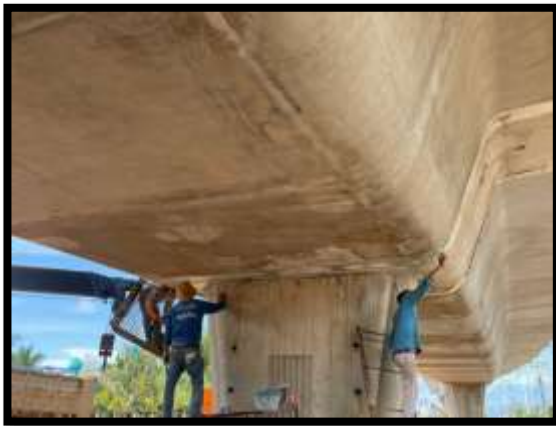
ภาพแสดงงานตบแต่งรอยต่อ Box Segment ช่วง P๒ ถึง P๓
