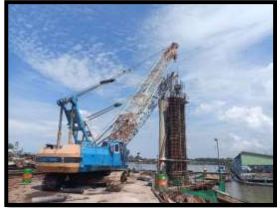
ภาพแสดงงานเทคอนกรีตโครงสร้างเสาตอม่อ P๙ ต้นที่ ๒
