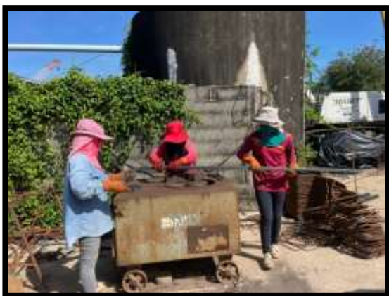
ภาพแสดงงานตัดและตัดเหล็กฐานเสาไฟฟ้าคอนกรีต
