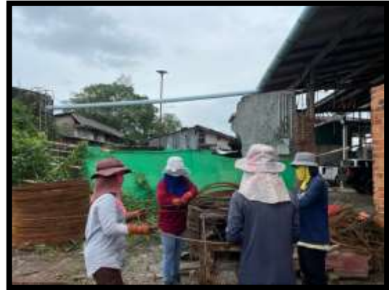
ภาพแสดงงานตัดและตัดเหล็กโครงสร้างเสาเข็มเจาะ P๑๐
