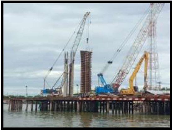
ภาพแสดงงานรื้อแบบโครงสร้างเสาตอม่อ P๙
