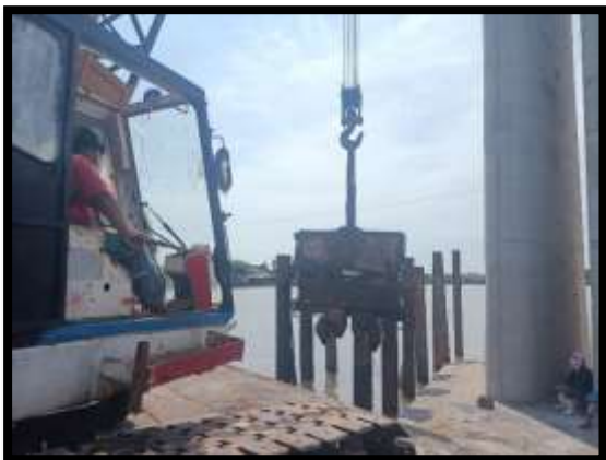
ภาพแสดงงานปักเสา H-Beam เตรียมติดตั้งนั่งร้าน Pier P๙
