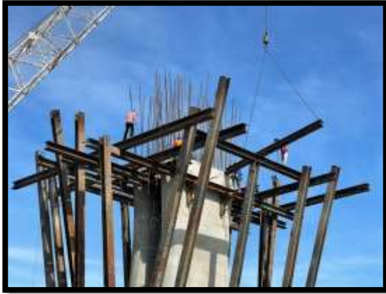
ภาพแสดงงานเตรียมติดตั้งนั่งร้านรับ Pier P๙
