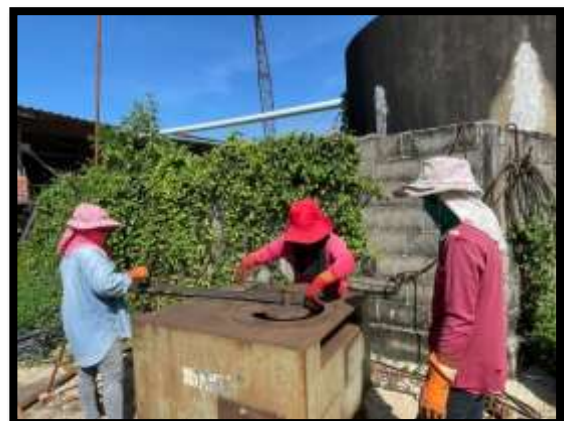
ภาพแสดงงานตัดและตัดเหล็กฐานเสาไฟฟ้าคอนกรีต
