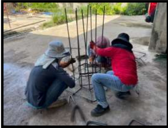
ภาพแสดงงานผูกเหล็กฐานเสาไฟฟ้าคอนกรีต
