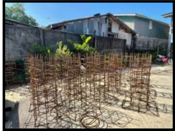
ภาพแสดงงานผูกเหล็กฐานเสาไฟฟ้าคอนกรีต
