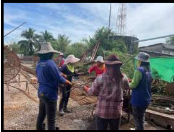
ภาพแสดงงานตัดและตัดเหล็กโครงสร้างเสาเข็มเจาะ P๑๐
