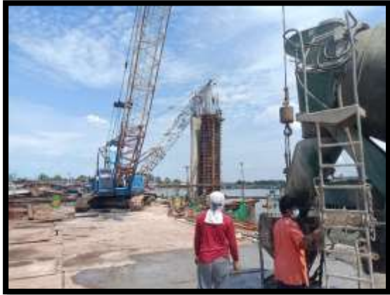
ภาพแสดงงานเทคอนกรีตโครงสร้างเสาตอม่อ P๙ ต้นที่ ๒
