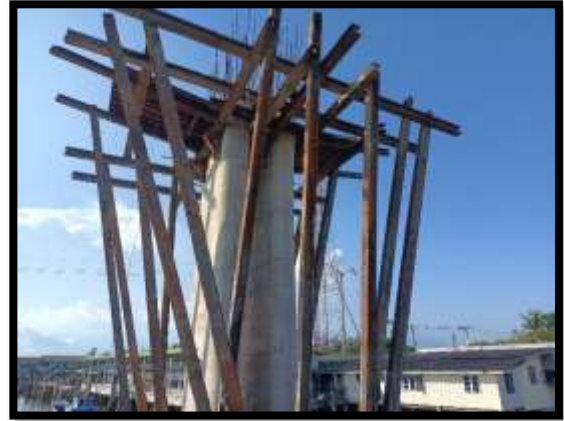
ภาพแสดงงานเตรียมติดตั้งนั่งร้านรับ Pier P๙
