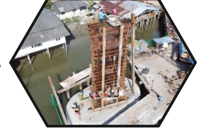
เทคอนกรีตโครงสร้างเสาตอม่อ P9
