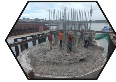
เทคอนกรีตฐานราก P9
