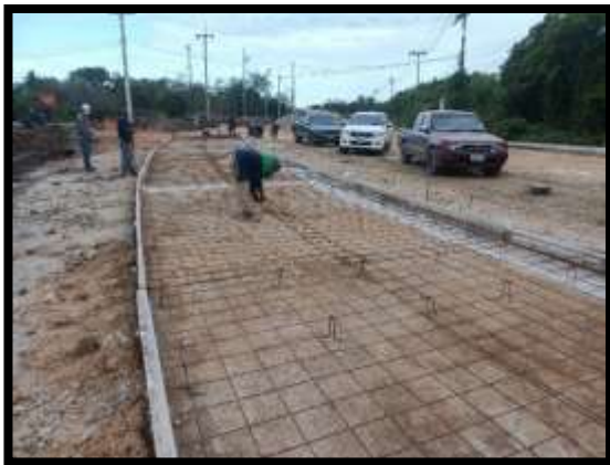
ภาพแสดงงานติดตั้งเหล็ก Wire Mesh งานถนน Sta.๐+๔๗๐ ถึง Sta.๐+๕๐๐ LT (ส่วนขยาย ไหล่ทาง)
