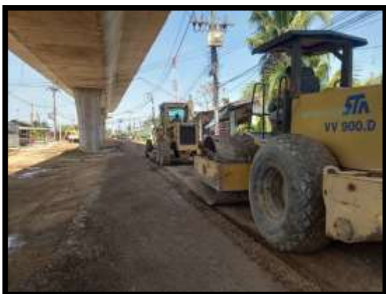
ภาพแสดงงานปรับเกลี่ยและบดอัดชั้นรองพื้นทาง (หนา ๐.๒๐ ม.) งานถนน Sta.๐+๕๐๐ ถึง Sta.๐+๗๐๐ RT
