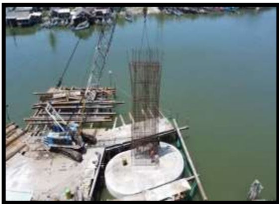
ภาพแสดงงานติดตั้งเหล็กโครงสร้างเสาตอม่อ P๔ ต้นที่ ๑
