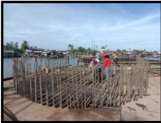
ภาพแสดงงานผูกเหล็กฐานราก งานเสาเข็มเจาะ P๙
