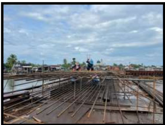
ภาพแสดงงานผูกเหล็กเสาดอม่อ P๑
