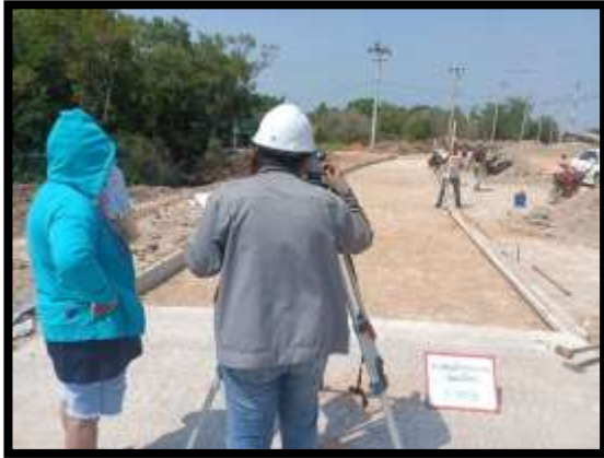
ภาพแสดงงานตรวจสอบระดับชั้นทรายหยาบและระดับแบบข้าง งานถนน Sta.๐+๔๗๐ ถึง Sta.๐+๕๐๐ LT (ส่วนขยาย ไหล่ทาง)
