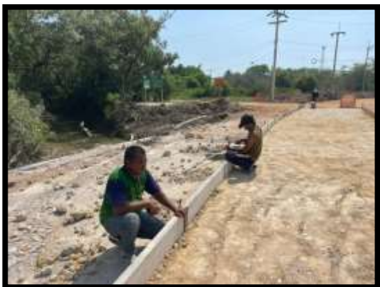
ภาพแสดงงานเข้าแบบและบดอัดชั้นทรายหยาบ งานถนน Sta.๐+๔๗๐ ถึง Sta.๐+๕๐๐ LT (ส่วนขยาย ไหล่ทาง)
