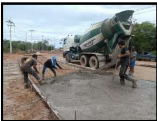
ภาพแสดงงานเทคอนกรีต งานถนน Sta.๐+๔๗๐ ถึง Sta.๐+๕๐๐ LT (ส่วนขยาย ไหล่ทาง)
