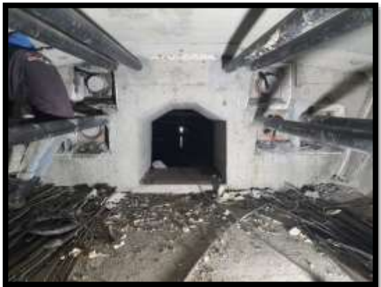
ภาพแสดงงานอัดฉีดปูน Grout ภายในท่อลวดอัดแรง ช่วง P๔ ถึง P๗
