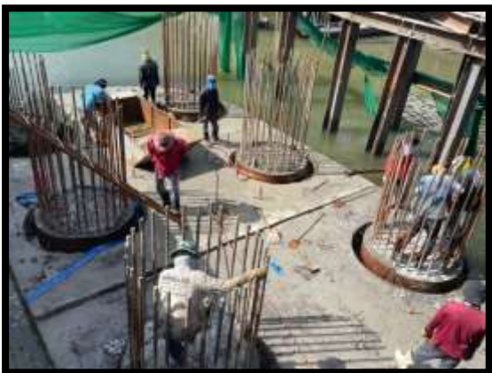
ภาพแสดงงานตัด ตกแต่ง งานเสาเข็มเจาะ P๔
