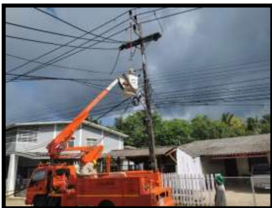
ภาพแสดงงานรื้อย้ายสายไฟฟ้าบริเวณโครงการ โดยเจ้าของหน่วยงาน
