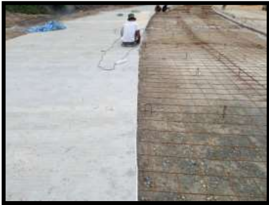
ภาพแสดงงานติดตั้งเหล็ก Wire Mesh งานถนน Sta.๐+๔๗๐ ถึง Sta.๐+๕๐๐ LT (ส่วนขยาย จาก CL)
