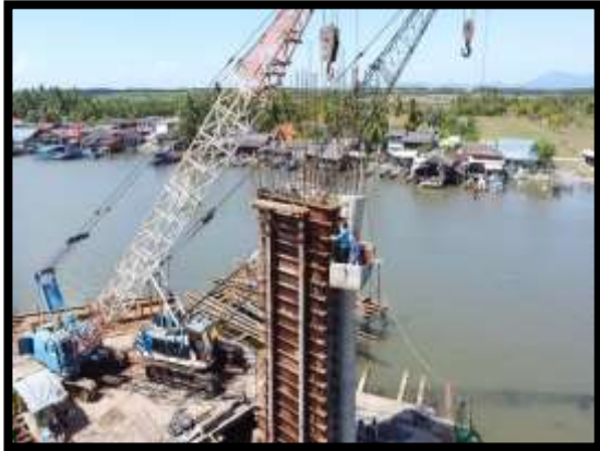
ภาพแสดงงานติดตั้งแบบโครงสร้างเสาตอม่อ P๙ ต้นที่ ๒
