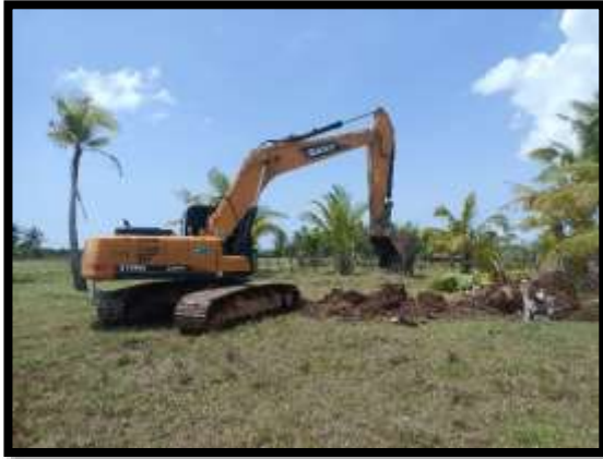
ภาพแสดงงานกรุยทางถางป่า งานถนน Sta.๑+๑๗๕ ถึง Sta.๒+๕๐๐ (ฝั่งเกาะ)
