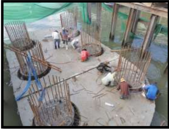
ภาพแสดงงานติดตั้งตะแกรงรอบเสาเข็ม งานเสาเข็มเจาะ P๙
