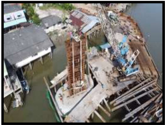
ภาพแสดงงานเทคอนกรีตโครงสร้างเสาตอม่อ P๙ ต้นที่ ๑
