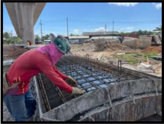
ภาพแสดงงานผูกเหล็ก Precast Skirt P๑๐
