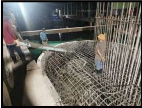
ภาพแสดงงานเทคอนกรีตฐานราก P๔
