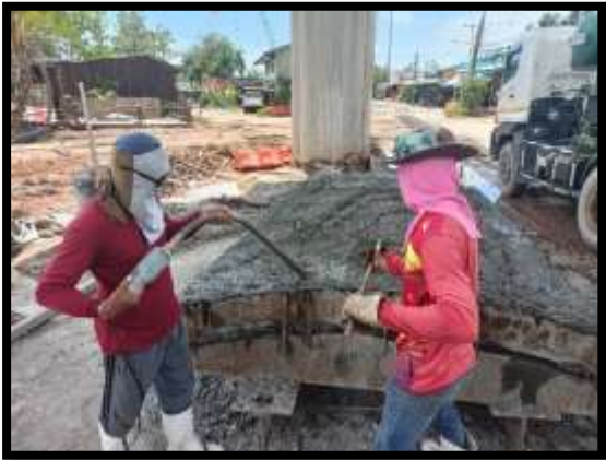
ภาพแสดงงานเทคอนกรีต Precast Skirt P๑๐
