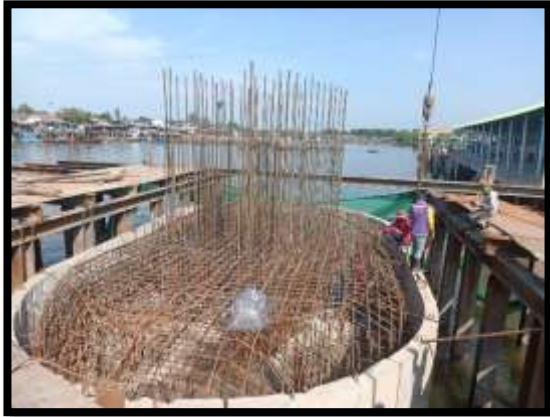
ภาพแสดงงานผูกเหล็กฐานราก P๔
