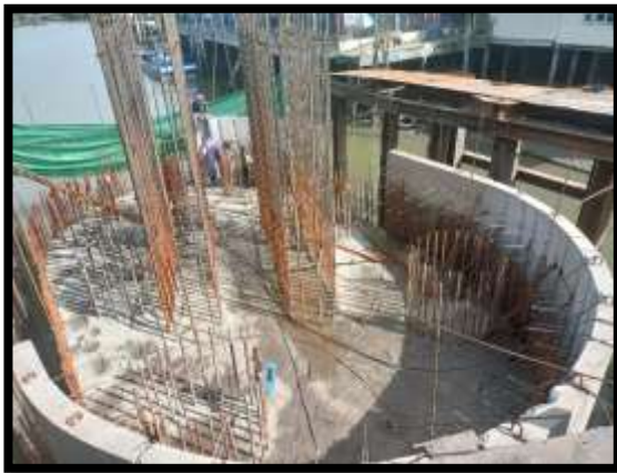
ภาพแสดงงานติดตั้ง Precast Skirt P๑
