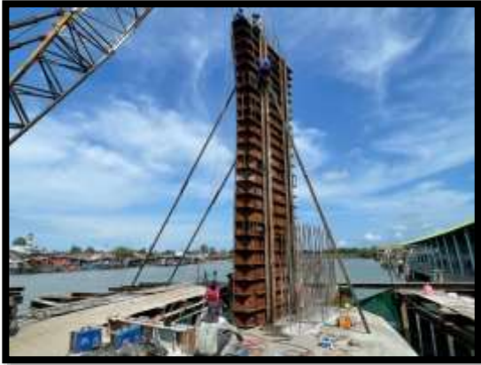
ภาพแสดงงานติดตั้งแบบโครงสร้างเสาตอม่อ P๙ ต้นที่ ๑
