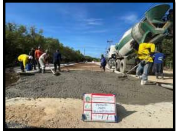
ภาพแสดงงานเทคอนกรีต งานถนน Sta.๐+๓๕๘ ถึง Sta.๐+๔๗๐ LT (ทางคู่ขนาน)
