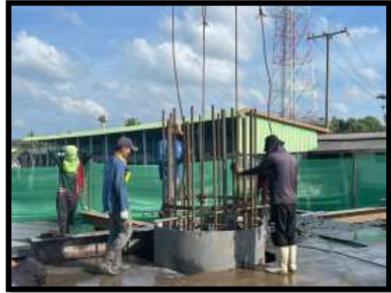
ภาพแสดงงานลงเหล็ก งานเสาเข็มเจาะ P๙ ต้นที่ ๒
