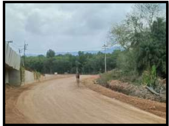
ภาพแสดงงานตรวจสอบระดับ ชั้นรองพื้นทาง ทางคู่ขนาน งานถนน Sta.๐+๕๒๕ ถึง Sta.๐+๗๐๐ LT
