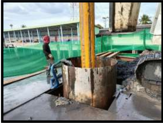
ภาพแสดงงานเจาะชั้นดิน งานเสาเข็มเจาะ P๙ ต้นที่ ๑
