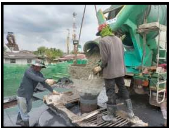
ภาพแสดงงานเทคอนกรีต งานเสาเข็มเจาะ P๙ ต้นที่ ๕
