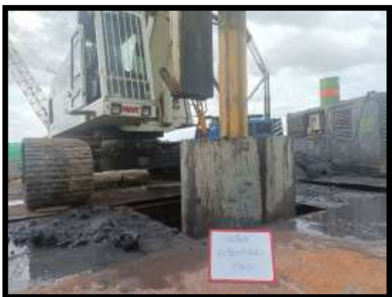
ภาพแสดงงานเจาะชั้นดิน งานเสาเข็มเจาะ P๙ ต้นที่ ๕
