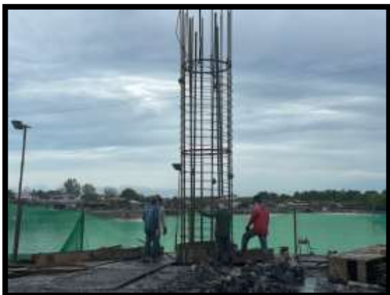
ภาพแสดงงานลงเหล็ก งานเสาเข็มเจาะ P๙ ต้นที่ ๑
