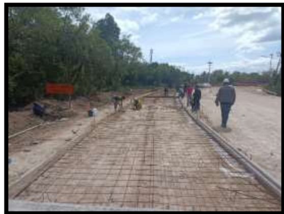
ภาพแสดงงานติดตั้ง Wire Mesh งานถนน Sta.๐+๓๕๘ ถึง Sta.๐+๔๗๐ LT (ทางคู่ขนาน)
