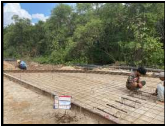
ภาพแสดงงานติดตั้ง Wire Mesh งานถนน (ช่วงวงเวียนกลับรถ) Sta.๐+๓๖๑ ถึง Sta.๐+๓๘๖ LT
