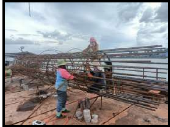
ภาพแสดงงานผูกเหล็กเสาเข็ม งานเสาเข็มเจาะ P๙ ต้นที่ ๕
