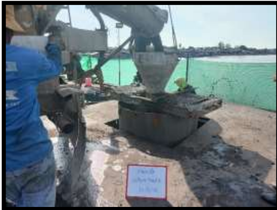
ภาพแสดงงานเทคอนกรีต งานเสาเข็มเจาะ P๙ ต้นที่ ๔
