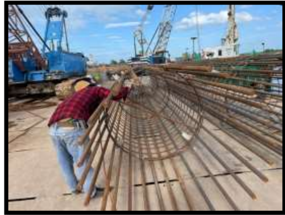
ภาพแสดงงานผูกเหล็กเสาเข็ม งานเสาเข็มเจาะ P๙ ต้นที่ ๑
