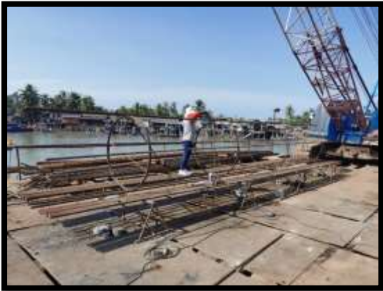
ภาพแสดงงานผูกเหล็กเสาเข็ม งานเสาเข็มเจาะ P๙ ต้นที่ ๒
