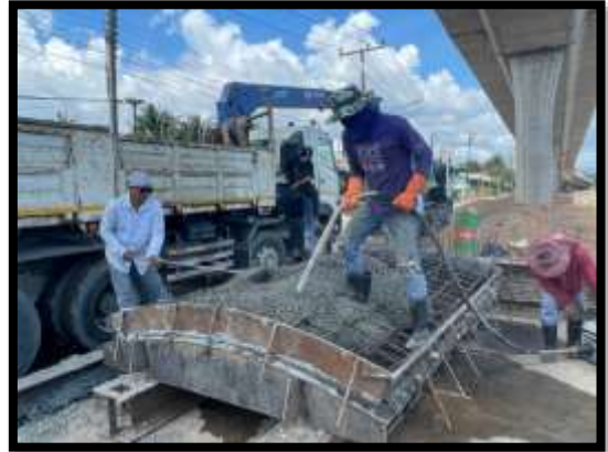
ภาพแสดงงานเทคอนกรีต แบบรองฐานราก , Precast Skirt P๙ และ P๑๐
