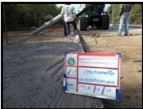
ภาพแสดงงานเทคอนกรีต งานถนน (ช่วงวงเวียนกลับรถ) Sta.๐+๓๖๑ ถึง Sta.๐+๓๘๖ LT
