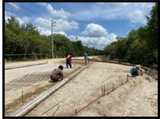
ภาพแสดงงานเข้าแบบข้าง งานถนน (ช่วงวงเวียนกลับรถ) Sta.๐+๓๖๑ ถึง Sta.๐+๓๘๖ LT
