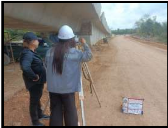
ภาพแสดงงานตรวจสอบระดับ ชั้นรองพื้นทาง ทางคู่ขนาน งานถนน Sta.๐+๕๒๕ ถึง Sta.๐+๗๐๐ LT
