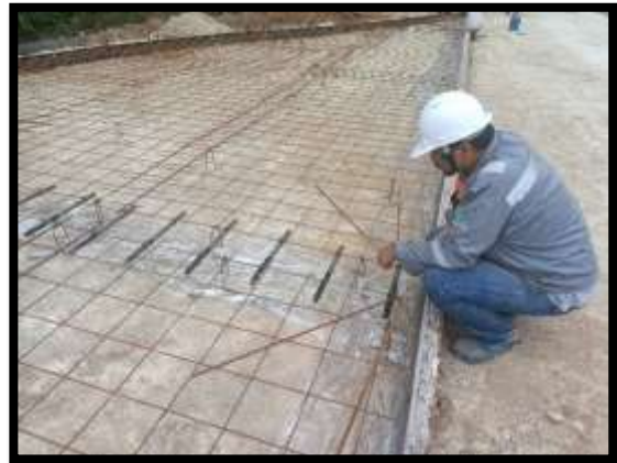
ภาพแสดงงานติดตั้ง Wire Mesh งานถนน (ช่วงวงเวียนกลับรถ) Sta.๐+๓๖๑ ถึง Sta.๐+๓๘๖ LT
