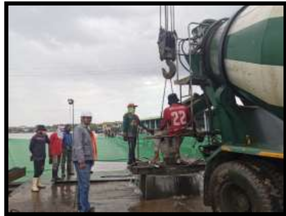
ภาพแสดงงานเทคอนกรีต งานเสาเข็มเจาะ P๙ ต้นที่ ๒
