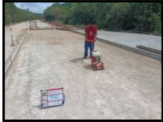
ภาพแสดงงานบดอัดชั้นทรายหยาบ งานถนน Sta.๐+๓๕๘ ถึง Sta.๐+๓๙๐ LT (ทางคู่ขนาน)
