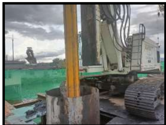
ภาพแสดงงานเจาะชั้นดิน งานเสาเข็มเจาะ P๙ ต้นที่ ๕
