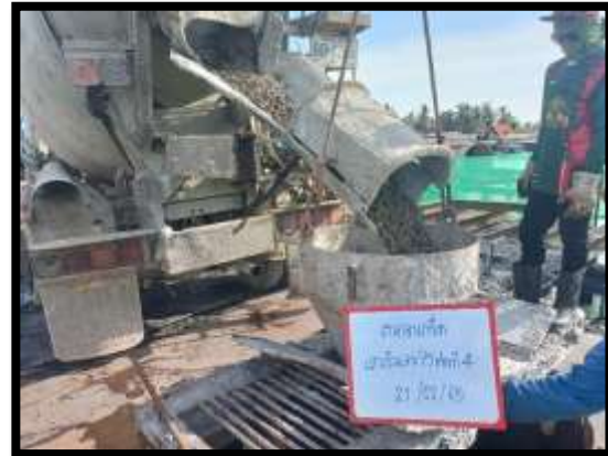
ภาพแสดงงานเทคอนกรีต งานเสาเข็มเจาะ P๙ ต้นที่ ๔
