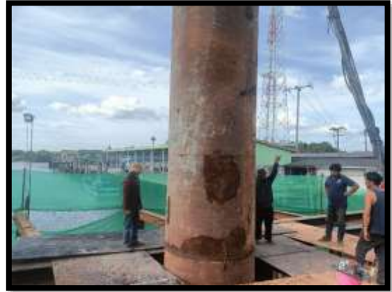
ภาพแสดงงานติดตั้ง Casing งานเสาเข็มเจาะ P๙ ต้นที่ ๒
