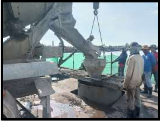
ภาพแสดงงานเทคอนกรีต งานเสาเข็มเจาะ P๙ ต้นที่ ๑
