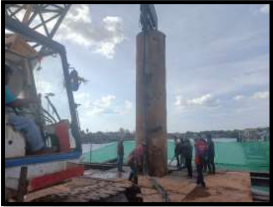
ภาพแสดงงานติดตั้ง Casing งานเสาเข็มเจาะ P๙ ต้นที่ ๒
