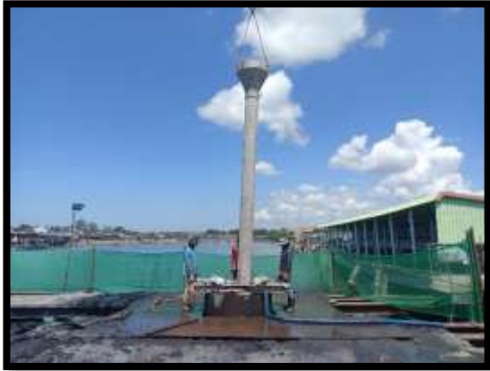
ภาพแสดงงานลงท่อ Timmy งานเสาเข็มเจาะ P๙ ต้นที่ ๔
