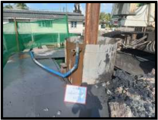
ภาพแสดงงานเจาะชั้นดิน งานเสาเข็มเจาะ P๙ ต้นที่ ๔
