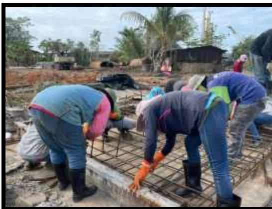
ภาพแสดงงานผูกเหล็ก แบบรองฐานราก , Precast Skirt P๙ และ P๑๐
