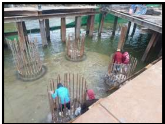
ภาพแสดงงานตัด ตกแต่ง งานเสาเข็มเจาะ P๙
