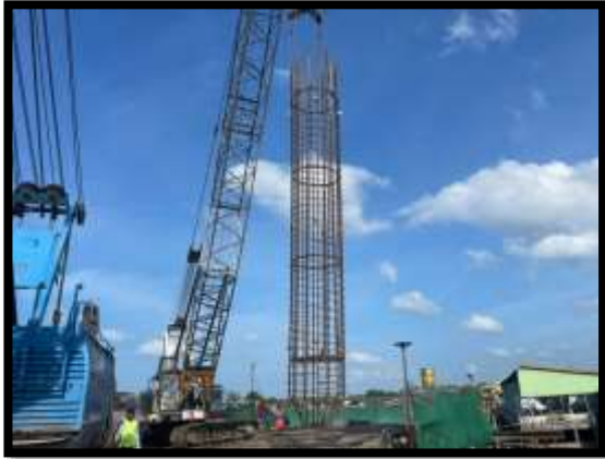
ภาพแสดงงานลงเหล็ก งานเสาเข็มเจาะ P๙ ต้นที่ ๒
