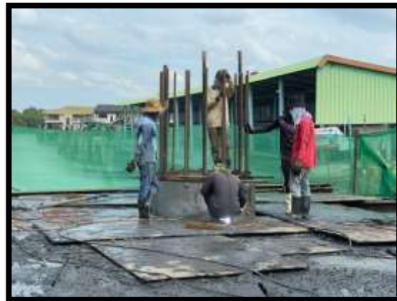
ภาพแสดงงานลงเหล็ก งานเสาเข็มเจาะ P๙ ต้นที่ ๕
