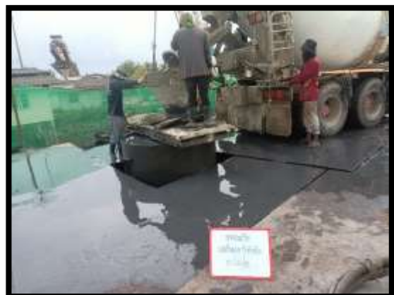
ภาพแสดงงานเทคอนกรีต งานเสาเข็มเจาะ P๙ ต้นที่ ๕
