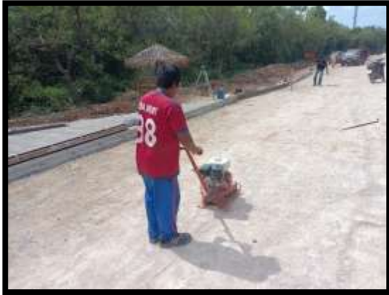
ภาพแสดงงานบดอัดชั้นทรายหยาบ งานถนน Sta.๐+๓๕๘ ถึง Sta.๐+๓๙๐ LT (ทางคู่ขนาน)
