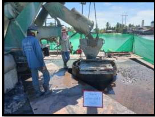
ภาพแสดงงานเทคอนกรีต งานเสาเข็มเจาะ P๙ ต้นที่ ๑
