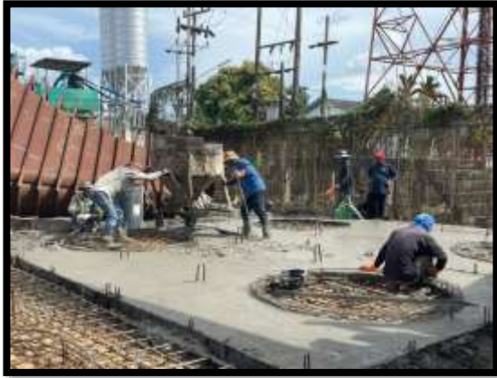
ภาพแสดงงานเทคอนกรีต แบบรองฐานราก , Precast Skirt P๙ และ P๑๐
