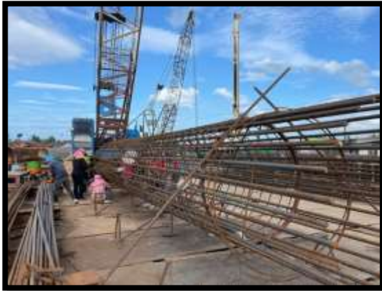
ภาพแสดงงานผูกเหล็กเสาเข็ม งานเสาเข็มเจาะ P๙ ต้นที่ ๑
