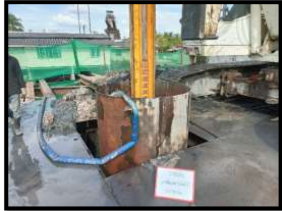
ภาพแสดงงานเจาะชั้นดิน งานเสาเข็มเจาะ P๙ ต้นที่ ๑
