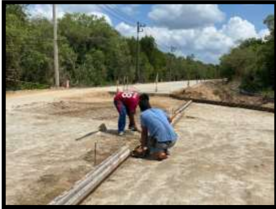
ภาพแสดงงานเข้าแบบข้าง งานถนน (ช่วงวงเวียนกลับรถ) Sta.๐+๓๖๑ ถึง Sta.๐+๓๘๖ LT
