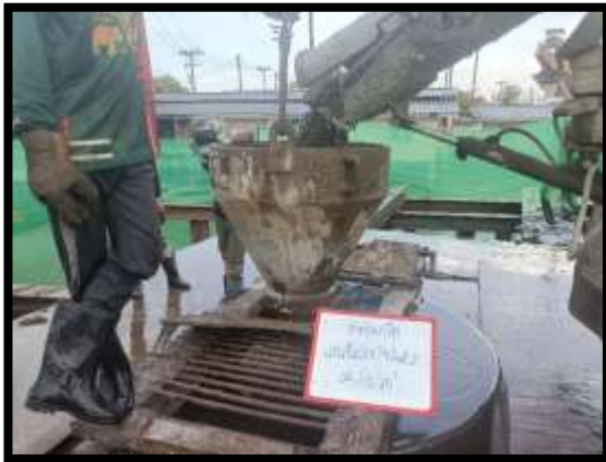
ภาพแสดงงานเทคอนกรีต งานเสาเข็มเจาะ P๙ ต้นที่ ๒
