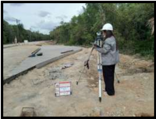
ภาพแสดงงานตรวจสอบชั้นทรายหยาบและระดับแบบข้าง งานถนน Sta.๐+๓๕๘ ถึง Sta.๐+๕๐๐ LT (ทางคู่ขนาน)
