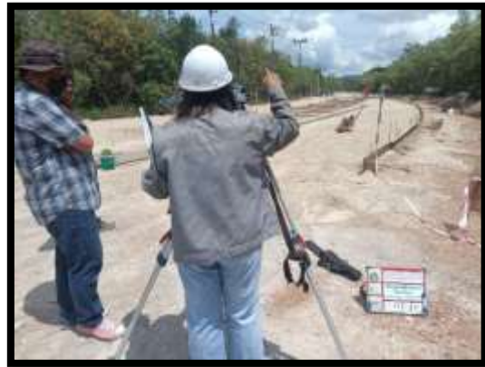
ภาพแสดงงานตรวจสอบชั้นทรายหยาบและระดับแบบข้าง งานถนน Sta.๐+๓๕๘ ถึง Sta.๐+๕๐๐ LT (ทางคู่ขนาน)
