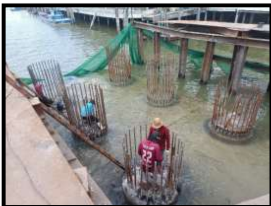
ภาพแสดงงานตัด ตกแต่ง งานเสาเข็มเจาะ P๙
