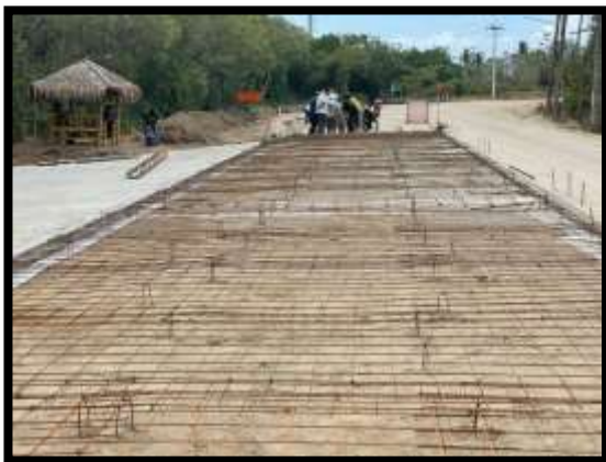
ภาพแสดงงานติดตั้ง Wire Mesh งานถนน Sta.๐+๓๕๘ ถึง Sta.๐+๔๗๐ LT (ทางคู่ขนาน)
