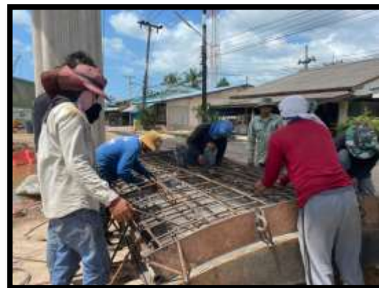
ภาพแสดงงานผูกเหล็ก แบบรองฐานราก , Precast Skirt P๙ และ P๑๐
