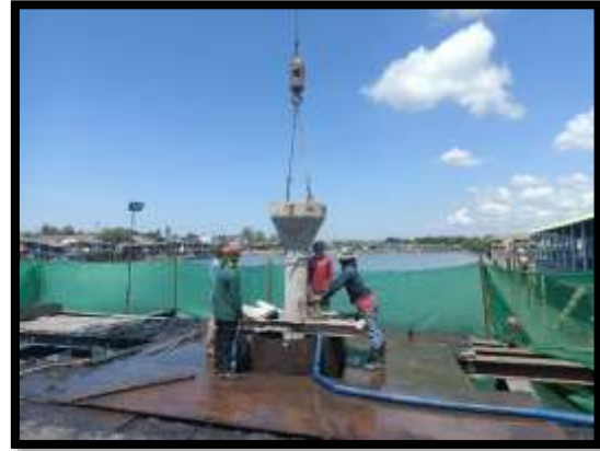
ภาพแสดงงานลงท่อ Timmy งานเสาเข็มเจาะ P๙ ต้นที่ ๔
