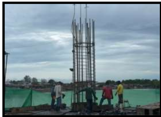
ภาพแสดงงานผูกเหล็กเสาเข็ม งานเสาเข็มเจาะ P๙ ต้นที่ ๑
