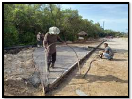
ภาพแสดงงานเทคอนกรีต งานถนน (ช่วงวงเวียนกลับรถ) Sta.๐+๓๖๑ ถึง Sta.๐+๓๘๖ LT
