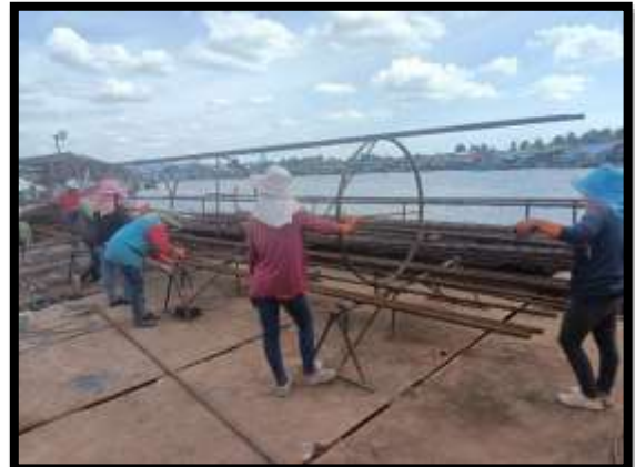
ภาพแสดงงานผูกเหล็กเสาเข็ม งานเสาเข็มเจาะ P๙ ต้นที่ ๒
