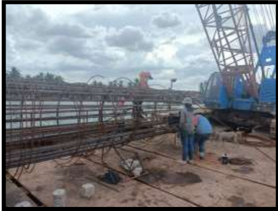
ภาพแสดงงานผูกเหล็กเสาเข็ม งานเสาเข็มเจาะ P๙ ต้นที่ ๕
