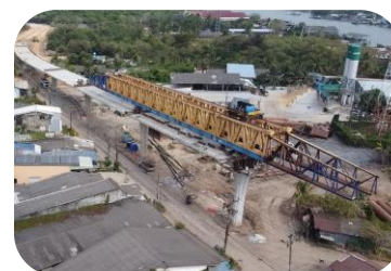
งานติดตั้ง Precast Box Segment (P6-P7)
