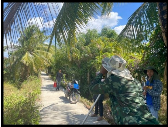
ภาพแสดงงานวางแนวเขตทาง งานถนน (ฝั่งเกาะ) จาก Sta.๑+๕๗๑.๖๙๔ ถึง Sta.๒+๗๕๐
