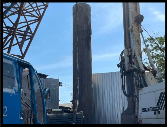
ภาพแสดงงานติดตั้ง Casing งานเสาเข็มเจาะ P๘ ต้นที่ ๕
