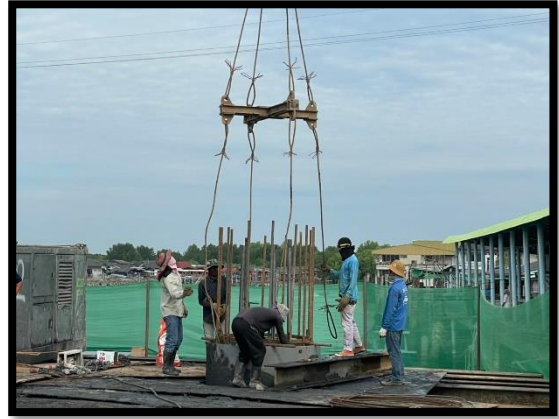
ภาพแสดงงานลงเหล็ก งานเสาเข็มเจาะ P๙ ต้นที่ ๖
