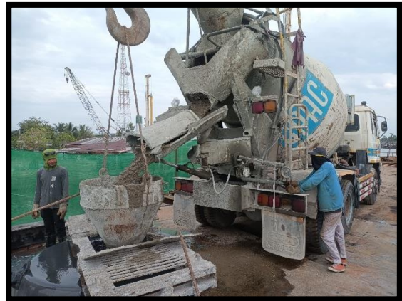
ภาพแสดงงานเทคอนกรีต งานเสาเข็มเจาะ P๙ ต้นที่ ๖
