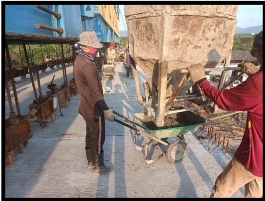
ภาพแสดงงานเทคอนกรีต Wet Joint Segment ช่วง P๖ ถึง P๗
