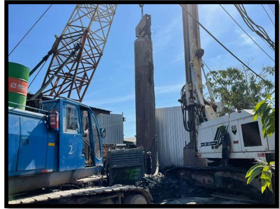
ภาพแสดงงานติดตั้ง Casing งานเสาเข็มเจาะ P๘ ต้นที่ ๕
