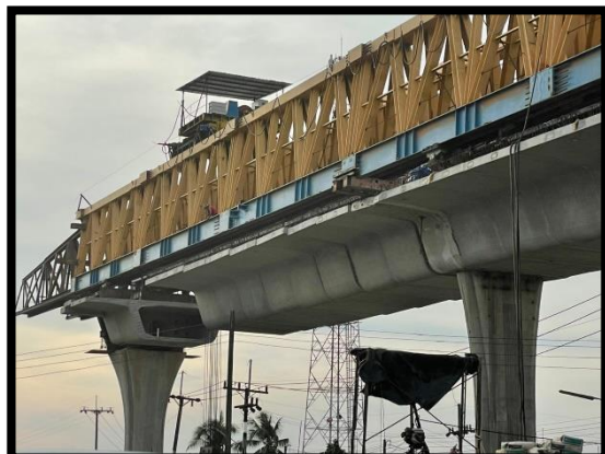
ภาพแสดงงานติดตั้ง Segment ช่วง P๖ ถึง P๗
