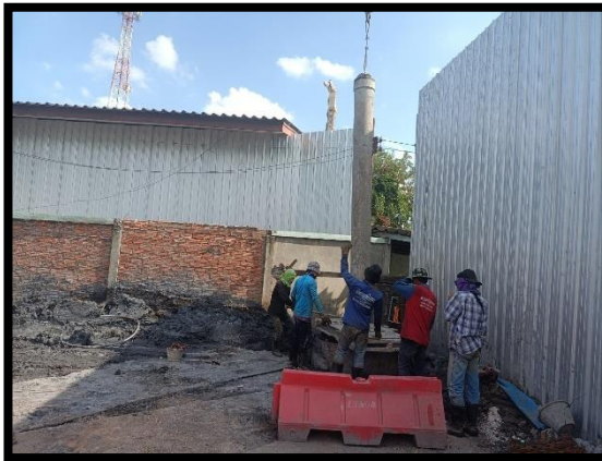
ภาพแสดงงานลงเหล็ก งานเสาเข็มเจาะ P๘ ต้นที่ ๕
