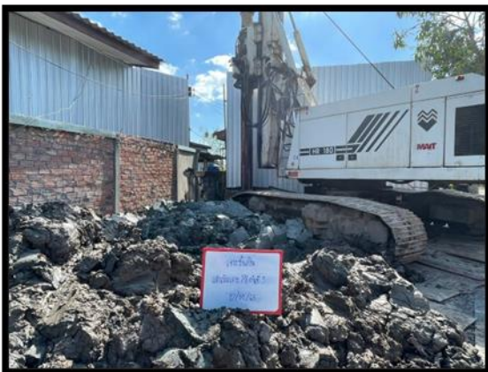
ภาพแสดงงานเจาะขึ้นดิน งานเสาเข็มเจาะ P๘ ต้นที่ ๕
