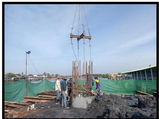
ภาพแสดงงานเจาะชั้นดิน งานเสาเข็มเจาะ P๙ ต้นที่ ๓
