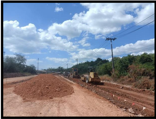
ภาพแสดงงานปรับเกลี่ยและบดอัดชั้นรองพื้นทาง งานถนน Sta.๐+๕๐๐ ถึง Sta.๐+๗๐๐ RT
