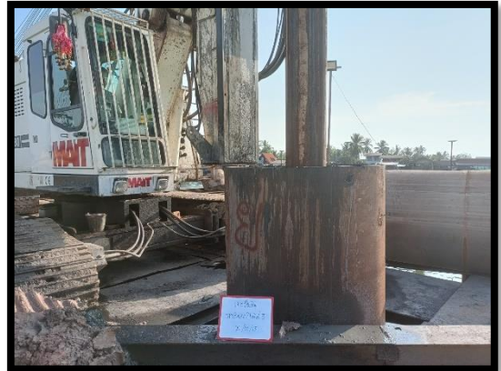
ภาพแสดงงานเจาะชั้นดิน งานเสาเข็มเจาะ P๙ ต้นที่ ๓
