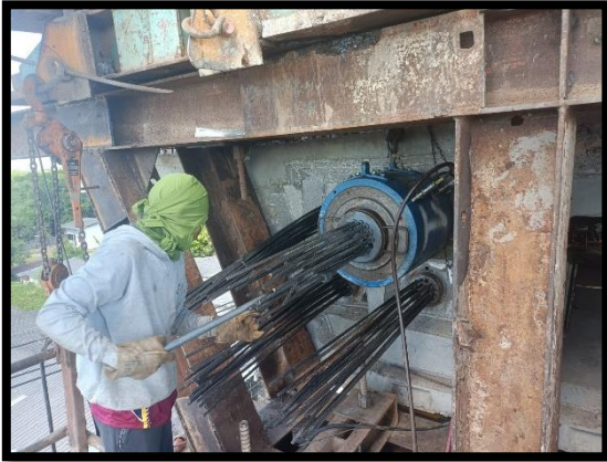
ภาพแสดงงานดัดลวด Segment ๑๕ % ตามยาว ช่วง P๖ ถึง P๗
