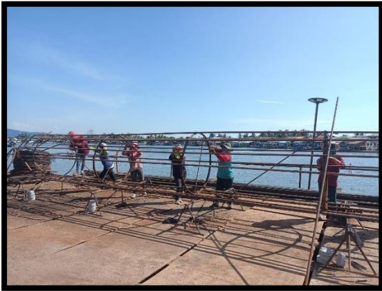
ภาพแสดงงานผูกเหล็กเสาเข็ม งานเสาเข็มเจาะ P๘ ต้นที่ ๕
