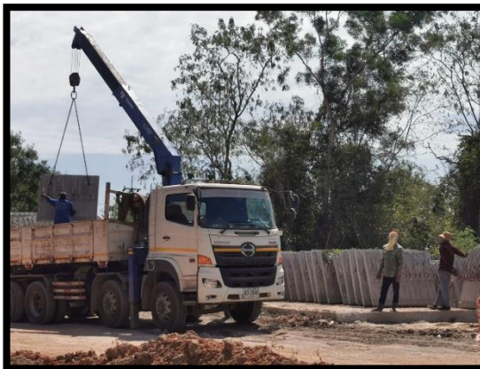
ภาพแสดงงานติดตั้งราวกันตก ช่วง Abutment
