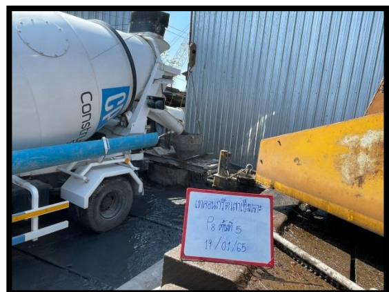
ภาพแสดงงานเทคอนกรีต งานเสาเข็มเจาะ P๘ ต้นที่ ๕
