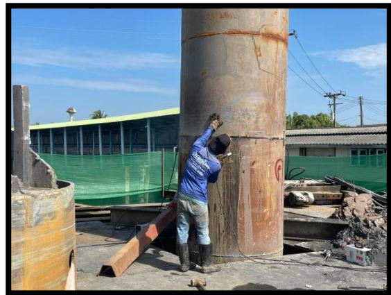
ภาพแสดงงานติดตั้ง Casing งานเสาเข็มเจาะ P๙ ต้นที่ ๓
