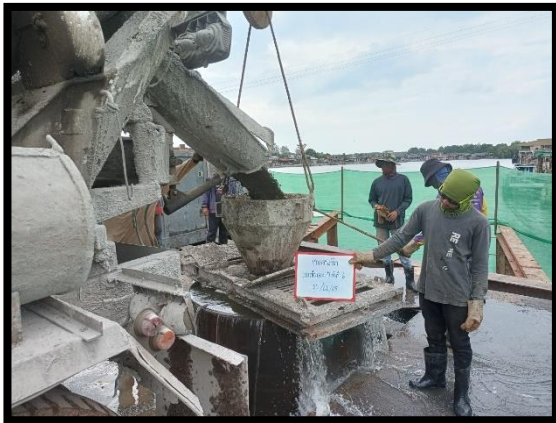
ภาพแสดงงานเทคอนกรีต งานเสาเข็มเจาะ P๙ ต้นที่ ๖
