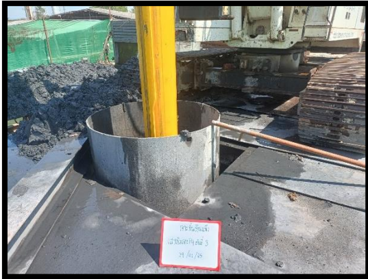
ภาพแสดงงานเจาะชั้นดิน งานเสาเข็มเจาะ P๙ ต้นที่ ๓
