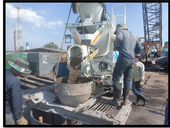
ภาพแสดงงานเทคอนกรีต งานเสาเข็มเจาะ P๔ ต้นที่ ๓
