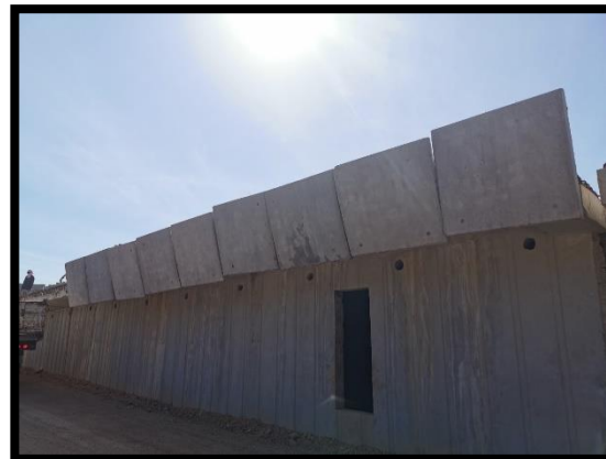
ภาพแสดงงานติดตั้งราวกันตก ช่วง Abutment
