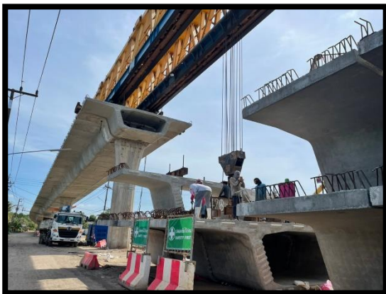
ภาพแสดงงานติดตั้ง Segment ช่วง P๖ ถึง P๗
