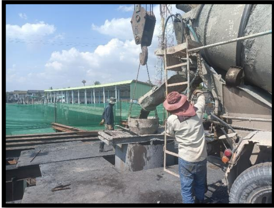
ภาพแสดงงานเทคอนกรีต งานเสาเข็มเจาะ P๔ ต้นที่ ๓
