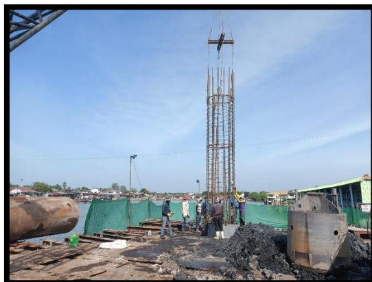
ภาพแสดงงานเจาะชั้นดิน งานเสาเข็มเจาะ P๙ ต้นที่ ๓
