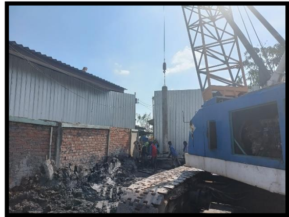
ภาพแสดงงานลงเหล็ก งานเสาเข็มเจาะ P๘ ต้นที่ ๕
