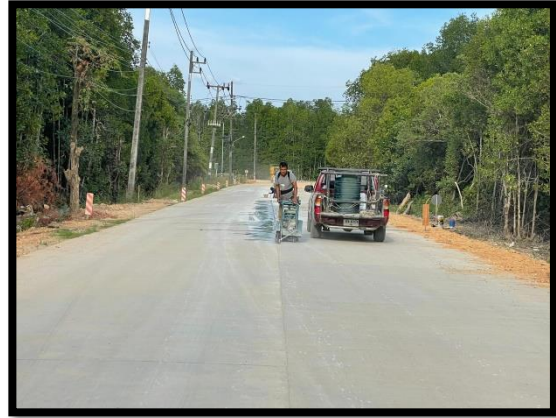
ภาพแสดงงานตัด Joint ตามยาว งานถนน Sta.๐+๐๒๐ ถึง Sta.๐+๒๕๘
