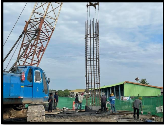
ภาพแสดงงานลงเหล็ก งานเสาเข็มเจาะ P๙ ต้นที่ ๖
