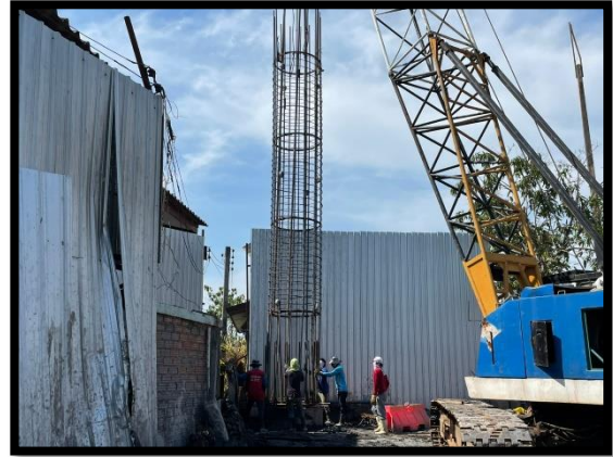
ภาพแสดงงานลงเหล็ก งานเสาเข็มเจาะ P๘ ต้นที่ ๕
