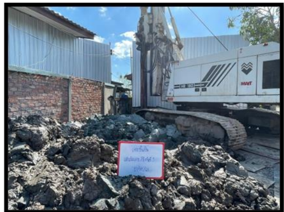
ภาพแสดงงานเจาะขึ้นดิน งานเสาเข็มเจาะ P๘ ต้นที่ ๕
