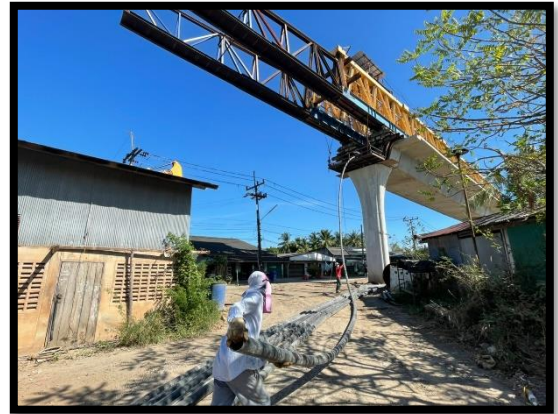
ภาพแสดงงานติดตั้งท่อร้อยลวดอัดแรงใน Segment ช่วง P๖ ถึง P๗
