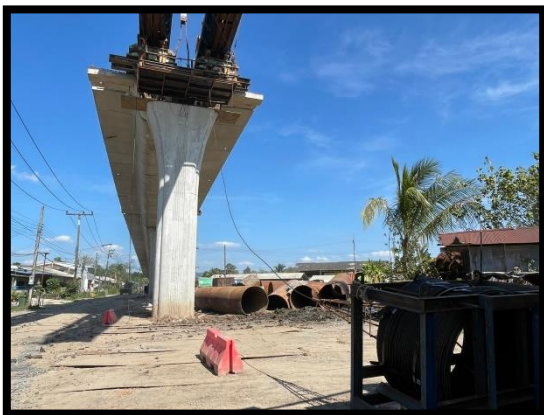
ภาพแสดงงานร้อยลวดอัดแรงใน Segment ช่วง P๖ ถึง P๗
