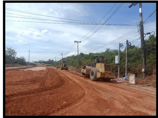
ภาพแสดงงานปรับเกลี่ยและบดอัดชั้นรองพื้นทาง งานถนน Sta.๐+๕๐๐ ถึง Sta.๐+๗๐๐ RT
