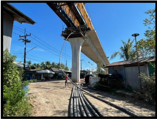
ภาพแสดงงานติดตั้งท่อร้อยลวดอัดแรงใน Segment ช่วง P๖ ถึง P๗
