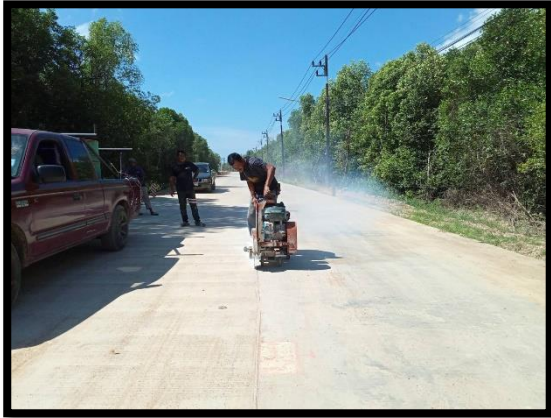
ภาพแสดงงานตัด Joint ตามยาว งานถนน Sta.๐+๐๒๐ ถึง Sta.๐+๒๕๘
