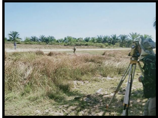
ภาพแสดงงานวางแนวเขตทาง งานถนน (ฝั่งเกาะ) จาก Sta.๑+๕๗๑.๖๙๔ ถึง Sta.๒+๗๕๐
