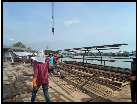
ภาพแสดงงานผูกเหล็กเสาเข็ม งานเสาเข็มเจาะ P๙ ต้นที่ ๓
