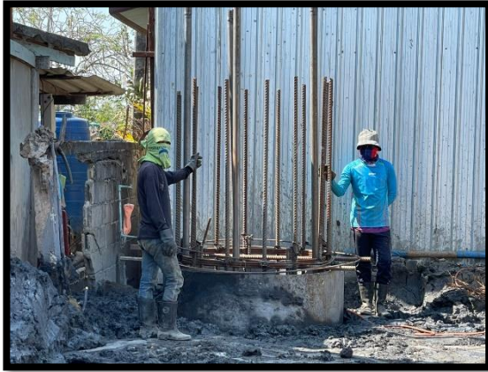
ภาพแสดงงานลงเหล็ก งานเสาเข็มเจาะ P๘ ต้นที่ ๕
