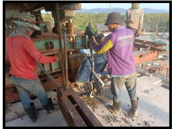
ภาพแสดงงานเทคอนกรีต Wet Joint Segment ช่วง P๖ ถึง P๗
