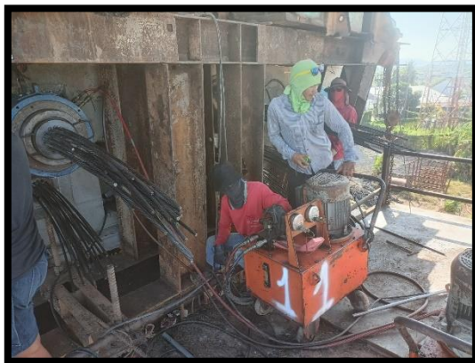
ภาพแสดงงานดัดลวด Segment ๑๐๐ % ตามยาว ช่วง P๖ ถึง P๗
