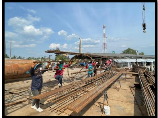
ภาพแสดงงานผูกเหล็กเสาเข็ม งานเสาเข็มเจาะ P๙ ต้นที่ ๓
