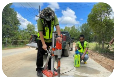
งานตรวจสอบความหนาผิวจราจรคอนกรีต
