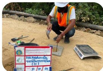
งาน ทดสอบ Field Density Test ชั้นรองพื้นทาง
