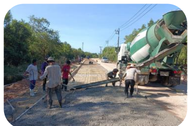
งานผิวทางคอนกรีตเสริมเหล็ก
