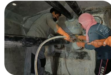
งานอัดฉีดน้ำปูนเกร้าท์ภายในท่อลอดอัดแรง ช่วง P2 -P3
