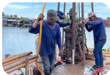
งานเจาะสำรวจชั้นดิน P9
