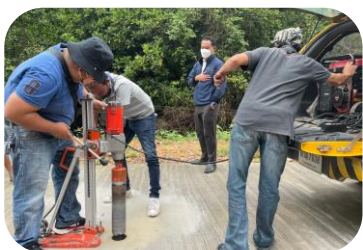
งานตรวจสอบความหนาผิวจราจรคอนกรีต
