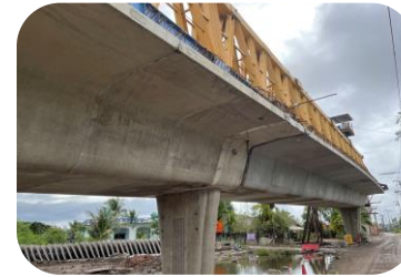
งานติดตั้ง Precast Box Segment (P2-P3 และ P3-P4)
