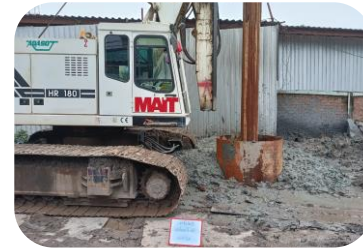
งานเสาเข็มเจาะ ขนาดเส้นผ่าศูนย์กลาง 1.50 ม. (P8/4)
