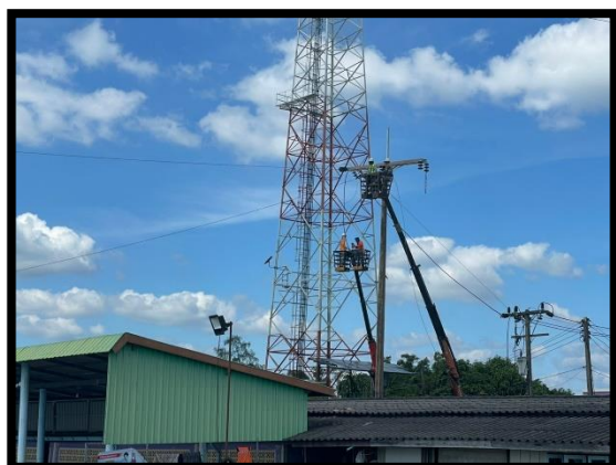
ภาพแสดงการดำเนินการรื้อย้ายสายไฟฟ้าแรงสูง ข้ามคลองท่ามะลิ่ง โดยเจ้าของหน่วยงาน
