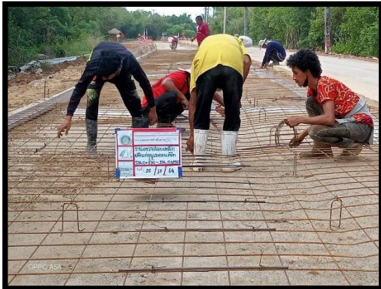
ภาพแสดงงานวางเหล็ก Wire Mesh งานถนน Sta.๐+๑๐๐ ถึง Sta.๐+๓๖๐ LT
