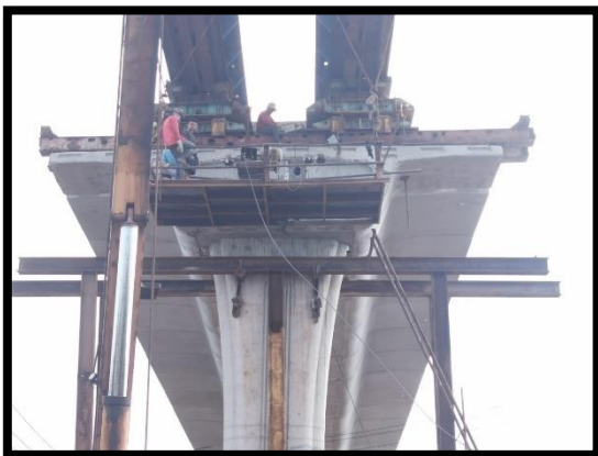
ภาพแสดงงานร้อยลวดอัดแรงใน Segment ช่วง P๕ ถึง P๖
