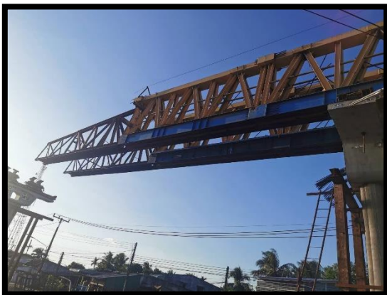
ภาพแสดงงานติดตั้ง Launcher Truss ช่วง P๕ ถึง P๖
