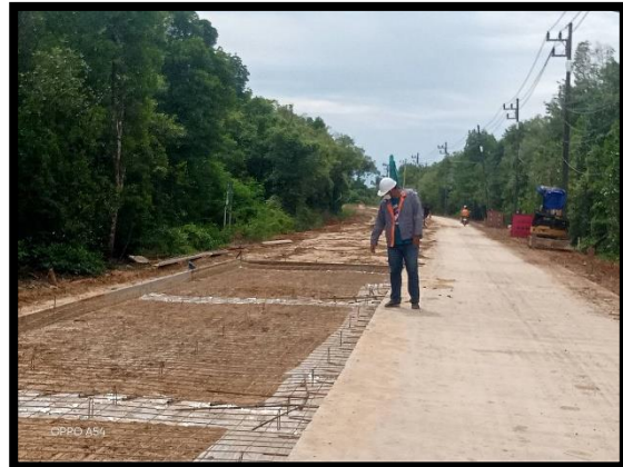
ภาพแสดงงานวางเหล็ก Wire Mesh งานถนน Sta.๐+๑๐๐ ถึง Sta.๐+๓๖๐ LT
