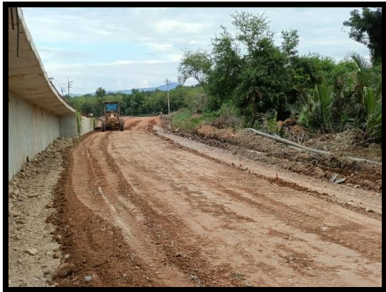
ภาพแสดงงานบดอัดถนน ชั้นรองพื้นทาง Sta.๐+๕๐๐ ถึง Sta.๐+๗๐๐ LT
