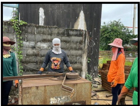
ภาพแสดงงานผูกเหล็ก เข้าแบบ และ เทคอนกรีต Barrier
