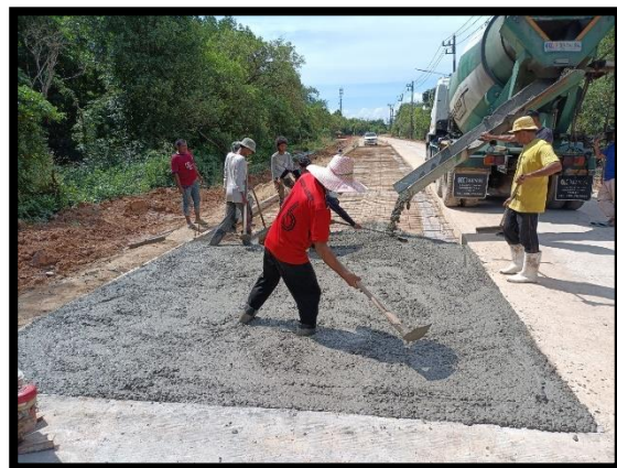
ภาพแสดงงานเทคอนกรีต งานถนน Sta.๐+๑๐๐ ถึง Sta.๐+๓๖๐ LT
