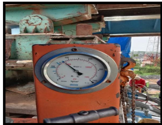
ภาพแสดงงานดึงลวด Segment ๑๐๐ % ตามยาว ช่วง P๕ ถึง P๖
