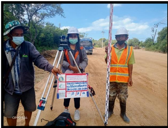
ภาพแสดงงานตรวจสอบระดับ ชั้นรองพื้นทาง Sta.๐+๓๕๗ ถึง Sta.๐+๕๐๐ LT
