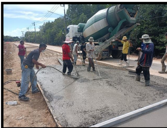
ภาพแสดงงานเทคอนกรีต งานถนน Sta.๐+๑๐๐ ถึง Sta.๐+๓๖๐ LT
