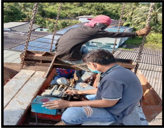
ภาพแสดงงานติดตั้งลวดอัดแรง ตามขวาง P๖
