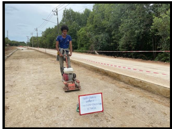
ภาพแสดงงานเข้าแบบข้าง และ งานปรับเกลี่ยและบดอัดชั้นทรายหยาบ Sta.๐+๑๐๐ ถึง Sta.๐+๓๖๐ LT
