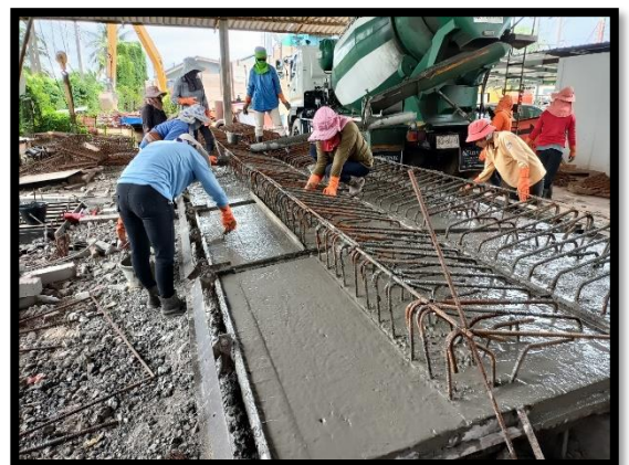
ภาพแสดงงานผูกเหล็ก เข้าแบบ และ เทคอนกรีต Barrier
