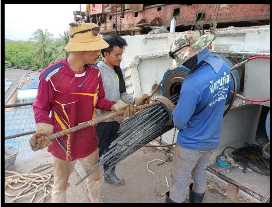
ภาพแสดงงานดึงลวด Segment ๑๕ % ตามยาว ช่วง P๕ ถึง P๖
