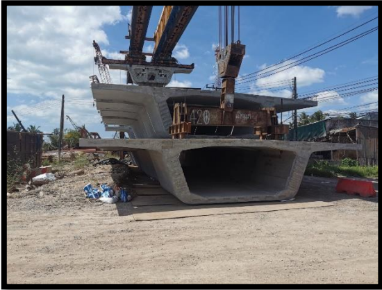
ภาพแสดงงานติดตั้ง Segment ช่วง P๕ ถึง P๖
