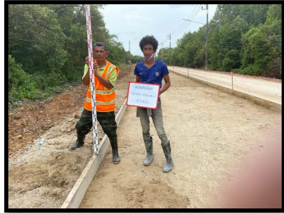
ภาพแสดงงานตรวจสอบระดับหลังแบบ งานถนน Sta.๐+๑๐๐ ถึง Sta.๐+๓๖๐ LT
