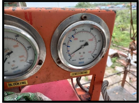
ภาพแสดงงานดึงลวด Segment ๑๕ % ตามยาว ช่วง P๕ ถึง P๖
