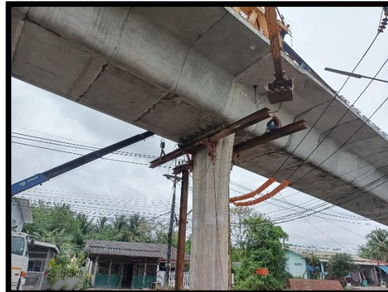
ภาพแสดงงานเคลื่อนย้าย H-Beam P๕
