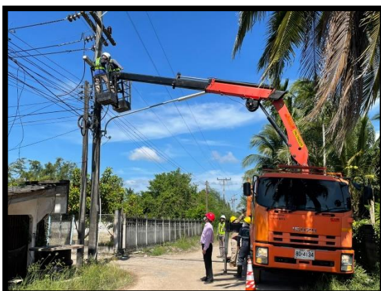
ภาพแสดงการดำเนินการรื้อย้ายสายไฟฟ้าแรงสูง ข้ามคลองท่ามะลิ่ง โดยเจ้าของหน่วยงาน
