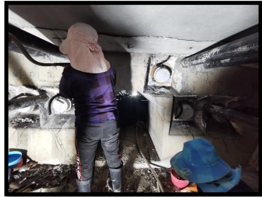
ภาพแสดงงานติดตั้งลวดอัดแรง ตามขวาง P๖
