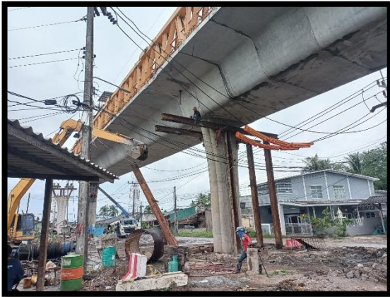
ภาพแสดงงานเคลื่อนย้าย H-Beam P๕
