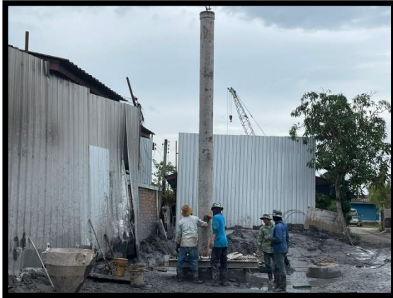
ภาพแสดงงานลง Timmy Pipe งานเสาเข็มเจาะ P๘ ต้นที่ ๑
