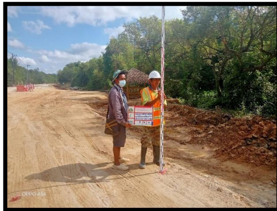
ภาพแสดงงานตรวจสอบระดับ ชั้นรองพื้นทาง Sta.๐+๓๕๗ ถึง Sta.๐+๕๐๐ LT
