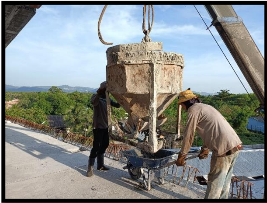
ภาพแสดงงานเทคอนกรีต Wet Joint Segment ช่วง P๔ ถึง P๕
