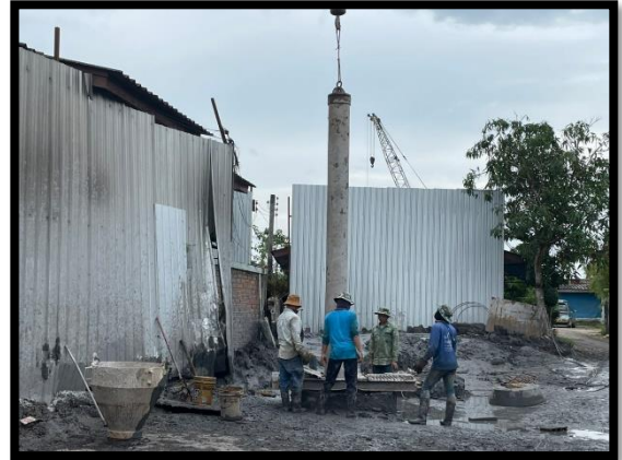
ภาพแสดงงานลง Timmy Pipe งานเสาเข็มเจาะ P๘ ต้นที่ ๑
