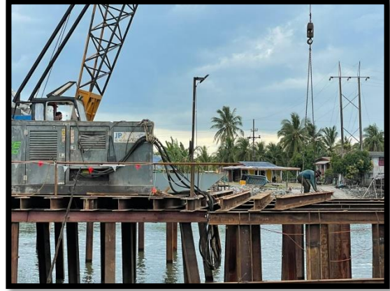
ภาพแสดงงานติดตั้ง H-Beam งาน Jetty
