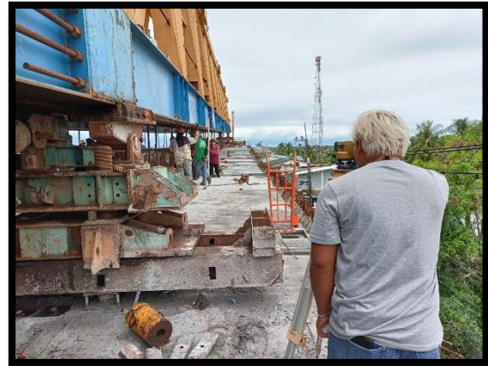
ภาพแสดงงานเข้าแบบ Pot Bearing P๑
