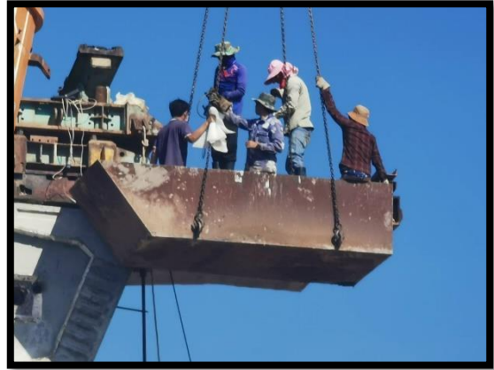
ภาพแสดงงานติดตั้งลวดอัดแรง ตามขวาง P๖
