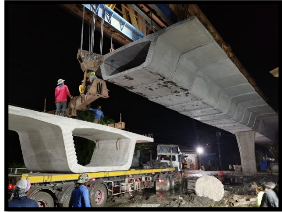
ภาพแสดงงานติดตั้ง Segment ช่วง P๔ ถึง P๕
