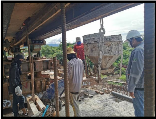
ภาพแสดงงานเทคอนกรีต Wet Joint Segment ช่วง P๕ ถึง P๖
