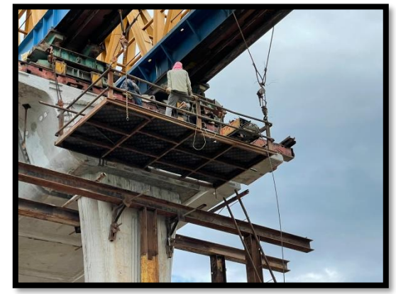
ภาพแสดงงานร้อยลวดอัดแรงใน Segment ช่วง P๕ ถึง P๖
