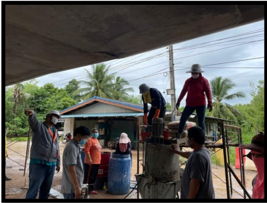
ภาพแสดงงานอัดฉีดปูน Grout ใส่ท่อลวดอัดแรง ช่วง P๑ ถึง P๒
