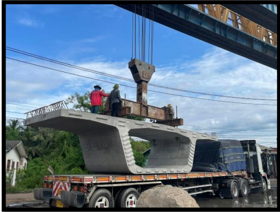
ภาพแสดงงานติดตั้ง Segment ช่วง P๔ ถึง P๕
