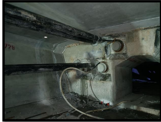
ภาพแสดงงานอัดฉีดปูน Grout ใส่ท่อลอดอัดแรง ช่วง P๒ ถึง P๓
