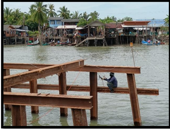
ภาพแสดงงานติดตั้ง H-Beam งาน Jetty
