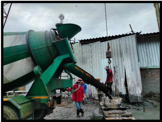
ภาพแสดงงานเทคอนกรีต งานเสาเข็มเจาะ P๘ ต้นที่ ๑
