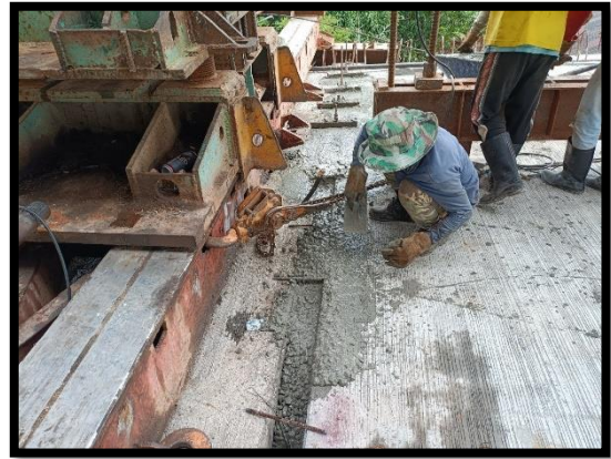
ภาพแสดงงานเทคอนกรีต Wet Joint Segment ช่วง P๕ ถึง P๖
