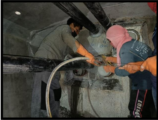
ภาพแสดงงานอัดฉีดปูน Grout ใส่ท่อลอดอัดแรง ช่วง P๒ ถึง P๓
