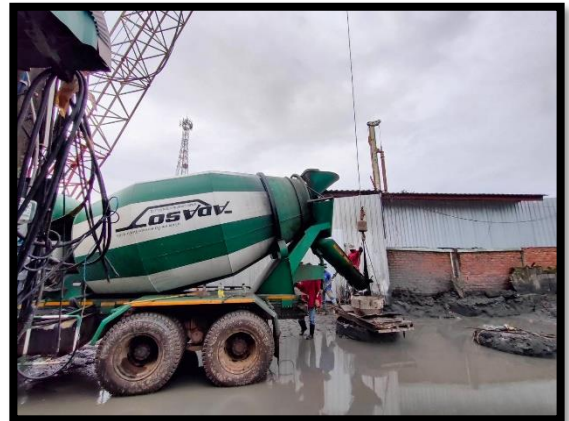
ภาพแสดงงานเทคอนกรีต งานเสาเข็มเจาะ P๘ ต้นที่ ๑
