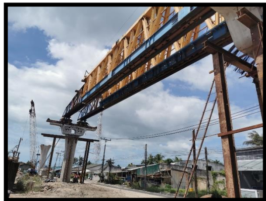
ภาพแสดงงานติดตั้ง Launcher Truss ช่วง P๕ ถึง P๖
