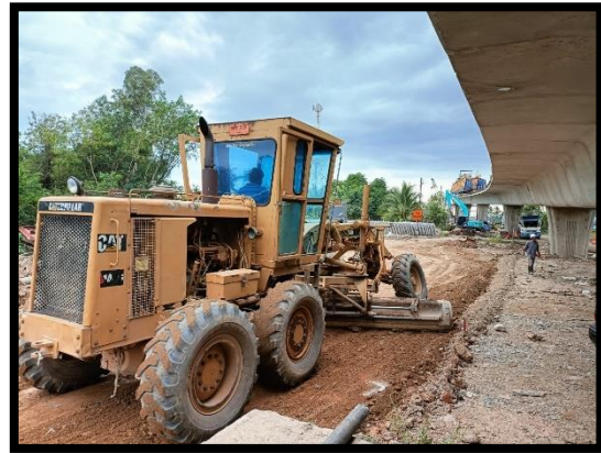
ภาพแสดงงานบดอัดถนน ชั้นรองพื้นทาง Sta.๐+๕๐๐ ถึง Sta.๐+๗๐๐ LT
