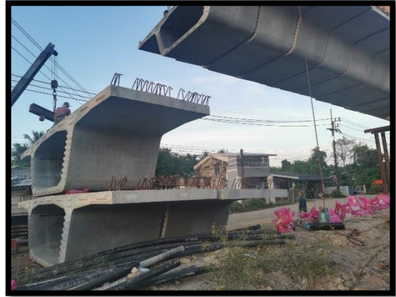
ภาพแสดงงานติดตั้ง Segment ช่วง P๕ ถึง P๖
