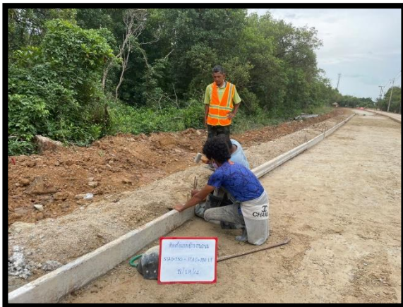
ภาพแสดงงานเข้าแบบข้าง และ งานปรับเกลี่ยและบดอัดชั้นทรายหยาบ Sta.๐+๑๐๐ ถึง Sta.๐+๓๖๐ LT
