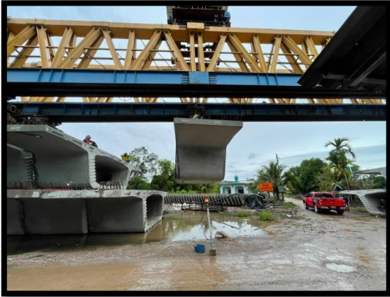
ภาพแสดงงานติดตั้ง Segment ช่วง P๒ ถึง P๓
