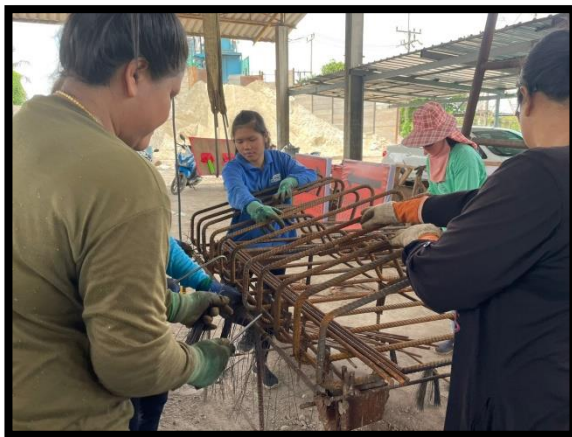
ภาพแสดงงานผูกเหล็ก เข้าแบบ และ เทคอนกรีต Barrier
