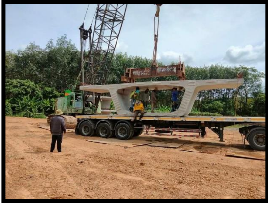
ภาพแสดงงานขนย้าย Segment และปรับพื้นที่เก็บวัสดุแห่งใหม่
