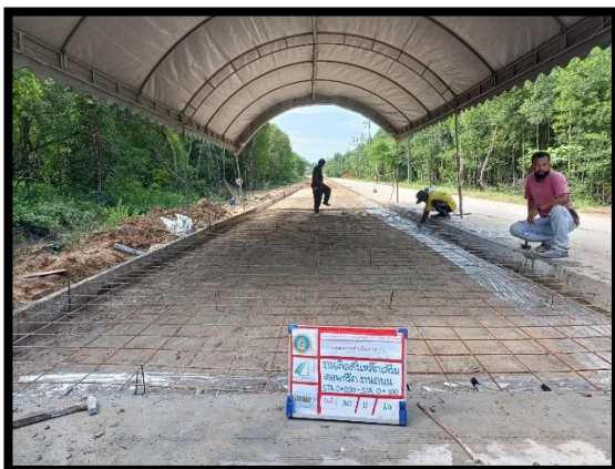
ภาพแสดงงานวางเหล็ก Wire Mesh งานถนน Sta.๐+๐๒๐ ถึง Sta.๐+๑๐๐ LT
