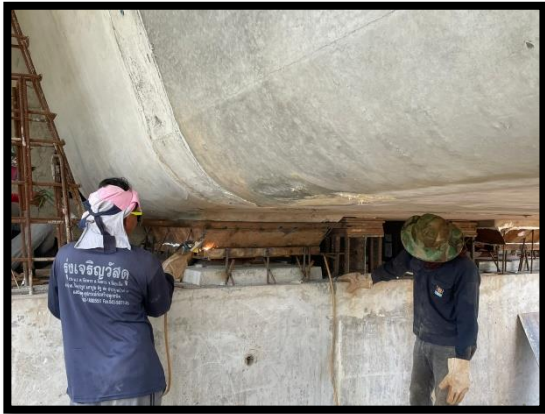
ภาพแสดงงานเข้าแบบ Pot Bearing P๑
