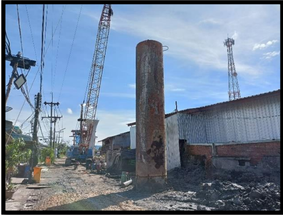
ภาพแสดงงานติดตั้ง Casing งานเสาเข็มเจาะ P๘ ต้นที่ ๑ และ ต้นที่ ๒
