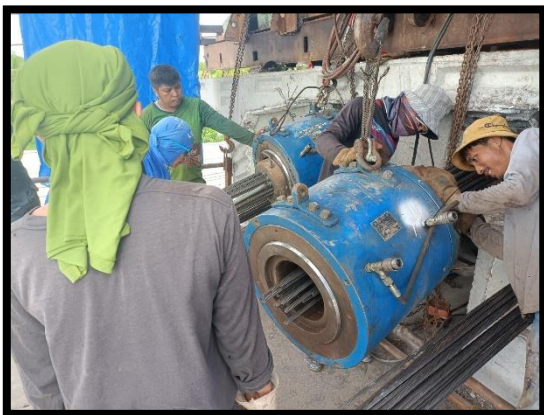
ภาพแสดงงานดึงลวด Segment ๑๕ % ตามยาว ช่วง P๑ ถึง P๒
