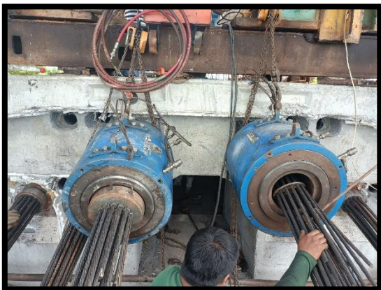
ภาพแสดงงานดึงลวด Segment ๑๕ % ตามยาว ช่วง P๓ ถึง P๔
