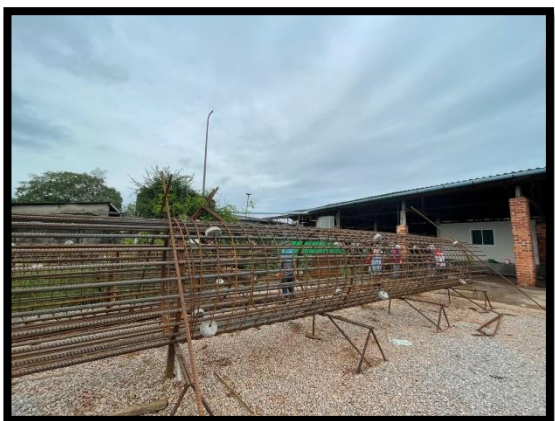
ภาพแสดงงานผูกเหล็ก งานเสาเข็มเจาะ P๘ ต้นที่ ๑
