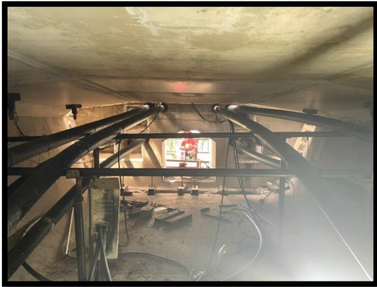
ภาพแสดงงานร้อยลวดอัดแรงใน Segment ช่วง P๒ ถึง P๓
