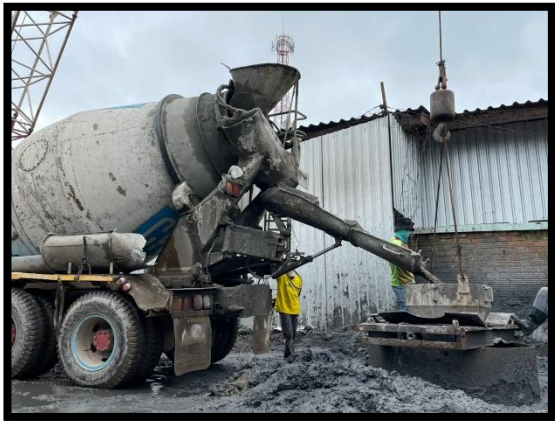
ภาพแสดงงานเทคอนกรีต งานเสาเข็มเจาะ P๘ ต้นที่ ๒
