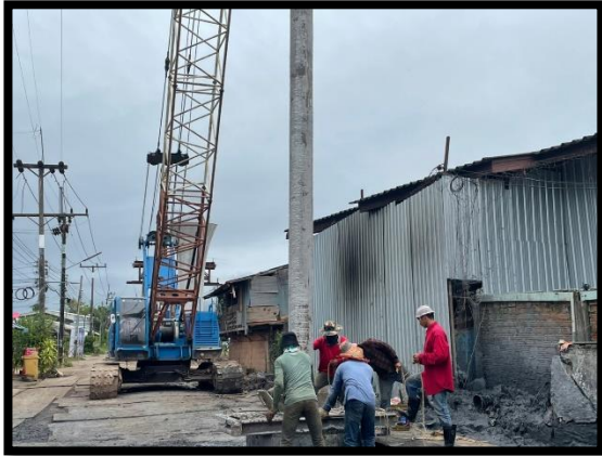
ภาพแสดงงานลง Timmy Pipe งานเสาเข็มเจาะ P๘ ต้นที่ ๒
