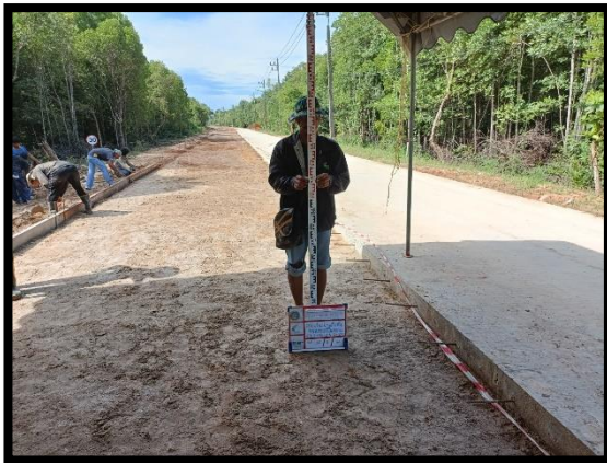
ภาพแสดงงานตรวจสอบระดับหลังแบบ งานถนน Sta.๐+๐๒๐ ถึง Sta.๐+๑๐๐ LT
