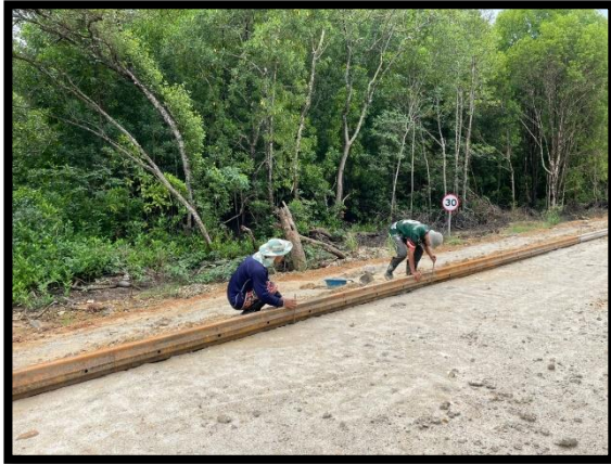
ภาพแสดงงานเข้าแบบข้างและ งานปรับเกลี่ยและบดอัดชั้นทรายหยาบ Sta.๐+๐๒๐ ถึง Sta.๐+๑๐๐ LT
