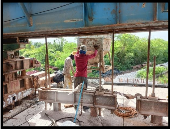
ภาพแสดงงานเทคอนกรีต Wet Joint Segment ช่วง P๒ ถึง P๓
