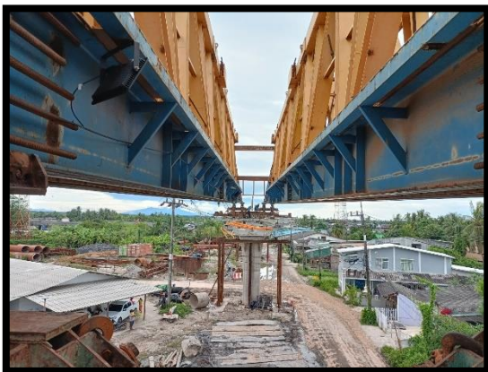
ภาพแสดงงานเคลื่อนย้ายตำแหน่ง Launcher Truss ช่วง P๔ และ P๕
