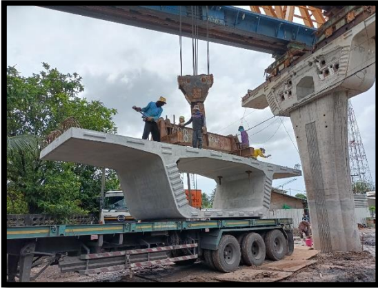
ภาพแสดงงานติดตั้ง Segment ช่วง P๓ ถึง P๔
