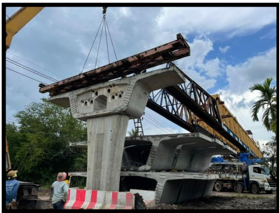
ภาพแสดงงานเคลื่อนย้ายตำแหน่ง Launcher Truss ช่วง P๒ และ P๓
