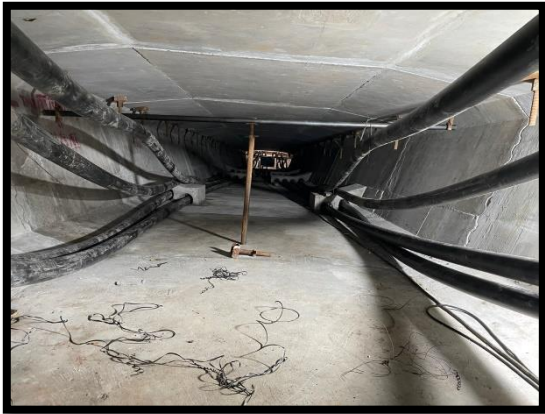
ภาพแสดงงานร้อยลวดอัดแรงใน Segment ช่วง P๓ ถึง P๔
