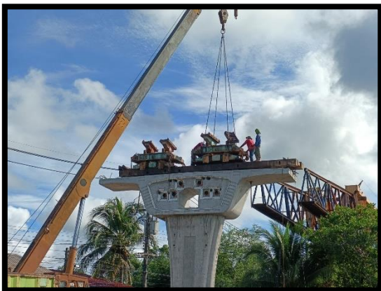
ภาพแสดงงานเคลื่อนย้ายตำแหน่ง Launcher Truss ช่วง P๓ และ P๔
