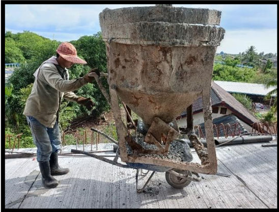
ภาพแสดงงานเทคอนกรีต Wet Joint Segment ช่วง P๓ ถึง P๔
