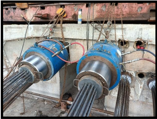
ภาพแสดงงานดัดลวด Segment ๑๐๐ % ตามยาว ช่วง P๒ ถึง P๓
