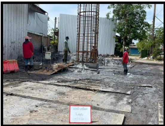
ภาพแสดงงานลงเหล็ก งานเสาเข็มเจาะ P๘ ต้นที่ ๑
