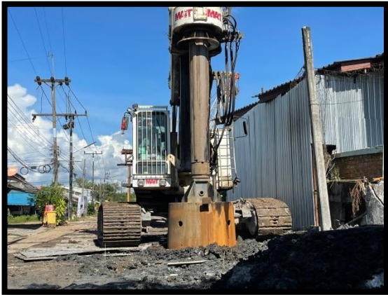
ภาพแสดงงานเจาะชั้นดิน งานเสาเข็มเจาะ P๘ ต้นที่ ๑ และ ต้นที่ ๒
