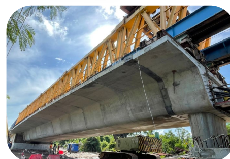
งานติดตั้ง Precast Box Segment (P1-P2)
