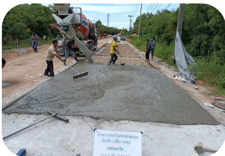
งานผิวทางคอนกรีตเสริมเหล็ก
