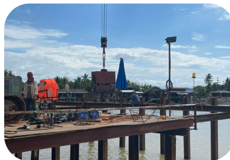
งานนั่งร้านสำหรับเสาเข็มเจาะ P9 และ P10
