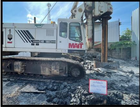
ภาพแสดงงานเจาะชั้นดิน งานเสาเข็มเจาะ P๘ ต้นที่ ๓ และ ต้นที่ ๔
