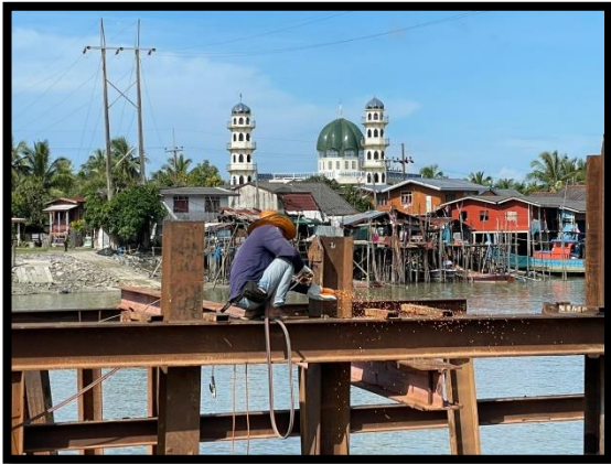
ภาพแสดงงานติดตั้ง Beam งาน Jetty ข้ามคลองท่ามะลิ่ง
