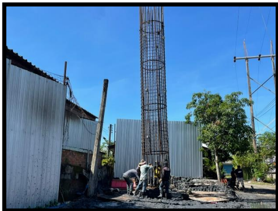
ภาพแสดงงานลงเหล็ก งานเสาเข็มเจาะ P๘ ต้นที่ ๓ และ ต้นที่ ๔
