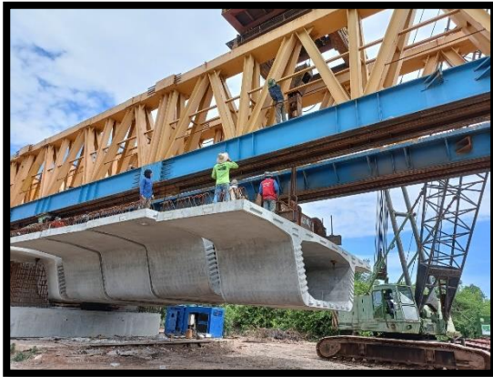
ภาพแสดงงานติดตั้ง Segment ช่วง P๑ และ P๒
