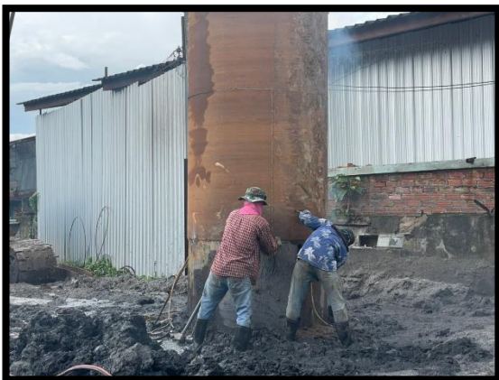
ภาพแสดงงานติดตั้งท่อ Casing งานเสาเข็มเจาะ P๘ ต้นที่ ๓ และ ต้นที่ ๔
