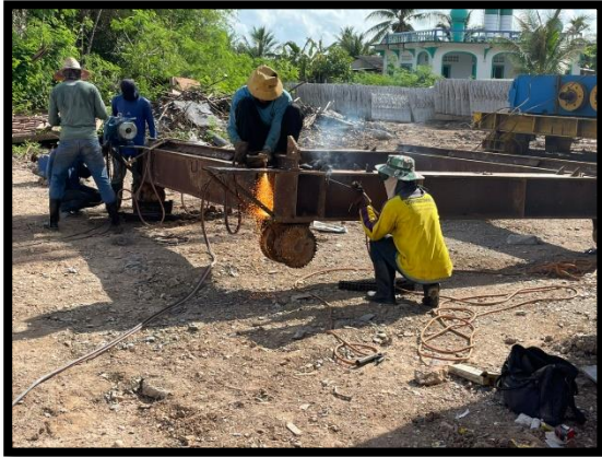
ภาพแสดงงานติดตั้ง Launcher Truss ช่วง P๑ และ P๒
