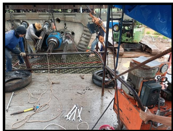
ภาพแสดงงานติดตั้งอัดแรง Segment ๑๐๐% ตามยาว ช่วง P๑ ถึง P๒
