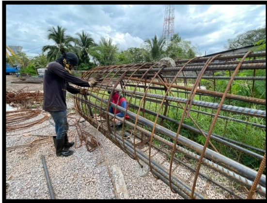
ภาพแสดงงานผูกเหล็กเสาเข็ม งานเสาเข็มเจาะ P๘ ต้นที่ ๓ และ ต้นที่ ๔
