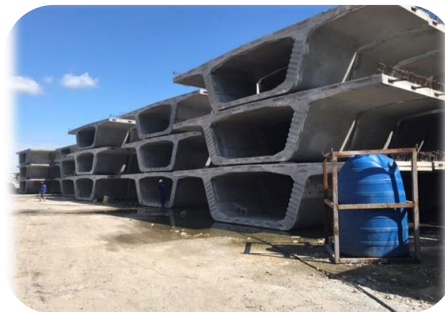
งานหล่อ Segment (จากโรงงาน)
