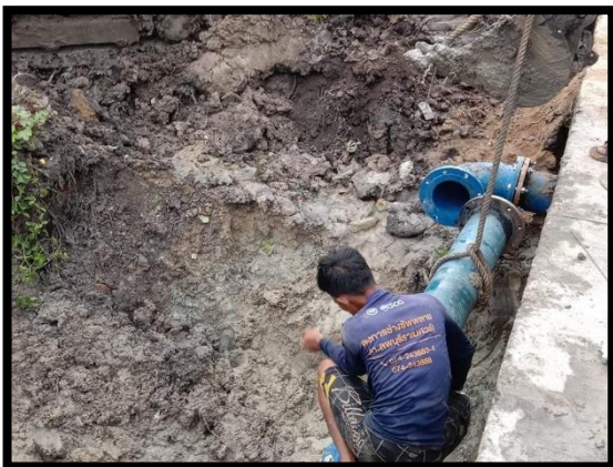
ภาพแสดงงานเชื่อมต่อท่อประปาโดยเจ้าของหน่วยงาน
