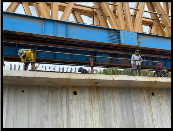
ภาพแสดงงานประกอบและติดตั้ง Launcher P๑ - P๓
