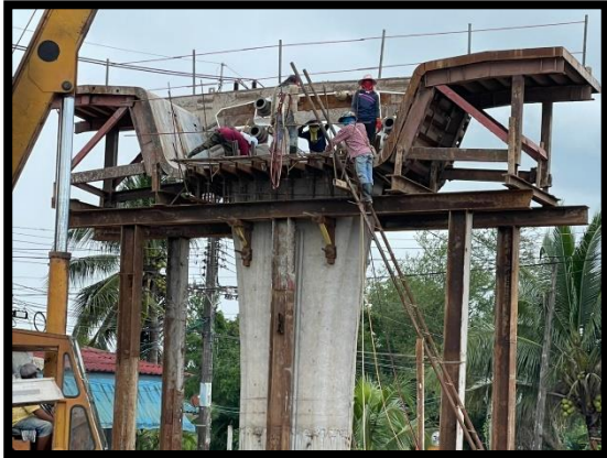
ภาพแสดงงานผูกเหล็ก Pier Segment (P๔)
