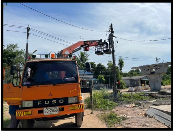
ภาพแสดงงานรื้อย้ายเสาไฟฟ้าแรงต่ำจากเจ้าของหน่วยงาน จำนวน ๕ ต้น
