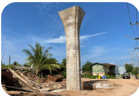
งานโครงสร้างเสาตอม่อ P7
