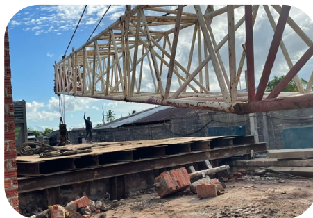
งานติดตั้งนั่งร้านสำหรับเสาเข็มเจาะ P9 และ P10
