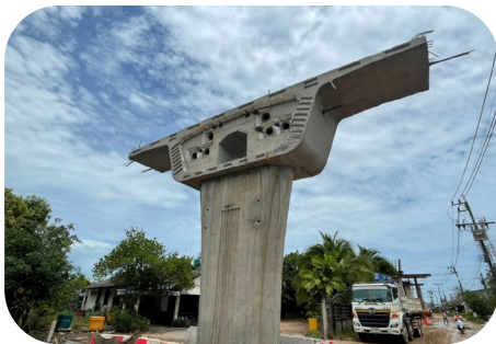
งานคอนกรีต Pier Segment P3
