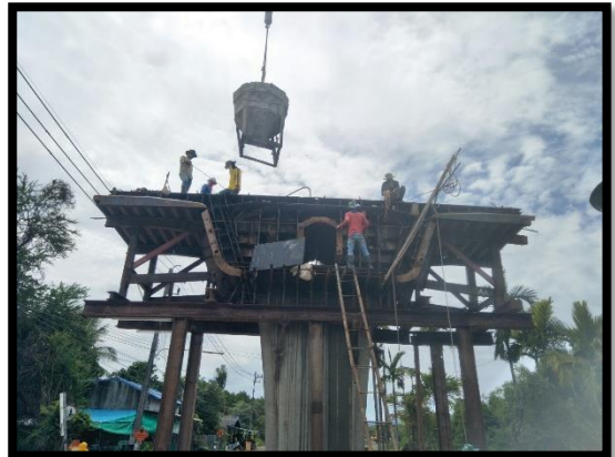
ภาพแสดงงานเทคอนกรีต Pier Segment (P๓)
