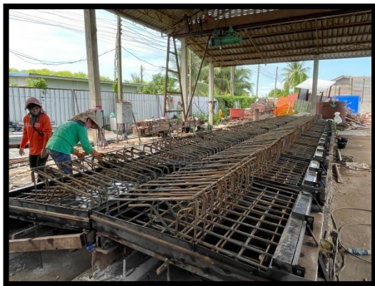
ภาพแสดงงานผูกเหล็ก Barrier
