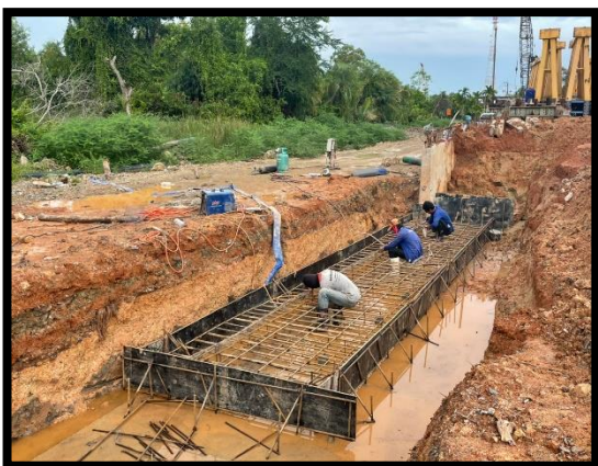
ภาพแสดงงานผูกเหล็กโครงสร้างฐานรากกำแพงกันดิน
