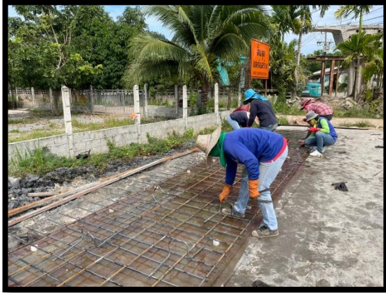
ภาพแสดงงานผูกเหล็กผนังกำแพงกันดิน
