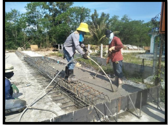
ภาพแสดงงานเทคอนกรีตผนังกำแพงกันดิน
