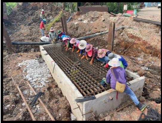
ภาพแสดงงานผูกเหล็กฐานราก (P๗)
