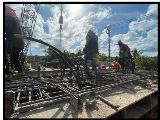
ภาพแสดงงานผูกเหล็ก Pier Segment (P๑)
