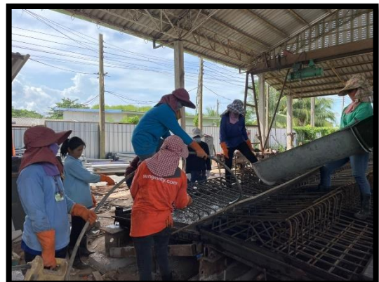
ภาพแสดงงานเทคอนกรีต Barrier
