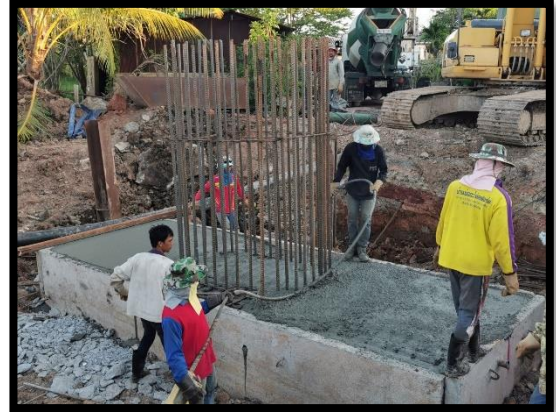
ภาพแสดงงานเทคอนกรีตฐานราก (P๗)
