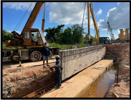
ภาพแสดงงานติดตั้งผนังกำแพงกันดิน
