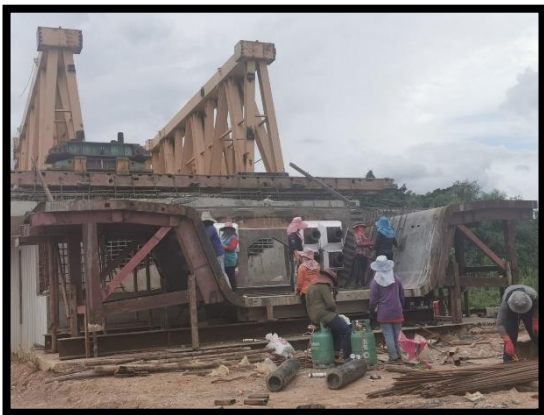
ภาพแสดงงาน Pier Segment (P๑)
