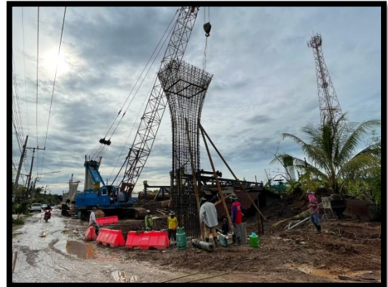
ภาพแสดงงานติดตั้งเหล็กและเข้าแบบโครงสร้างเสาตอม่อ (P๗)
