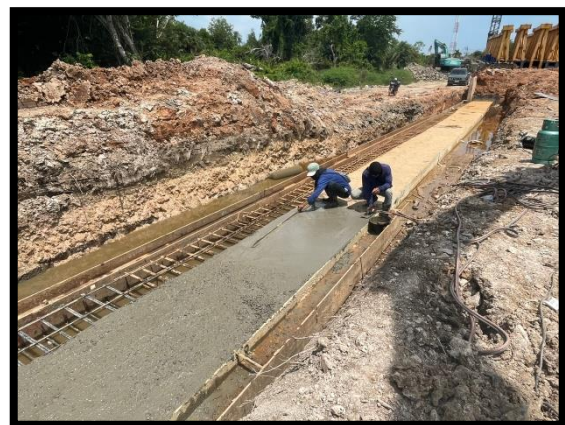
ภาพแสดงงานเทคอนกรีตโครงสร้างฐานรากกำแพงกันดิน
